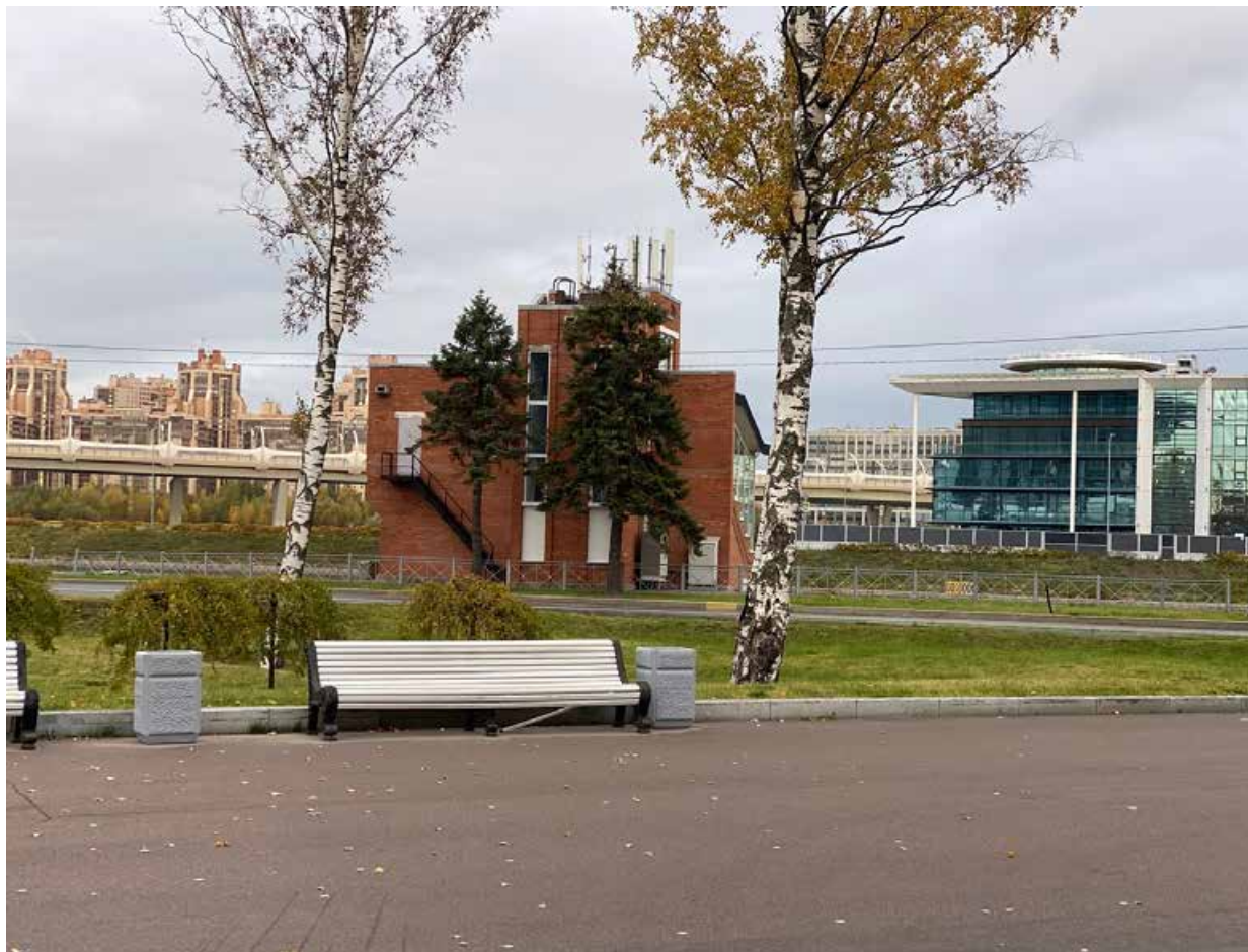
3. Вид на здание по адресу: Санкт-Петербург, Южная дорога, д. 25, литера П со стороны Газпром Арены.
