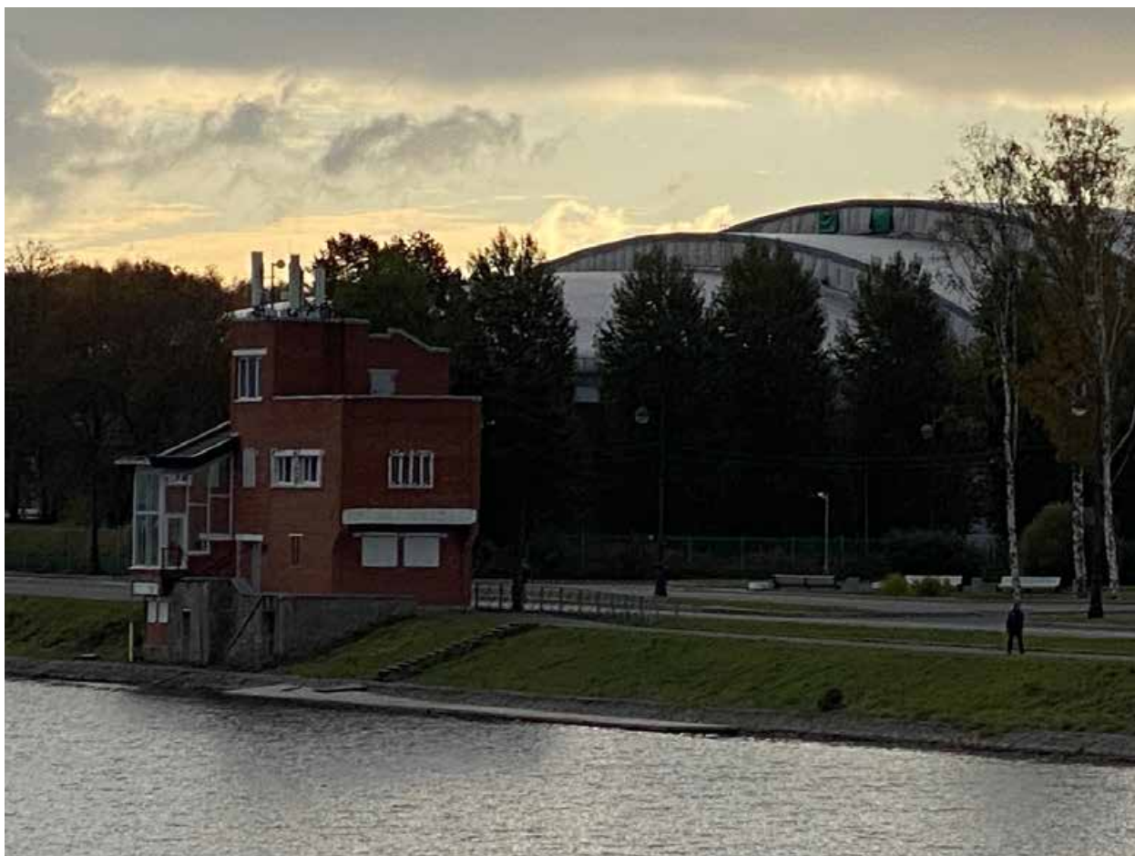
8. Вид на здание по адресу: Санкт-Петербург, Южная дорога, д. 25, литера П со стороны ЗСД.
