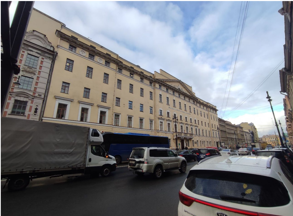
3. Объект культурного наследия регионального значения «Институт инженеров путей сообщения», расположенный по адресу: г. Санкт-Петербург, Московский проспект, дом 9, литера А. Общий вид восточного лицевого фасада.
