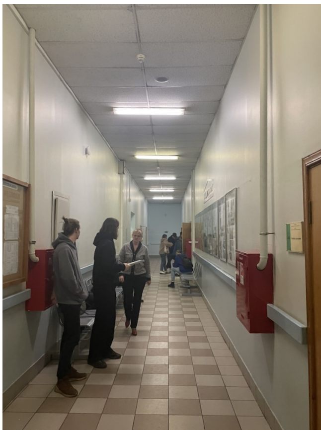
13. Объект культурного наследия регионального значения «Институт инженеров путей сообщения», расположенный по адресу: г. Санкт-Петербург, Московский проспект, дом 9, литера А. Общий вид пом. 32-Н (1498) в уровне 4-го этажа.
