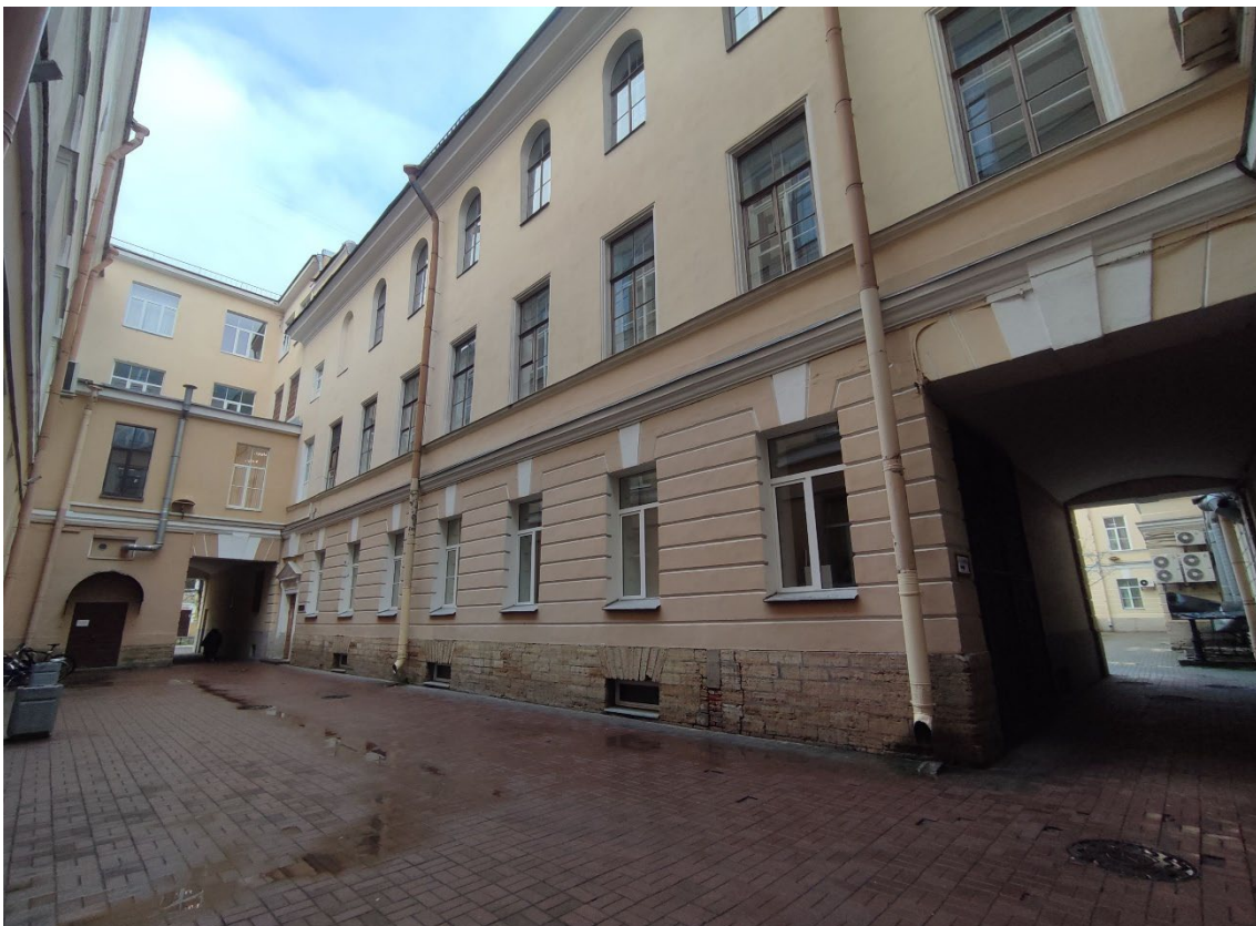
4. Объект культурного наследия регионального значения «Институт инженеров путей сообщения», расположенный по адресу: г. Санкт-Петербург, Московский проспект, дом 9, литера А. Общий вид южного дворового фасада южного дворового корпуса.
