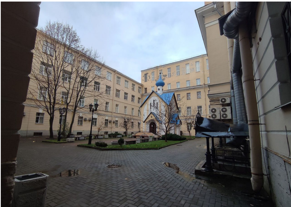
5. Объект культурного наследия регионального значения «Институт инженеров путей сообщения», расположенный по адресу: г. Санкт-Петербург, Московский проспект, дом 9, литера А. Общий вид восточного дворового фасада западного дворового корпуса, и южного дворового фасада северного дворового корпуса.
