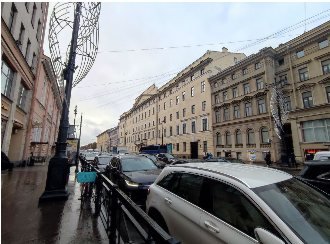
1. Объект культурного наследия регионального значения «Институт инженеров путей сообщения», расположенный по адресу: г. Санкт-Петербург, Московский проспект, дом 9, литера А. Общий вид восточного лицевого фасада в перспективе Московского проспекта.
