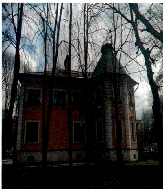
5. Общий вид (западный фасад).
