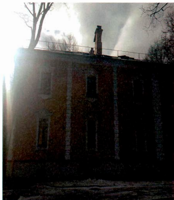
4. Общий вид (северный фасад)
