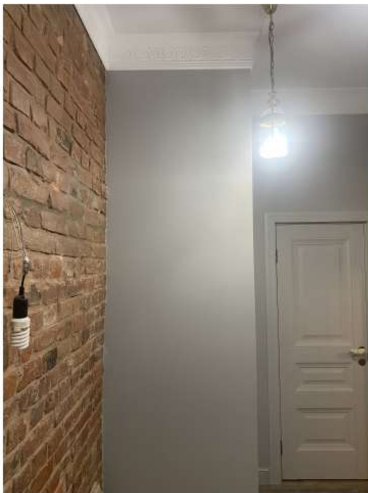
7. Фрагмент интерьера коридора (помещение №1/6.8);
