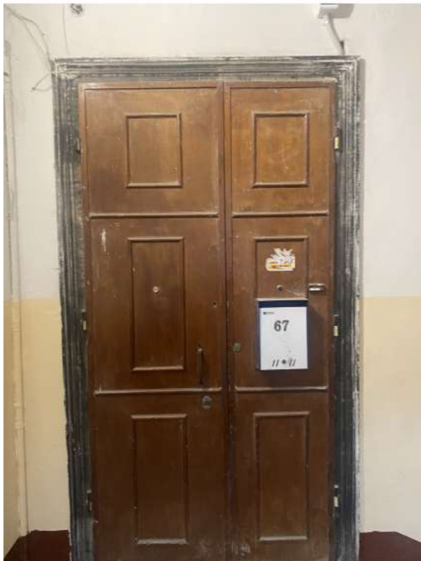
3. Вид на входную дверь в квартиру №67;
