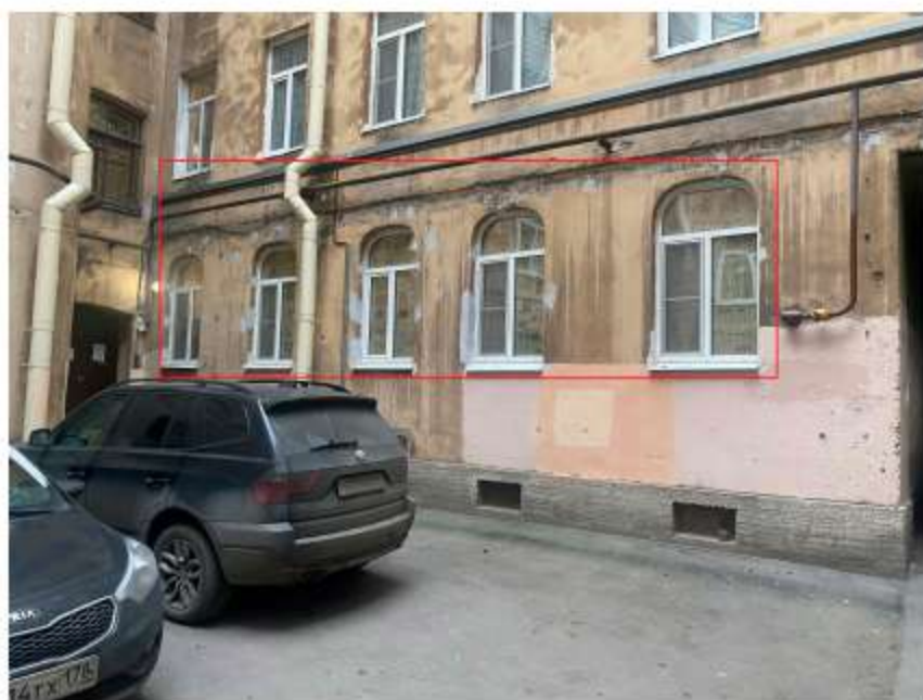
2. Вид на дворовой фасад здания и окна квартиры;
