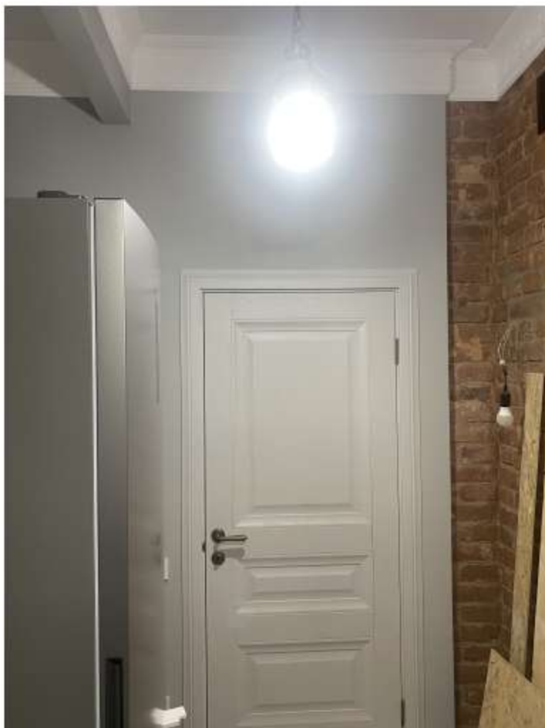
4. Вид на входную дверь в квартире №67;
