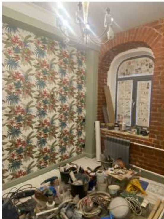
17.Фрагмент интеръера кабинета (помещение №8/9.9);
