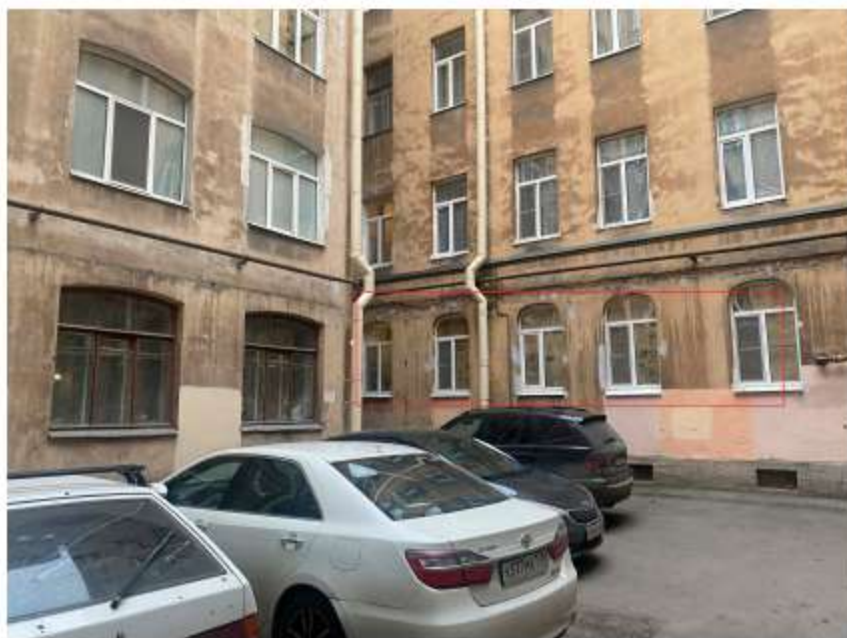
1. Вид на дворовой фасад здания и окна квартиры;
