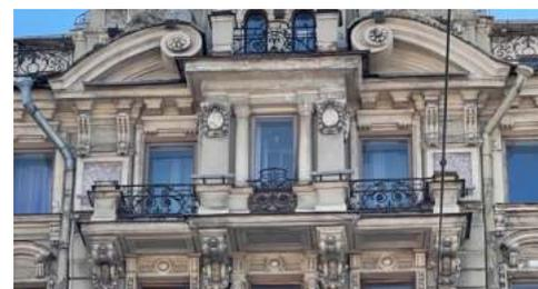
ограждение выполнено в виде фигурной (в центральной части) ажурной металлической ковано-литой решетки, декорированной волютообразными завитками и розетками, установленный между кирпичными оштукатуренными тумбами;
