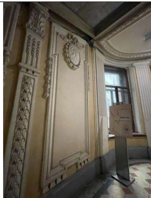
на площадках в уровне второго-третьего и третьего-четвертого этажей над пилястрами – рельефные медальоны, обрамленные гирляндами, увенчанные мужскими маскаронами; стены завершены профилированным карнизом;
