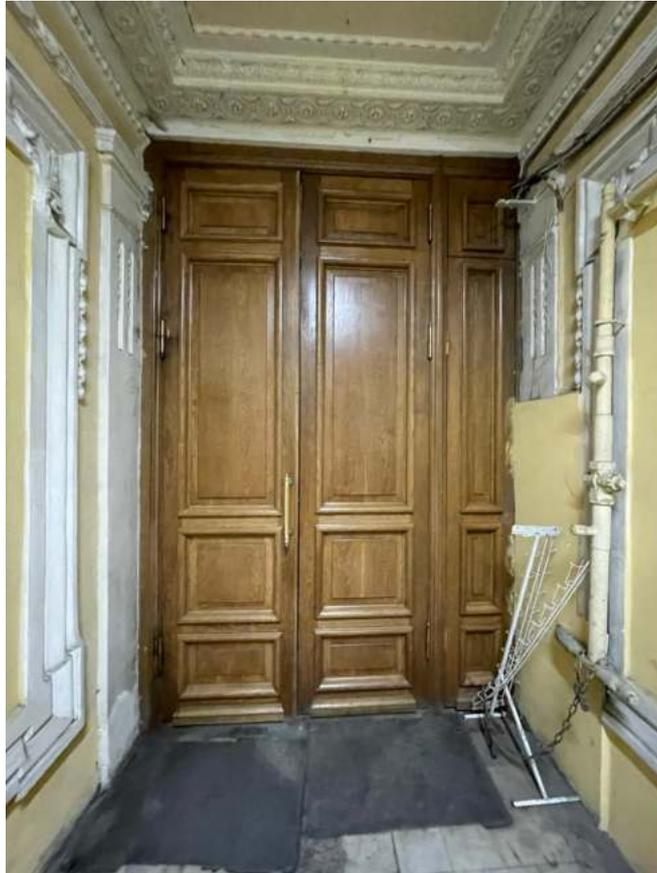
3. Общий вид трехстворчатого дверного заполнения тамбура со стороны вестибюля. Каждая створка поделена одинаково на четыре неравные филенки.
