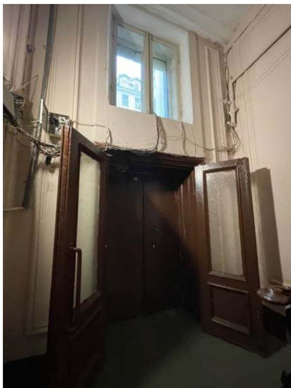
159. Общий вид входного проема и заполнения. Деревянный тамбур с филенчатыми панелями. Дверное заполнение двустворчатое деревянное, каждая створка делится на две филенки, большая из них остеклена. Проем оформлен профилированным наличником. Над дверным проемом находится оконный. Стены оформлены профилированными панелями.
