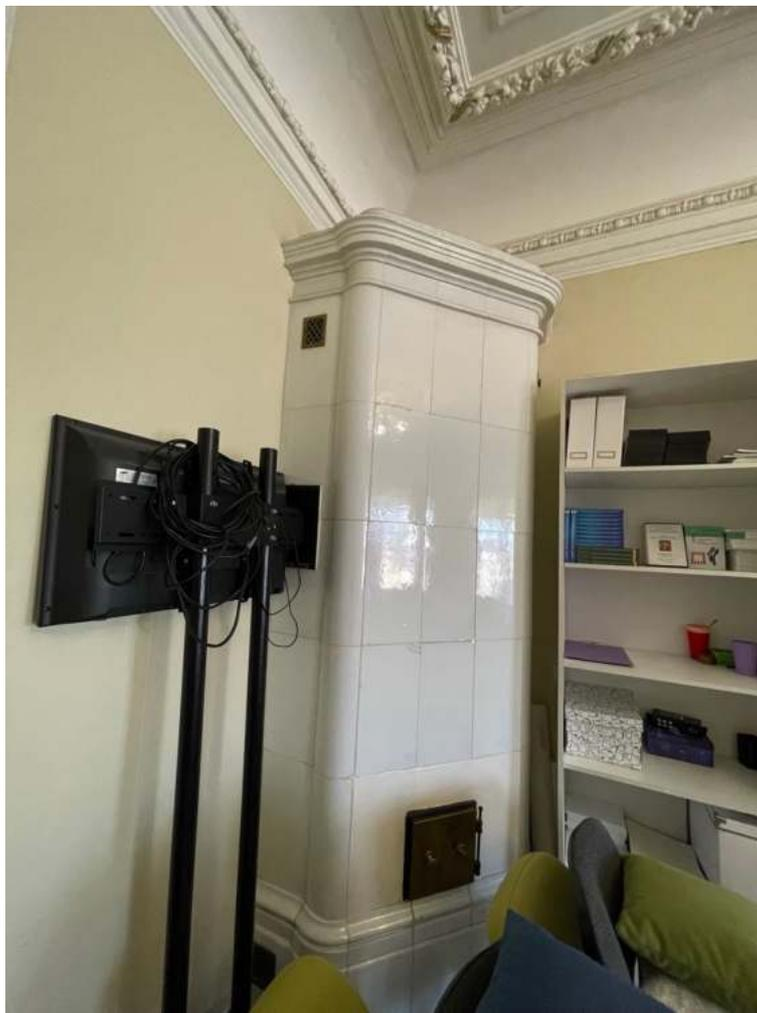
140. Изразцовая печь угловая в помещении 26(Н)-5. Завершается профилированным карнизом. Оформлена глазурованными белыми изразцами без рельефного декора.
