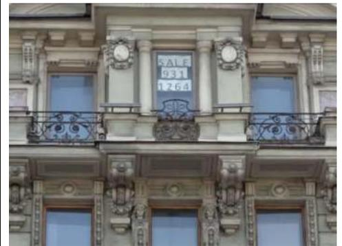
ограждение выполнено в виде фигурной (в центральной части) ажурной металлической ковано-литой решетки, декорированной воллютообразными завитками и розетками, установленной между кирпичными оштукатуренными тумбами;
