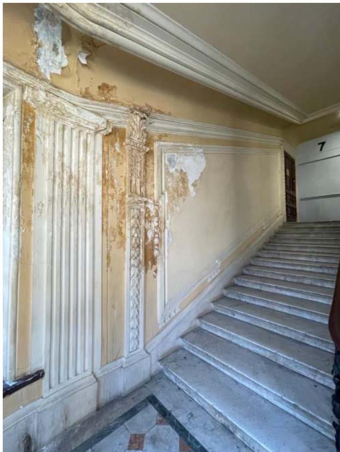
152. Общий вид лестничного марша с шестого этажа на мансардный этаж. Сильные дефекты декоративной отделки стен в результате протечек крыши.
