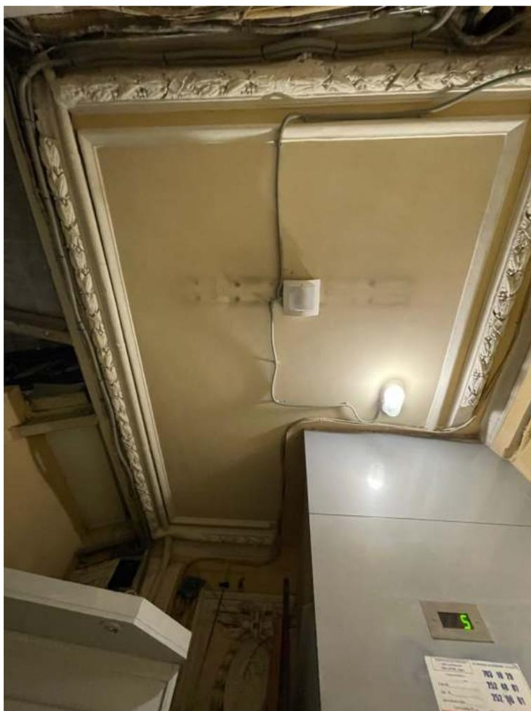
10. Потолок лестничной площадки оформлен профилированным карнизом и лавровой гирляндой, аналогичной гирлянде дверного проема. В месте установки лифтовой шахты гирлянда и профилированный карниз утрачены.
