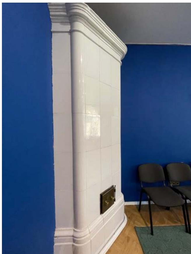
137. Угловая изразцовая печь в помещении 26(Н)-3. Завершается профилированным карнизом. Выполнена из белых глазурованных изразцов без рельефных композиций.
