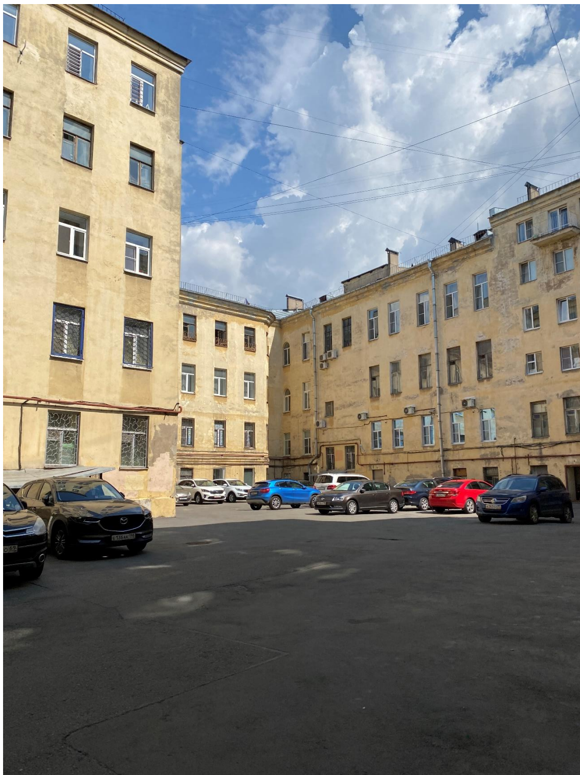
Фото 8. Вид на западный (дворовый) фасад объекта культурного наследия регионального значения «Дом Косиковского (А.М. Тупикова)».
