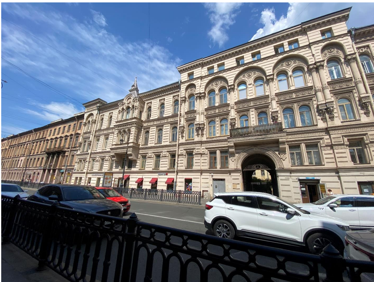
Фото 5. Вид на южный (лицевой) фасад объекта культурного наследия регионального значения «Дом Косиковского (А.М. Тупикова)».
