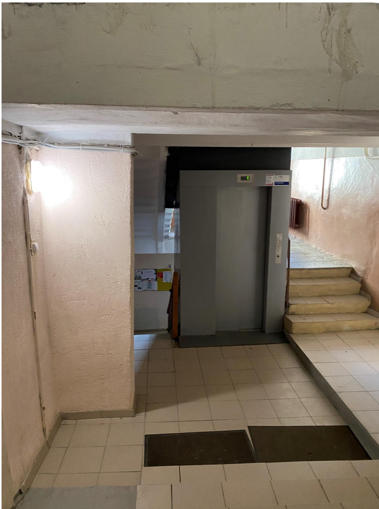
Фото 12. Лестничная клетка 4ЛК объекта культурного наследия регионального значения «Дом Косиковского (А.М. Тупикова)» в уровне 2-го этажа.
