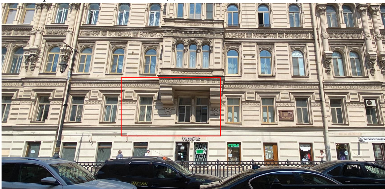
Фото 6. Фрагмент южного фасада объекта культурного наследия регионального значения «Дом Косиковского (А.М. Тупикова)» с отображением оконных проемов квартиры № 41.
