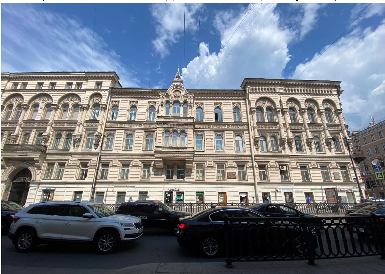
Фото 4. Вид на южный (лицевой) фасад объекта культурного наследия регионального значения «Дом Косиковского (А.М. Тупикова)».
