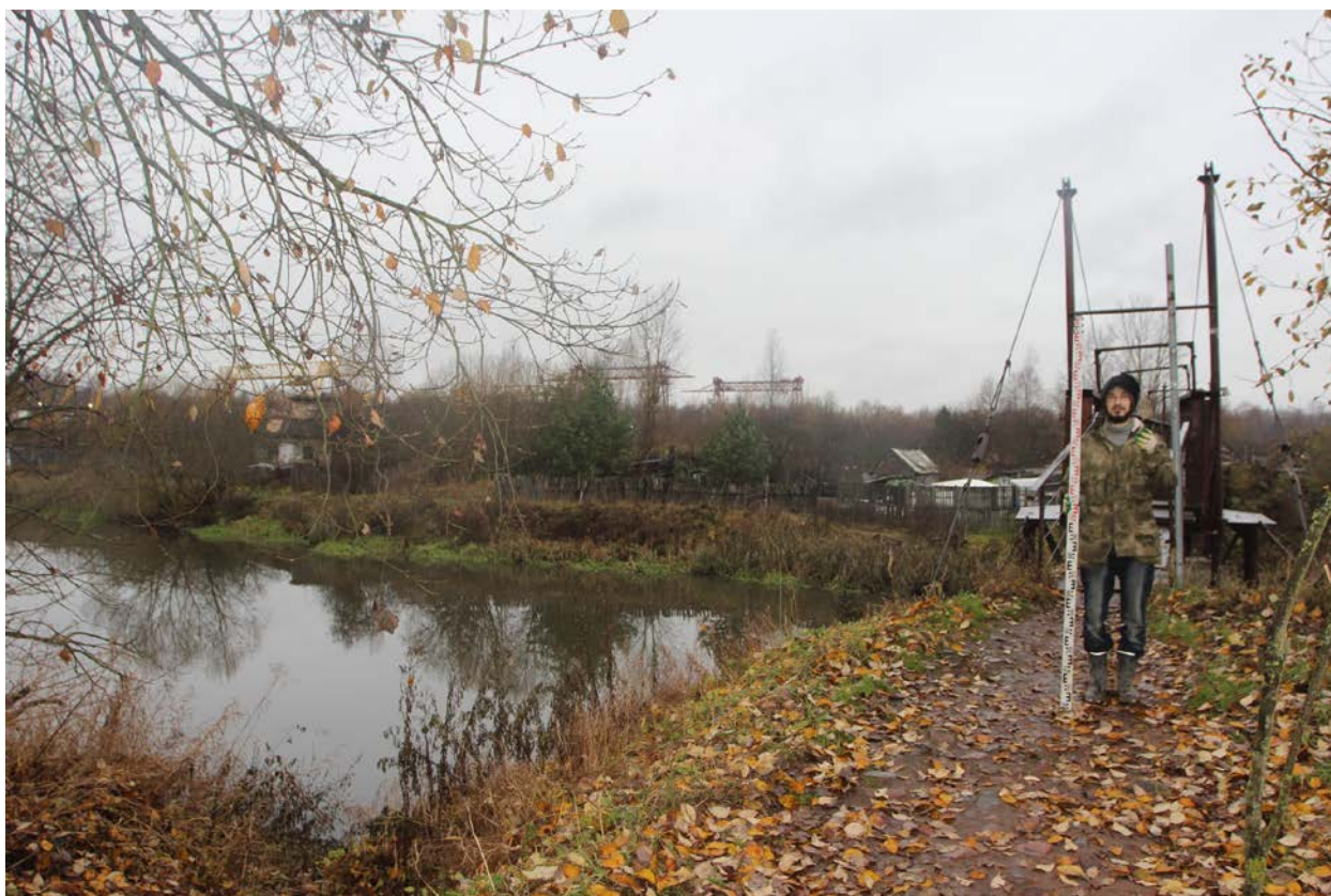
Рис. 19. Колпино-2023. Заречная улица, пешеходный мост. Точка фотофиксации 2, вид на северо-запад.
