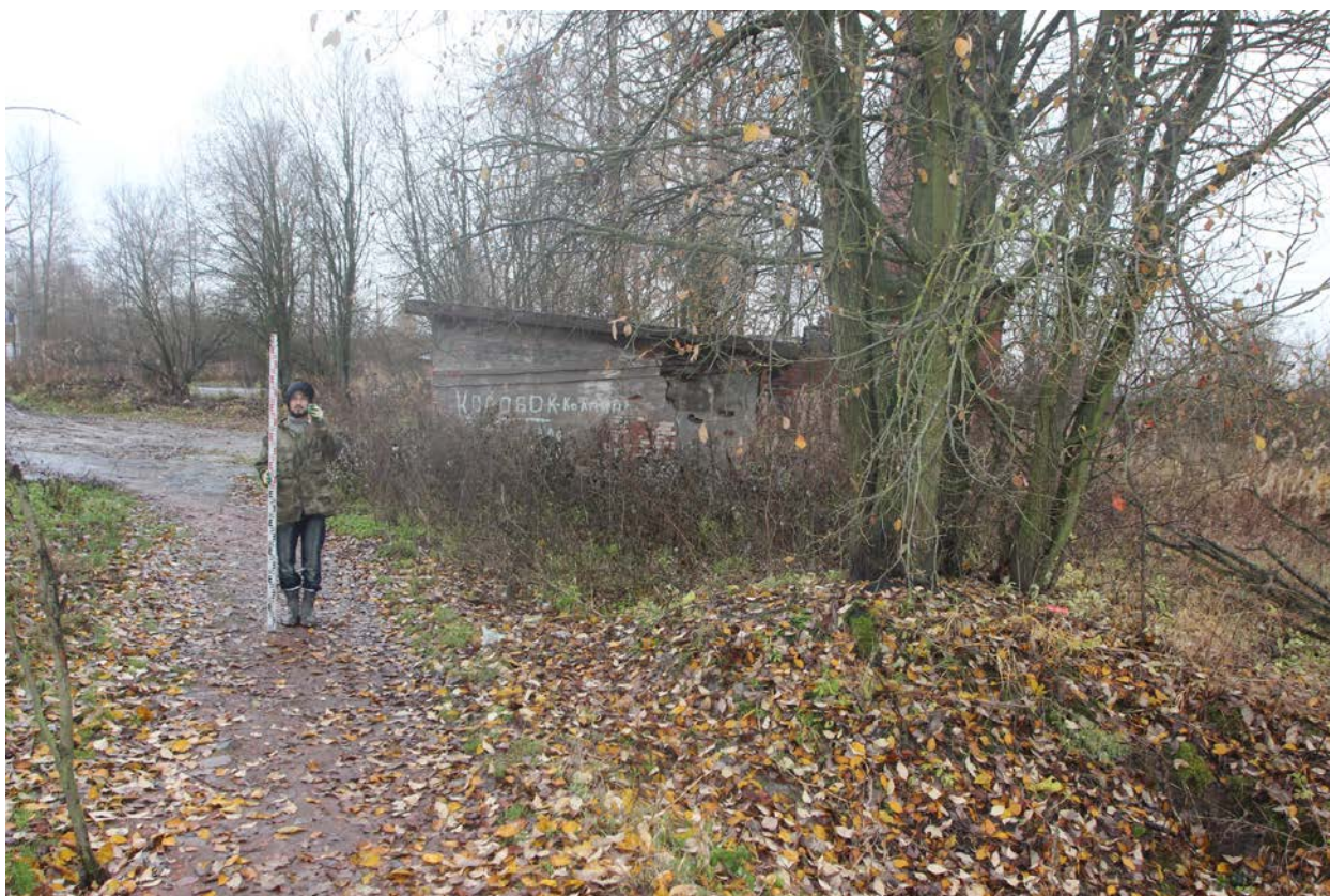
Рис. 21. Колпино-2023. Заречная улица, пешеходный мост. Точка фотофиксации 2, вид на юго-запад.
