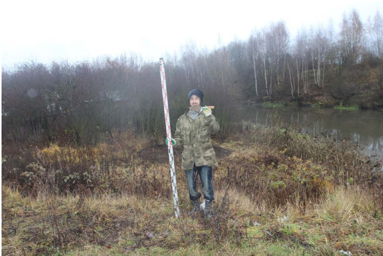
Рис. 14. Колпино-2023. Заречная улица, пешеходный мост. Точка фотофиксации 1, вид на восток.
