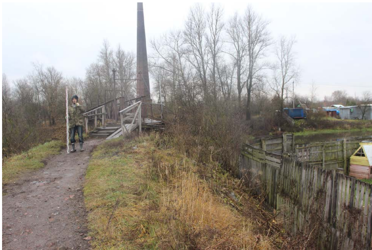
Рис. 12. Колпино-2023. Заречная улица, пешеходный мост. Точка фотофиксации 1, вид на юго-запад.
