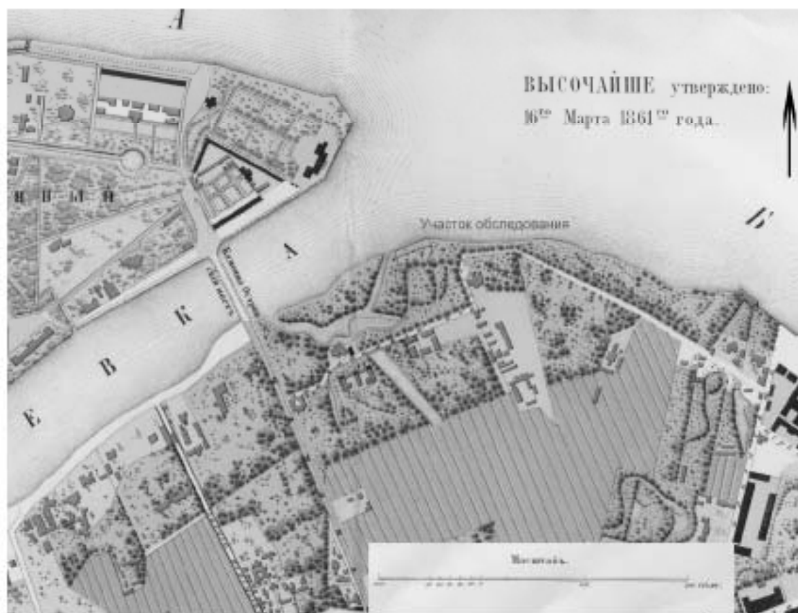
Рис. 12. Санкт-Петербург, ул. Академика Павлова, д. 11а (участок 1) и ул. Академика Павлова, д. 11 а, литера А. Участок обследования на фрагменте плана Петербургской части, 1861 г.
