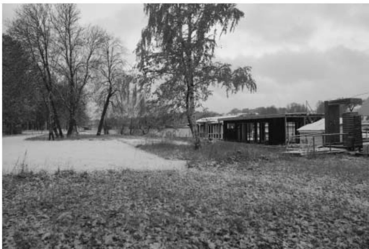
Рис. 22. Санкт-Петербург, ул. Академика Павлова, д. 11а (участок 1) и ул. Академика Павлова, д. 11 а, литера А. Общий вид на участок обследования и береговую линию с СВ
