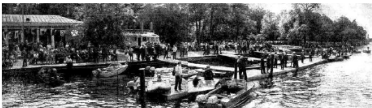
Рис. 7. Санкт-Петербург, ул. Академика Павлова, д. 11а (участок 1) и ул. Академика Павлова, д. 11 а, литера А. Вид на водную станцию в Лопухинском саду, 1972 г. (Источник: https://www.citywalls.ru/house/comm_image120-123166.jpg?mt=1696310035 ).
