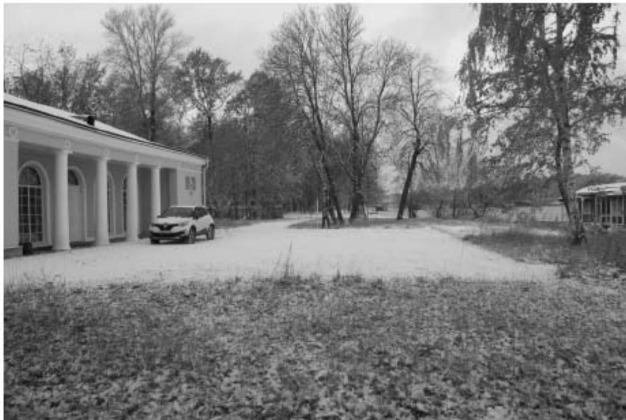
Рис. 17. Санкт-Петербург, ул. Академика Павлова, д. 11а (участок 1) и ул. Академика Павлова, д. 11 а, литера А. Общий вид на участок обследования и северный фасад Павильона водной станции с СВ.
