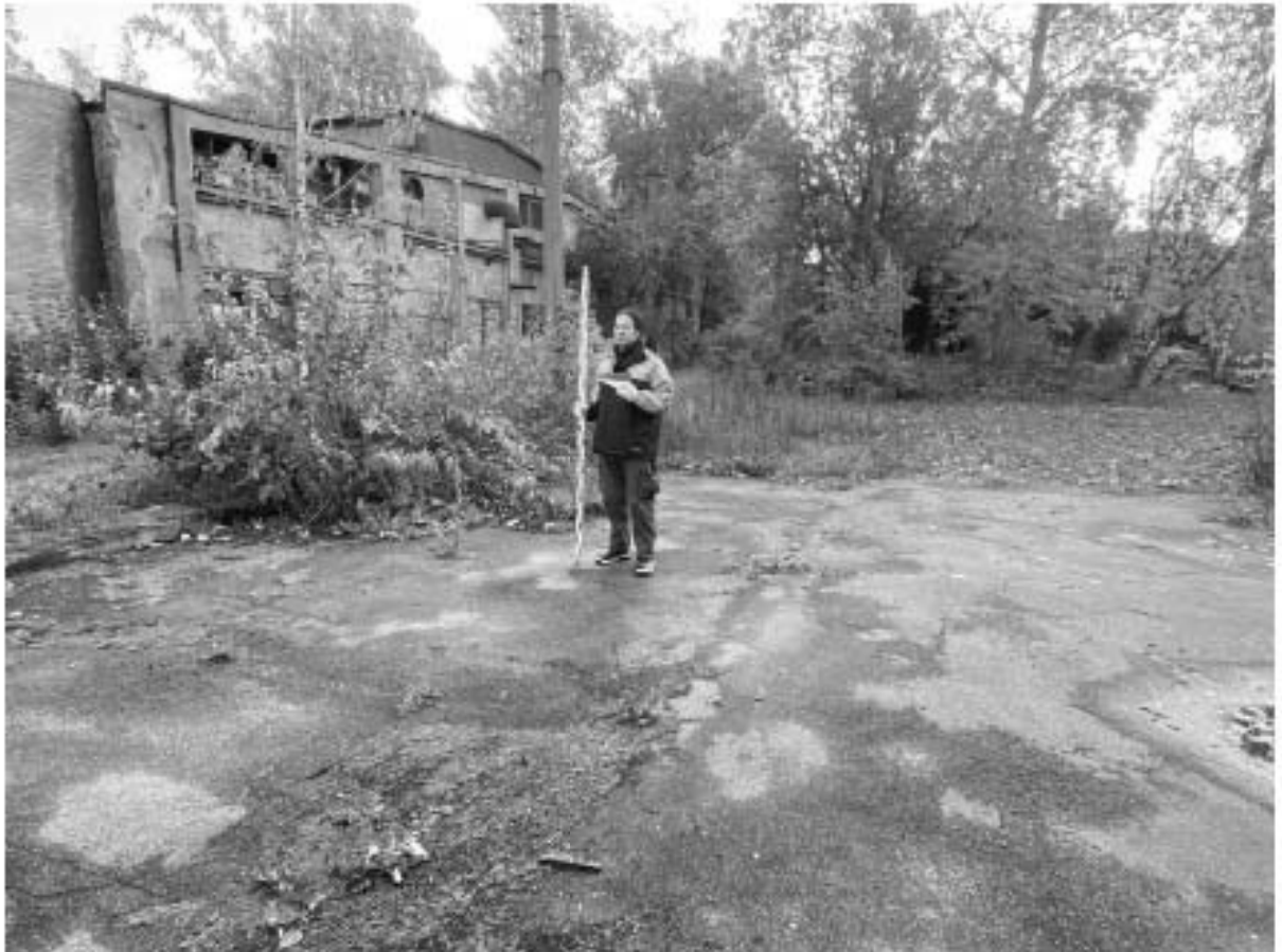
Рис. 28. СПб, Средний проспект В.О., дом 77, литера Ф (кадастровый номер: 78:06:0002076:17). Photo 3. Общий вид территории обследования. Вид с запада
