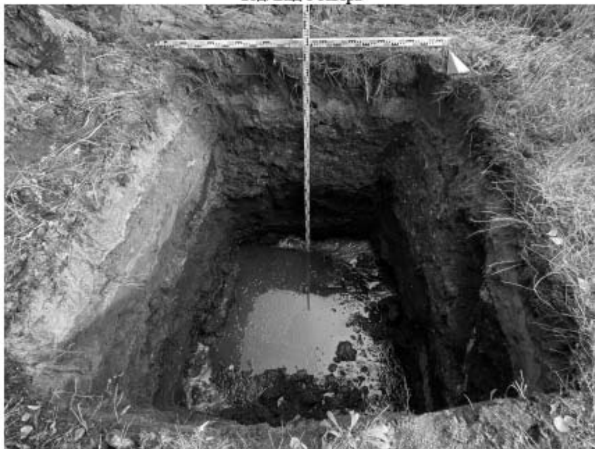
Рис. 60. СПб, Средний проспект В.О., дом 77, литера Ф (кадастровый номер: 78:06:0002076:17). Шурф 1. Фиксация дна шурфа по матерiku на уровне стояния грунтовых вод. Вид с юга
