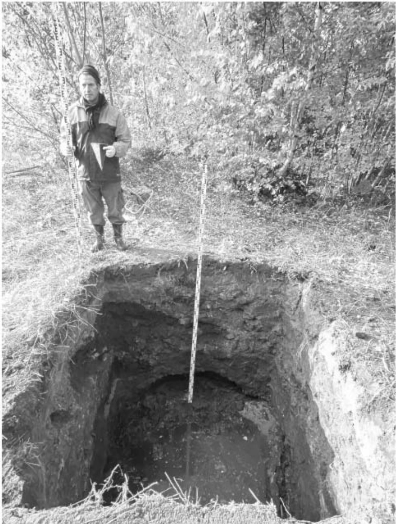
Рис. 58. СПб, Средний проспект В.О., дом 77, литера Ф (кадастровый номер: 78:06:0002076:17). Шурф 1. Фиксация дна шурфа по материке на уровне стояния грунтовых вод. Вид с севера
