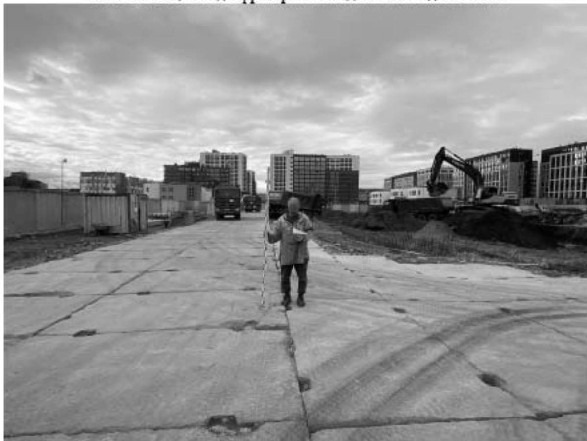
Рис. 21. СПб, проспект Энгельса, кадастровый номер земельного участка 78:36:0005354:8382. Photo 3. Общий вид территории обследования. Вид с востока
