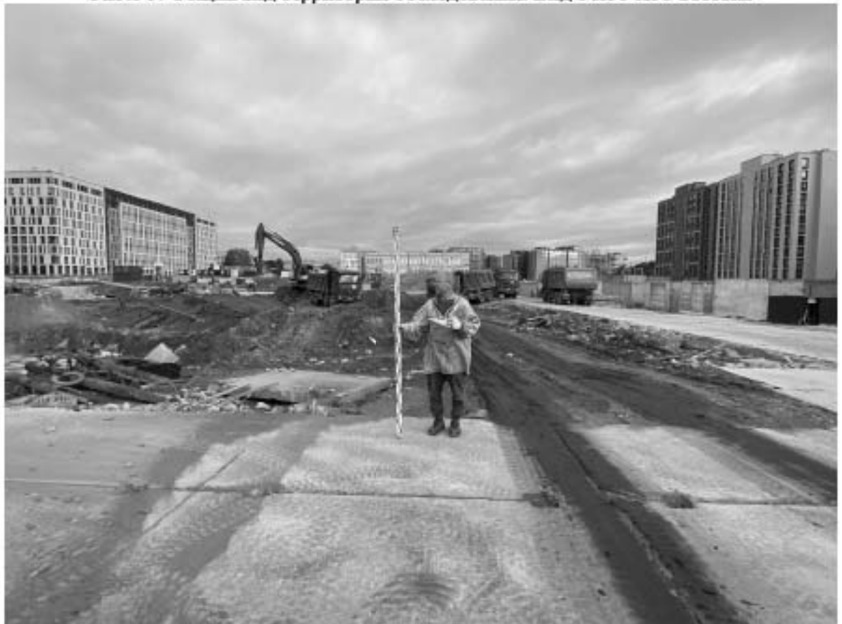
Рис. 29. СПб, проспект Энгельса, кадастровый номер земельного участка 78:36:0005354:8382. Photo 5. Общий вид территории обследования. Вид с запада
