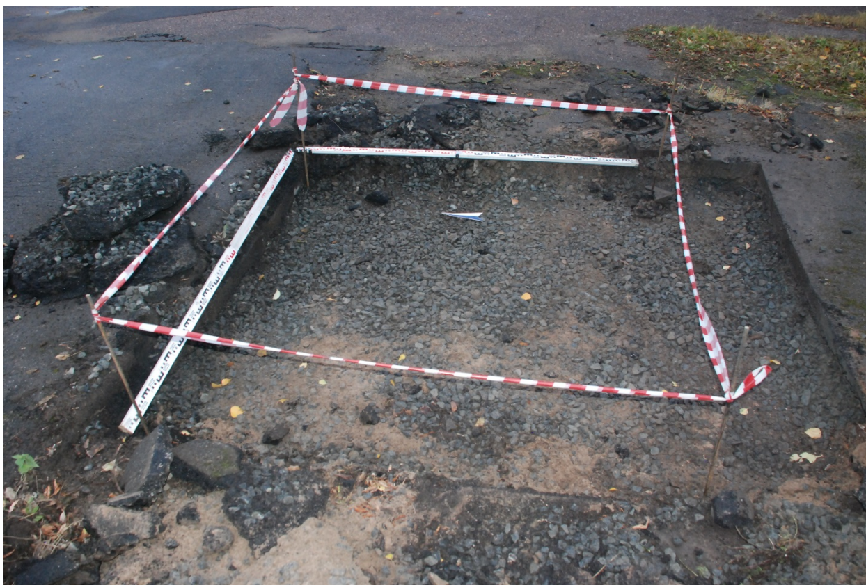
Рис. 25. Санкт-Петербург, Корабельная улица, д. 6, территория завода «Северная верфь». Шурф 1. Общий вид на шурф после снятия слоя асфальта. Вид с ЮЗ.
