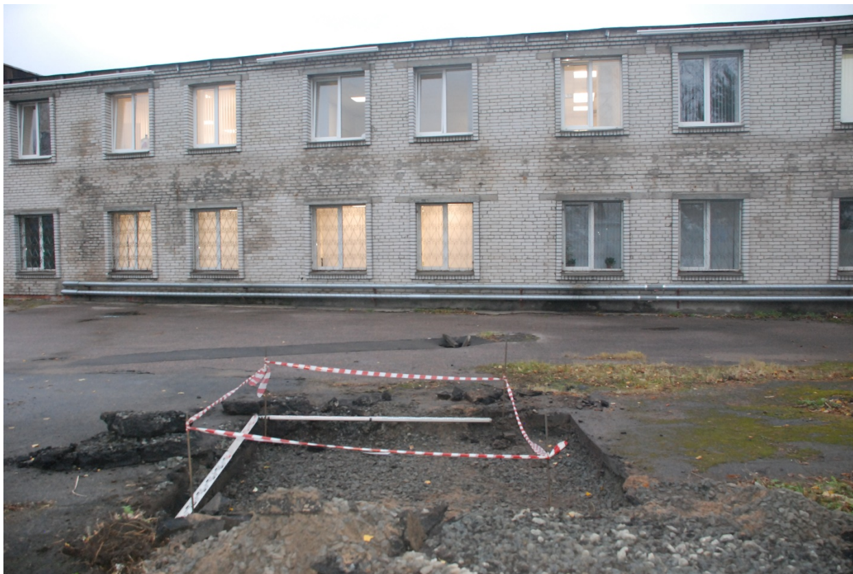
Рис. 24. Санкт-Петербург, Корабельная улица, д. 6, территория завода «Северная верфь». Шурф 1. Общий вид на шурф после снятия слоя асфальта. Вид с ЮЗ.
