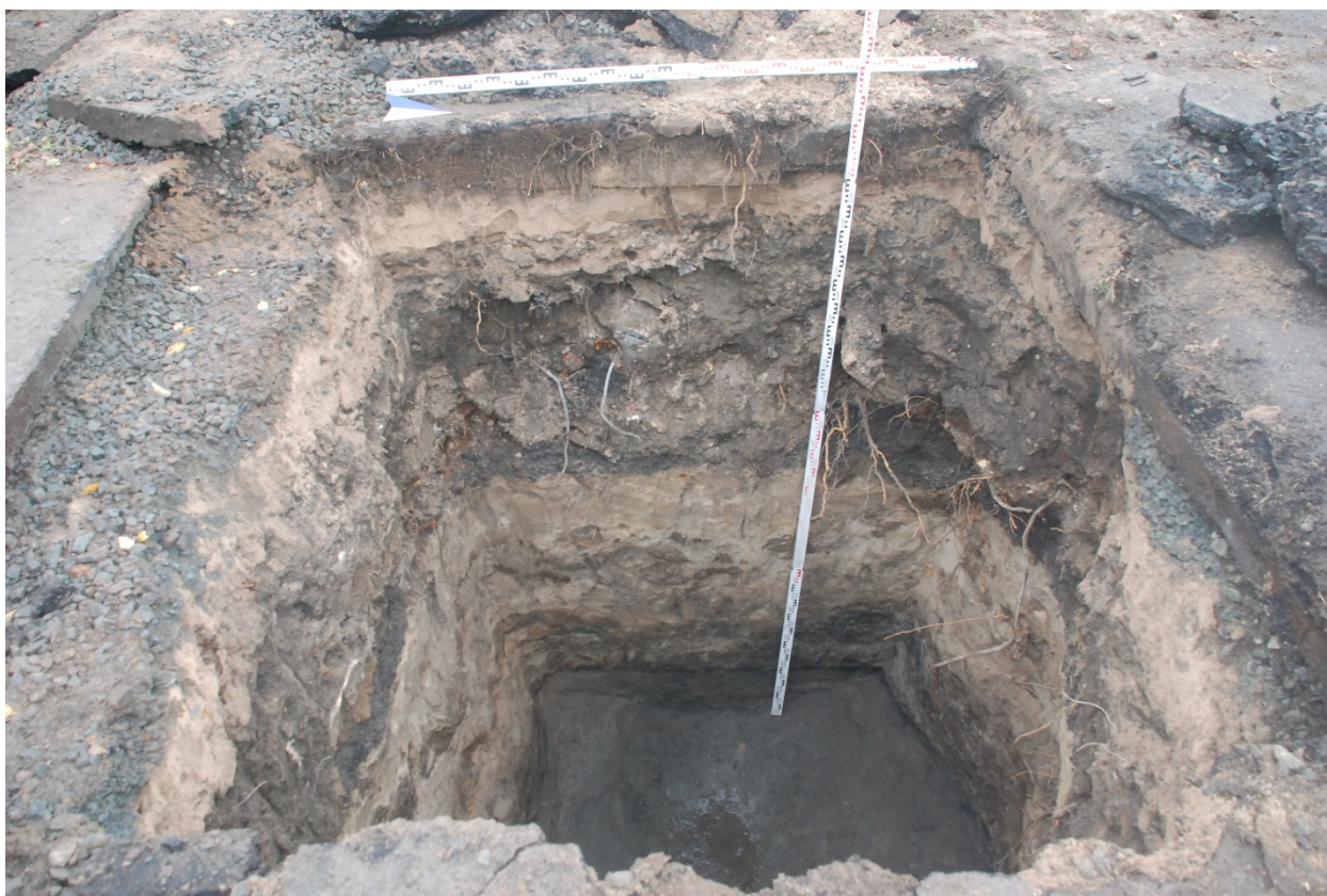
Рис. 31. Санкт-Петербург, Корабельная улица, д. 6, территория завода «Северная верфь». Шурф 1. Общий вид на шурф на уровне прекращения работ. Вид с СВ.
