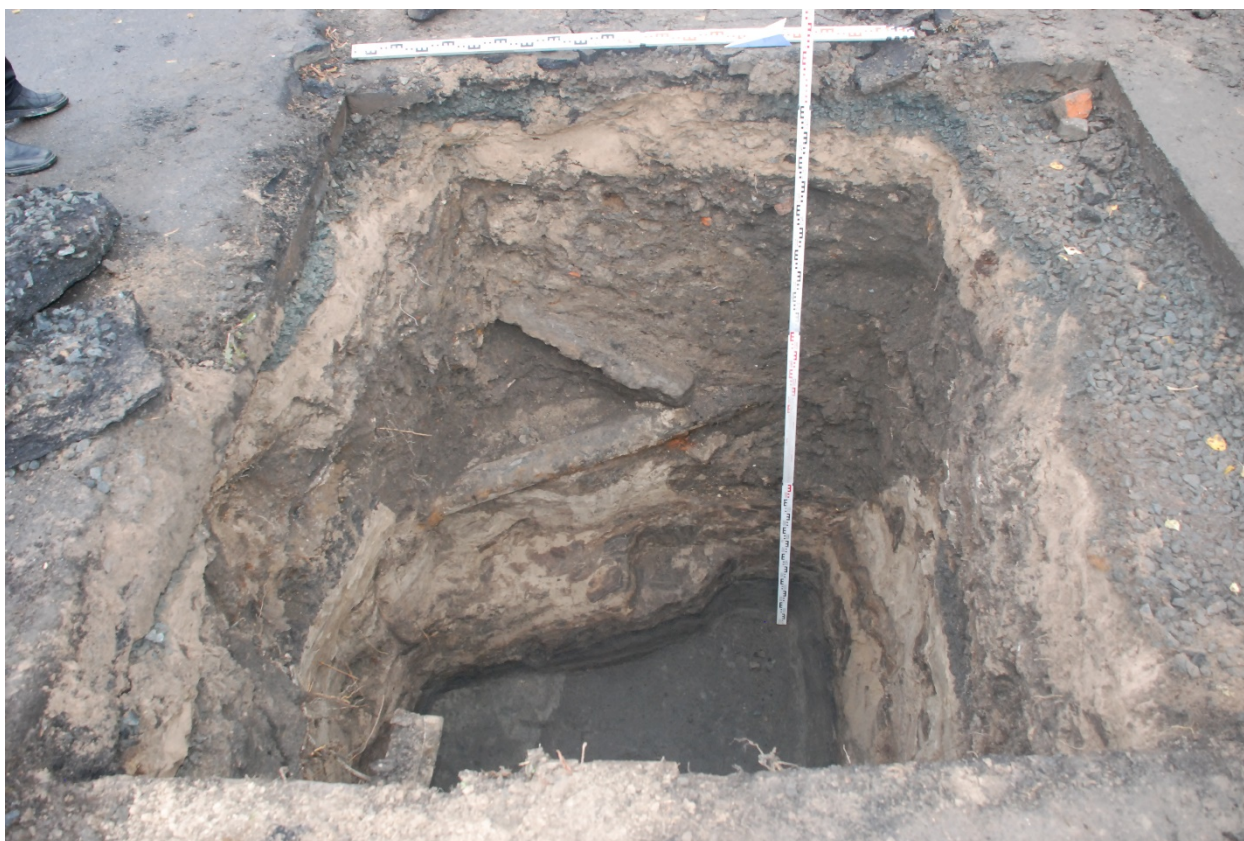
Рис. 29. Санкт-Петербург, Корабельная улица, д. 6, территория завода «Северная верфь». Шурф 1. Общий вид на шурф на уровне прекращения работ. Вид ЮЗ.
