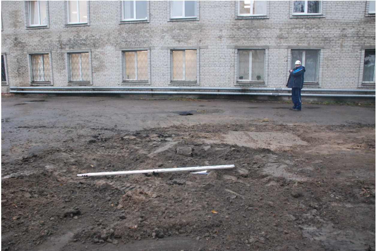
Рис. 39. Санкт-Петербург, Корабельная улица, д. 6, территория завода «Северная верфь». Шурф 1. Рекультивация. Вид с ЮЗ.
