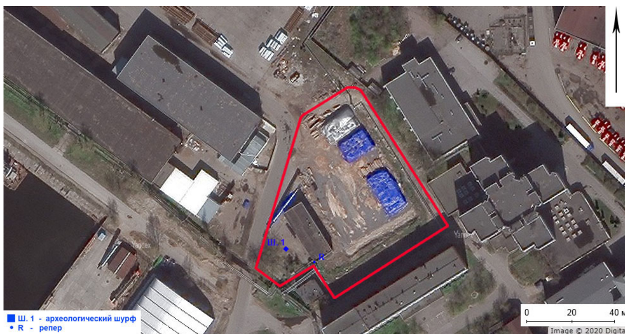
Рис. 4. Санкт-Петербург, Корабельная улица, д. 6, территория завода «Северная верфь». Участок обследования с указанием его границ, места закладки шурфа и репера на фрагменте спутникового снимка Яндекс (дата обращения 2020 г.).
