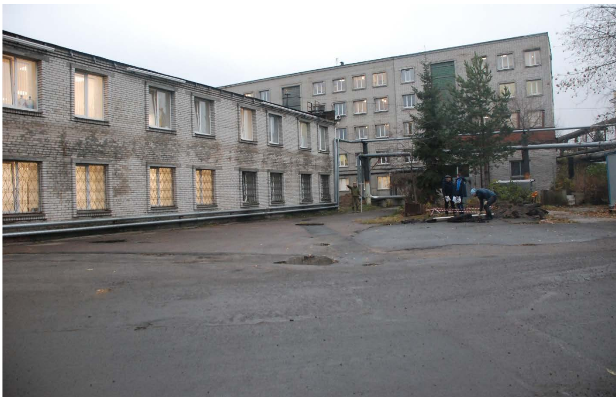
Рис. 13. Санкт-Петербург, Корабельная улица, д. 6, территория завода «Северная верфь». Общий вид на территорию обследования и место закладки шурфа (справа). Вид с СЗ.
