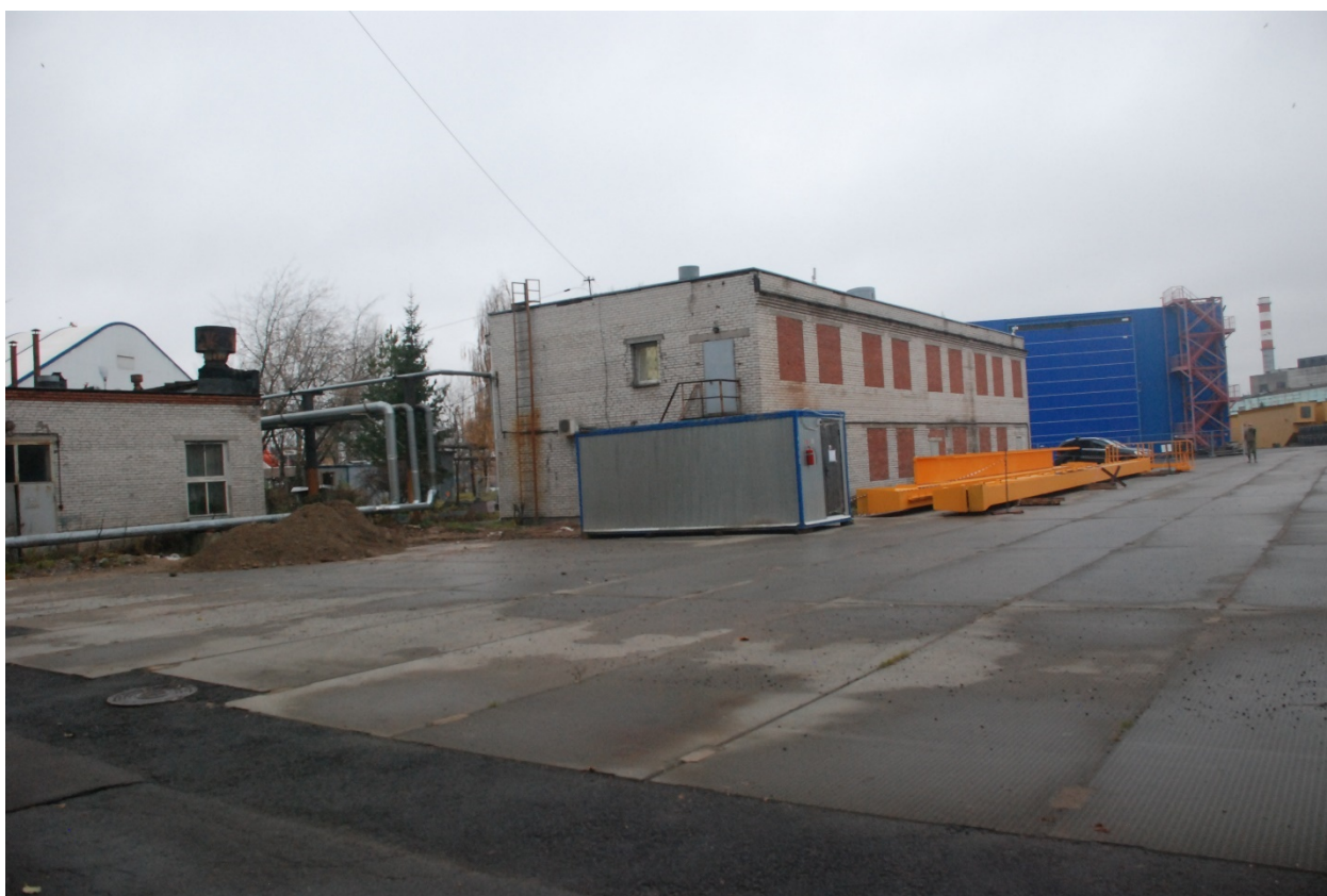
Рис. 20. Санкт-Петербург, Корабельная улица, д. 6, территория завода «Северная верфь». Общий вид на территорию обследования. Вид с ВЮВ.
