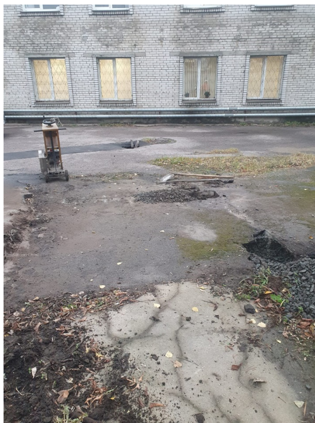
Рис. 23. Санкт-Петербург, Корабельная улица, д. 6, территория завода «Северная верфь». Шурф 1. Вид до начала работ в процессе снятия асфальта. Вид с ЮЗ.
