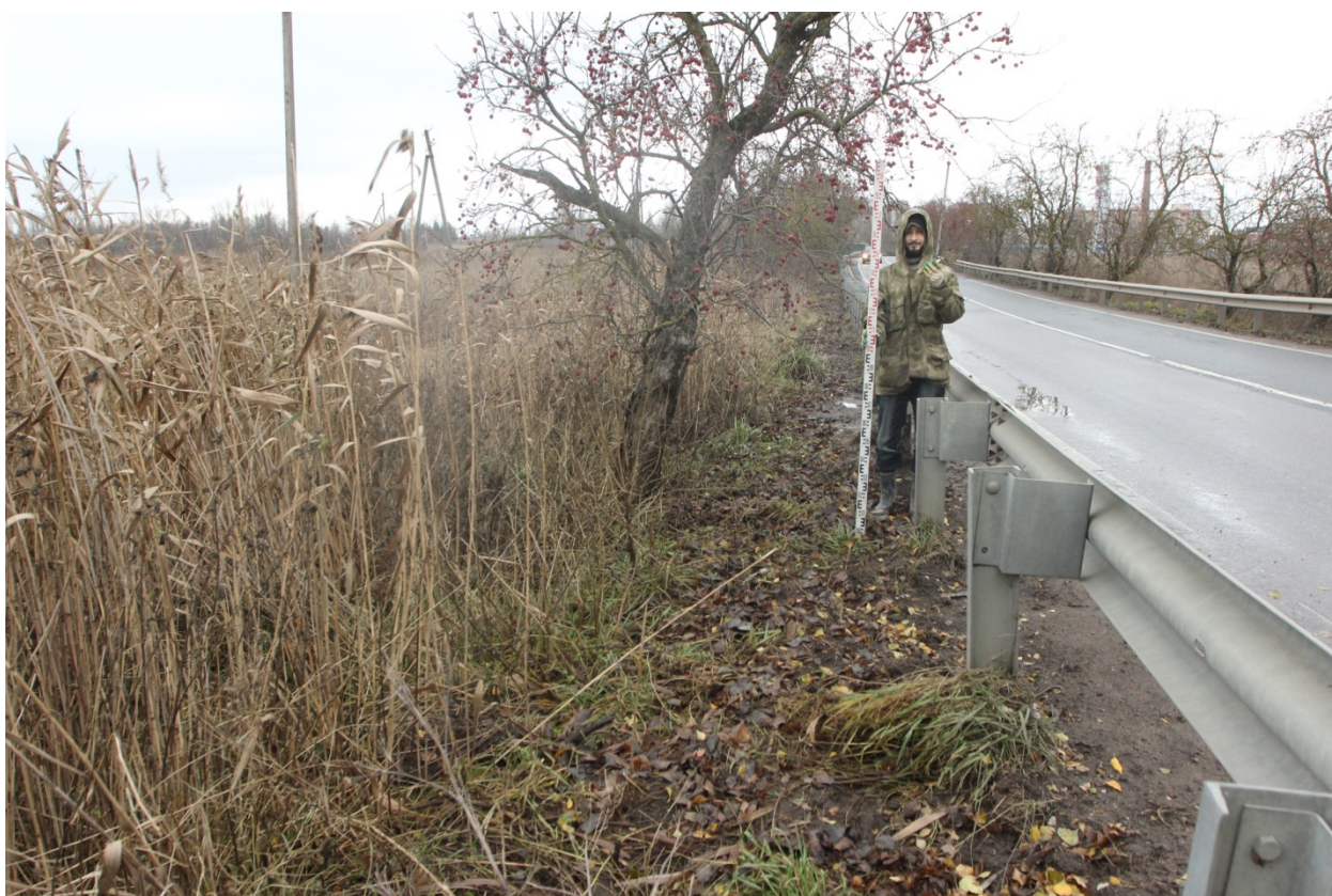
Рис. 15. Шушары-2023. Мост через ручей б.н 1736. Точка фотофиксации 3, вид на северо-запад.
