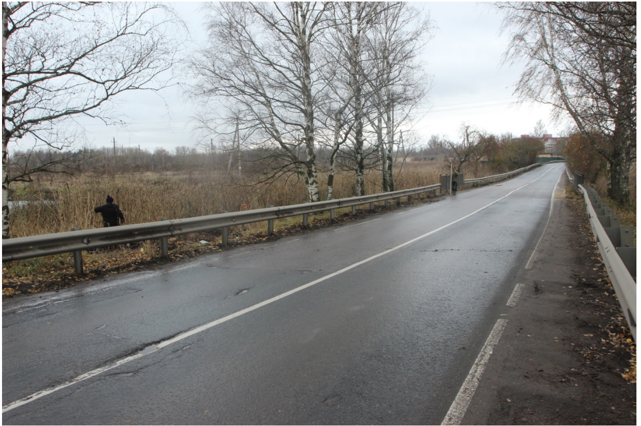
Рис. 12. Шушары-2023. Мост через ручей б.н 1736. Точка фотофиксации 1, вид на запад.
