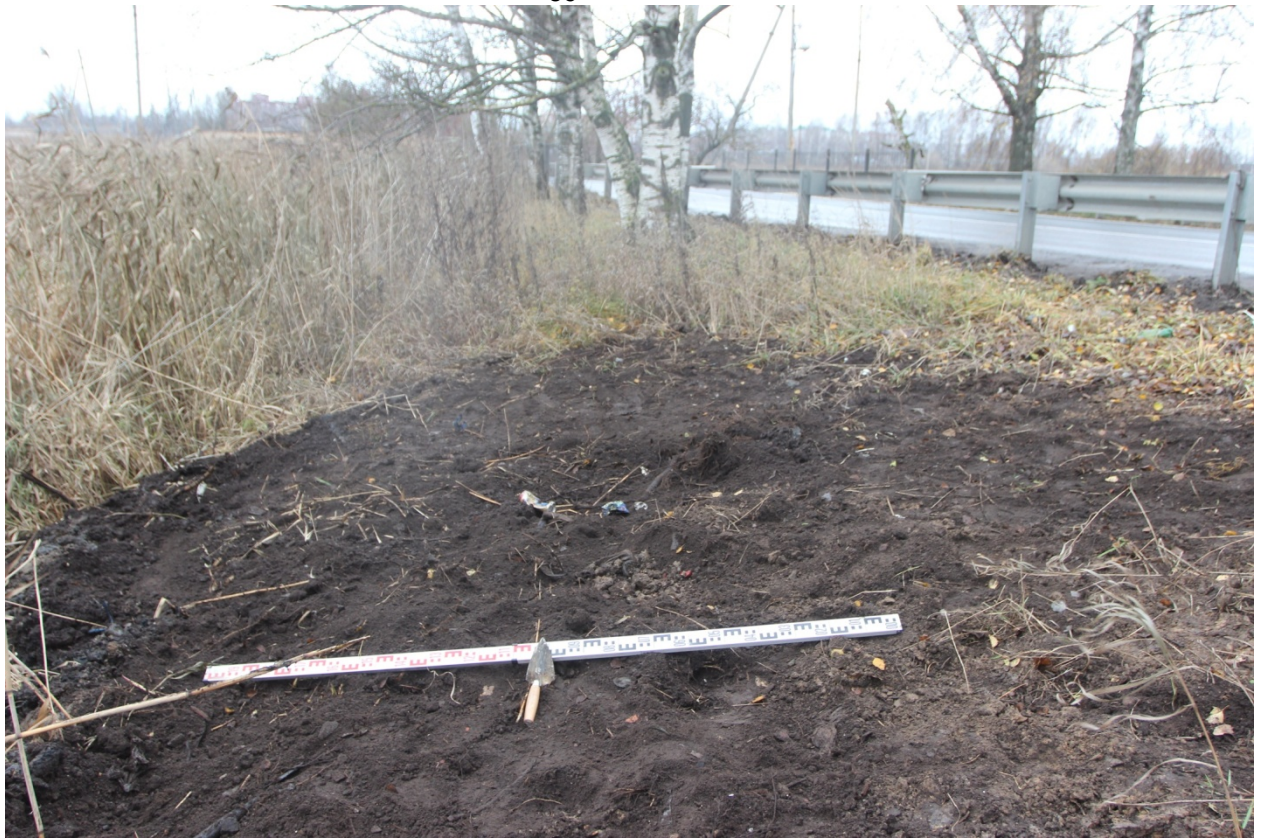
Рис. 30. Шушары-2023. Мост через ручей б.н 1736. Шурф 1, после рекультивации, вид на север.
