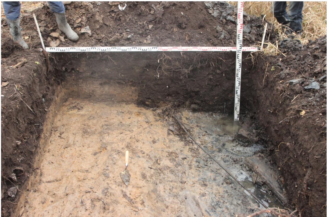
Рис. 29. Шушары-2023. Мост через ручей б.н 1736. Шурф 1, фиксация по уровню окончания работ, южная стенка.
