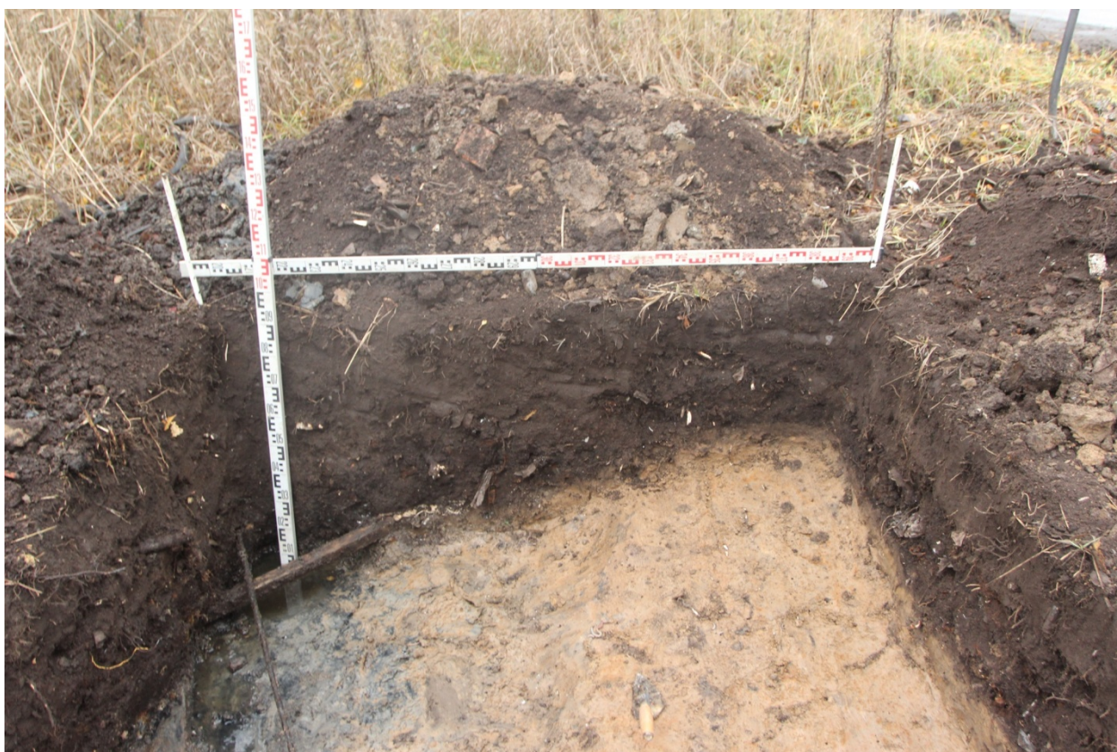
Рис. 23. Шушары-2023. Мост через ручей б.н 1736. Шурф 1, фиксация по уровню окончания работ, северная стенка.
