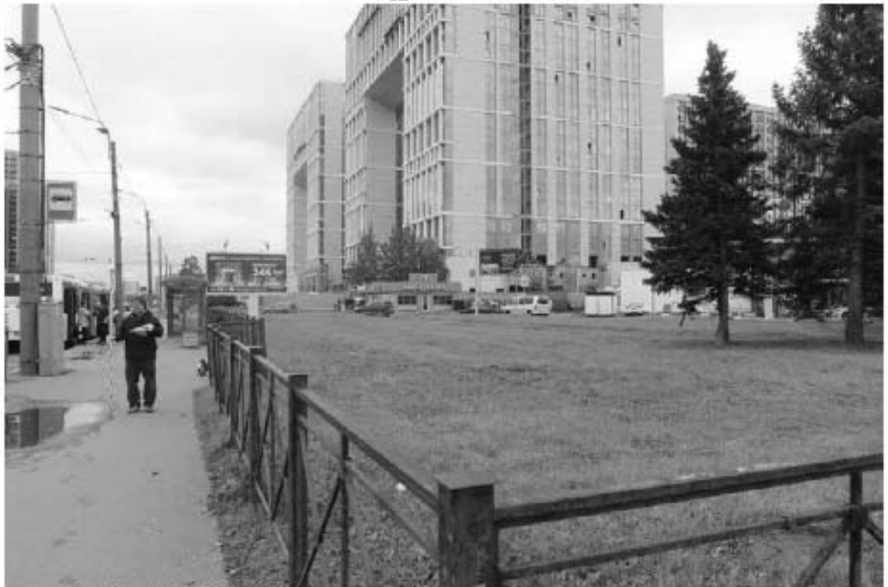
Рис. 31. СПб-2023. ПС Чесменская. Точка фотофиксации 8, вид на юго-восток.
