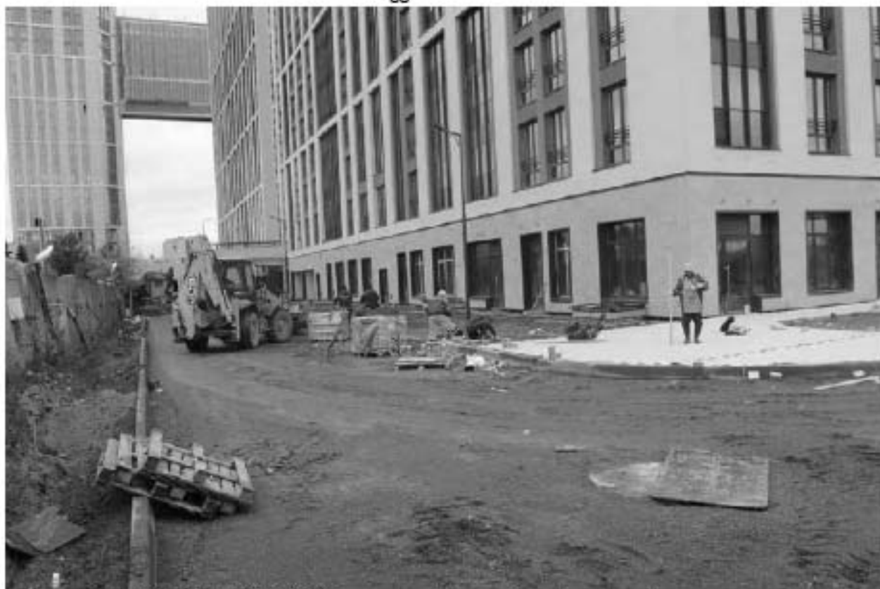
Рис. 23. СПб-2023. ПС Чесменская. Точка фотофиксации 4, вид на север.
