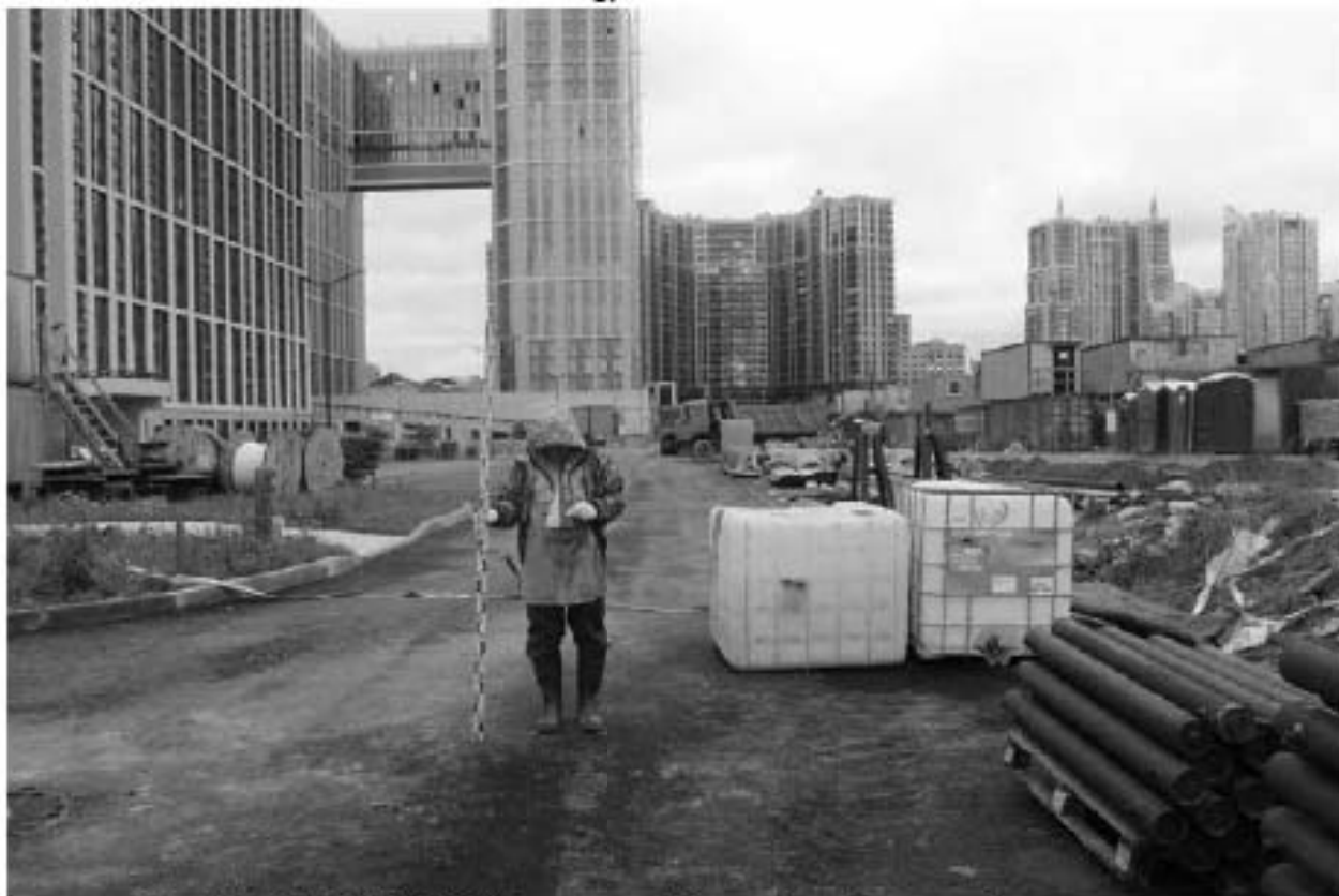
Рис. 21. СПб-2023. ПС Чесменская. Точка фотофиксации 3, вид на север.
