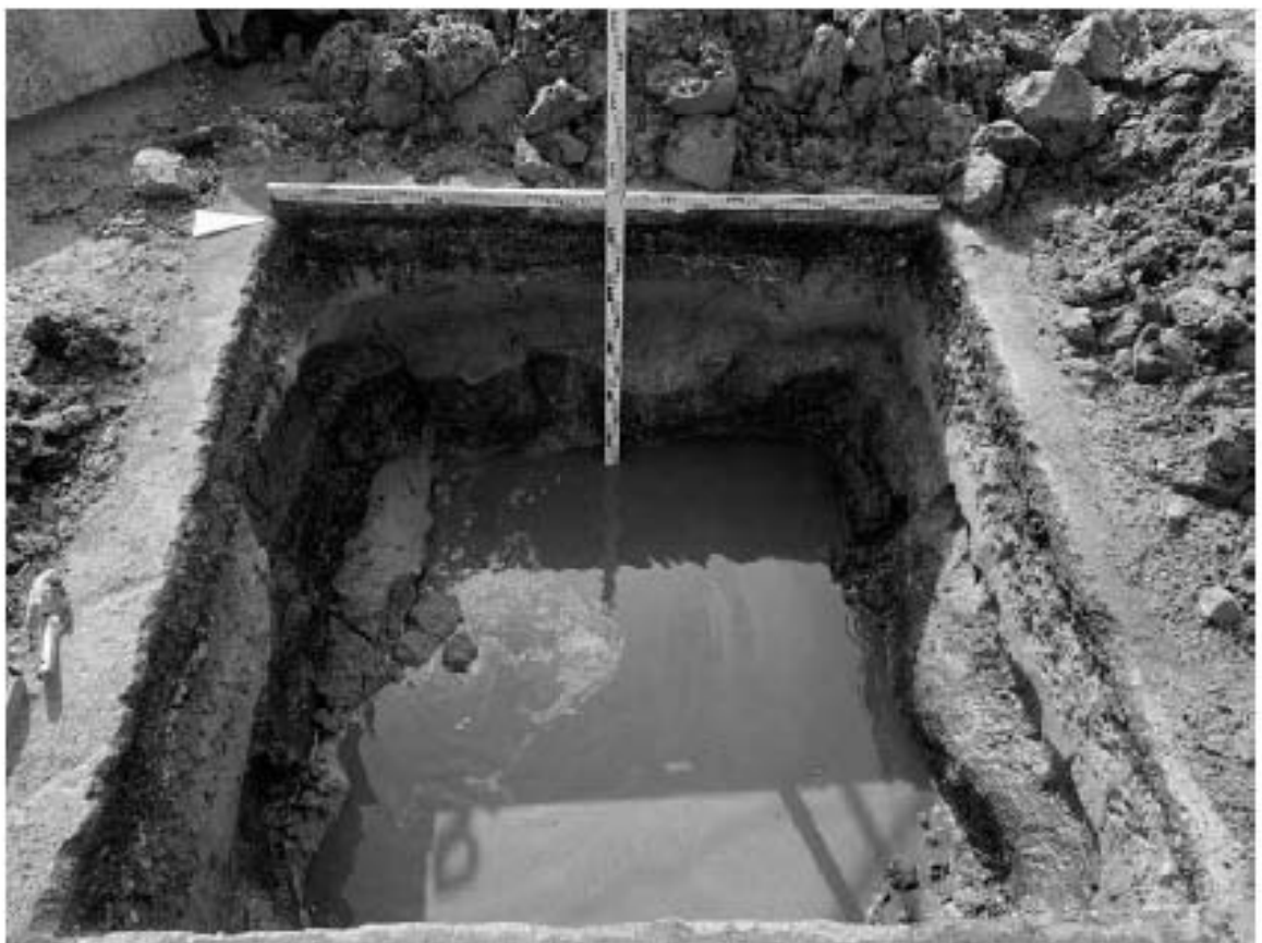
Рис. 54. СПб-2023. ПС Чесменская. Шурф 1, фиксация по уровню окончания работ, вид на запад.
