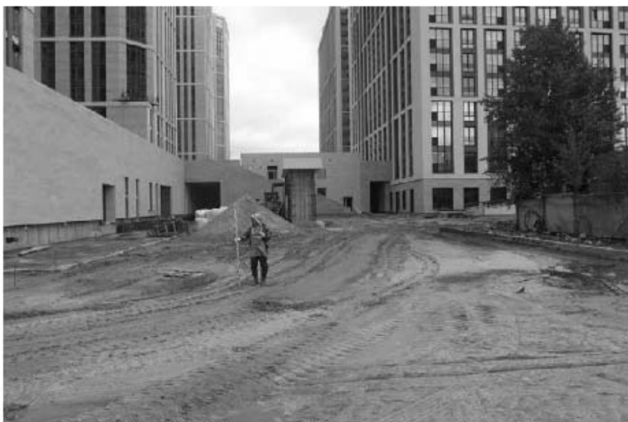
Рис. 26. СПб-2023. ПС Чесменская. Точка фотофиксации 5, вид на восток.
