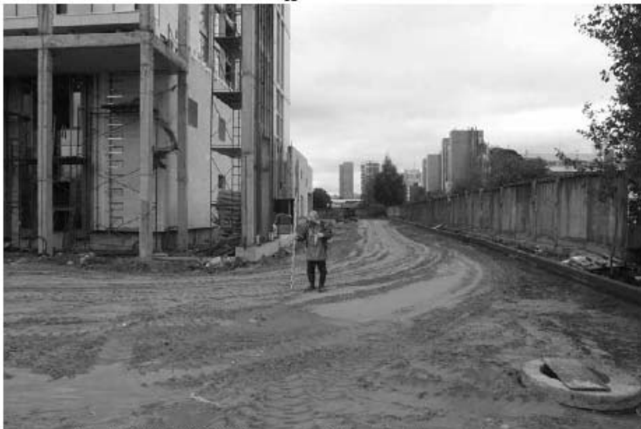
Рис. 27. СПб-2023. ПС Чесменская. Точка фотофиксации 6, вид на юг.
