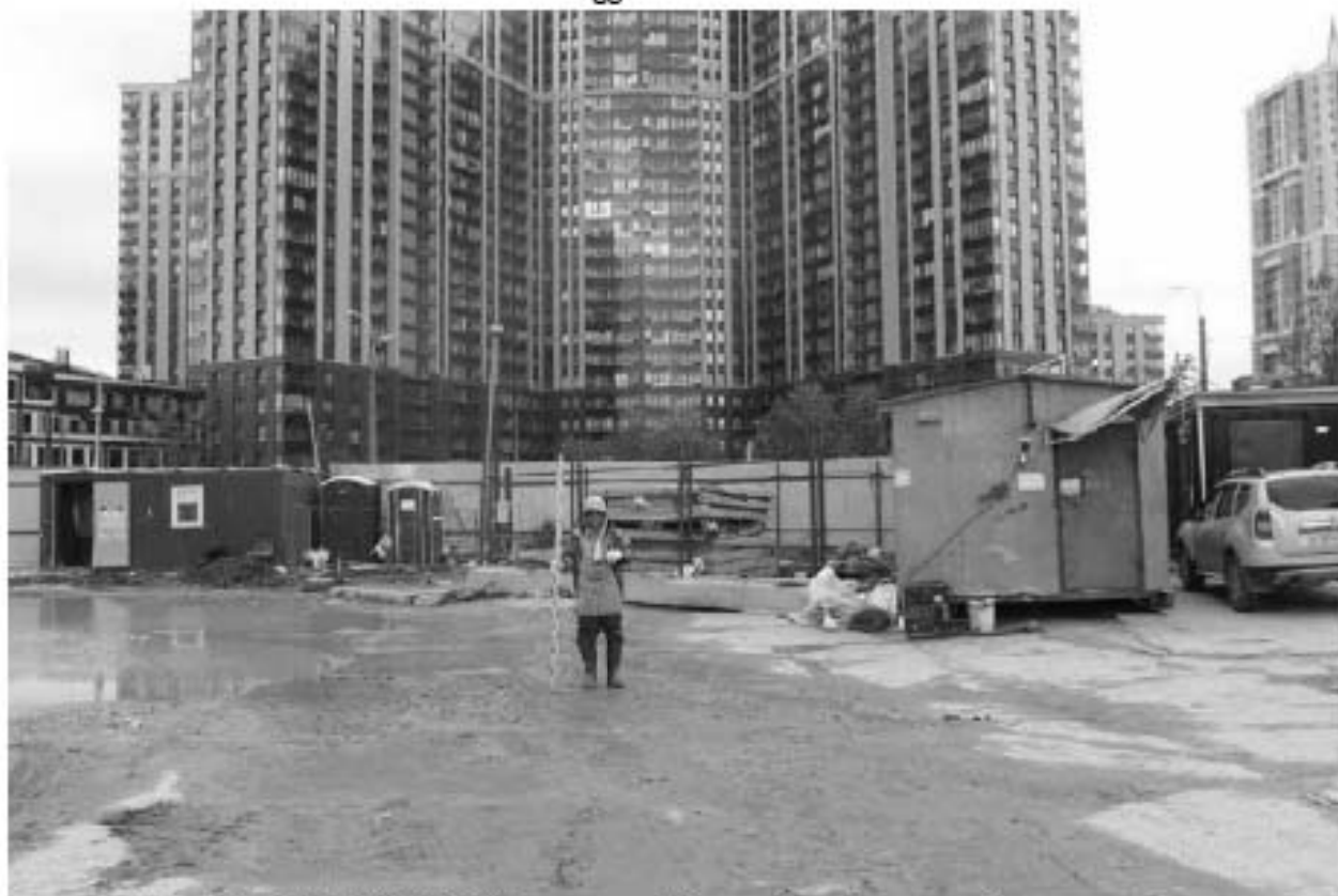
Рис. 13. СПб-2023. ПС Чесменская. Точка фотофиксации 1, вид на север.
