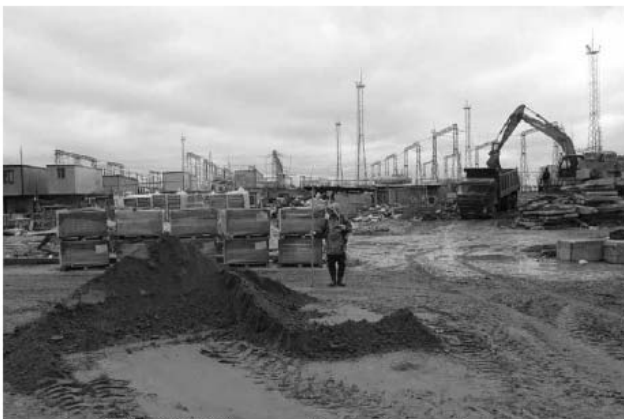
Рис. 20. СПб-2023. ПС Чесменская. Точка фотофиксации 2, вид на восток.
