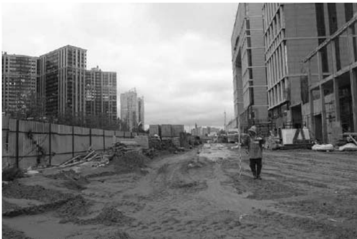
Рис. 28. СПб-2023. ПС Чесменская. Точка фотофиксации 6, вид на восток.
