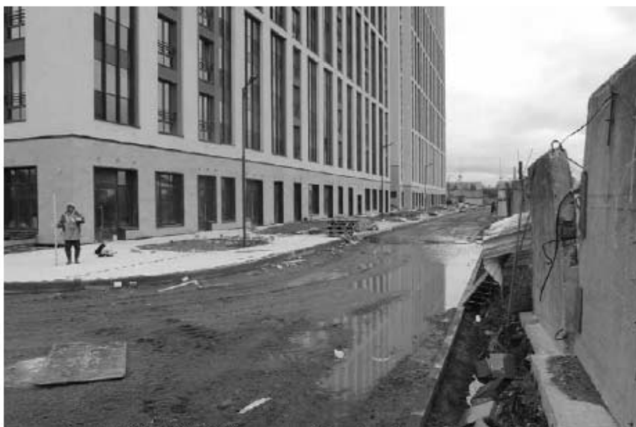
Рис. 24. СПб-2023. ПС Чесменская. Точка фотофиксации 4, вид на восток.
