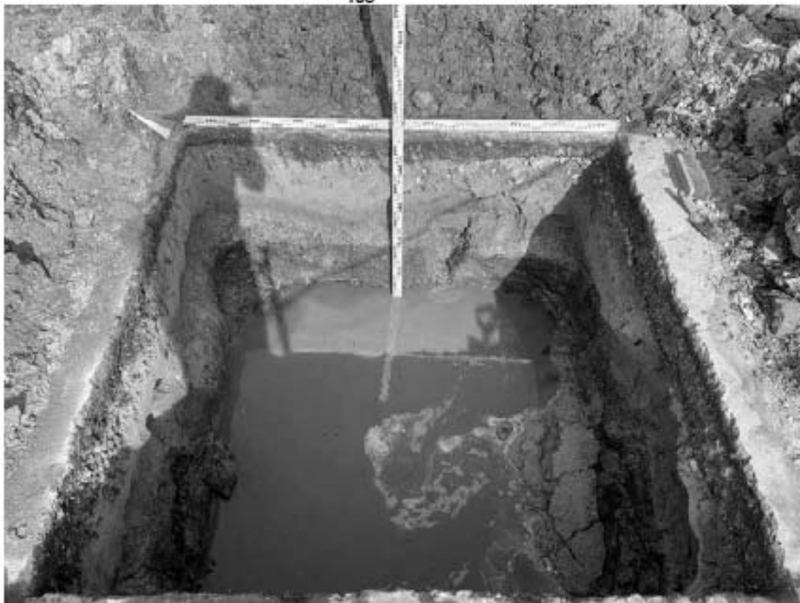
Рис. 57. СПб-2023. ПС Чесменская. Шурф 1, фиксация по уровню окончания работ, вид на восток, восточная стенка.
