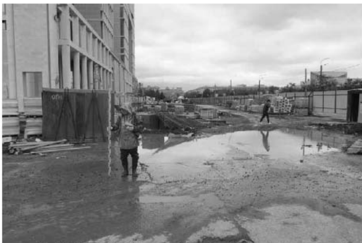
Рис. 14. СПб-2023. ПС Чесменская. Точка фотофиксации 1, вид на запад.
