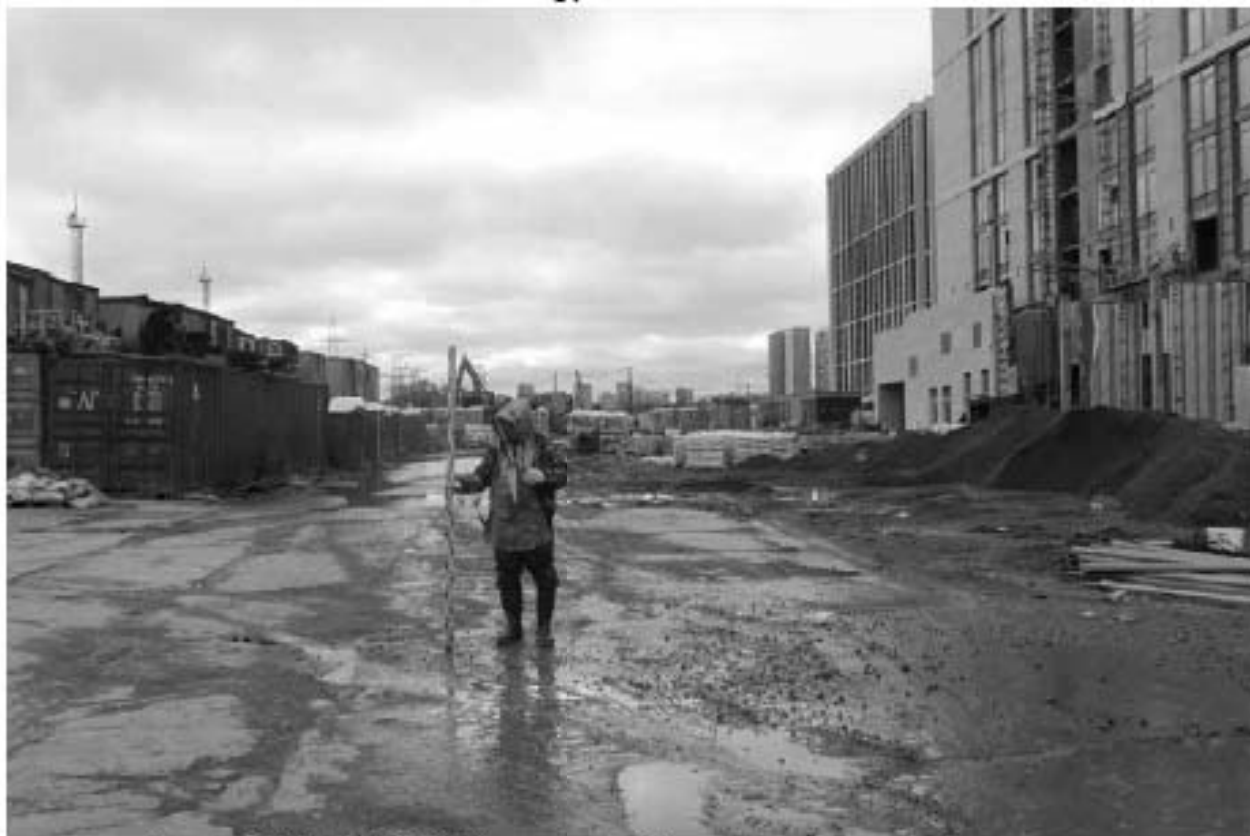
Рис. 15. СПб-2023. ПС Чесменская. Точка фотофиксации 1, вид на юг.
