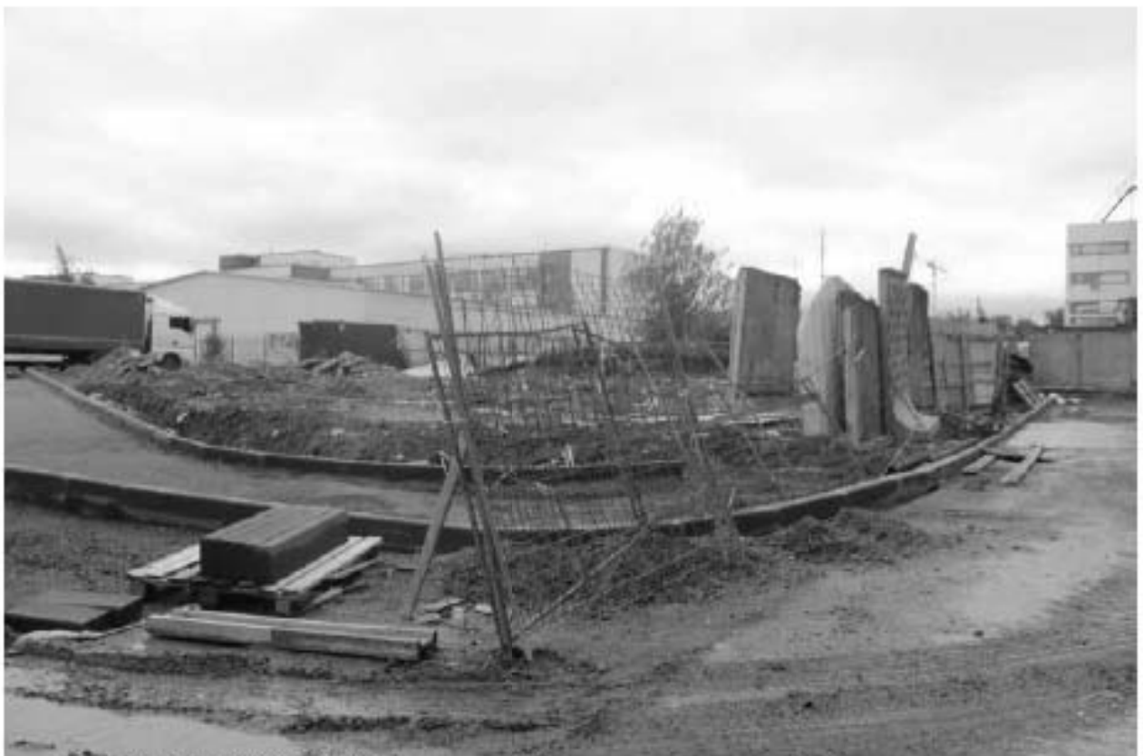
Рис. 52. СПб-2023. ПС Чесменская. Местоположение шурфа 1, вид на юго-запад.
