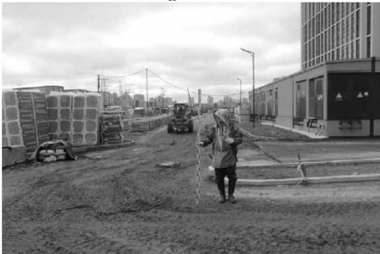
Рис. 19. СПб-2023. ПС Чесменская. Точка фотофиксации 2, вид на юг.
