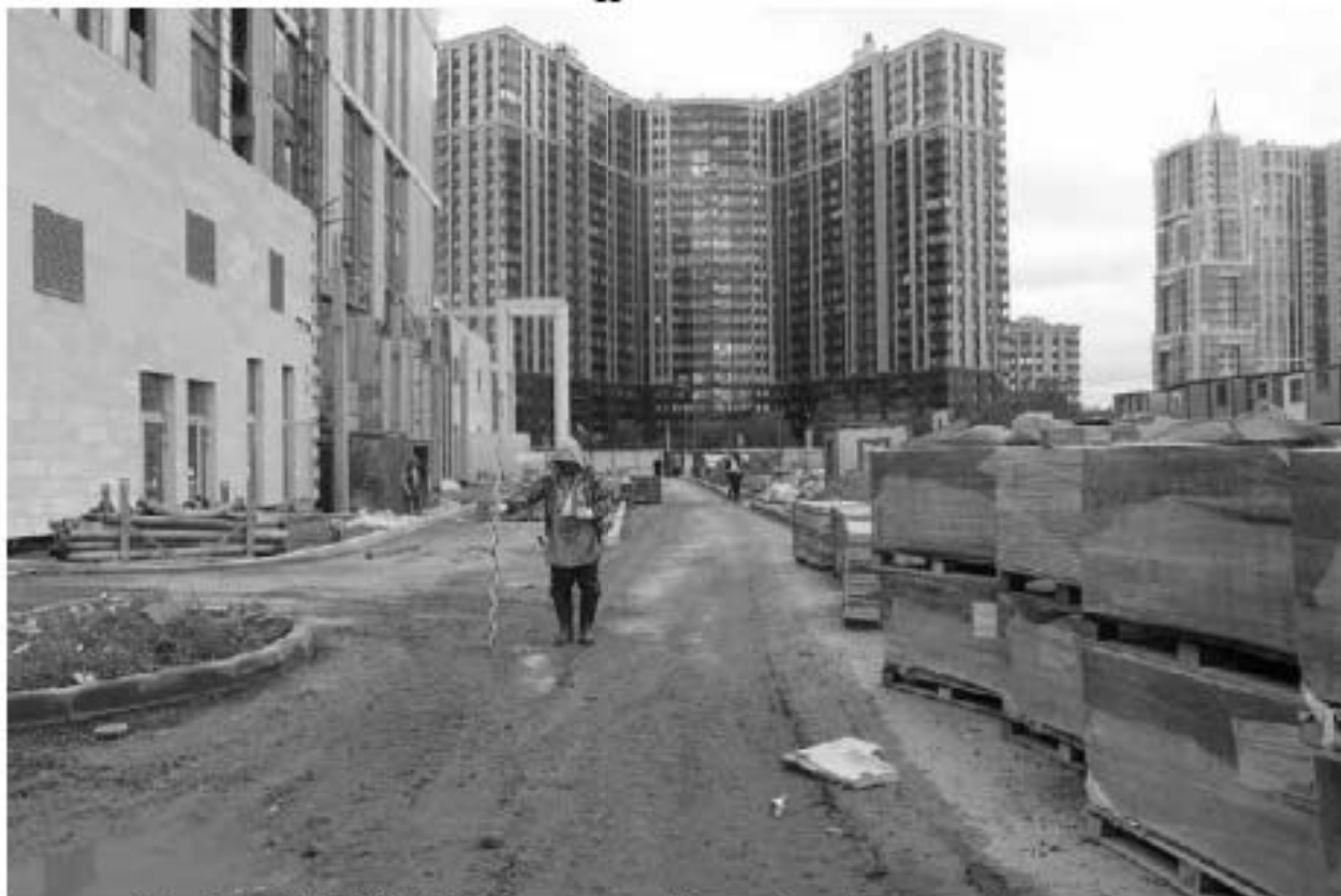
Рис. 17. СПб-2023. ПС Чесменская. Точка фотофиксации 2, вид на север.
