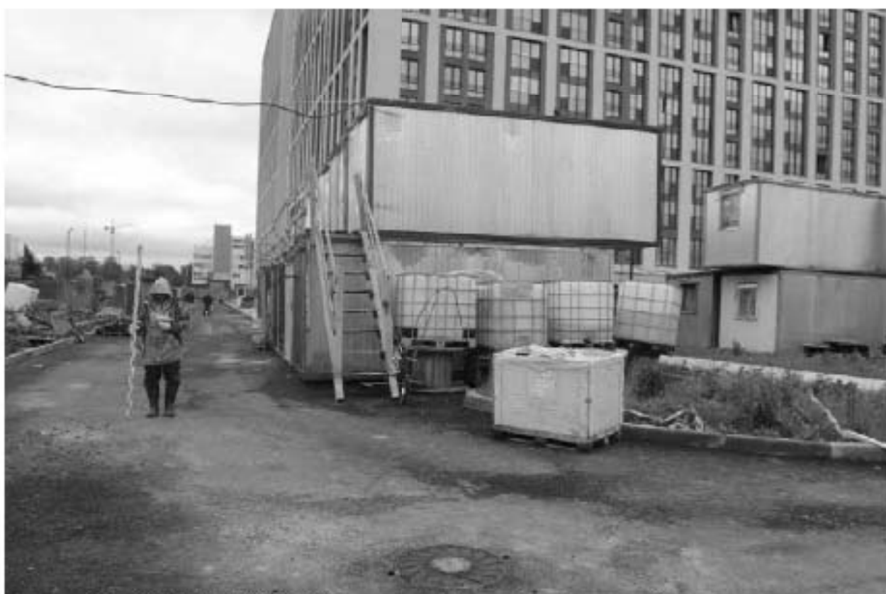
Рис. 22. СПб-2023. ПС Чесменская. Точка фотофиксации 3, вид на запад.
