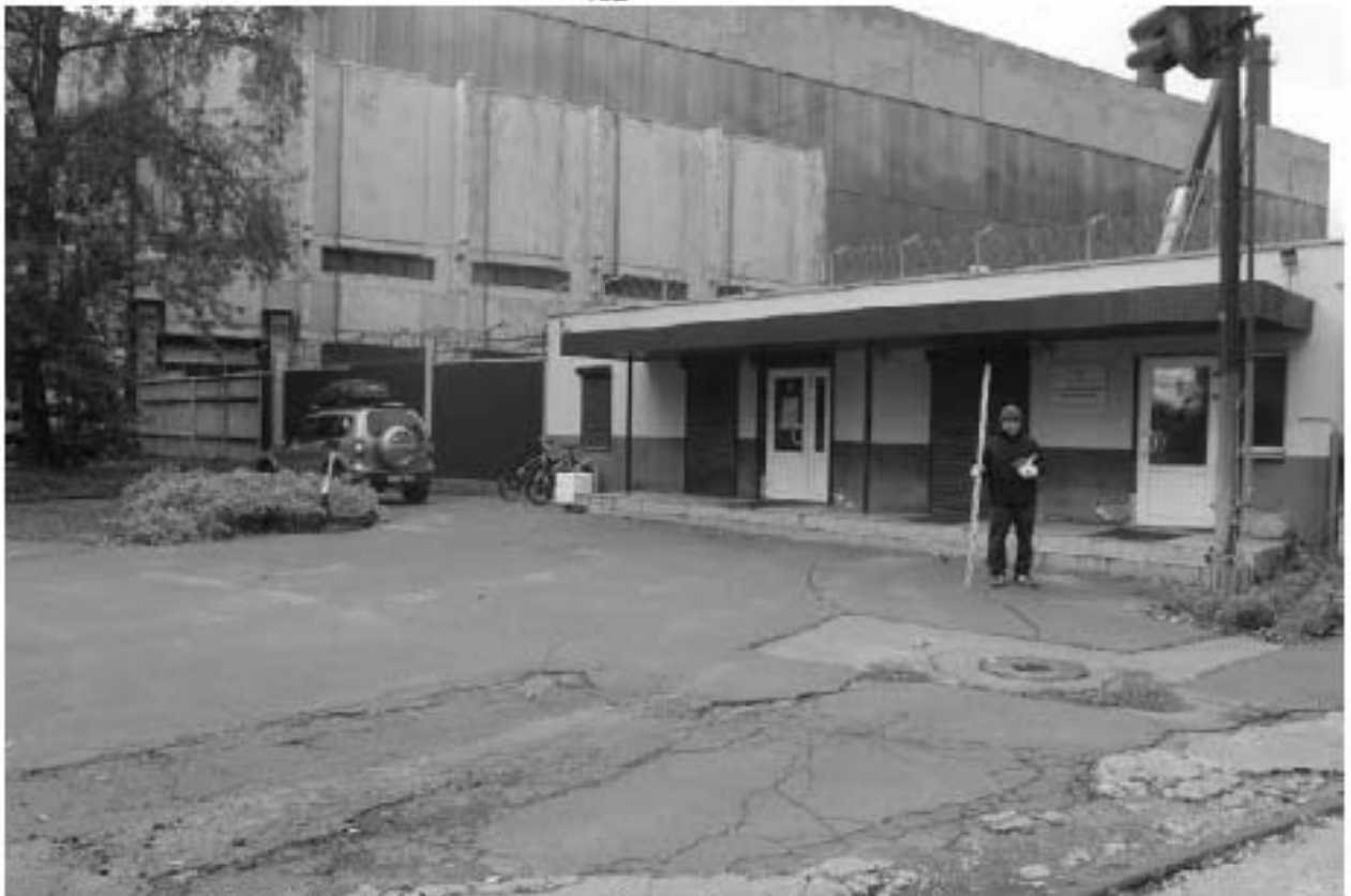
Рис. 51. СПб-2023. ПС Чесменская. Точка фотофиксации 18, вид на северо-запад.
