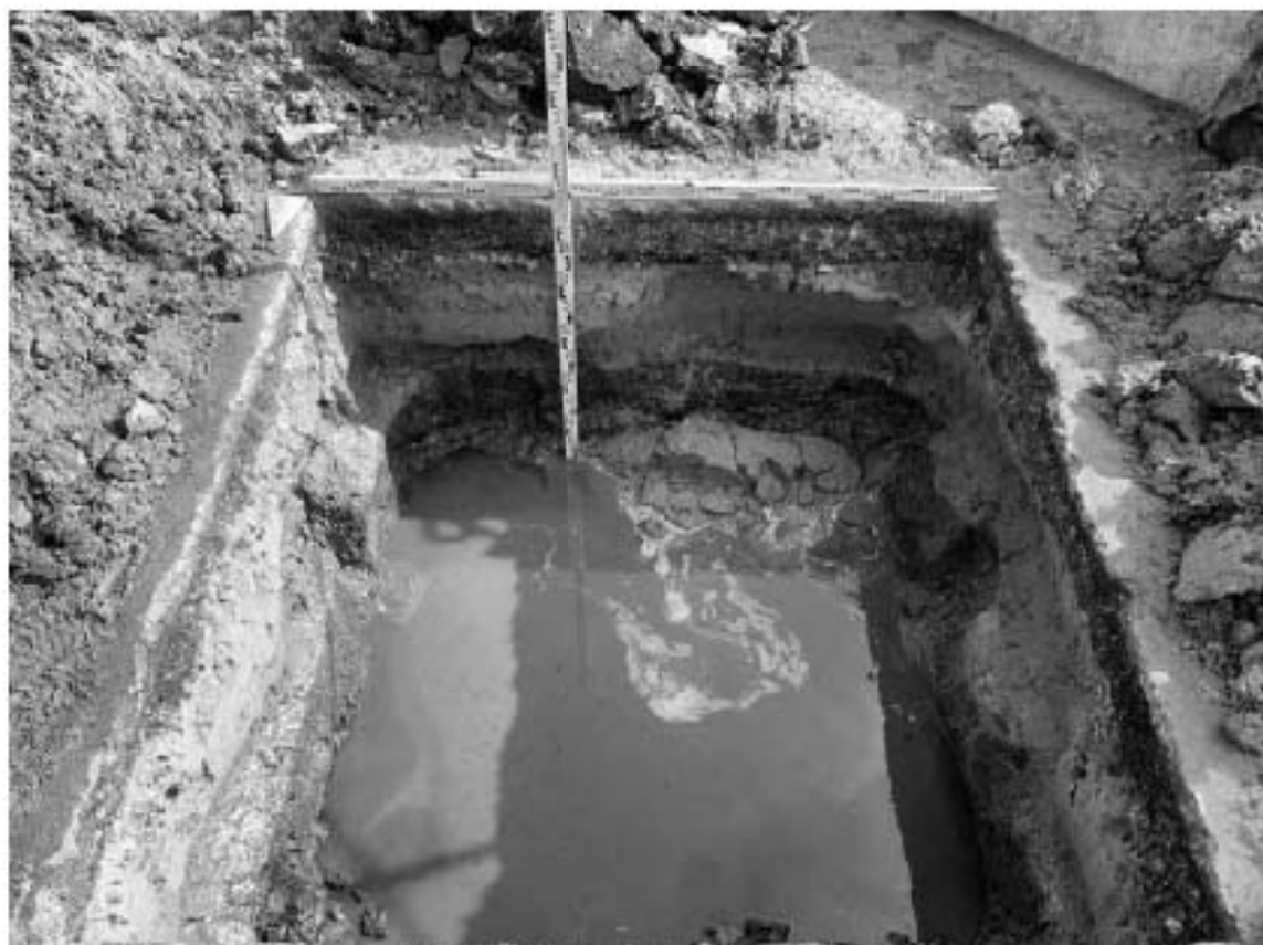
Рис. 58. СПб-2023. ПС Чесменская. Шурф 1, фиксация по уровню окончания работ, вид на юг, южная стенка.
