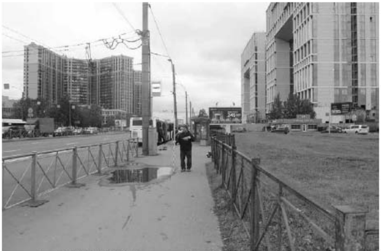
Рис. 32. СПб-2023. ПС Чесменская. Точка фотофиксации 8, вид на восток.
