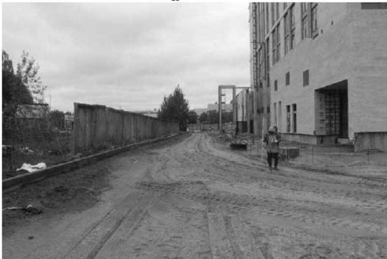
Рис. 25. СПб-2023. ПС Чесменская. Точка фотофиксации 5, вид на север.
