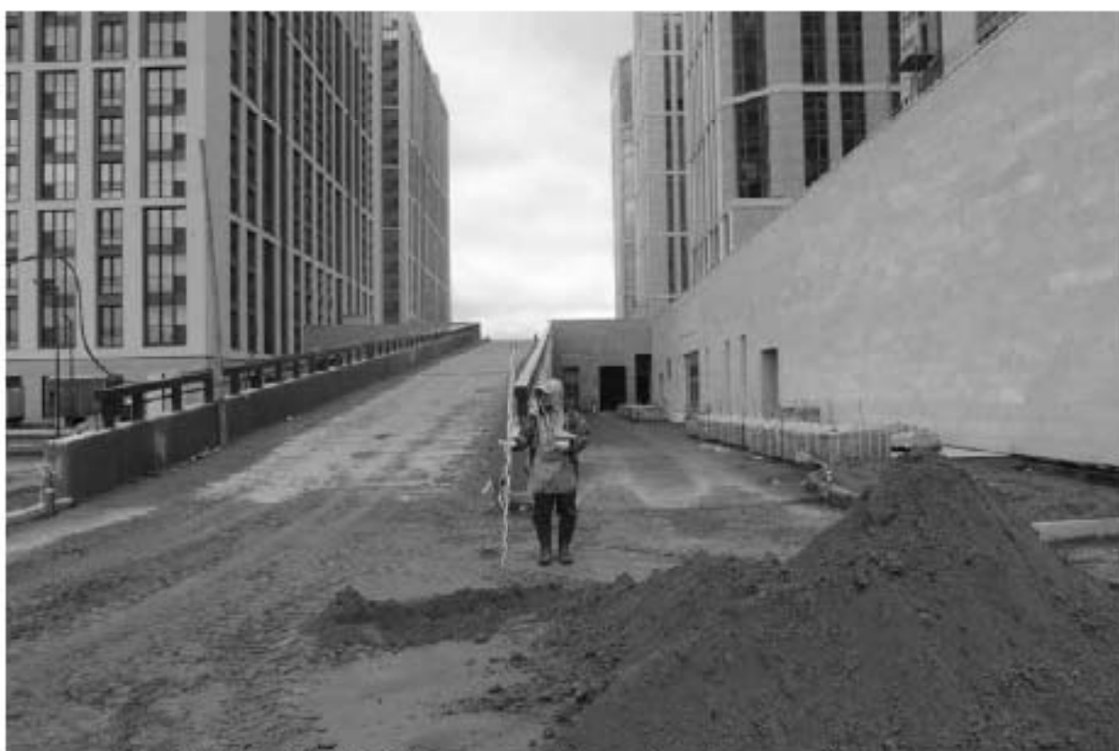
Рис. 18. СПб-2023. ПС Чесменская. Точка фотофиксации 2, вид на запад.
