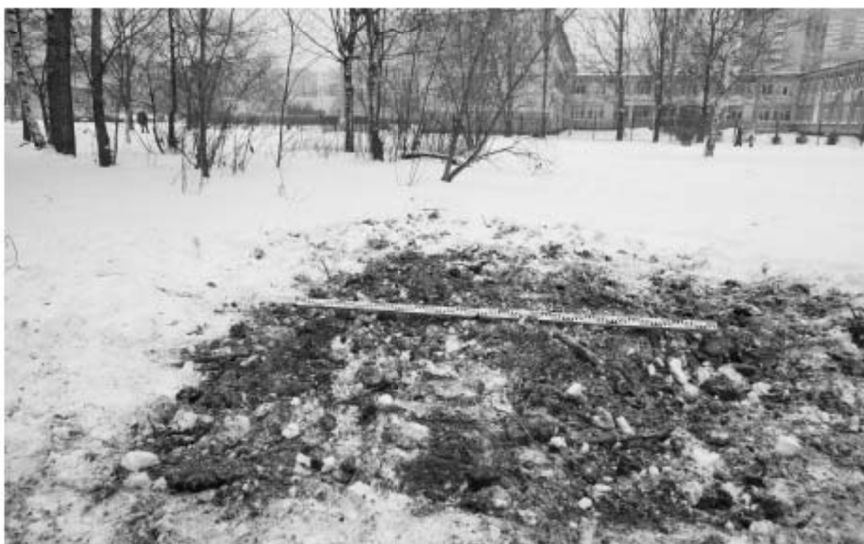
Рис. 39. Санкт-Петербург, ул. Бухарестская-2023. Шурф 1 после засыпки. Вид с юга.
