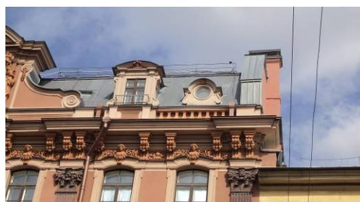
венчающий профилированный раскрепованный с выносом карниз на каннелированных кронштейнах с венками;
