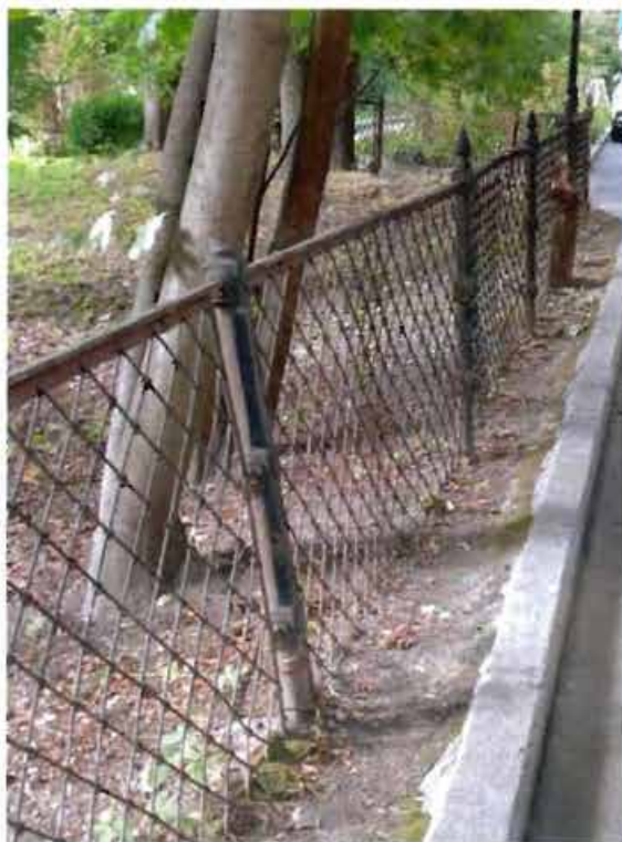
Фото 15: фрагмент объекта культурного наследия: фрагмент исторической чугуной ограды (опорные стойки круглые в сечении с прямоугольными перехватами, контрфорсами и конусообразным навершием).
