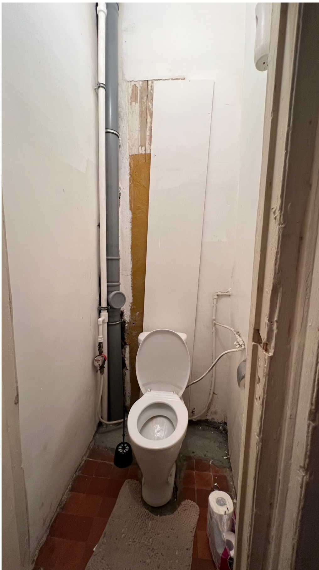
10.Фрагмент интерьера туалета (помещение 3/1);
