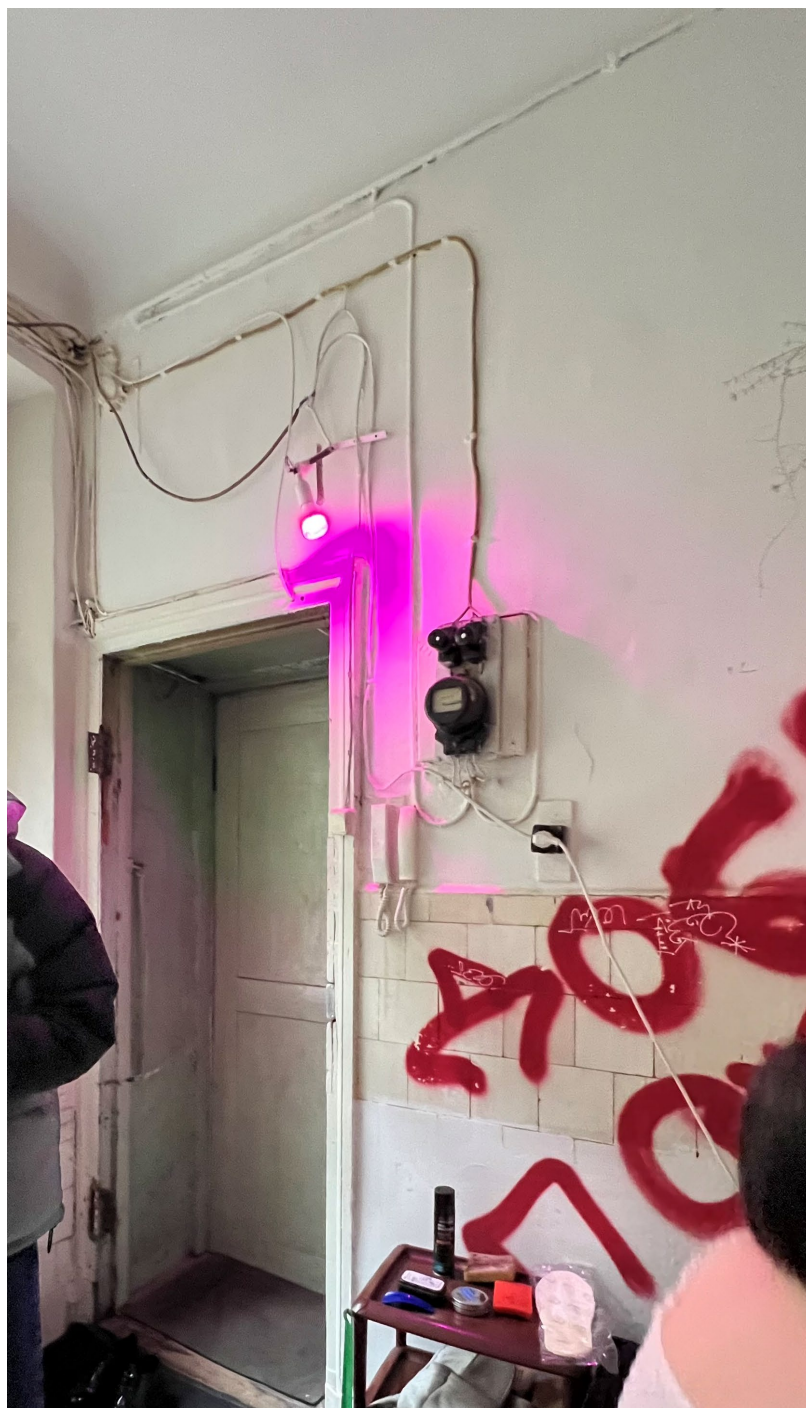
4. Вид на входную дверь в квартире;
