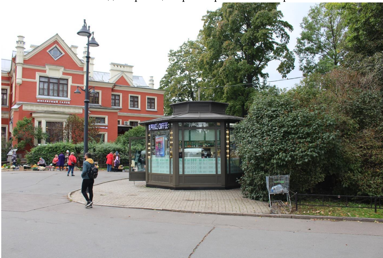
Фото 4. Вид на нестационарный торговый объект № 16340 с северо-востока.
