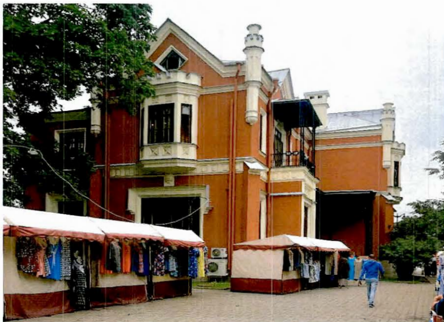
2. Лицевой фасад объекта культурного наследия «Дача» (вид с западной стороны)
