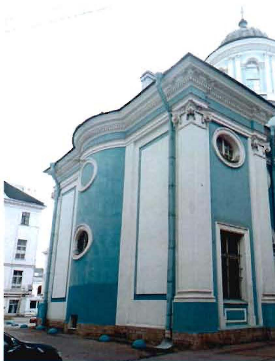
2. Общий вид. Восточный фасад объекта культурного наследия.
