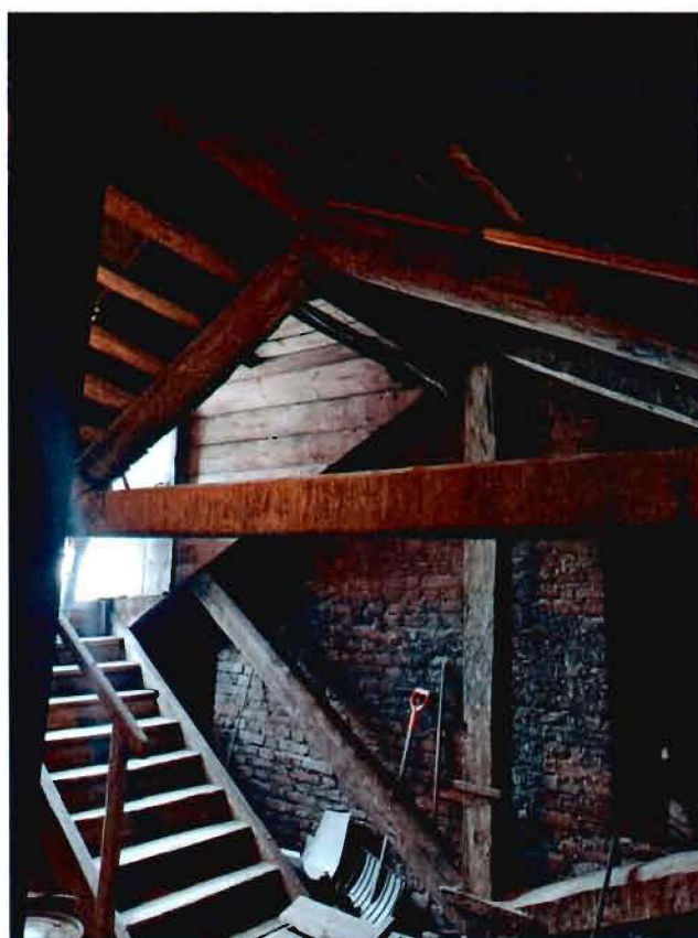
18. Чердачное пространство объекта культурного наследия.
