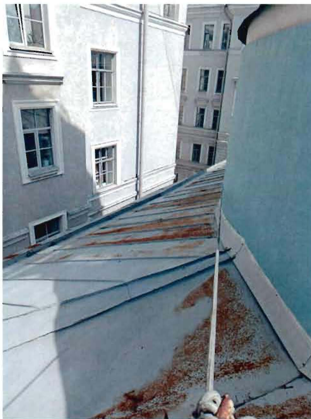
21. Кровля объекта культурного наследия.
