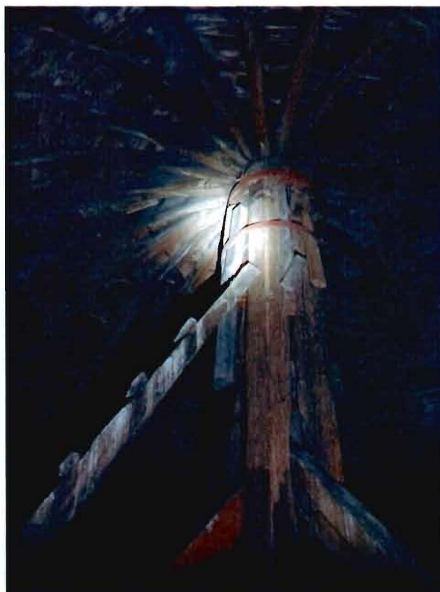
20. Чердачное пространство объекта культурного наследия.
