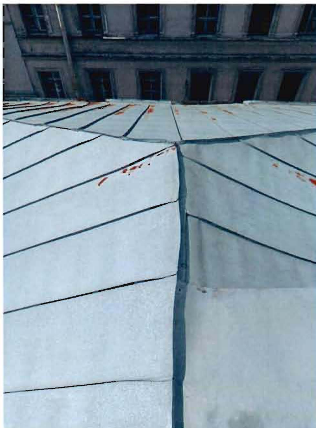
22. Кровля объекта культурного наследия.
