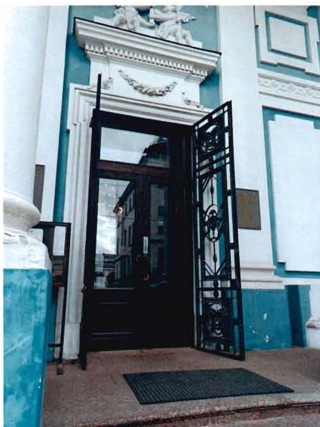
8. Фрагмент. Южный фасад объекта культурного наследия. Главный вход.
