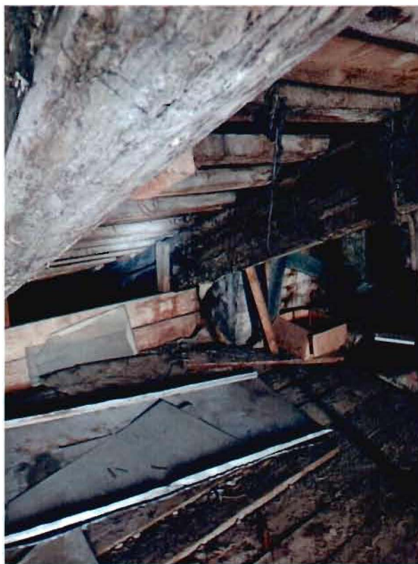
19. Чердачное пространство объекта культурного наследия.
