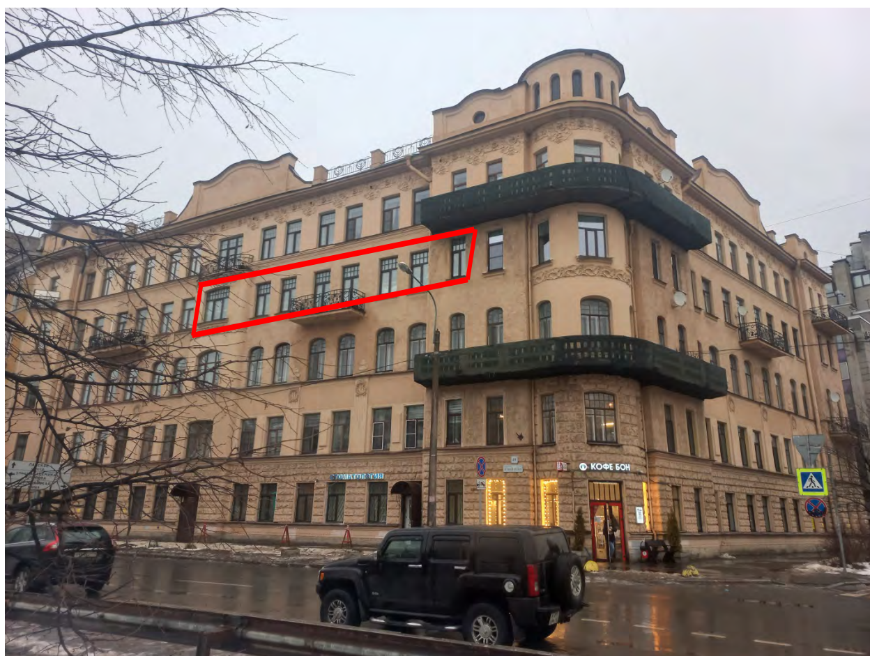
Фото 2. Лицевой фасад вдоль наб. Черной речки (нечетная сторона). Окна рассматриваемой квартиры расположены на 4 этаже.
