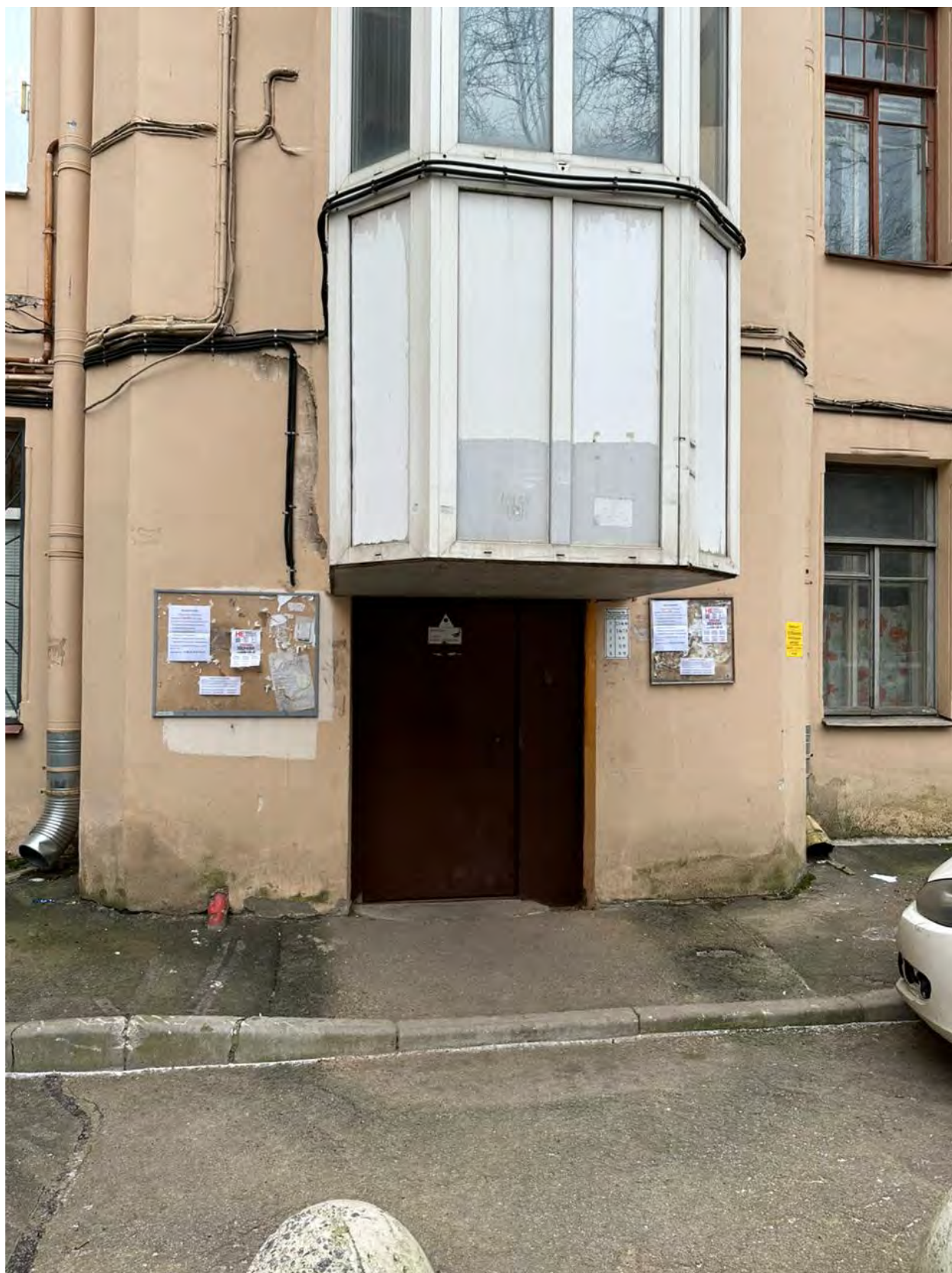
Фото 7. Вход в парадную в части здания вдоль наб. Черной Речки (1ЛК).
