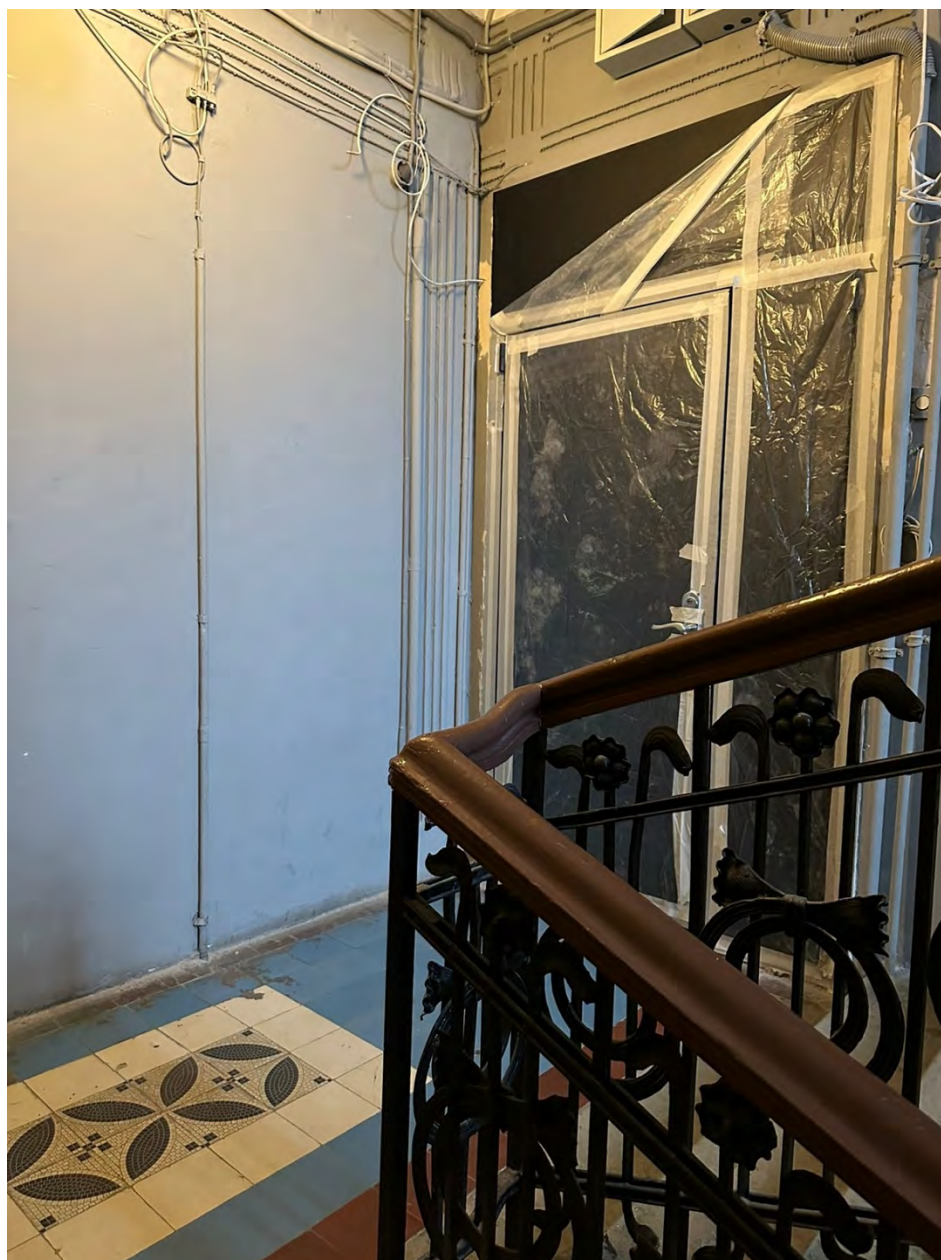
Фото 6. Вход в квартиру с угловой лестничной клетки (2ЛК).
