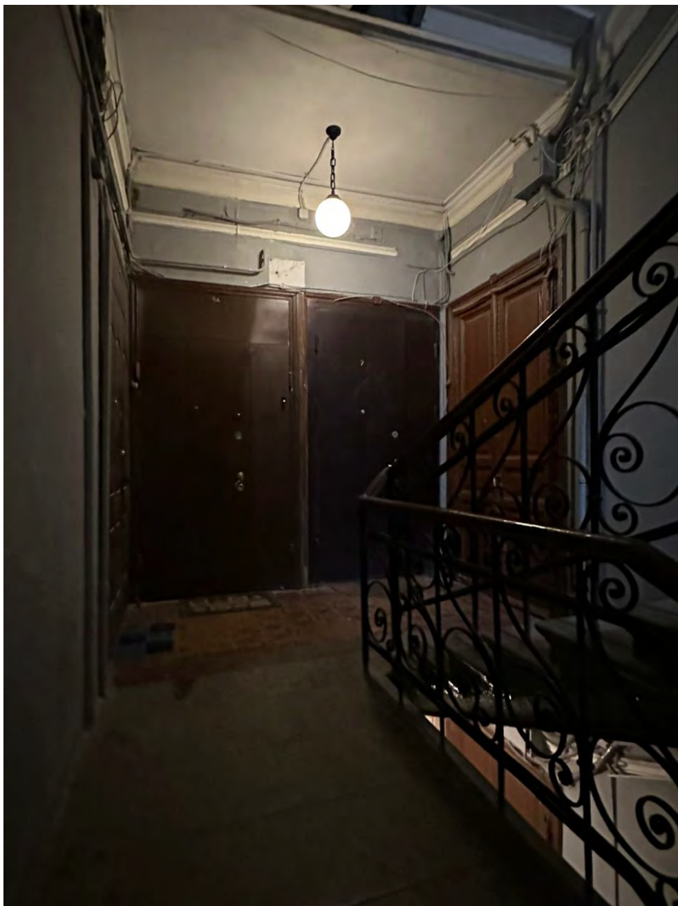
Фото 8. Второй вход в квартиру (дверь слева).
