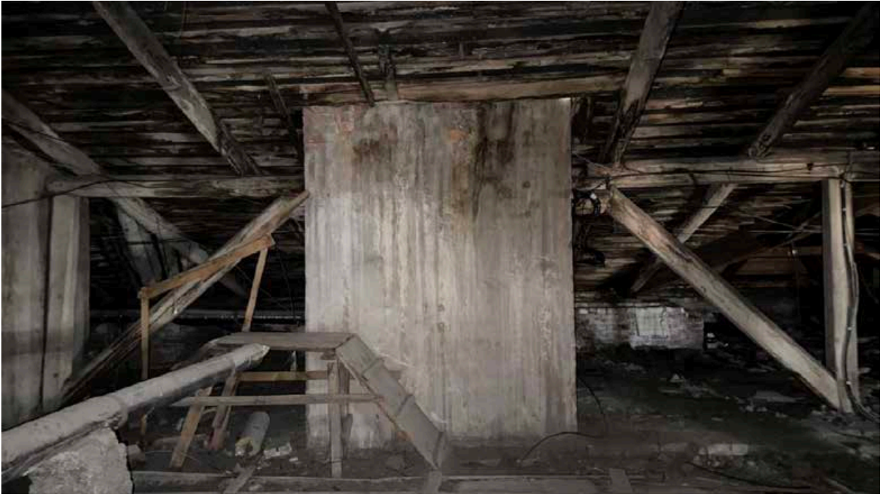
16. Общий вид чердака. Вид дымового канала
