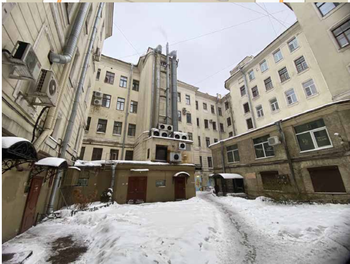
4. Здание по адресу: Санкт-Петербург, ул. Рубинштейна, д. 2/45, литера А. Общий вид дворовых фасадов
