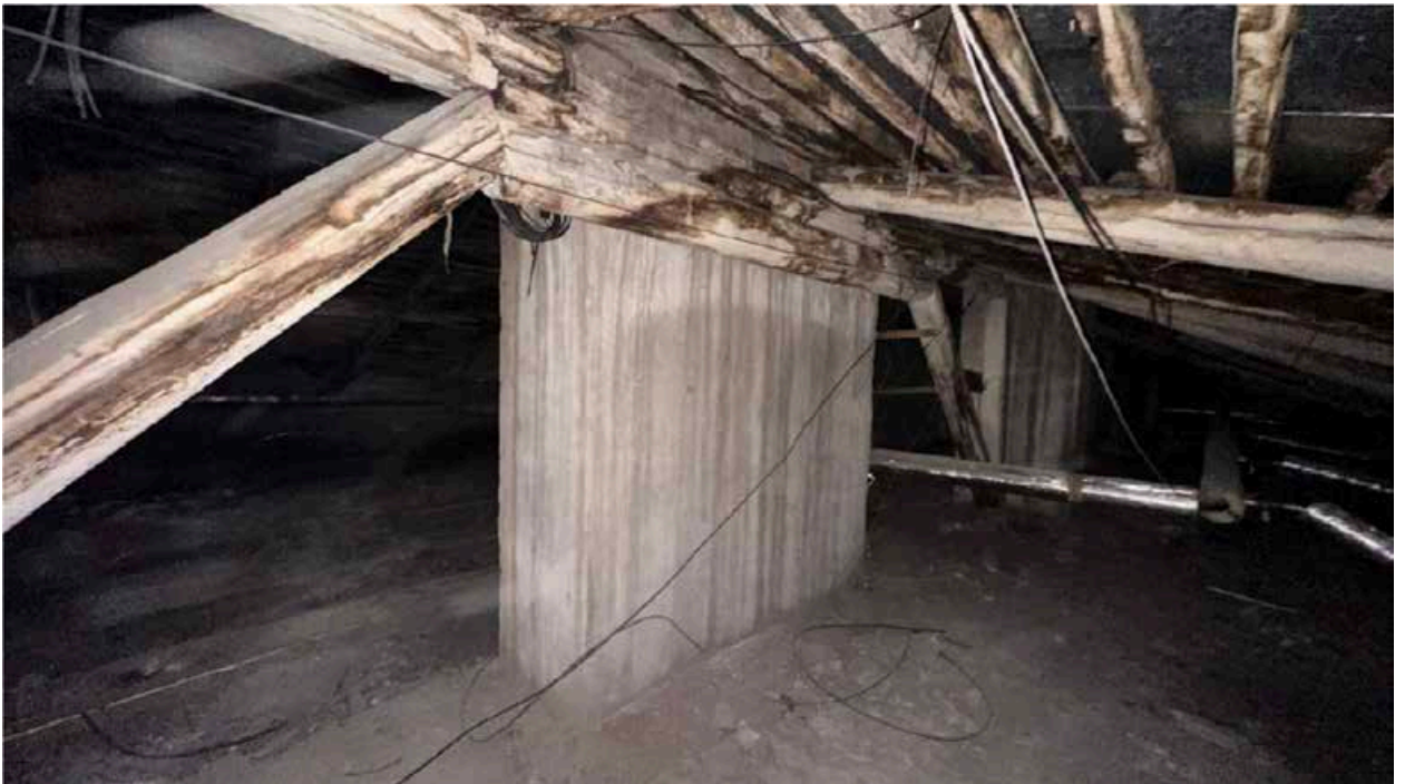
17. Общий вид чердака. Вид дымового канала
