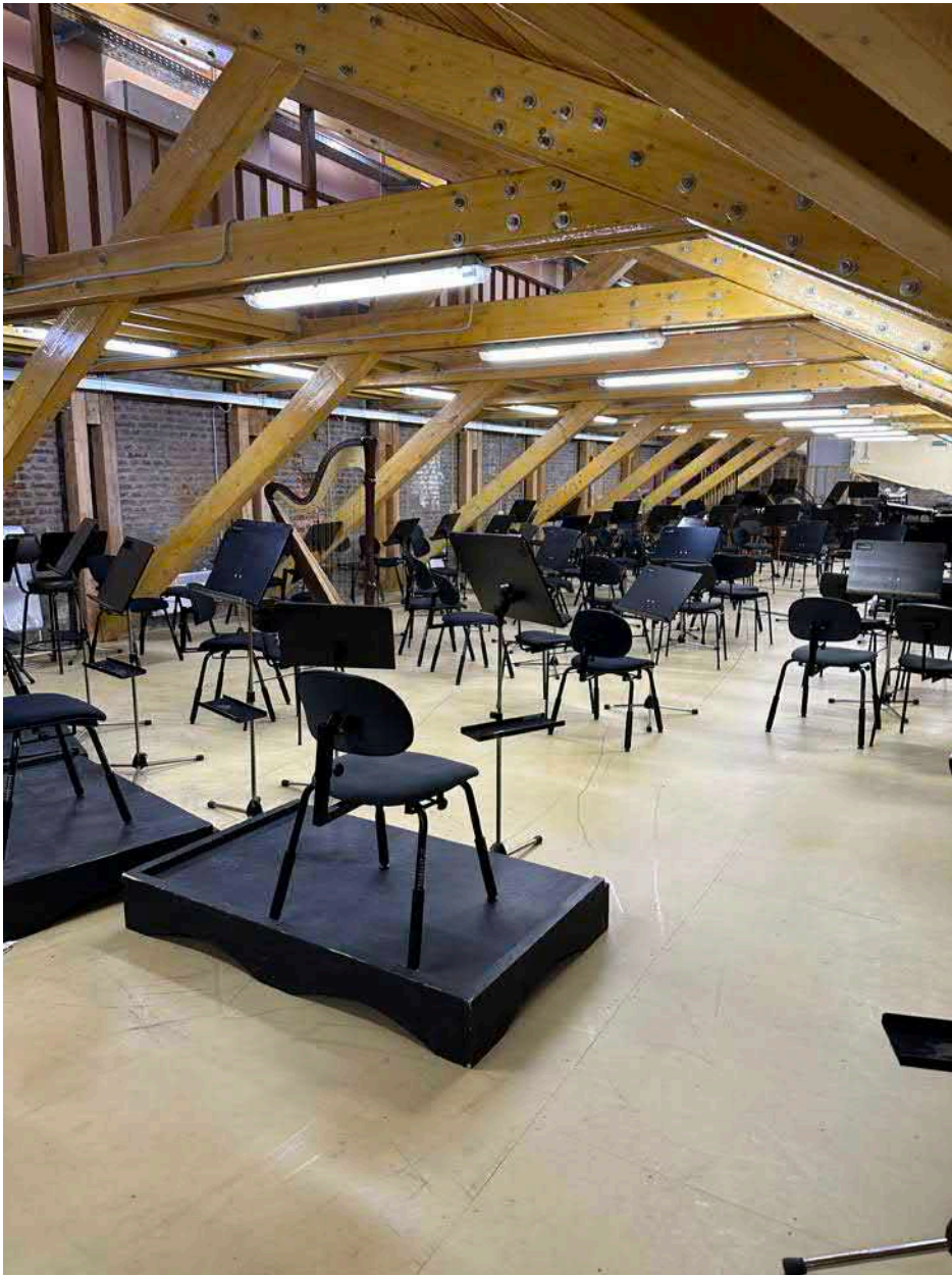
Фото 2. Чердачное помещение, д.1. Основной объем помещения
