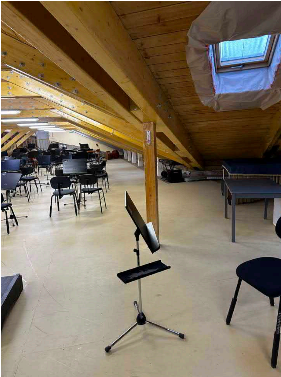
Фото 3. Чердачное помещение, д.1. Основной объем помещения
