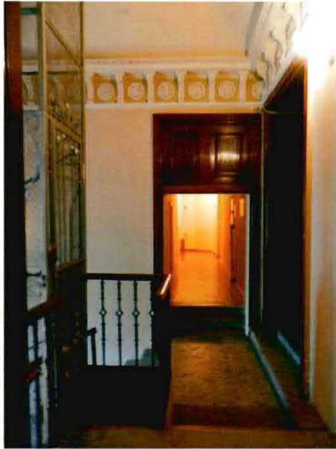
7. Лестничная клетка 3-го этажа
