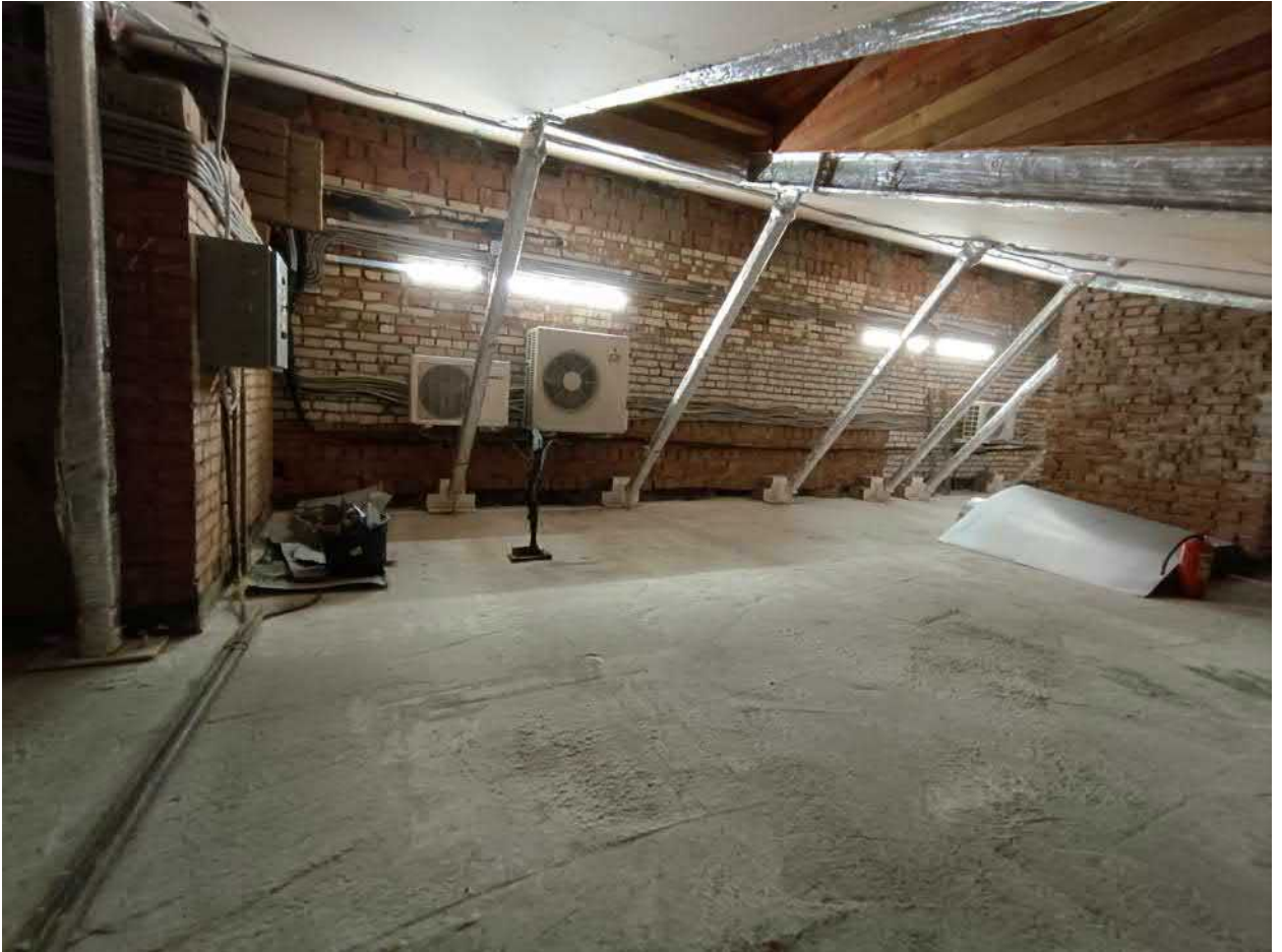
Фото 12. Чердачное помещение, д.3. Стена, вдоль которой планируется установка вентиляционного оборудования
