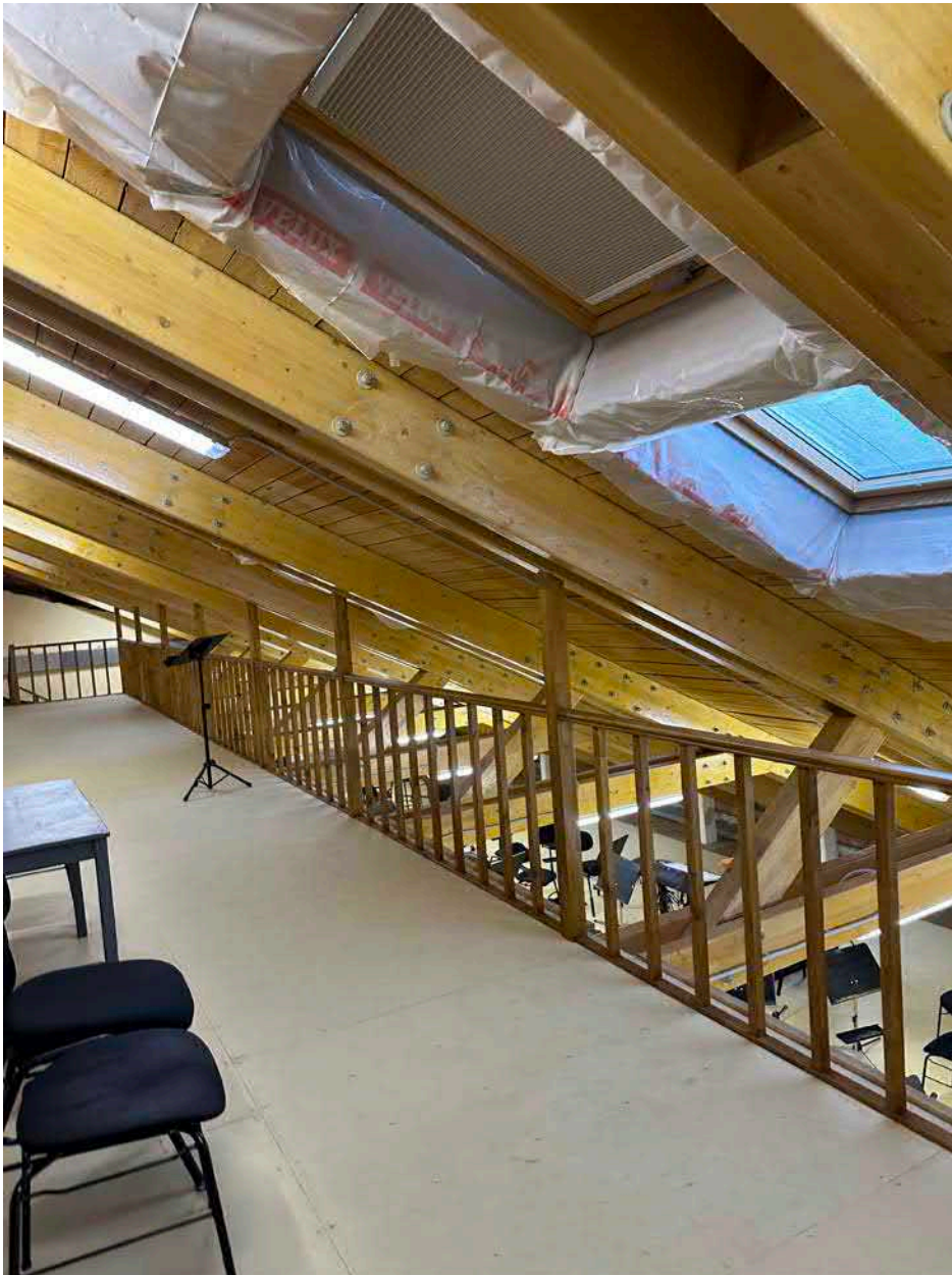
Фото 6. Чердачное помещение, д.1. Галерея
