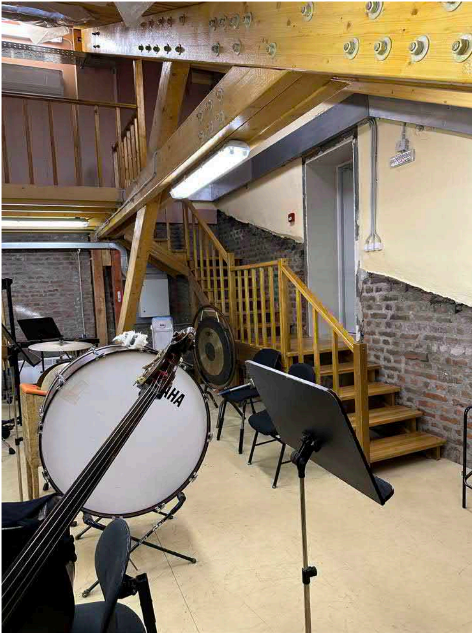
Фото 9. Чердачное помещение, д.1. Основной объем помещения
