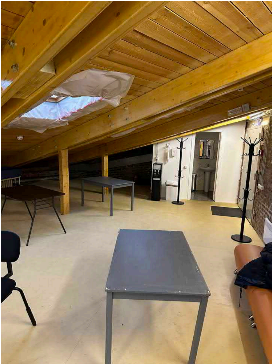
Фото 4. Чердачное помещение, д.1. Основной объем помещения
