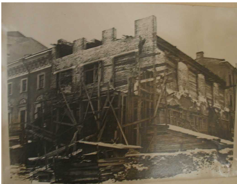
Илл. 25. Строительство репетиционных залов и гримборных на месте электростанции театра.1936-1937 гг. Фото из собрания театра.
