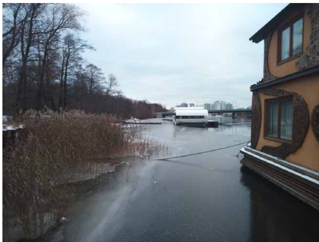
8. Объект культурного наследия регионального значения «Приморский парк Победы». Фрагмент территории берега реки Малой Невки. Земельный участок с кадастровым номером № 78:07:0321502:3025. Вид от причала в сторону Большого Петровского моста. Дата съёмки: 22.11.2023 г.
