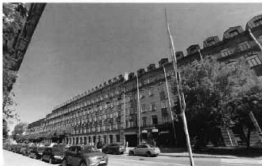
1. Общий вид на юго-западный фасад объекта культурного наследия (27.06.2022)
