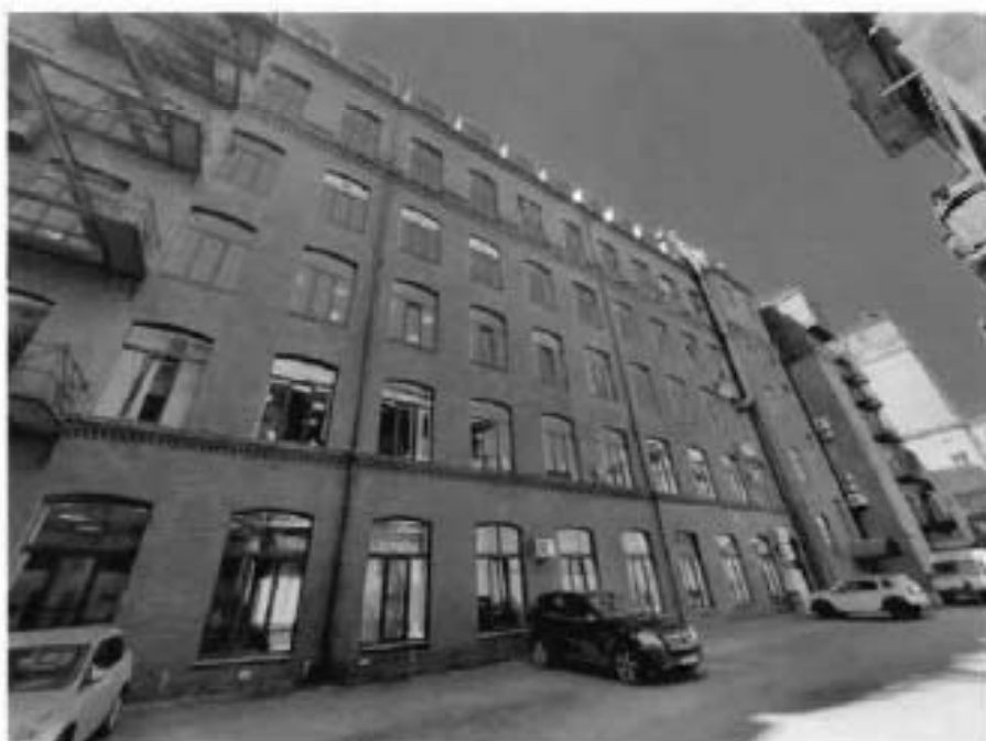
5. Фрагмент северо-восточного фасада объекта культурного наследия (центральный корпус) (27.06.2022)
