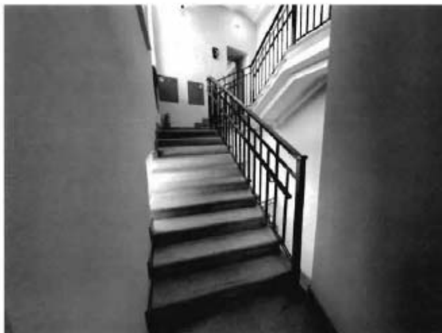
11. Трехмаршевая лестница в западной части северо-западного корпуса (30.06.2022)
