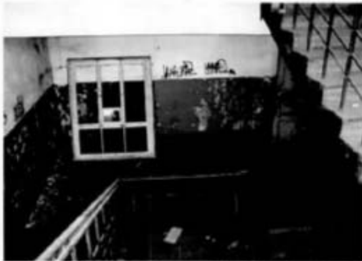
Фото 16. Центральная лестница в южной части здания.
