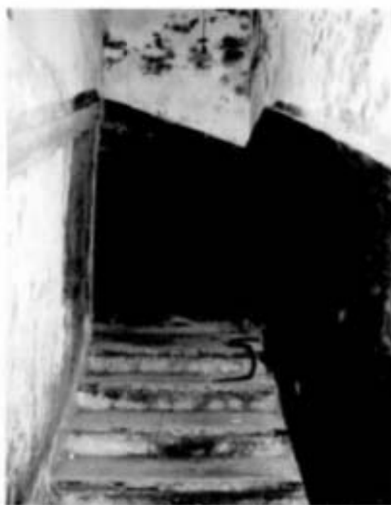
Фото 17. Лестница в северной части здания.
