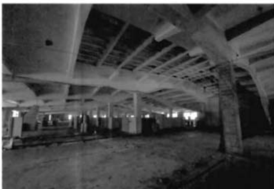
7. Интерьеры объекта культурного наследия, 3 этаж
