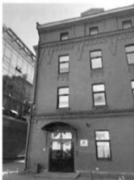
2. Северо-западный фасад. Главный вход.
