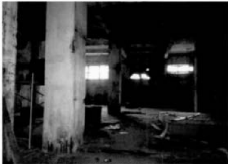
Фото 14. Быши, отделение испароподготовки.
