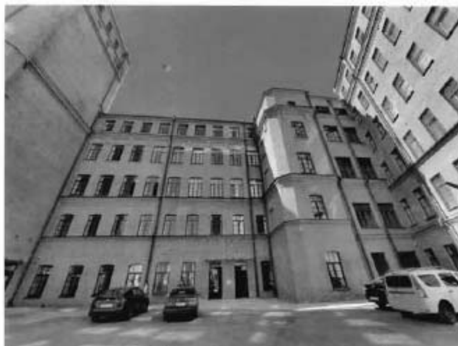
6. Фрагмент северо-восточного фасада объекта культурного наследия (северо-западный корпус) (27.06.2022)
