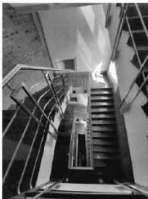
16. Двухмаршевая лестница в башне юго-восточного корпуса (27.06.2022)
