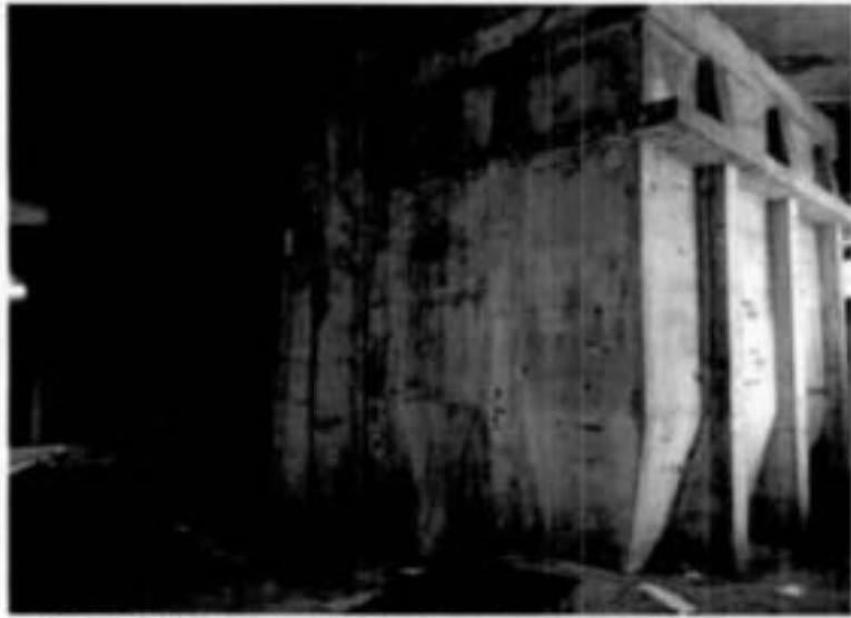
Фото 15. Железобетонный бак в башне, отделке не водоподготовки.
