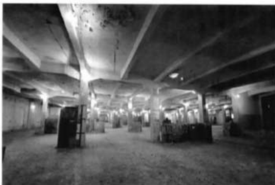
6. Интерьеры объекта культурного наследия, 2 этаж
