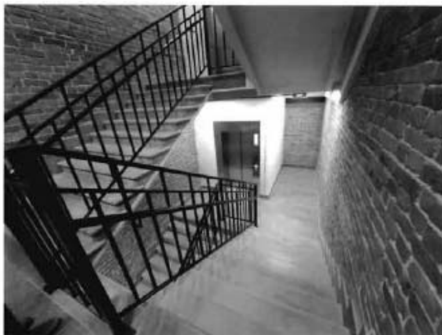
14. Двухмаршевая лестница с лифтом в башне северо-западного корпуса (30.06.2022)
