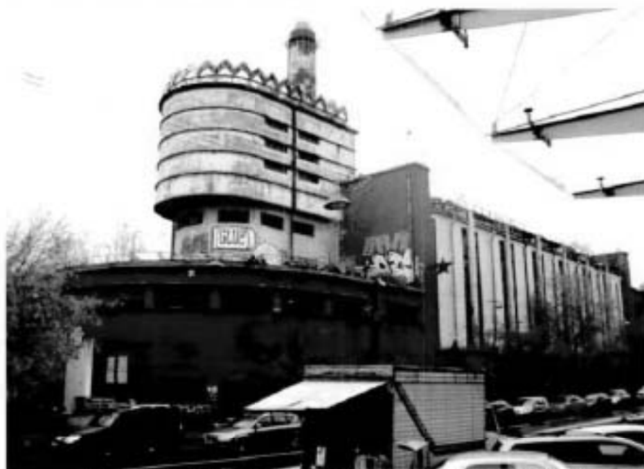
Фото 1. Полуциркульный северо-западный фасад и юго-западный фасад.
