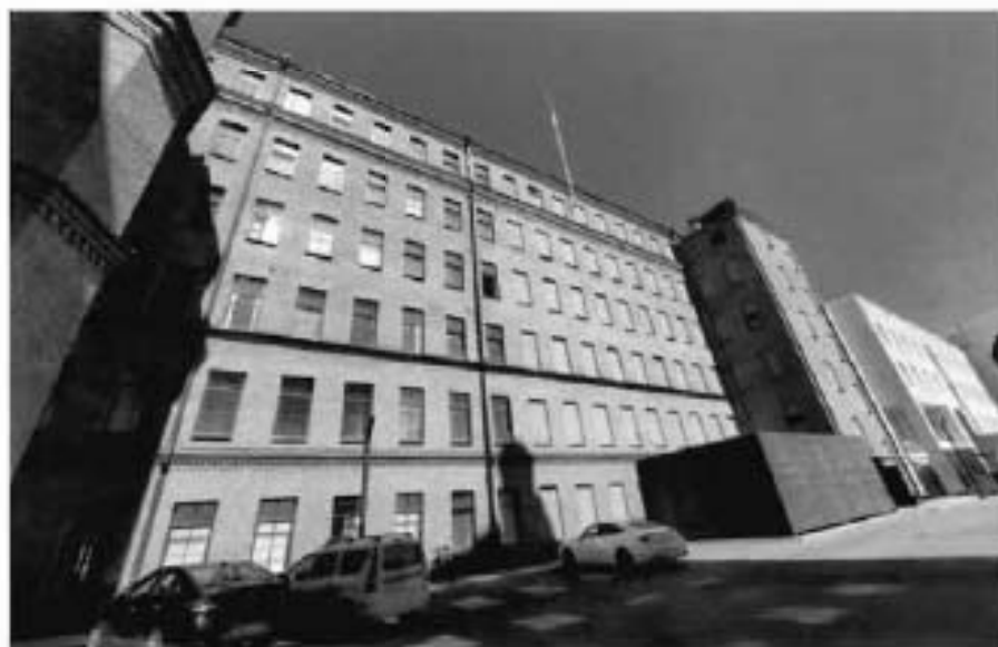
7. Фрагмент юго-восточного фасада объекта культурного наследия (27.06.2022)
