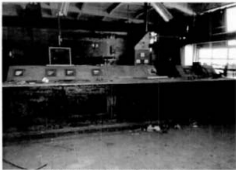
Фото 12. Пулт управления в бывш. турбинном зале.
