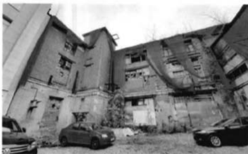
4. Вид на северо-западный фасад объекта культурного наследия
