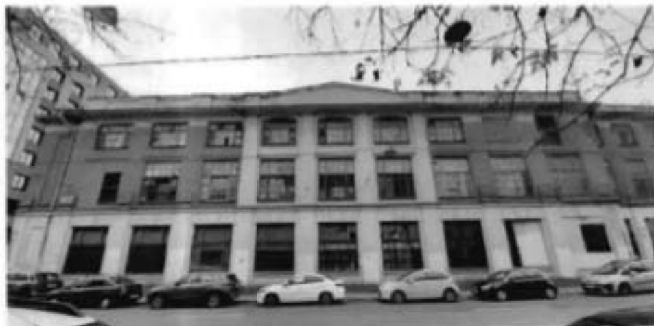
1. Вид на северо-восточный фасад объекта культурного наследия
