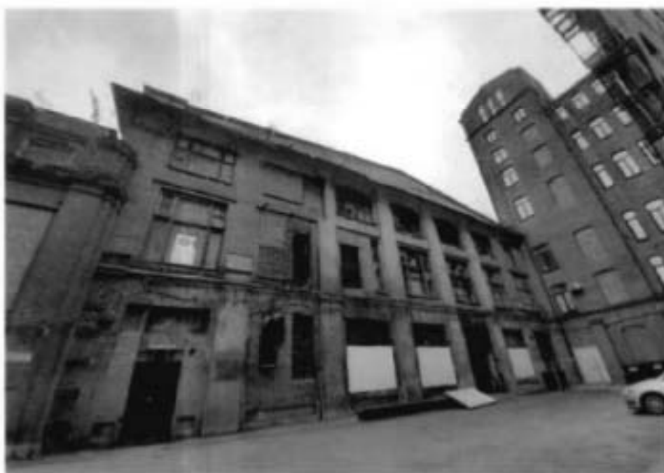
3. Вид на юго-западный фасад объекта культурного наследия
