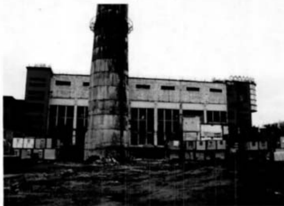
Фото 5. Фрагмент Северо-восточного фасада.
