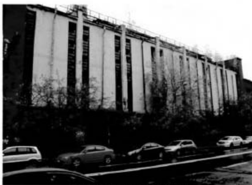
Фото 2. Фрагмент юго-западной фасада.
