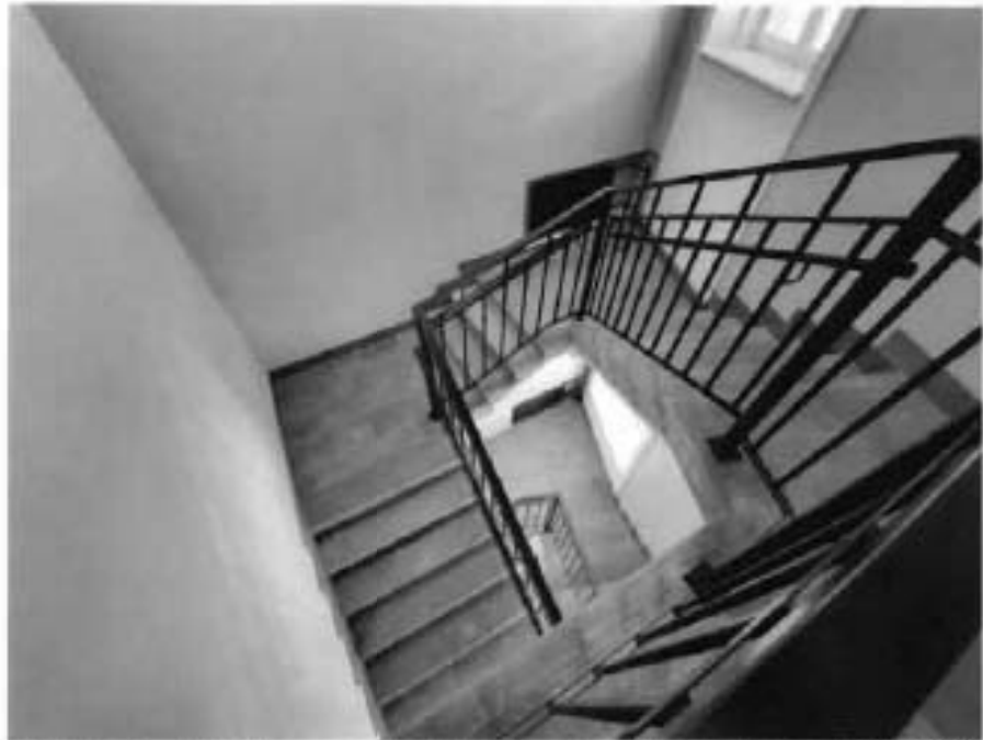
12. Четырехмаршевая лестница в западной части северо-западного корпуса (30.06.2022)
