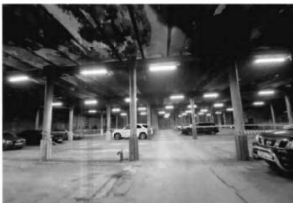
5. Интерьеры объекта культурного наследия, 1 этаж
