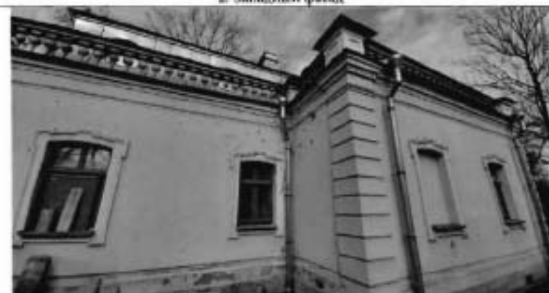
3. Фрагмент южного фасада
