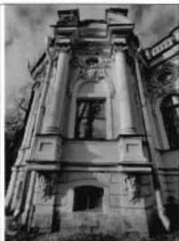
7. Фрагмент восточного фасада
