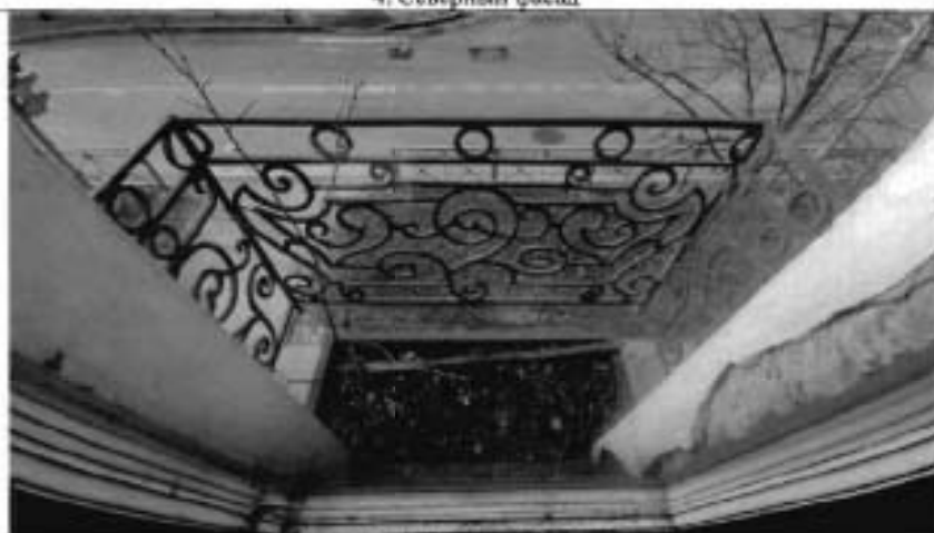
5. Балкон со стороны западного фасада
