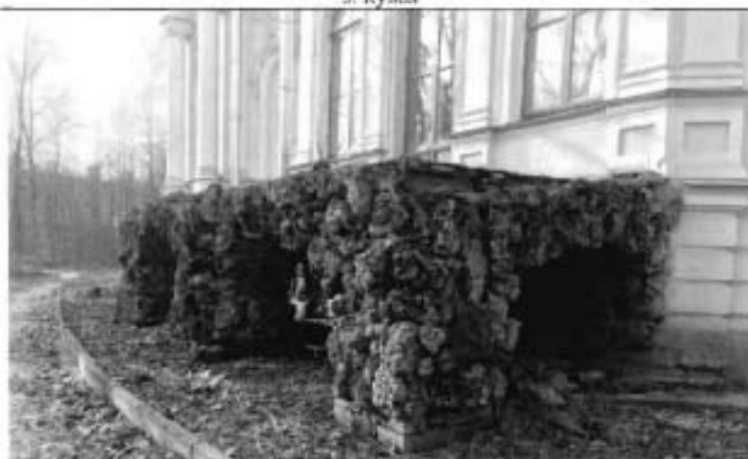
6. Терраса с туфовым срезом со стороны восточного фасада
