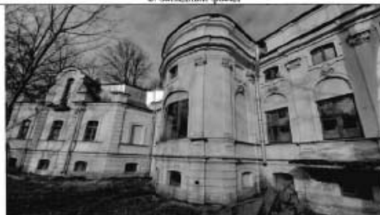
3. Фрагмент южного фасада
