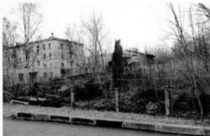
Фото 8. Вид территории и объекта культурного наследия с северо-запада.
