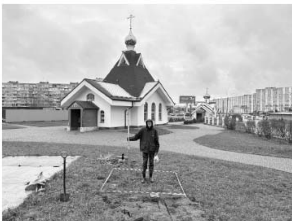
Илл. 13. Земельный участок кад. номер 78:13:0007416:4687 по адресу: г. Санкт-Петербург, проспект Славы, участок 1 (северо-восточнее дома 52, корпус 1, литера А по проспекту Славы). Место закладки разведочного шурфа. Вид с юго-запада.
