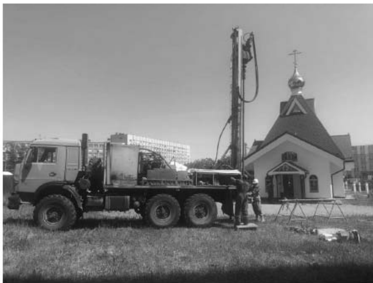
Рисунок 4.1.1 - Бурение скважины на участке изысканий 2023 г. (фотофиксация)
