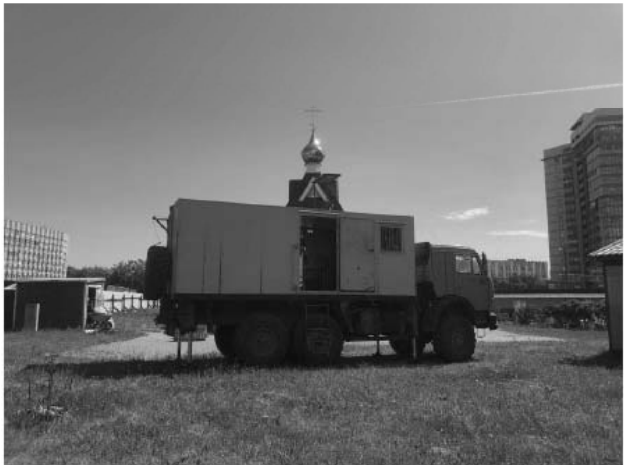
Рисунок 4.1.2 – Выполнение статического зондирования на участке изысканий 2023 г. (фотофиксация)
