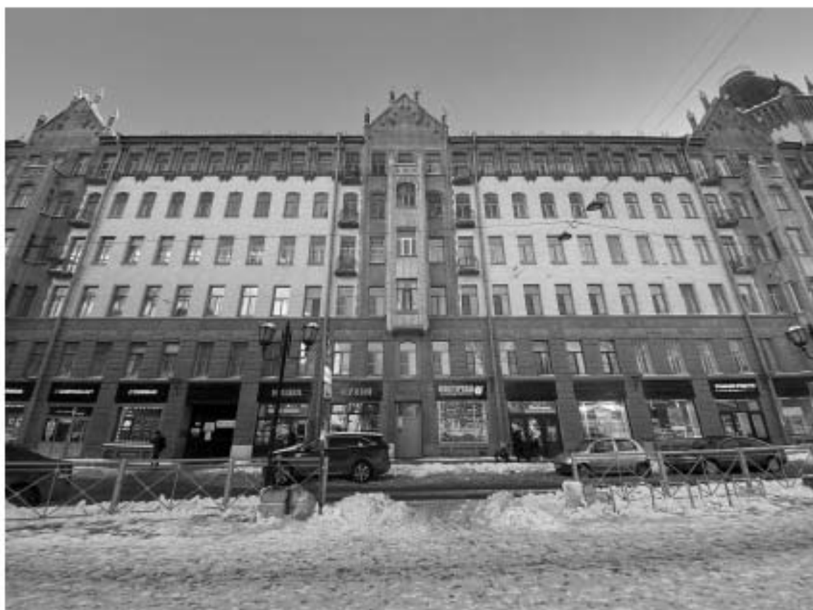
Фото 7. Фрагмент фасада объекта культурного наследия по 12-й Красноармейской улице.
