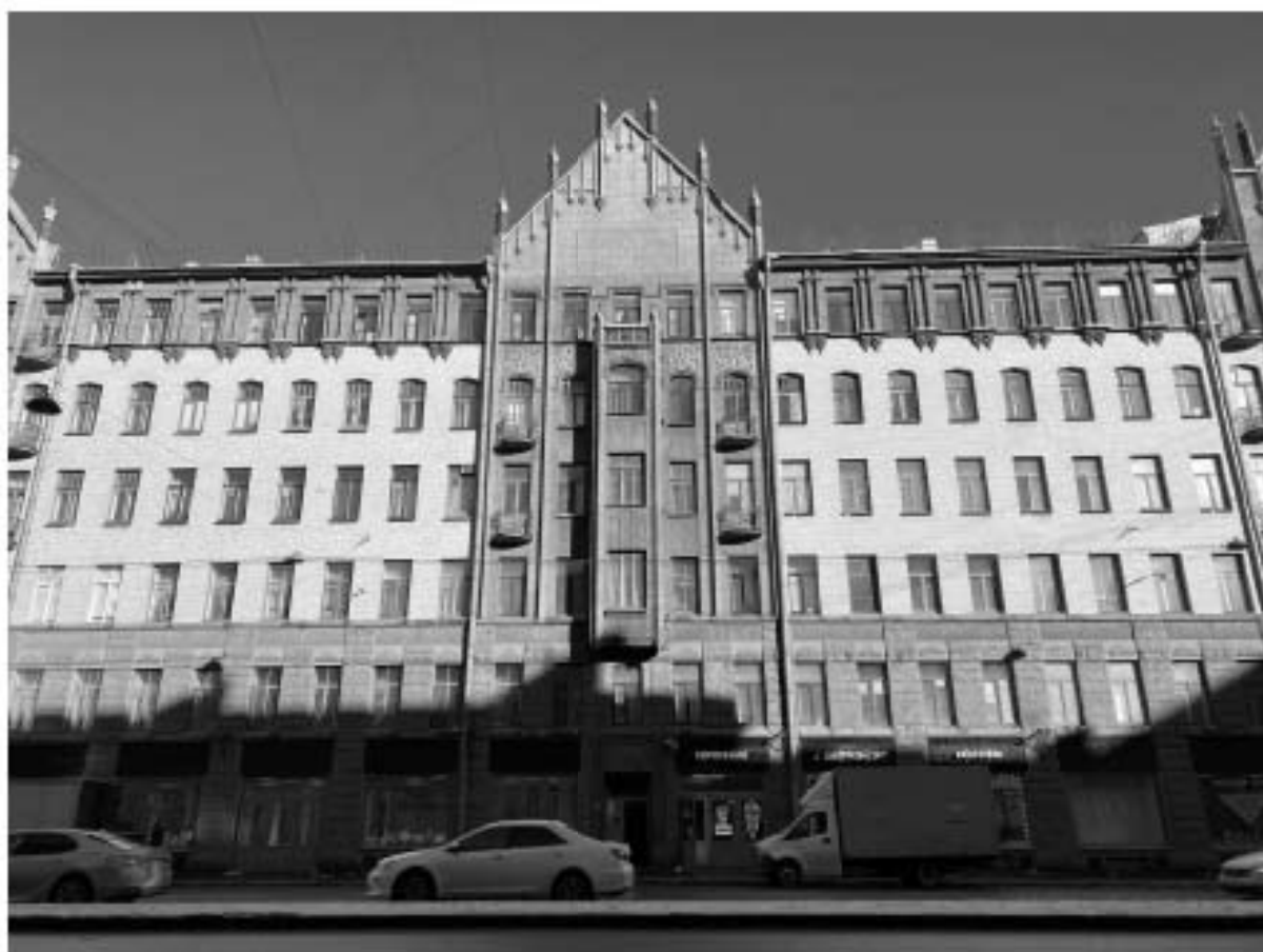
Фото 3. Фрагмент фасада объекта культурного наследия по Измайловскому проспекту.
