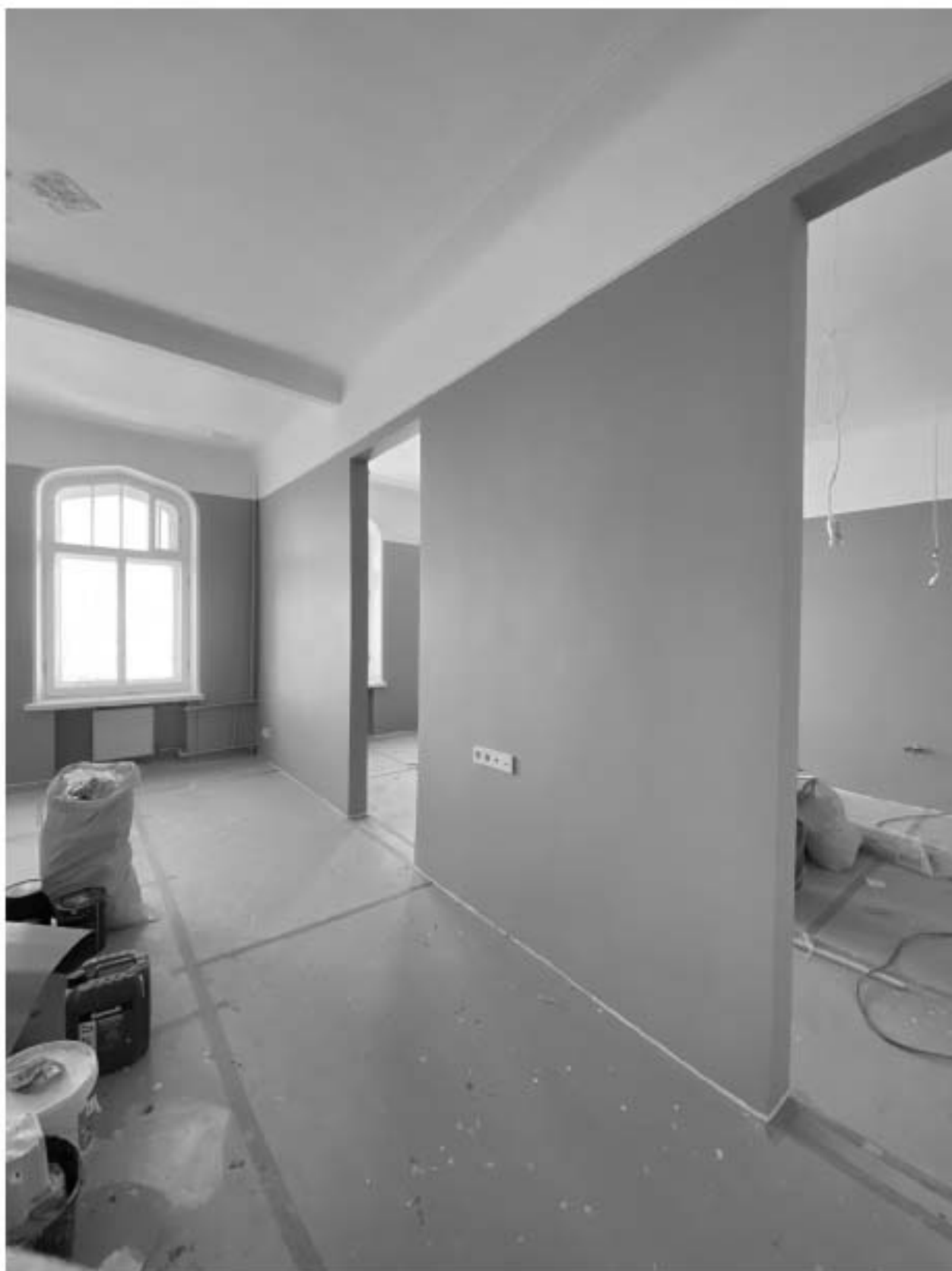
Фото 40. Вид на помещение квартиры № 39 объекта культурного наследия.
