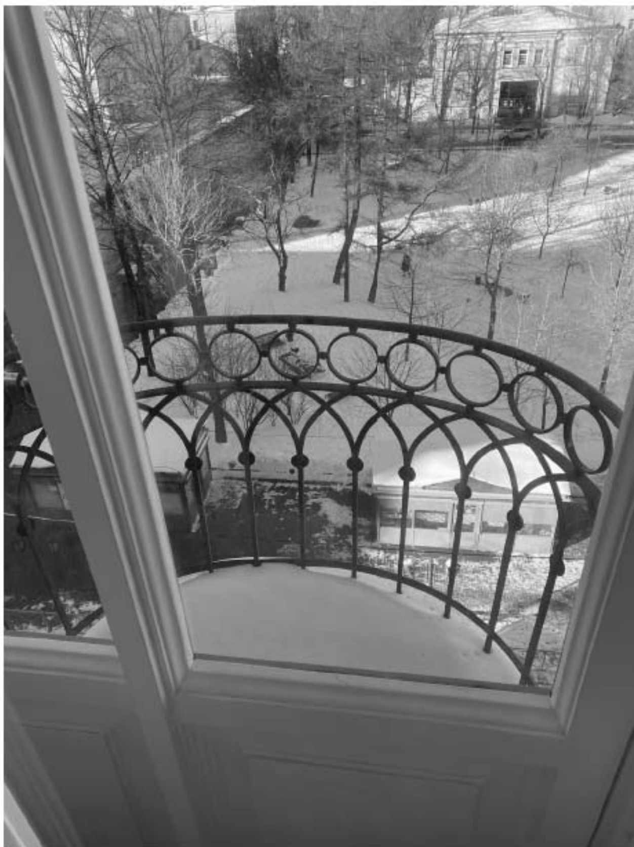
Фото 29. Вид на балконное ограждение из помещения квартиры № 39 объекта культурного наследия.
