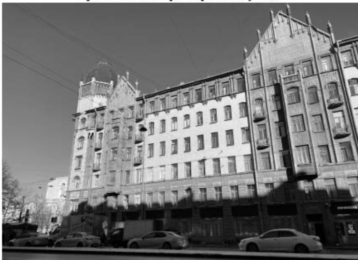
Фото 2. Фрагмент фасада объекта культурного наследия по Измайловскому проспекту.
