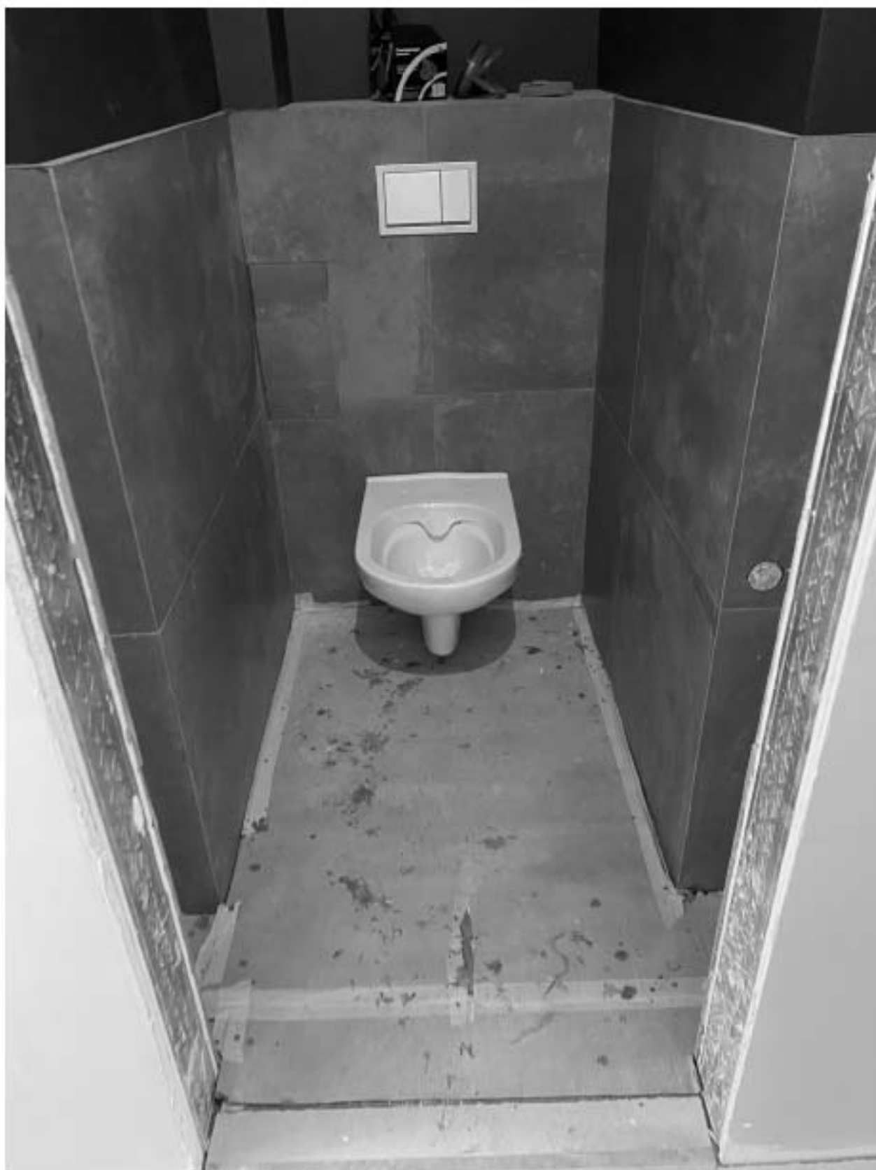
Фото 50. Вид на помещение квартиры № 39 объекта культурного наследия.
