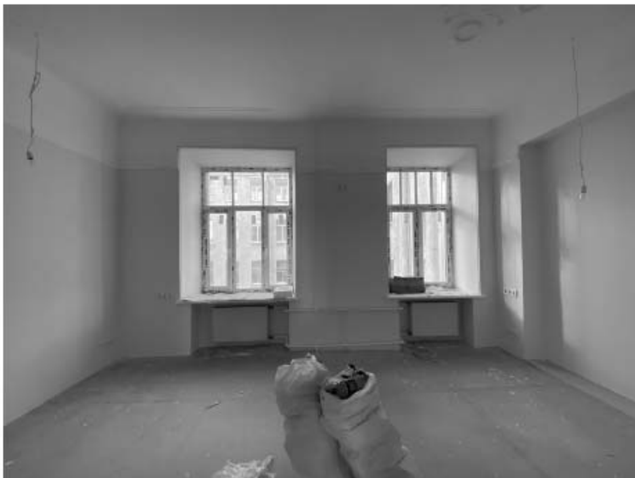
Фото 32. Вид на помещение квартиры № 39 объекта культурного наследия.
