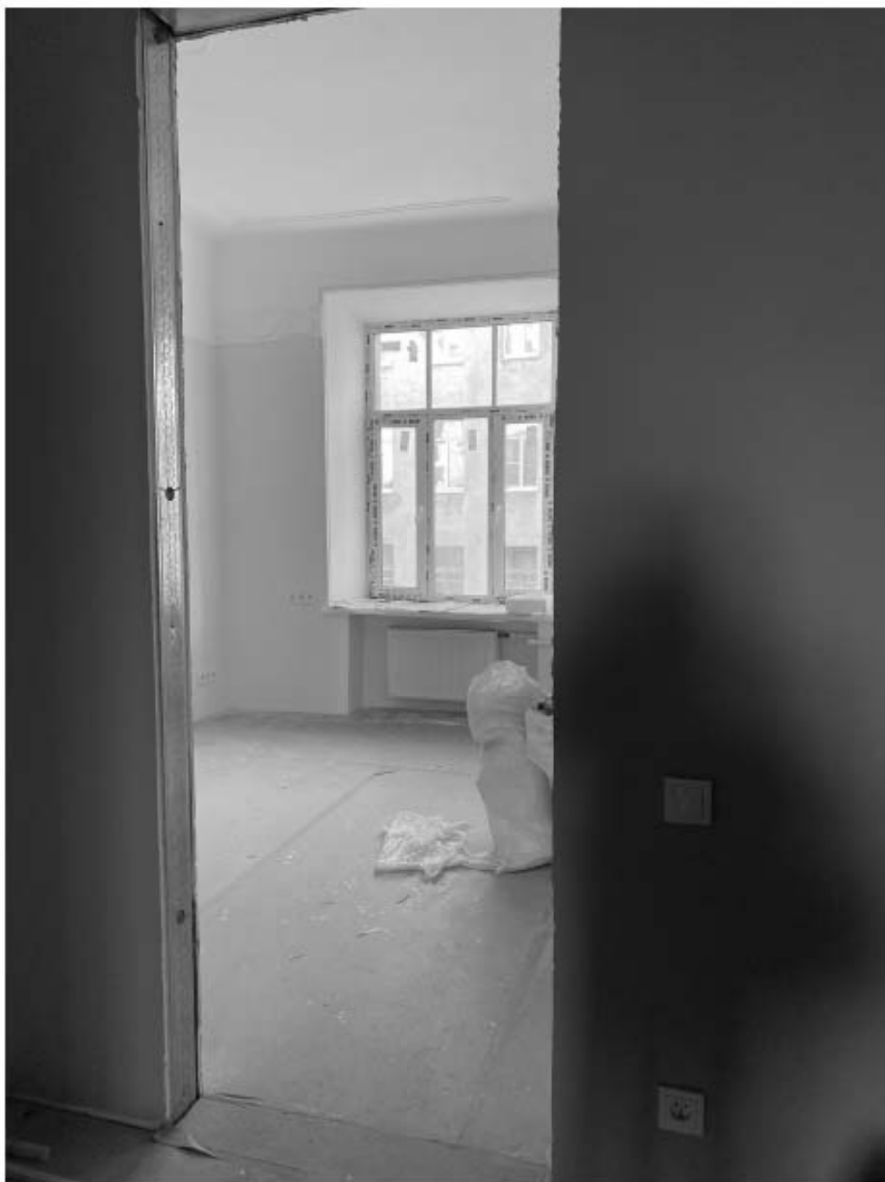
Фото 31. Вид на помещение квартиры № 39 объекта культурного наследия.
