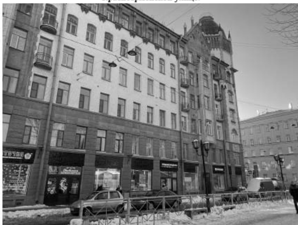
Фото 6. Фрагмент фасада объекта культурного наследия по 12-й Красноармейской улице.
