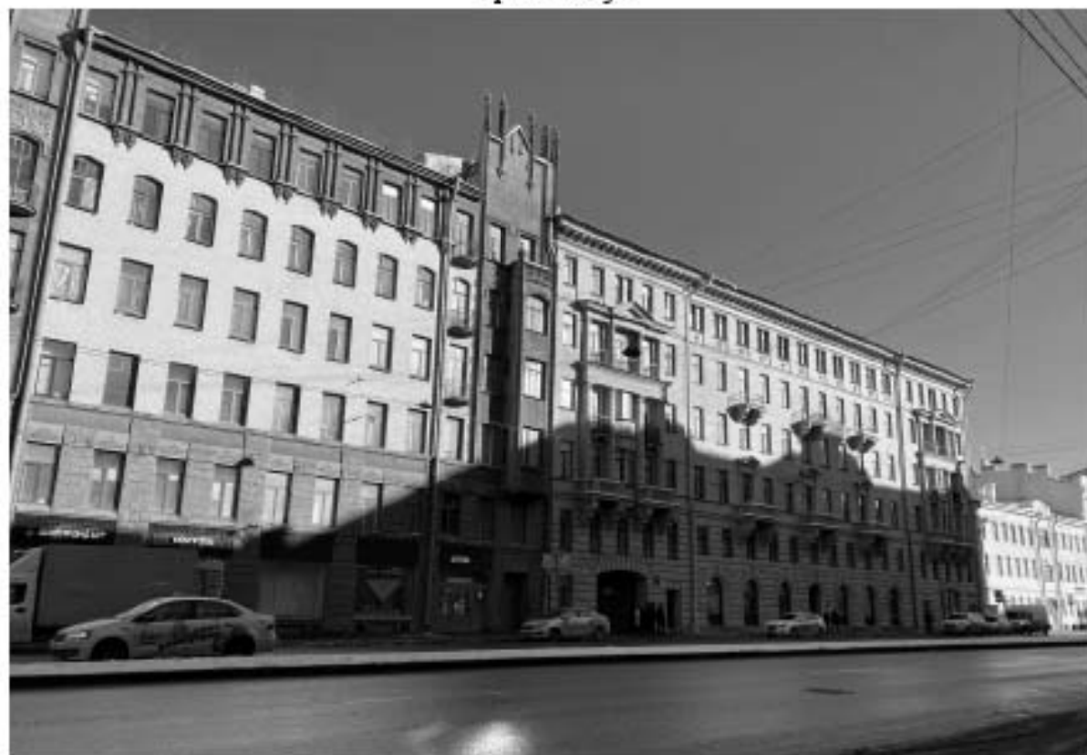
Фото 4. Фрагмент фасада объекта культурного наследия по Измайловскому проспекту.
