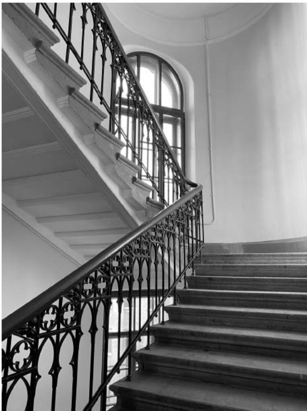
Фото 15. Вид на лестницу, ведущую в квартиру № 39, объекта культурного наследия.
