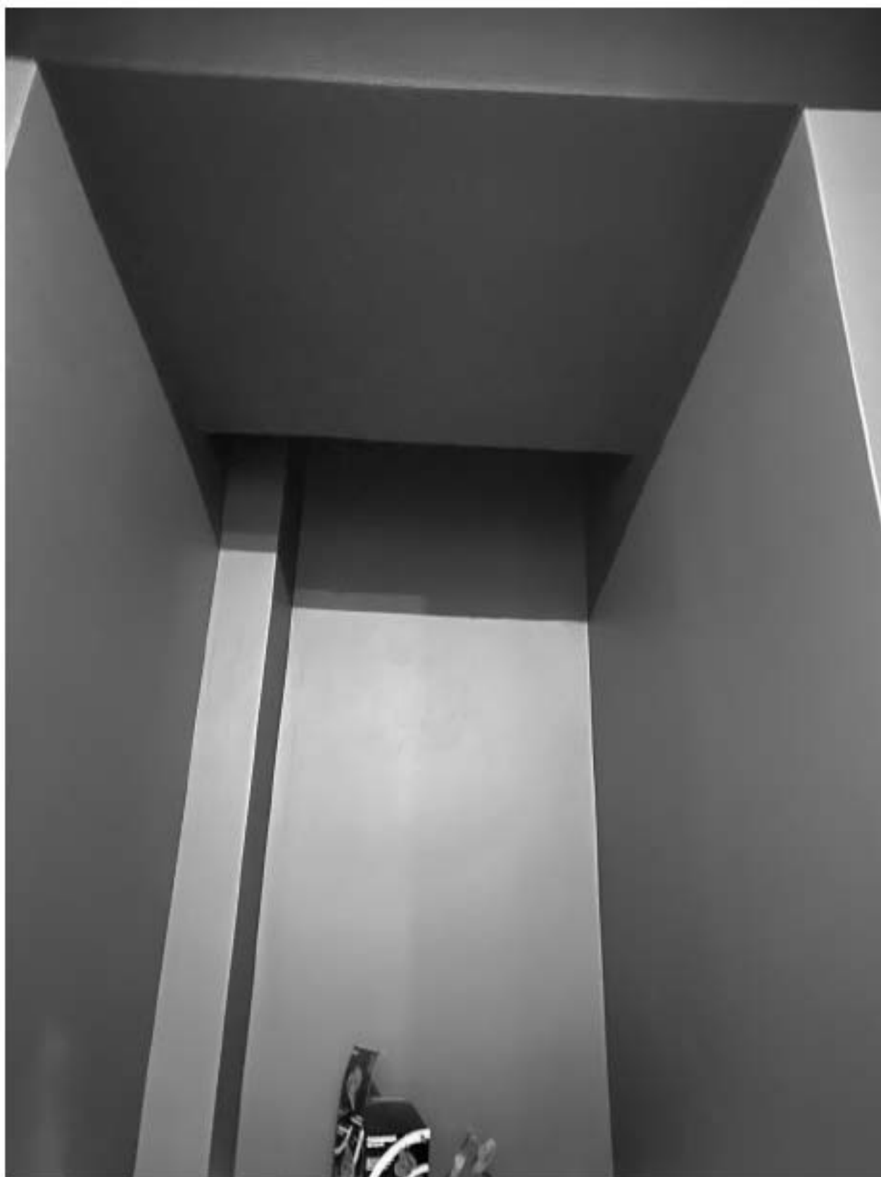
Фото 51. Вид на помещение квартиры № 39 объекта культурного наследия.
