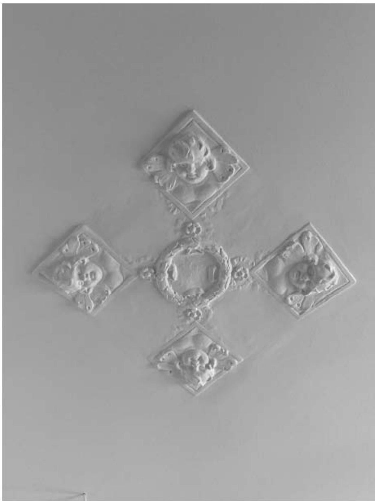
Фото 27. Вид на лепной декор в помещении квартиры № 39 объекта культурного наследия
