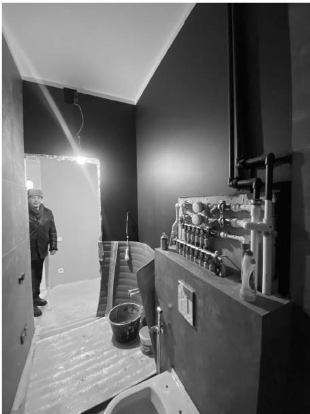
Фото 49. Вид на помещение квартиры № 39 объекта культурного наследия.
