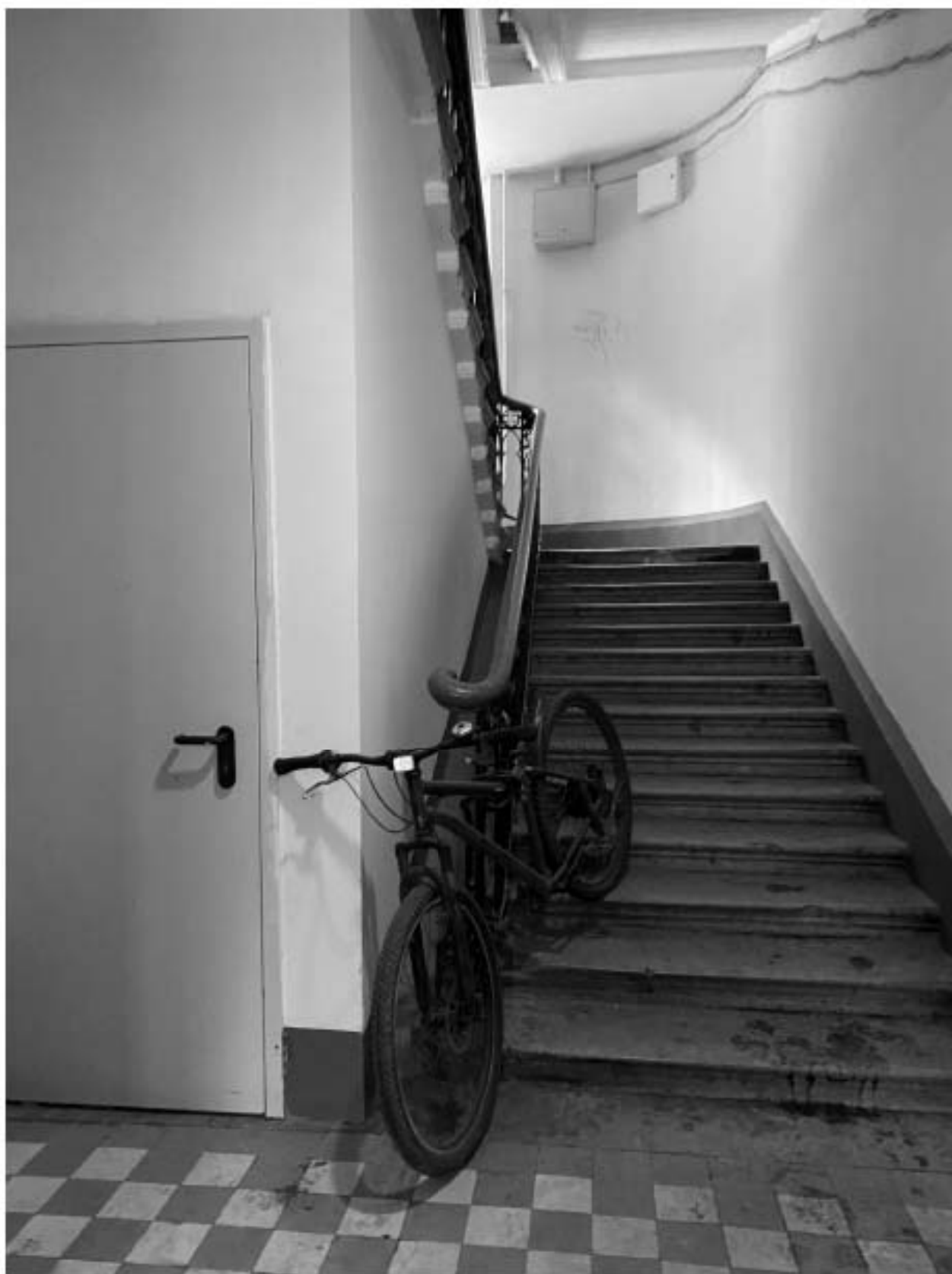
Фото 13. Вид на лестницу, ведущую в квартиру № 39, объекта культурного наследия.
