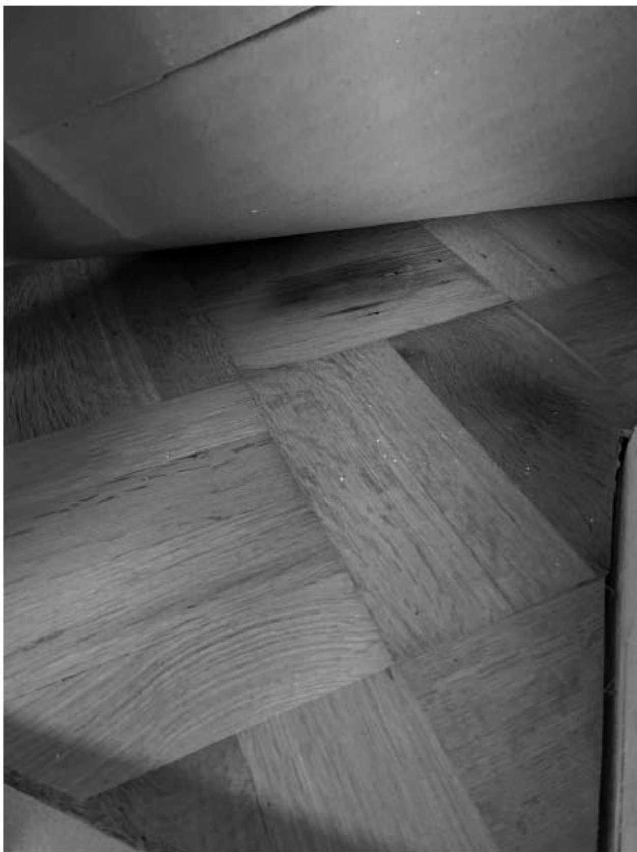
Фото 44. Вид на напольное покрытие в помещении квартиры № 39 объекта культурного наследия.
