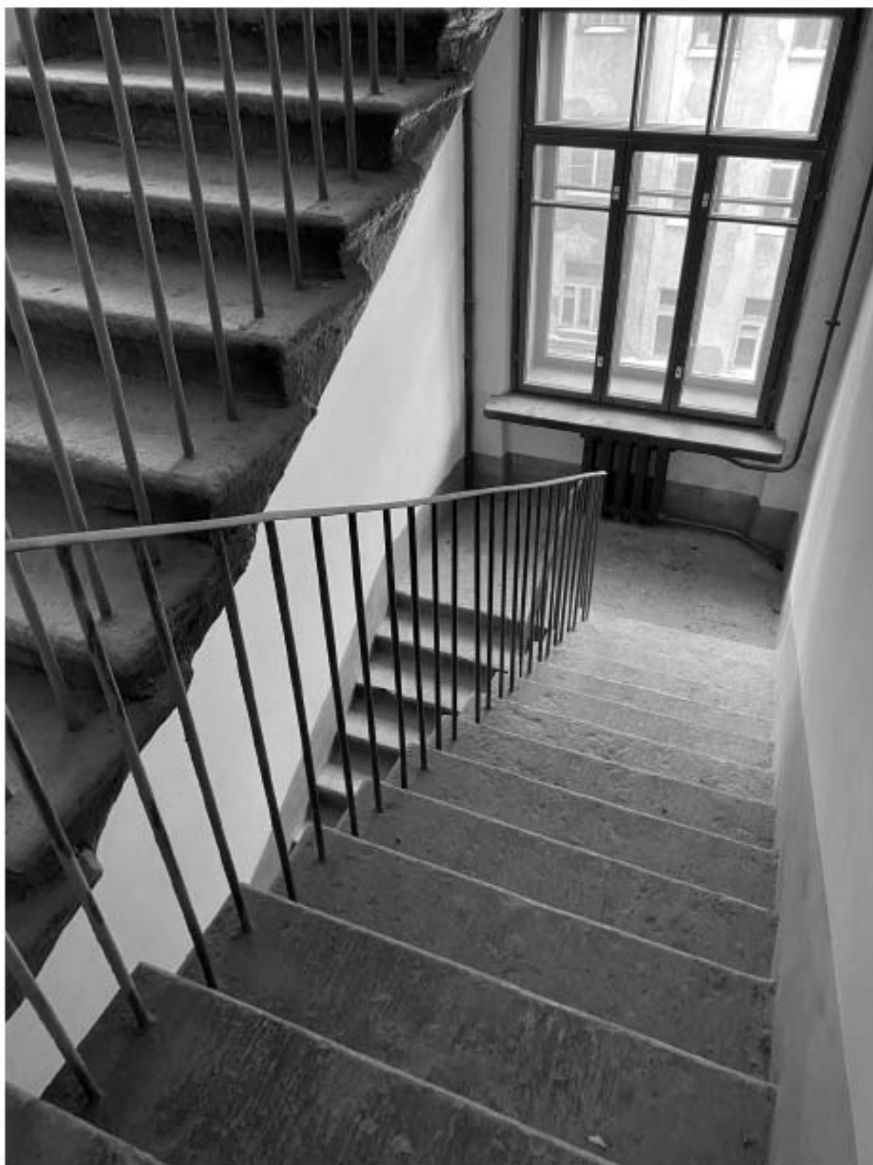
Фото 57. Вид на черную лестницу объекта культурного наследия.
