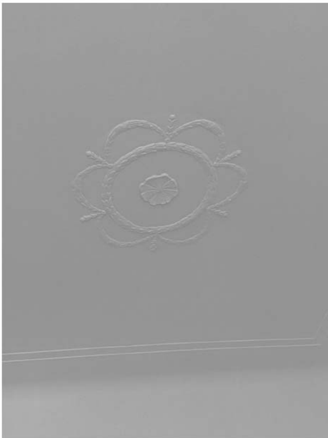
Фото 36. Вид на лепной декор в помещении квартиры № 39 объекта культурного наследия.
