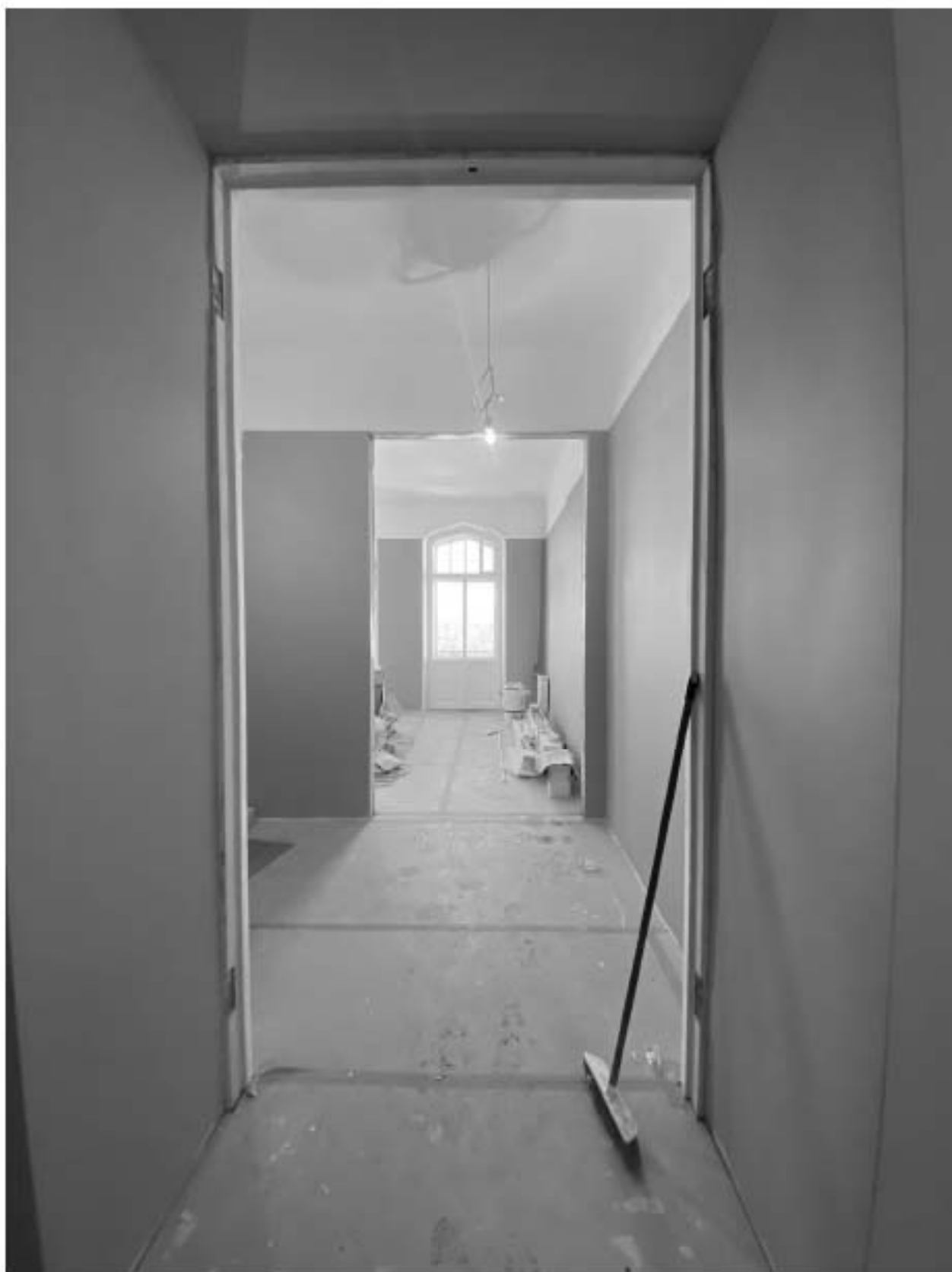
Фото 20. Вид на помещение квартиры № 39 объекта культурного наследия.
