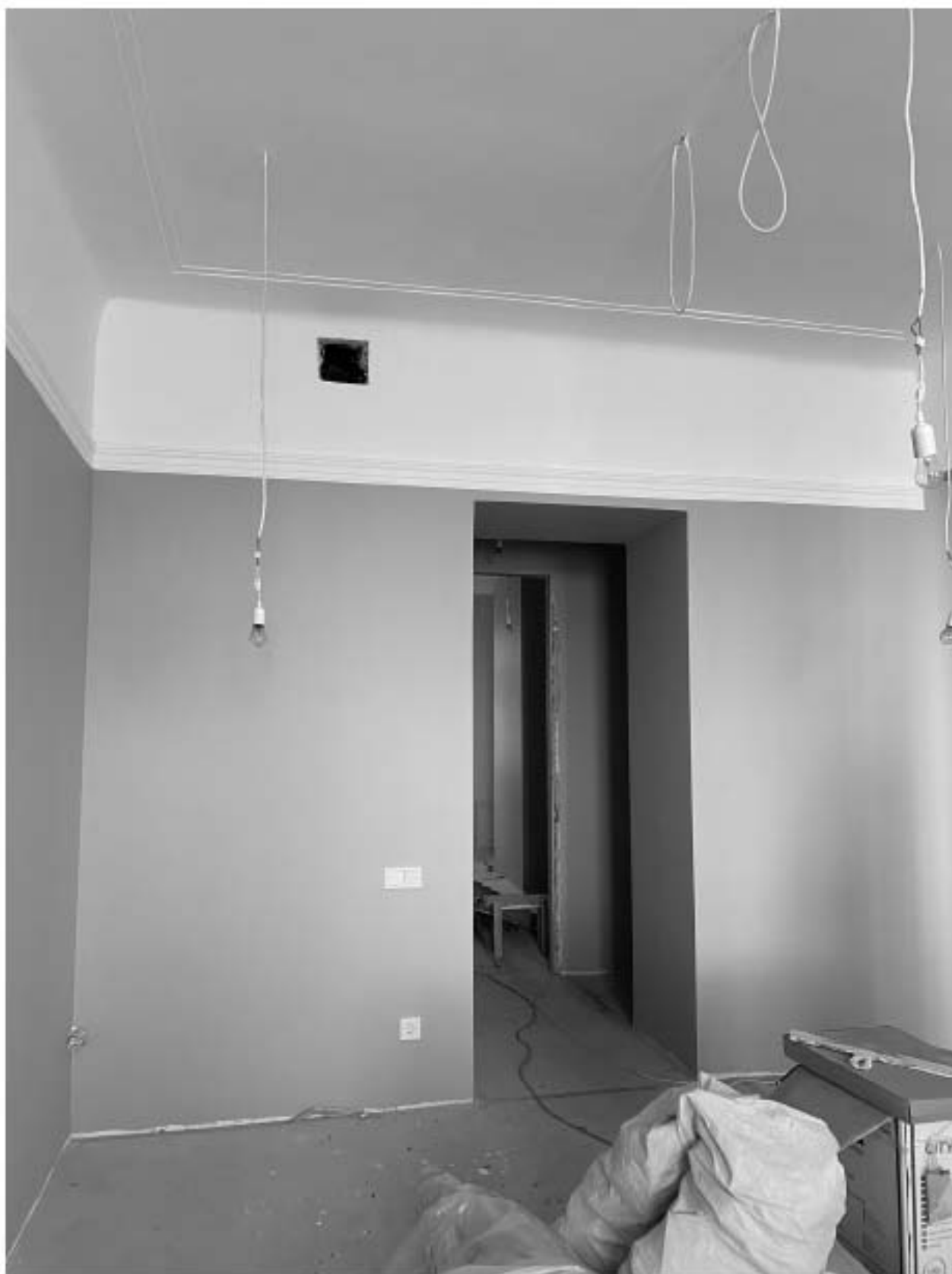
Фото 47. Вид на помещение квартиры № 39 объекта культурного наследия.
