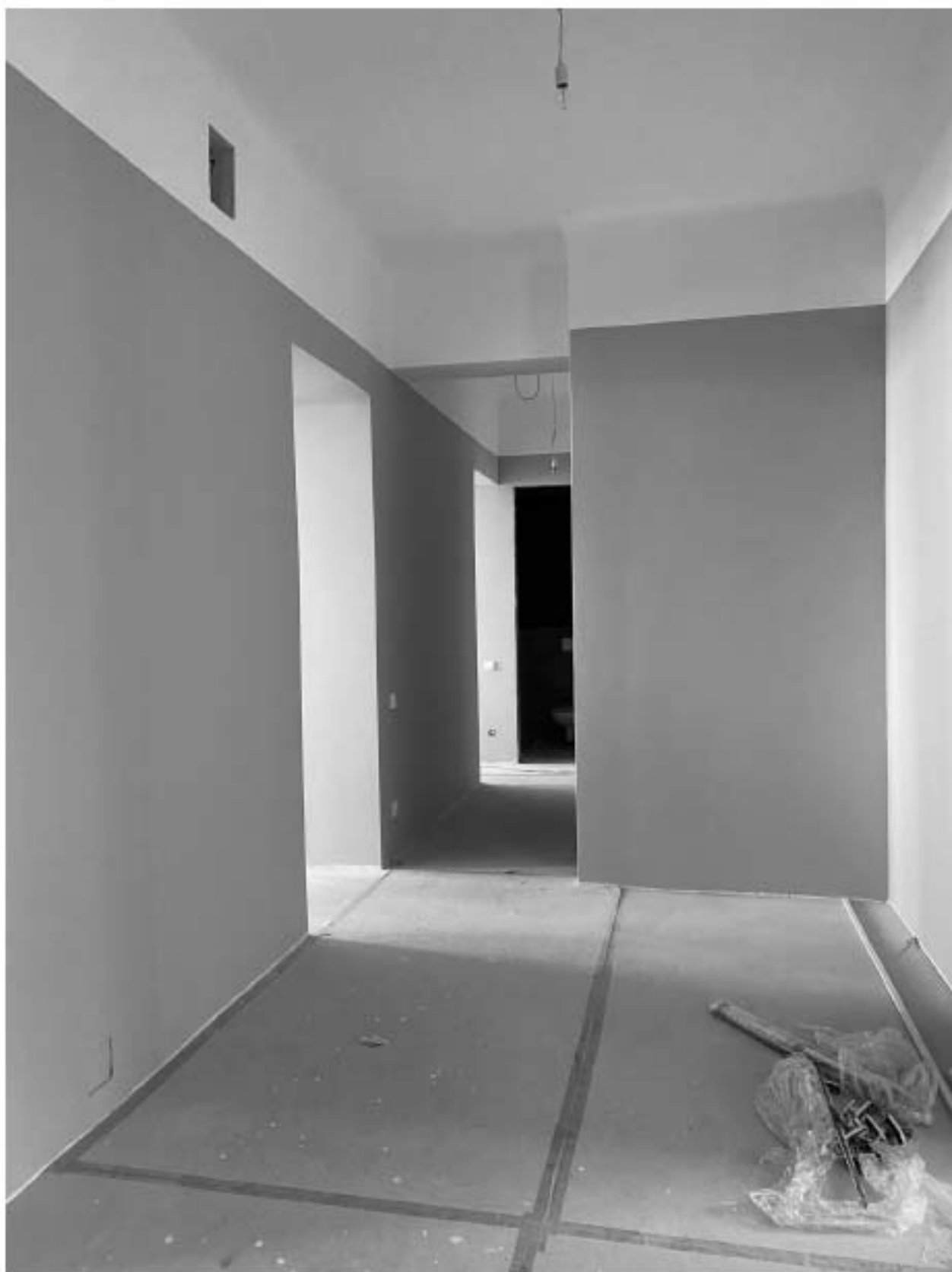
Фото 17. Вид на помещение квартиры № 39 объекта культурного наследия.
