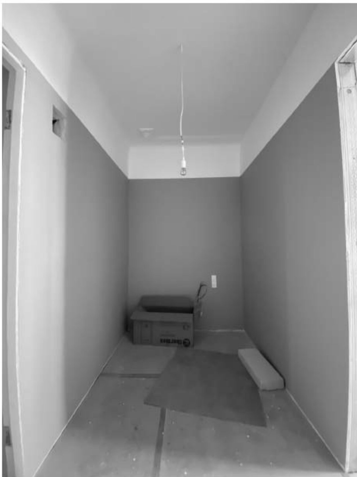
Фото 22. Вид на помещение квартиры № 39 объекта культурного наследия.
