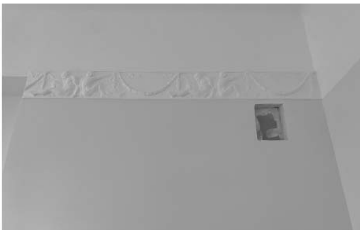
Фото 33. Вид на лепной декор в помещении квартиры № 39 объекта культурного наследия.
