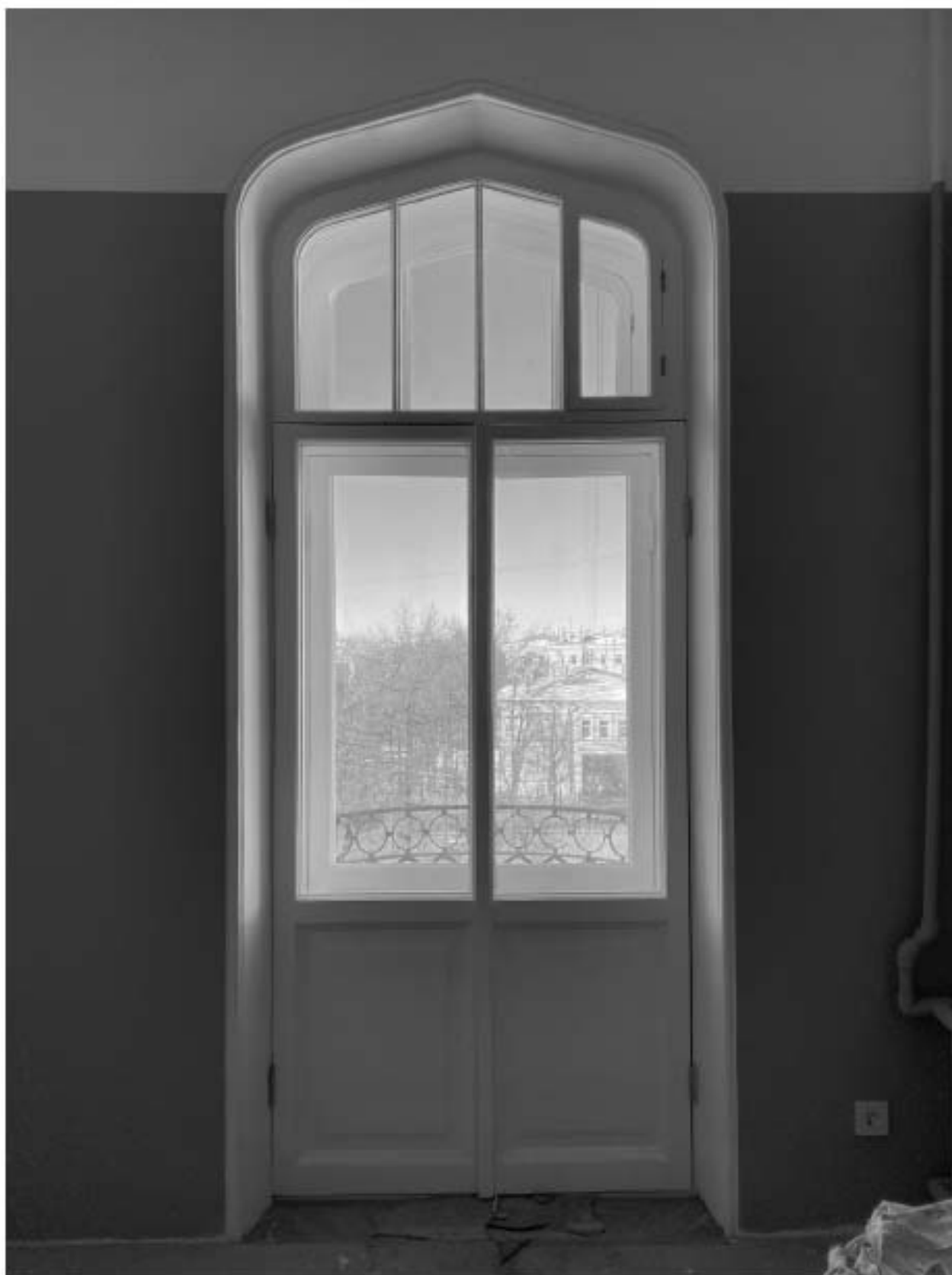
Фото 28. Вид на балконное заполнение в помещении квартиры № 39 объекта культурного наследия.
