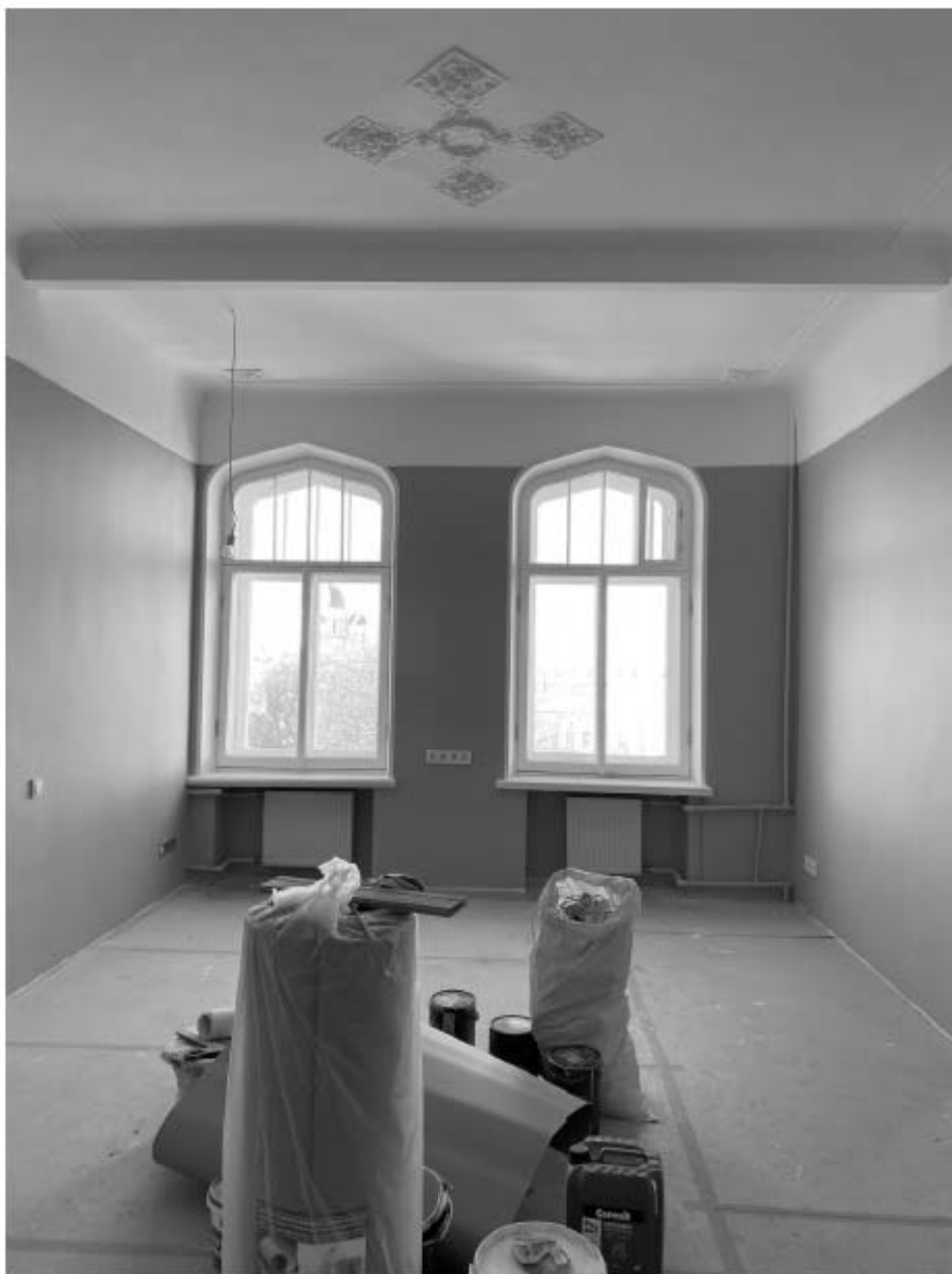
Фото 38. Вид на помещение квартиры № 39 объекта культурного наследия.
