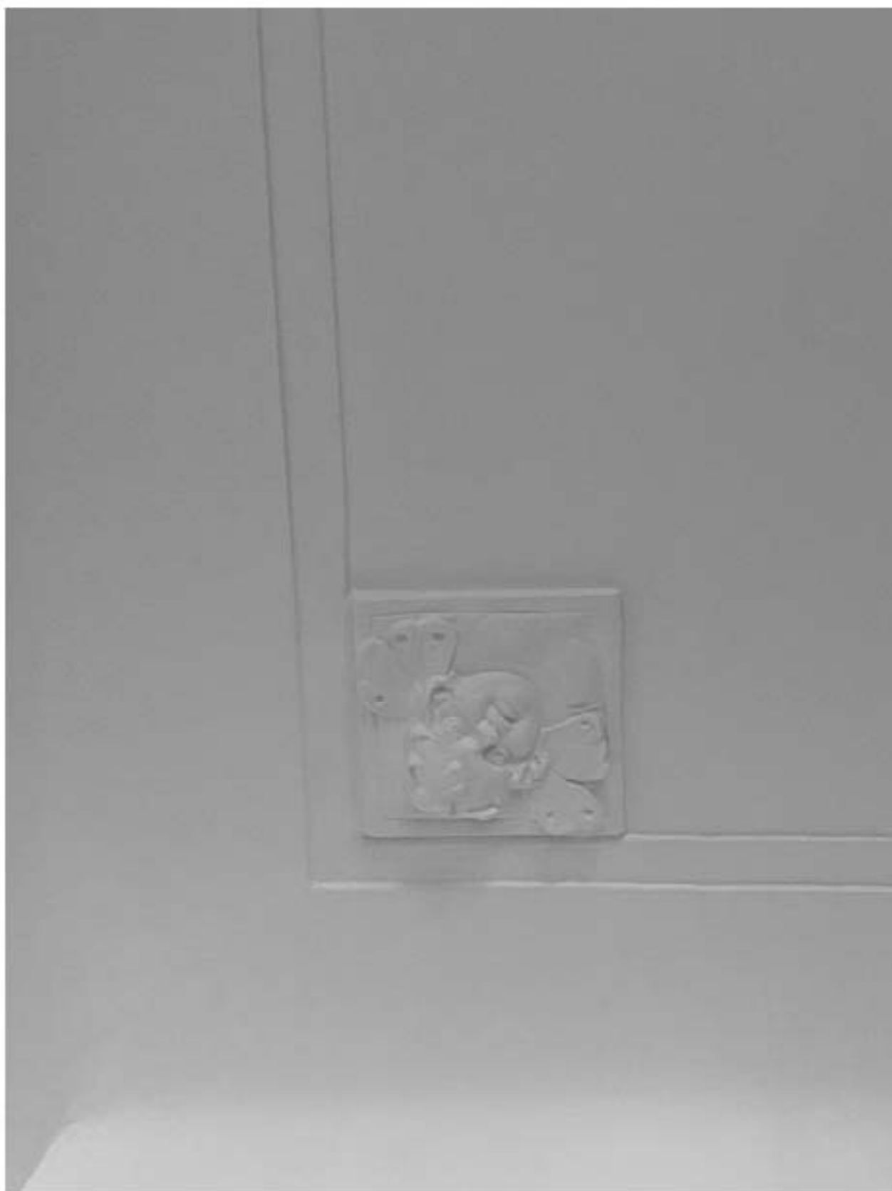
Фото 23. Вид на лепной декор в помещении квартиры № 39 объекта культурного наследия.
