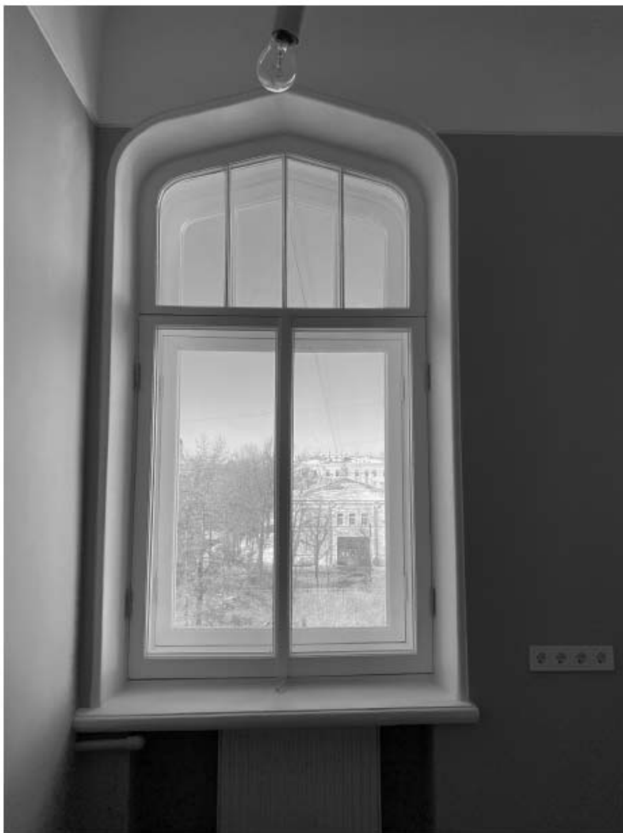
Фото 43. Вид на оконное заполнение в помещении квартиры № 39 объекта культурного наследия.
