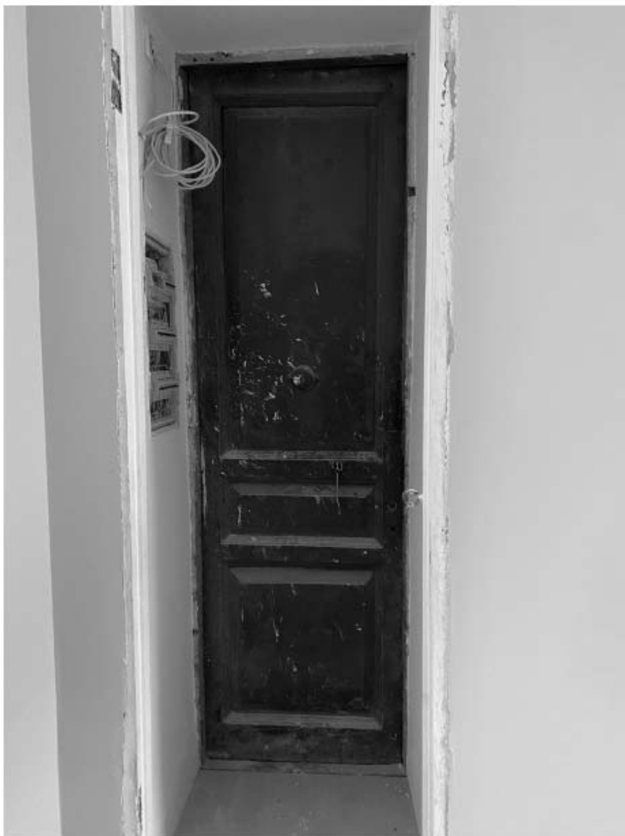
Фото 56. Вид на дверное заполнение в помещении квартиры № 39 объекта культурного наследия.
