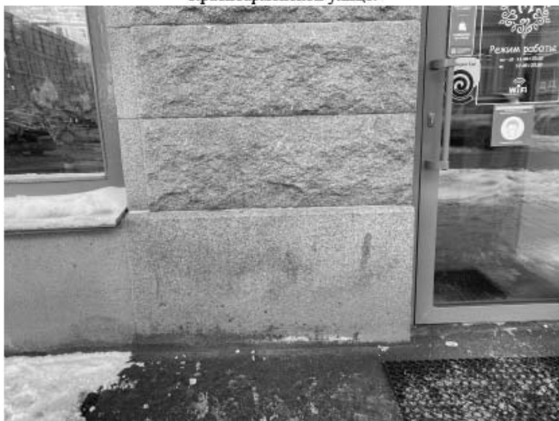
Фото 8. Фрагмент фасада объекта культурного наследия по 12-й Красноармейской улице.
