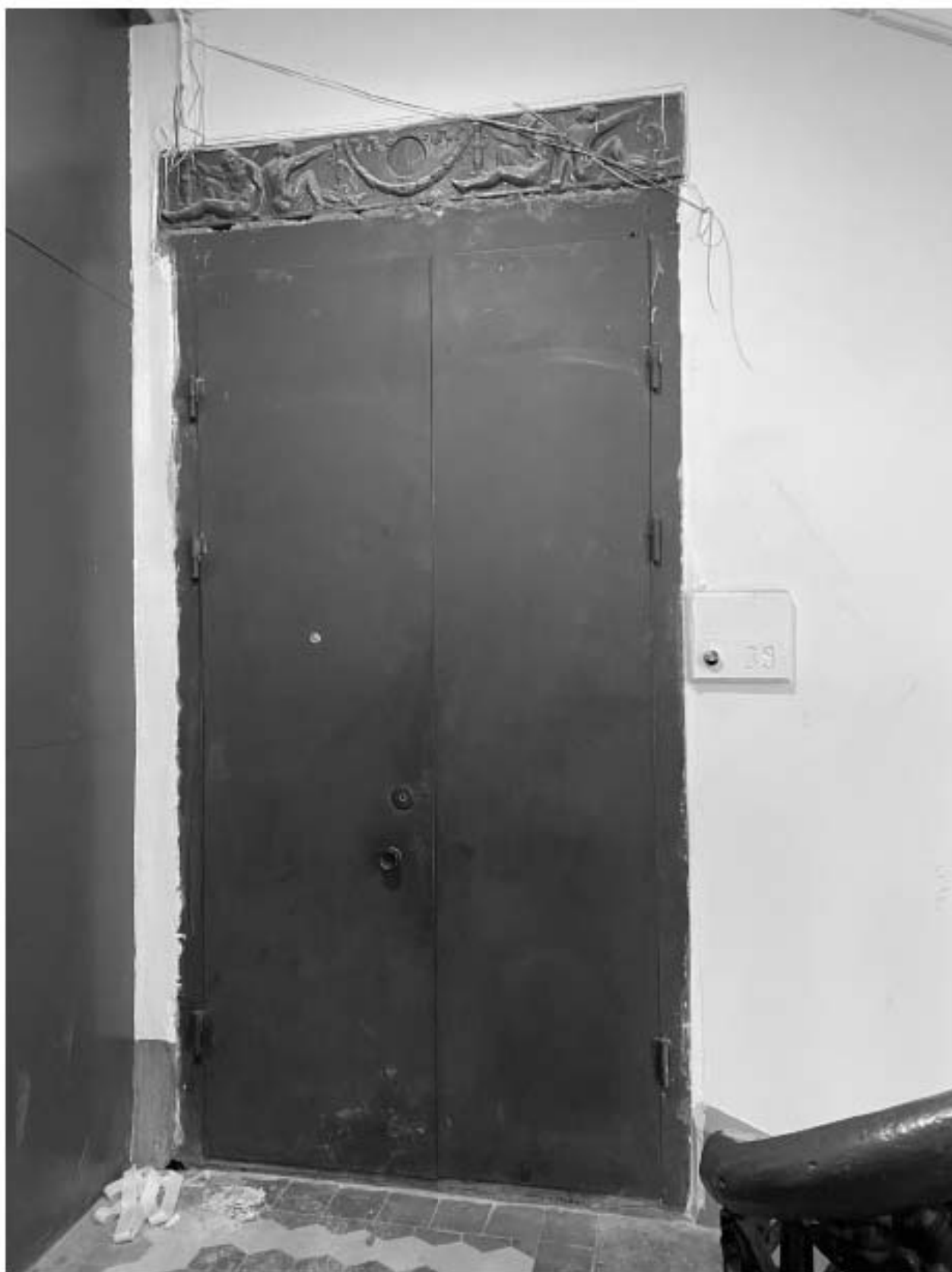
Фото 16. Вид на входную дверь в квартиру № 39 объекта культурного наследия.
