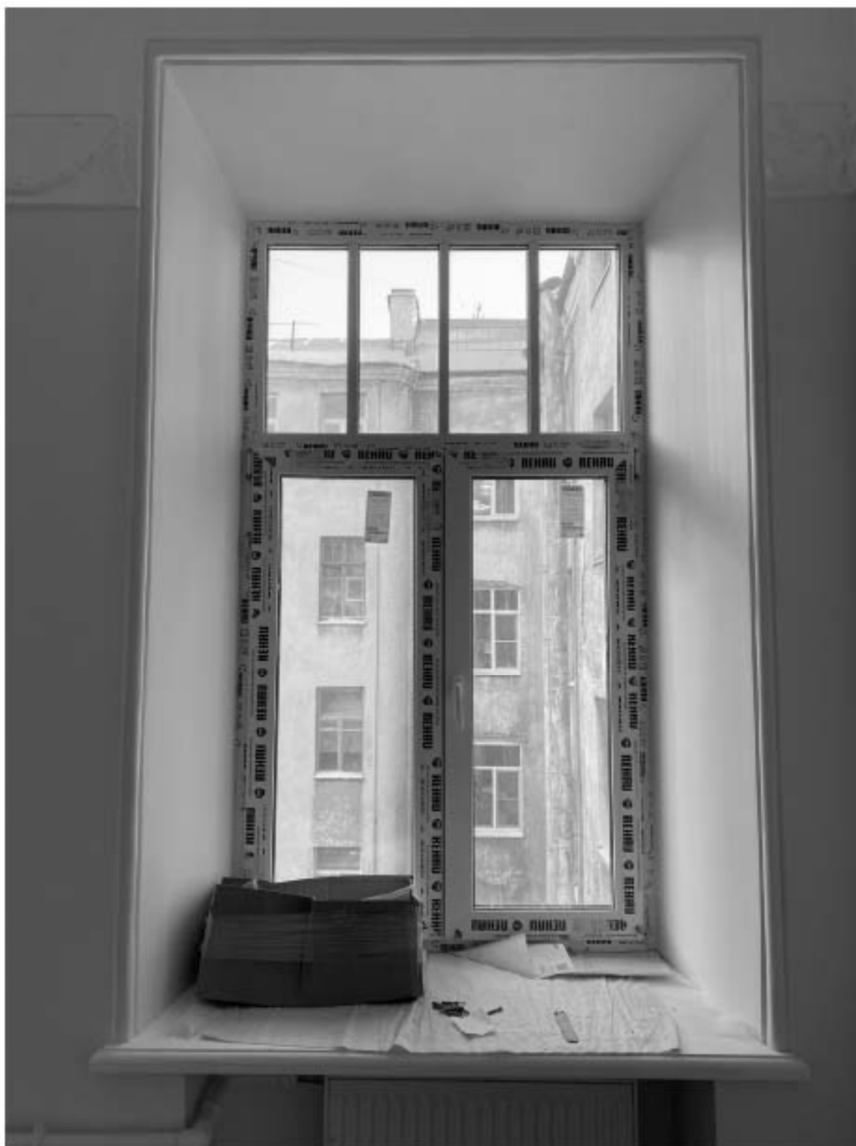
Фото 35. Вид на оконное заполнение в помещении квартиры № 39 объекта культурного наследия.
