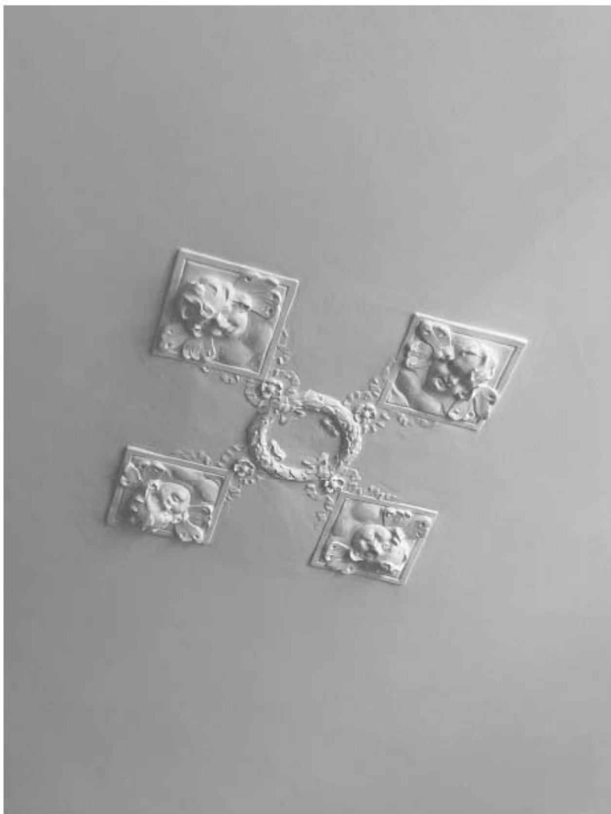
Фото 46. Вид на лепной декор в помещении квартиры № 39 объекта культурного наследия.
