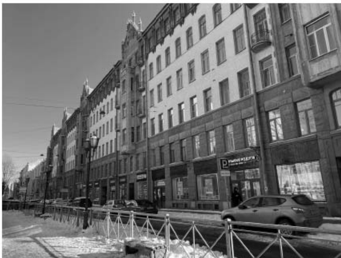
Фото 5. Фрагмент фасада объекта культурного наследия по 12-й Красноармейской улице.
