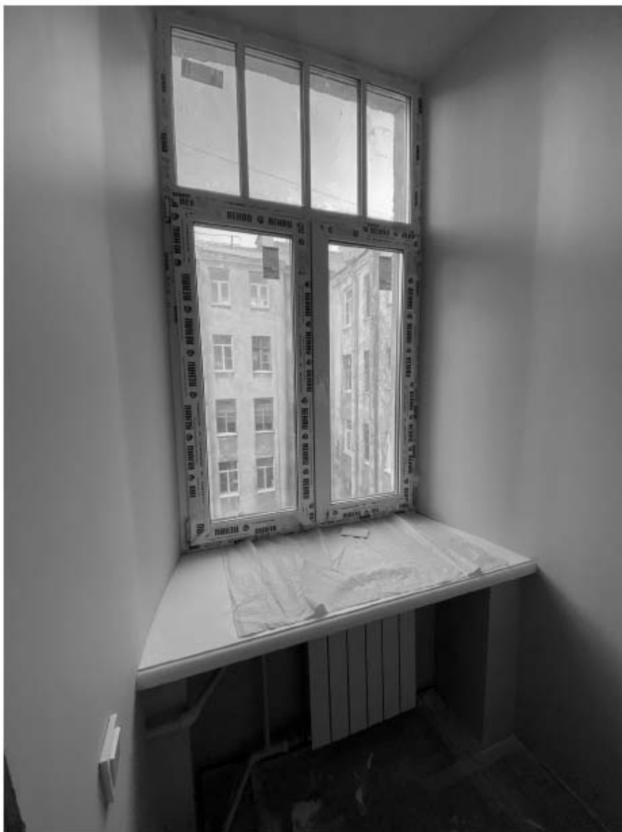
Фото 54. Вид на оконное заполнение в помещении квартиры № 39 объекта культурного наследия.
