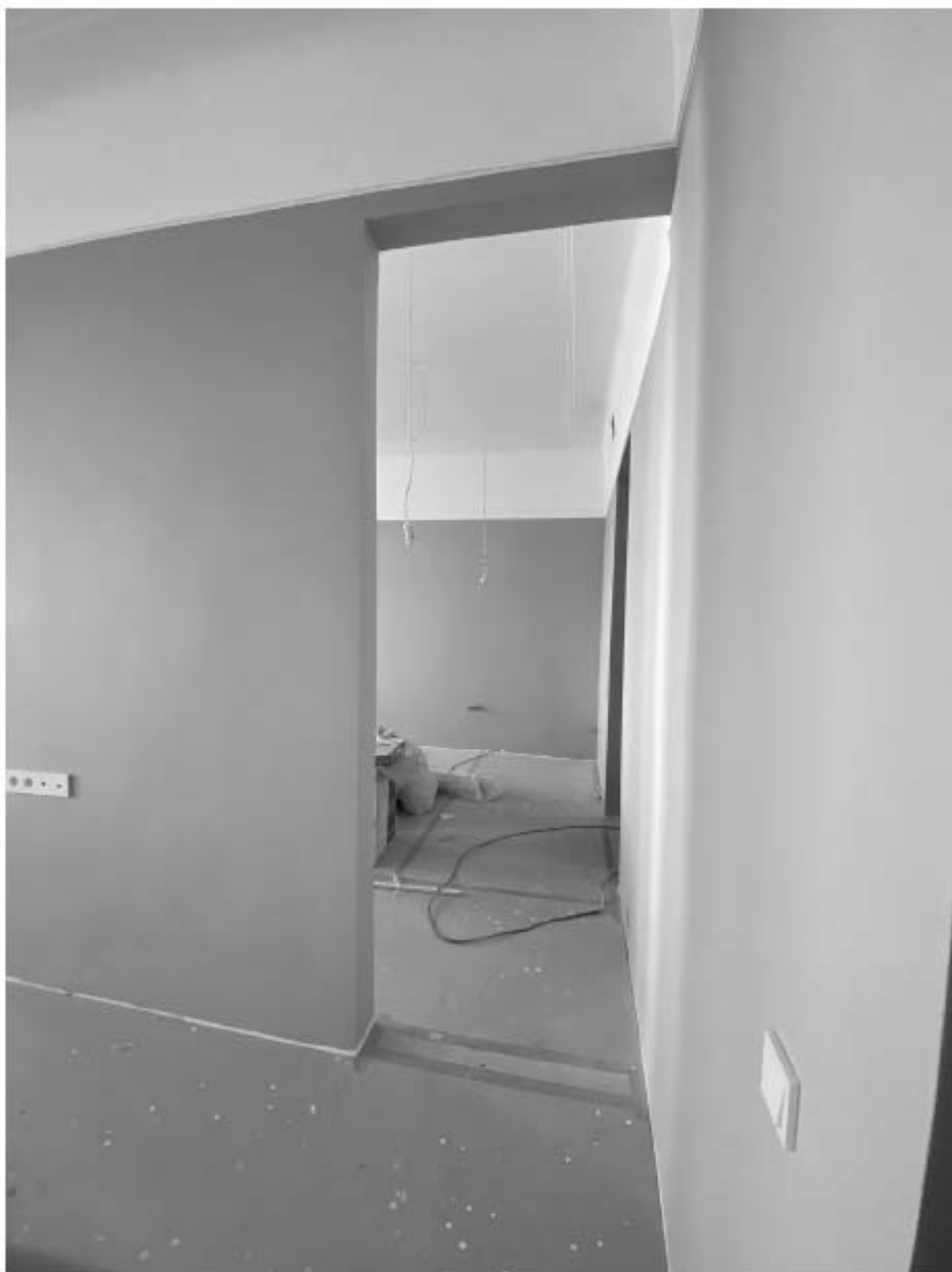
Фото 39. Вид на помещение квартиры № 39 объекта культурного наследия.
