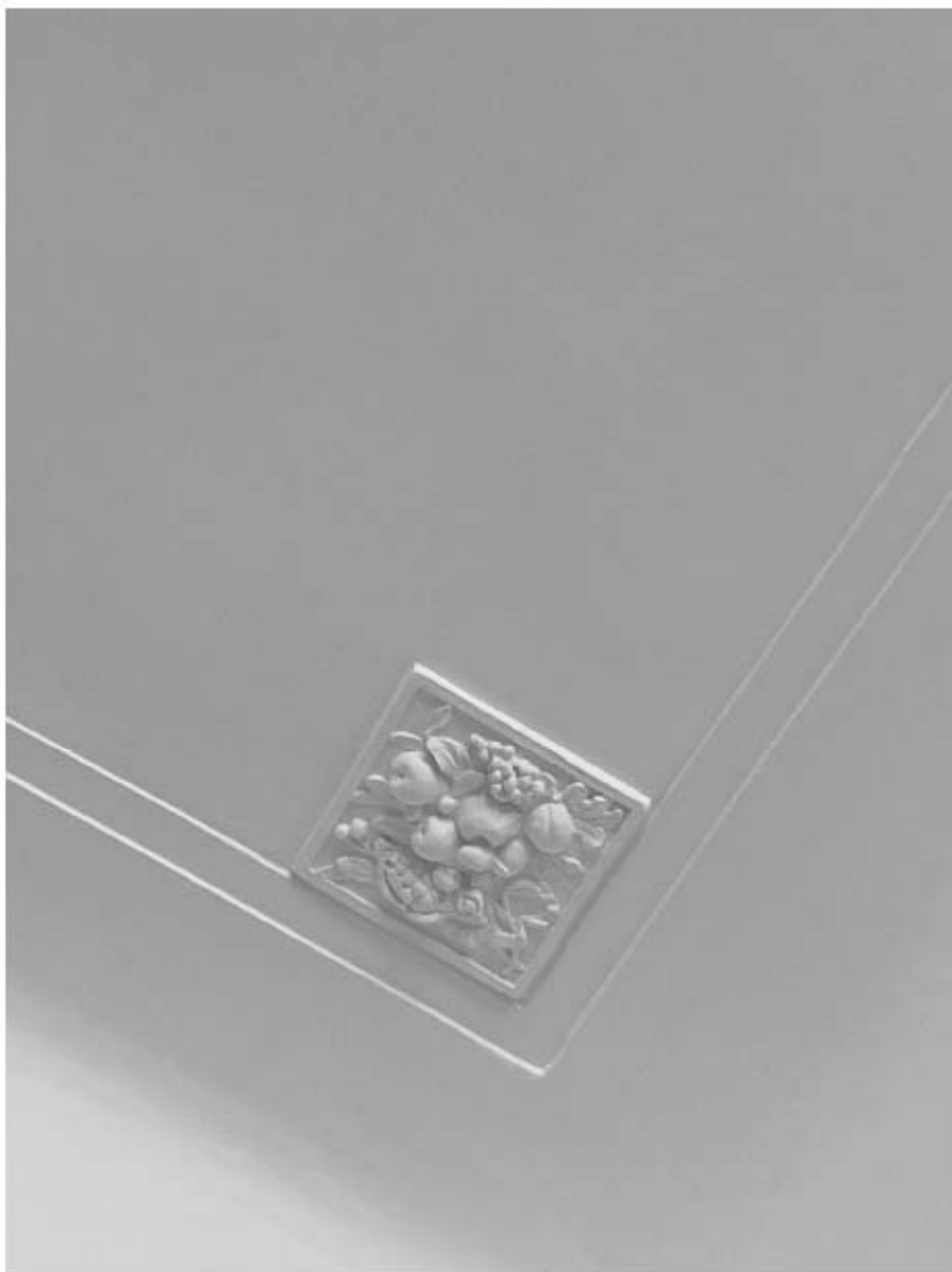
Фото 41. Вид на лепной декор в помещении квартиры № 39 объекта культурного наследия.
