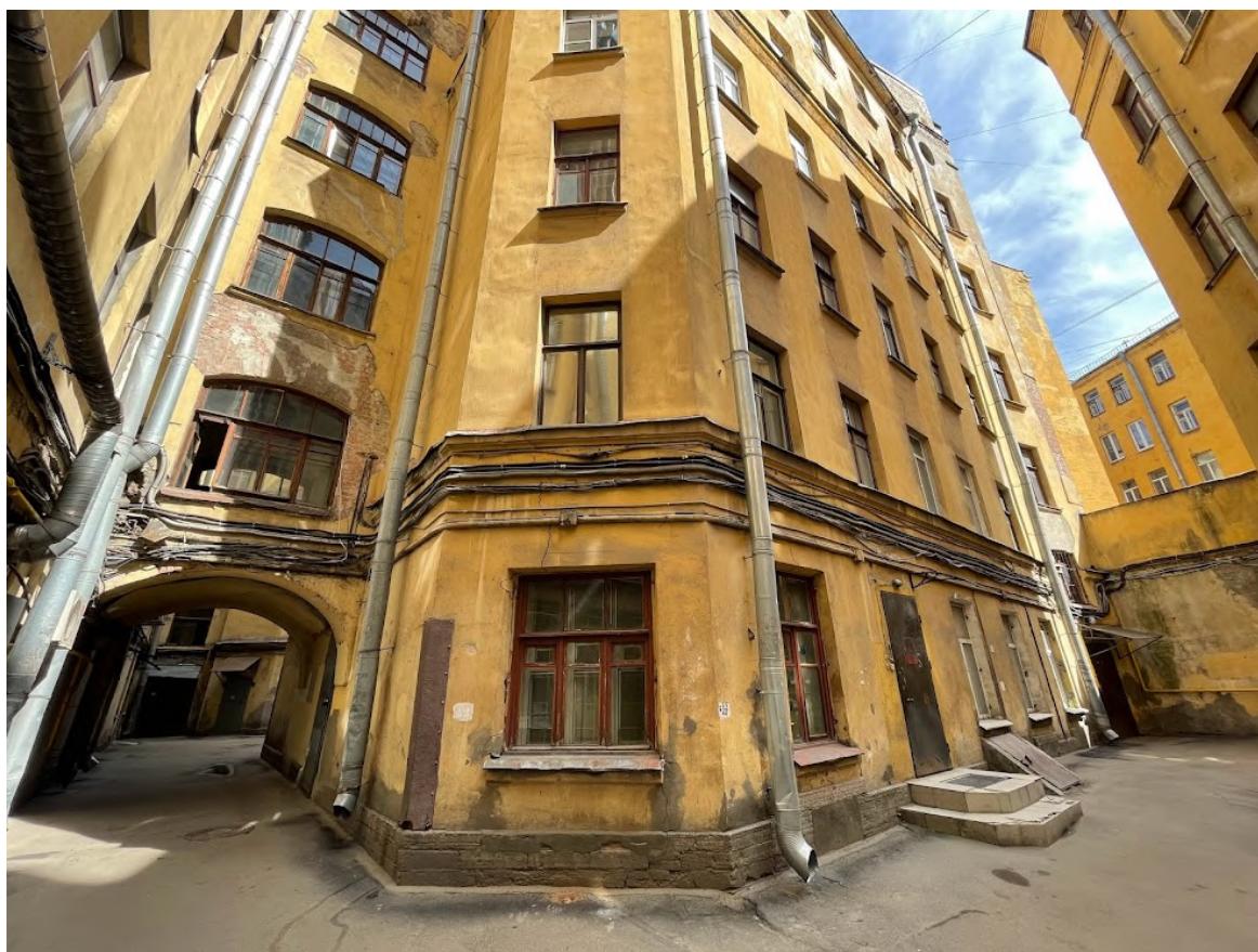
5. Фрагмент дворовых фасадов
