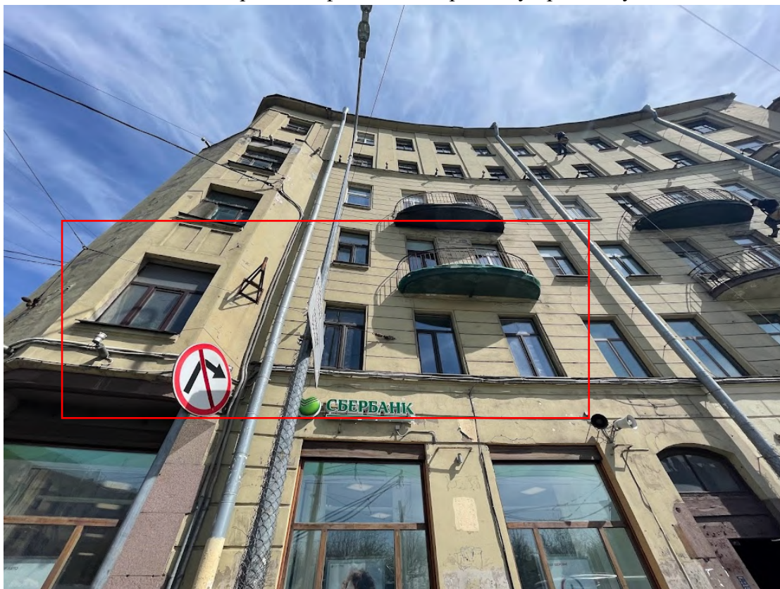
4. Фрагмент фасада, выходящего на площадь Стачек
