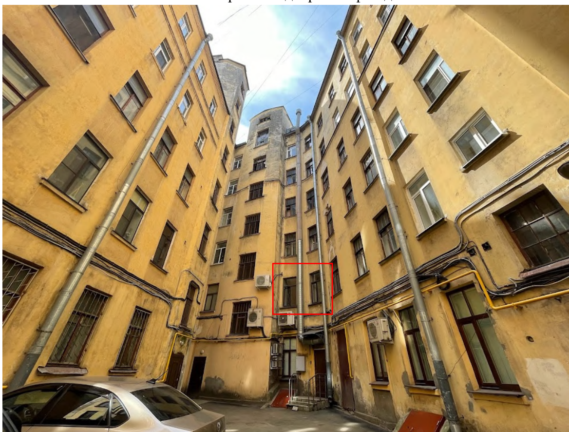
6. Фрагмент дворовых фасадов
