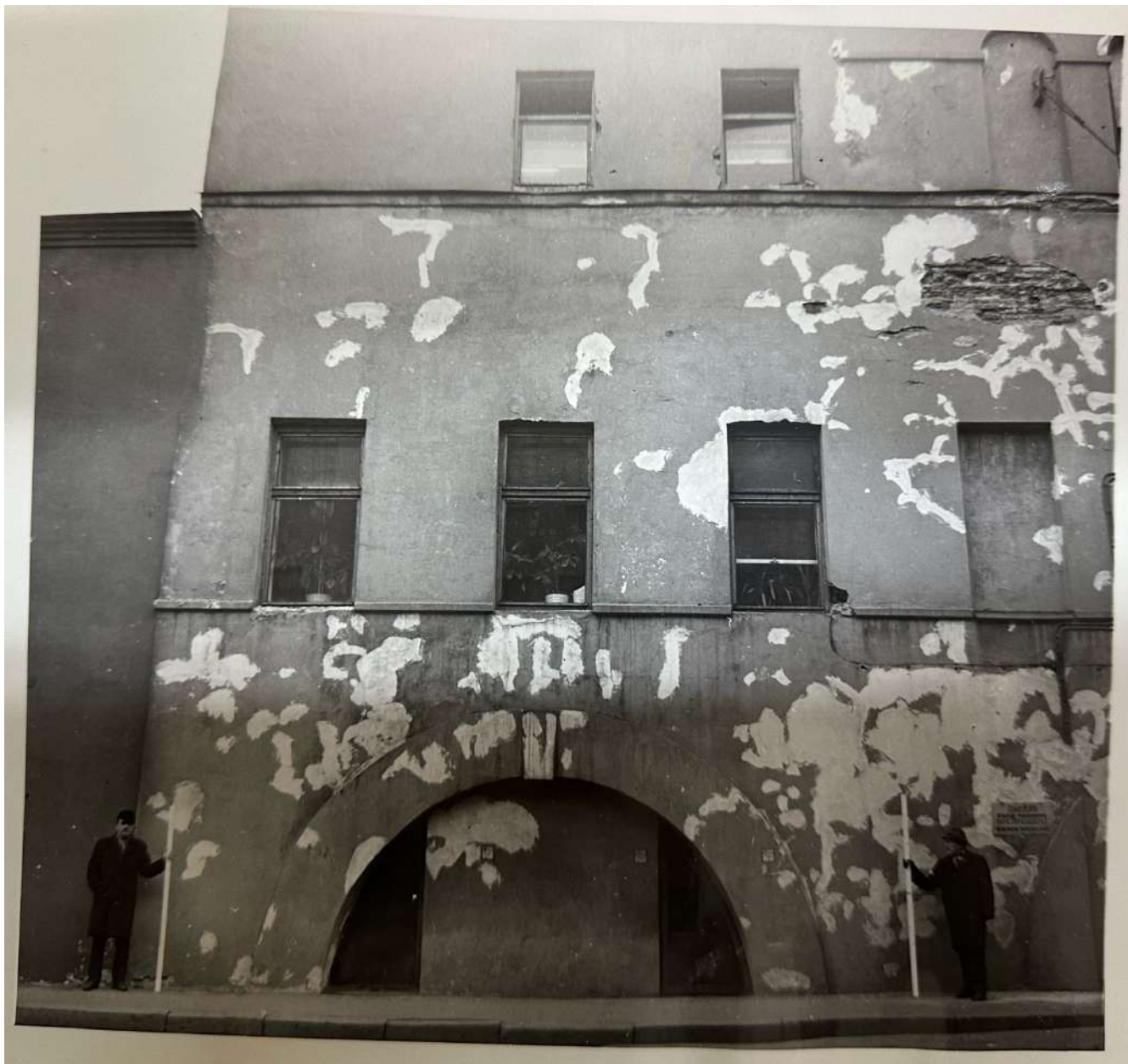
55. Фрагмент фасада строения по современному адресу Кожевенная линия, 27, корпус 1 литера А. Фотография. Автор неизвестен. Конец XX века. // Источник: Отдел систематизации, популяризации и хранения документированной информации об объектах культурного наследия (архив КГИОП). П.835, пр-2.
