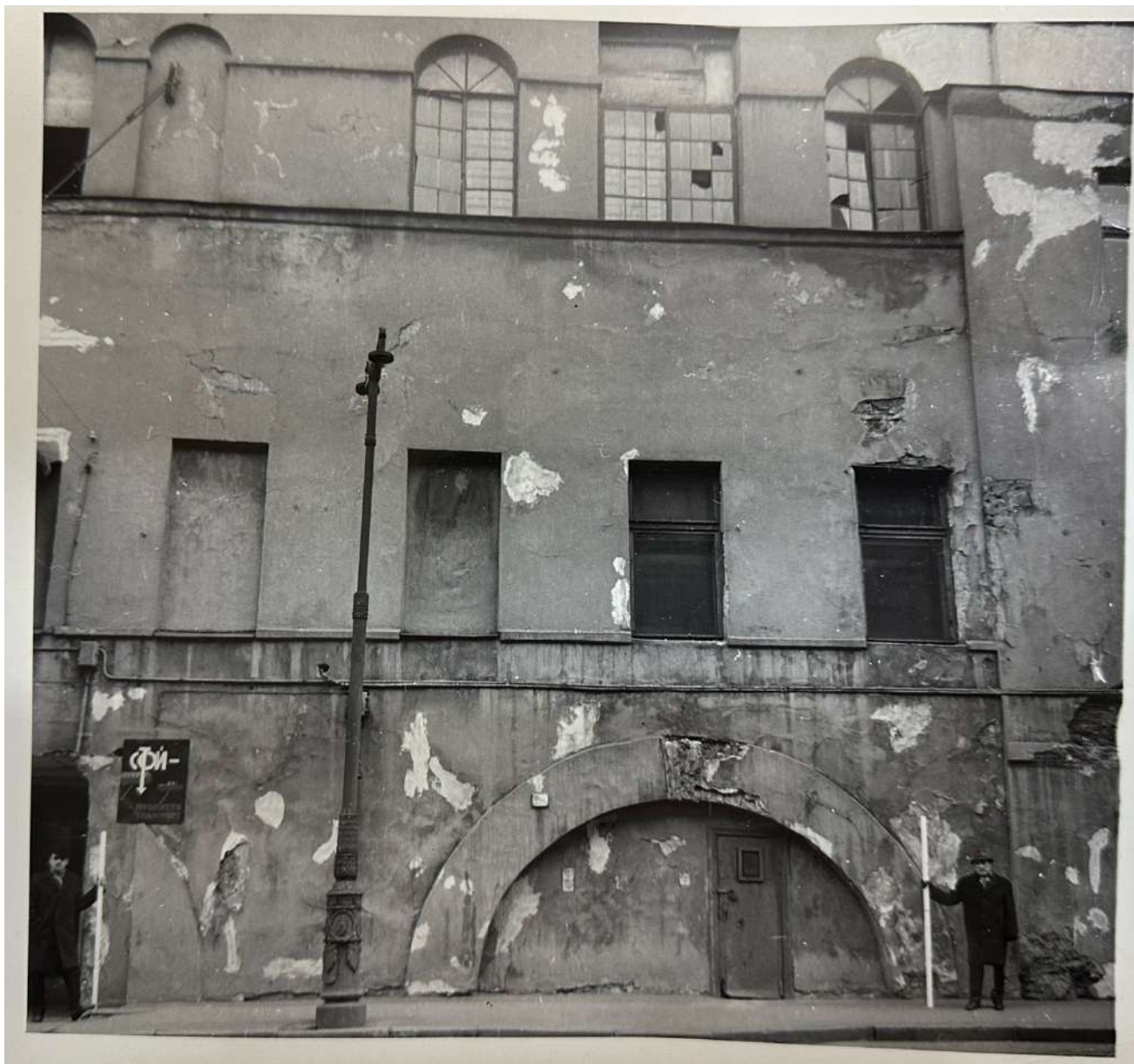
51. Фрагмент фасада строения по современному адресу Кожевенная линия, 27, корпус 1 литера А. Фотография. Автор неизвестен. Конец XX века. // Источник: Отдел систематизации, популяризации и хранения документированной информации об объектах культурного наследия (архив КГИОП). П.835, пр-2.
