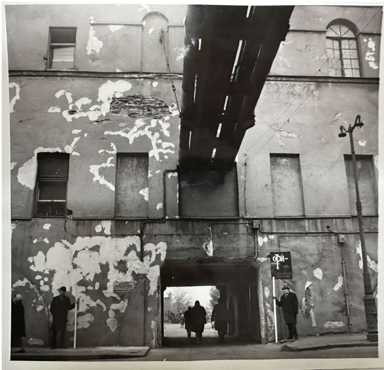
54. Фрагмент фасада строения по современному адресу Кожевенная линия, 27, корпус 1 литера А. Фотография. Автор неизвестен. Конец XX века. // Источник: Отдел систематизации, популяризации и хранения документированной информации об объектах культурного наследия (архив КГИОП). П.835, пр-2.
