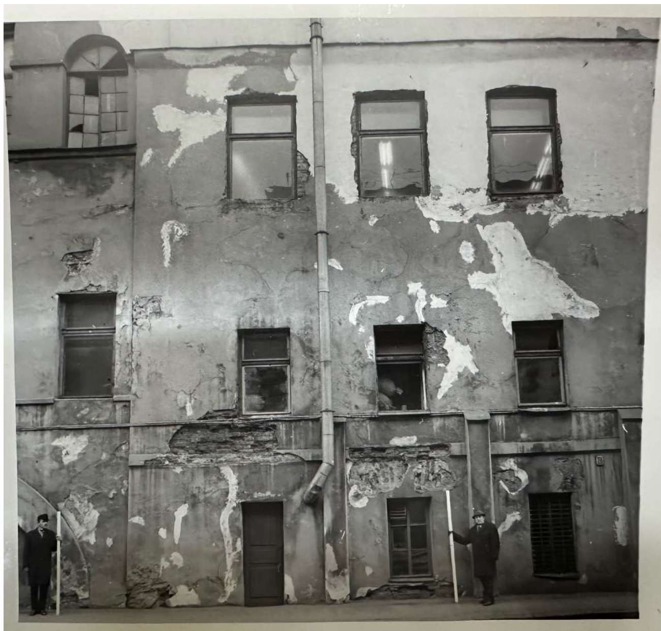
53. Фрагмент фасада строения по современному адресу Кожевенная линия, 27, корпус 1 литера А. Фотография. Автор неизвестен. Конец XX века. // Источник: Отдел систематизации, популяризации и хранения документированной информации об объектах культурного наследия (архив КГИОП). П.835, пр-2.
