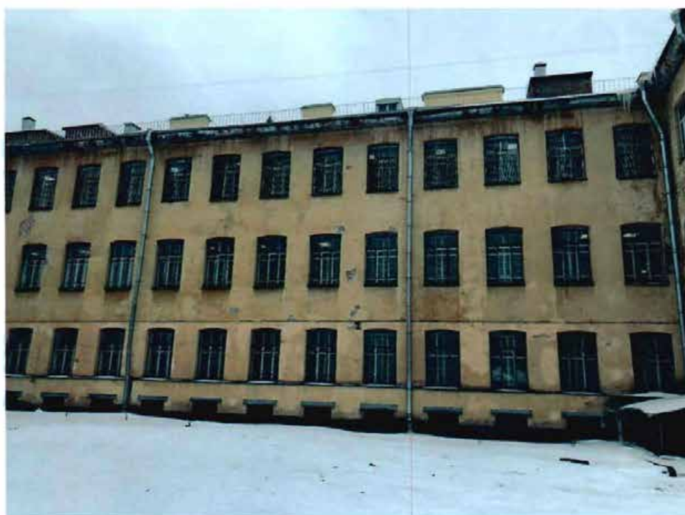
3. Фрагмент северного фасада объекта культурного наследия. Центральная часть.
