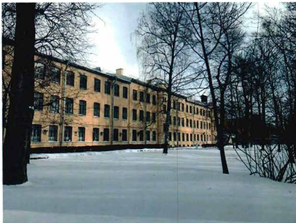
1. Южный фасад объекта культурного наследия.
