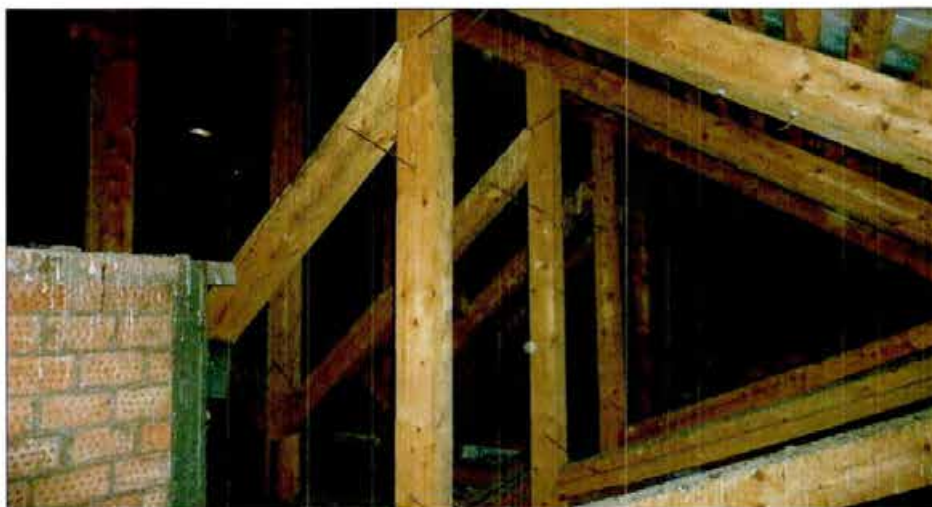
7. Стропильная система.
