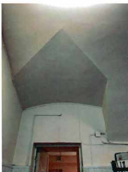
22. Внутренние помещения объекта культурного наследия. Помещение 1 этажа.
