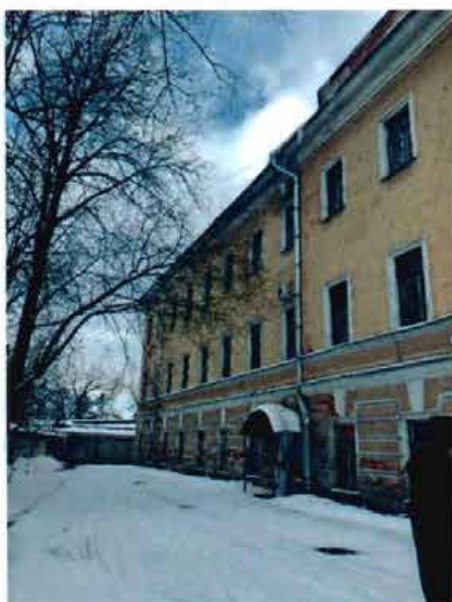
18. Фрагмент северного фасада объекта культурного наследия.
