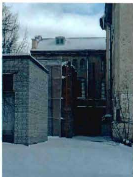
12. Западный фасад объекта культурного наследия.
