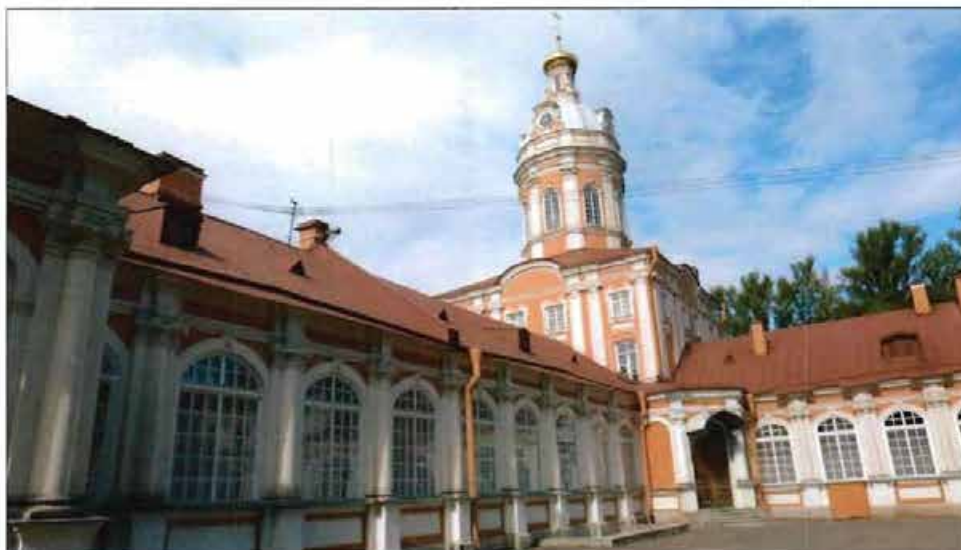
7. Северная часть восточного фасада и северная башня. Вид с юго-востока.
