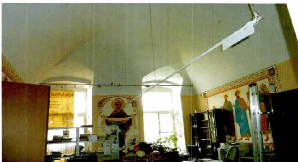
10. Сводчатые перекрытия в уровне первого этажа.
