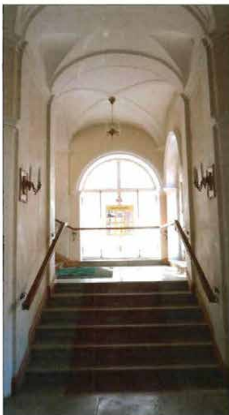
3. Лестница. Первый этаж.
