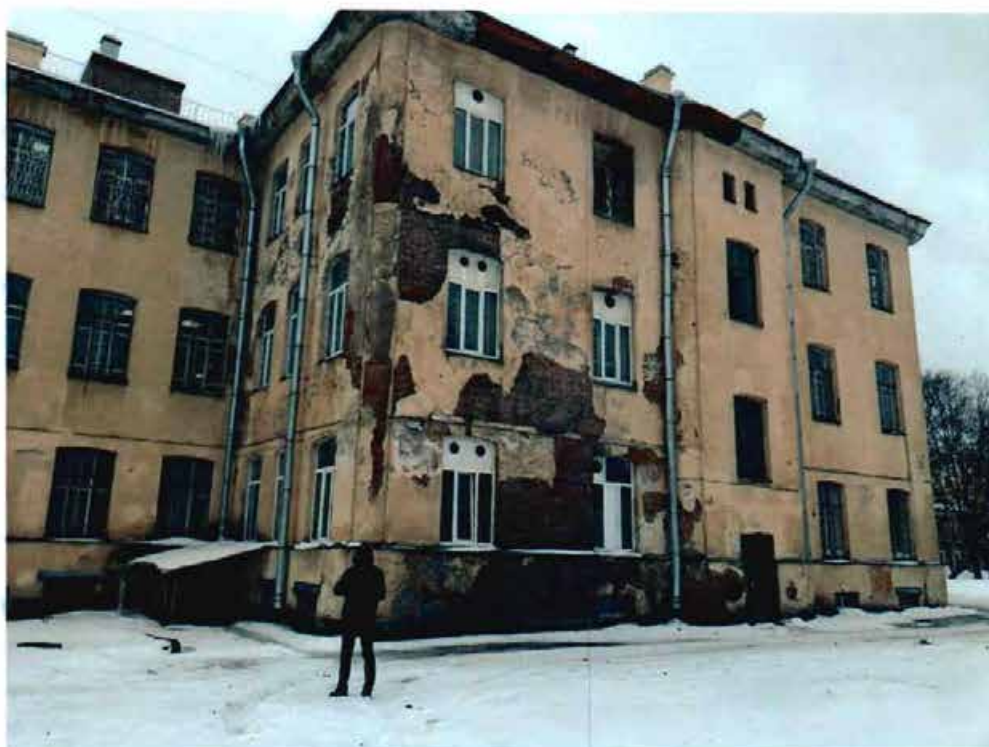
2. Фрагмент северного фасада объекта культурного наследия. Западный ризалит.
