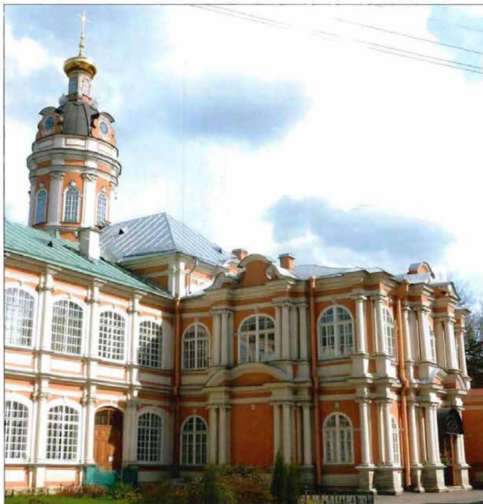
1. Общий вид с северо-запада.
