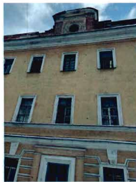
19. Фрагмент северного фасада объекта культурного наследия.
