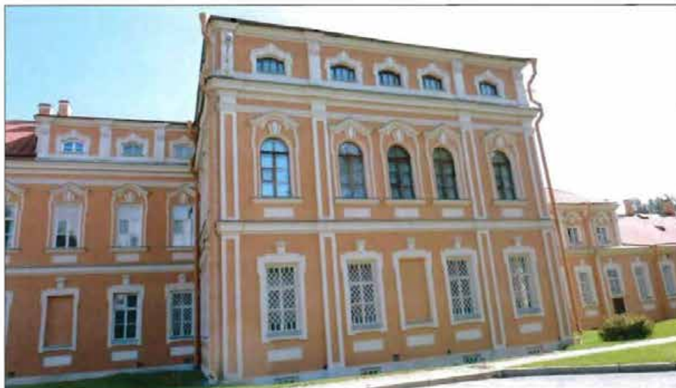
3. Западный фасад. Фрагмент.
