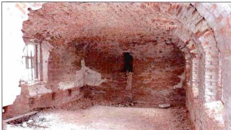
7. Коробовые с распалубкой свода. Помещение второго этажа.
