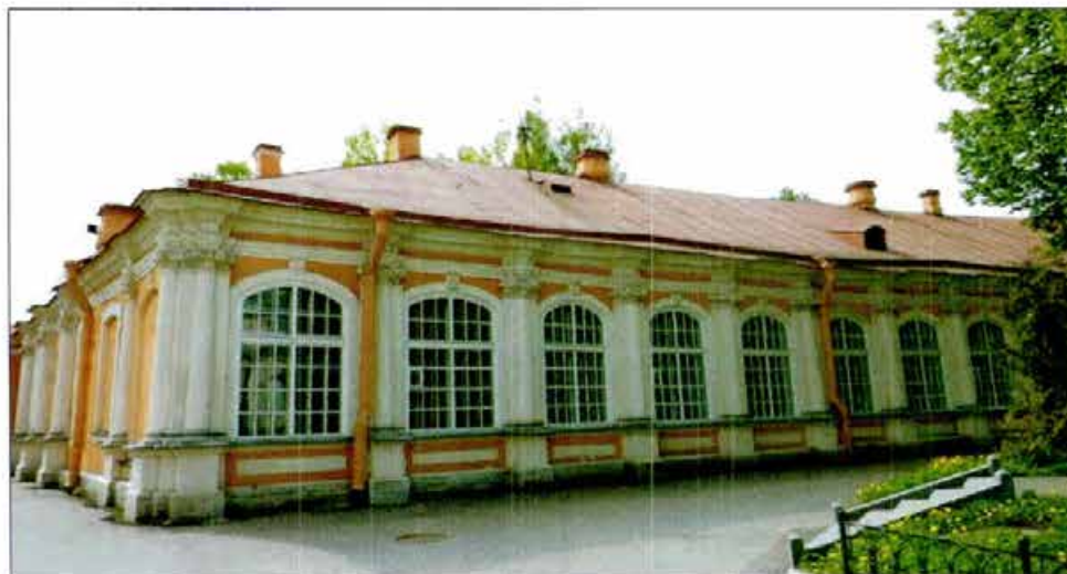
2 Восточная часть здания. Вид с севера.
