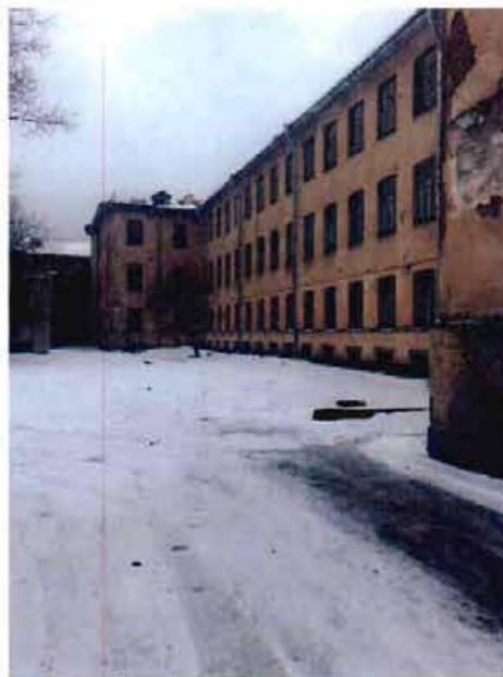
29. Вид на фрагмент территории со стороны южного фасада объекта культурного наследия регионального значения «Новый корпус».
