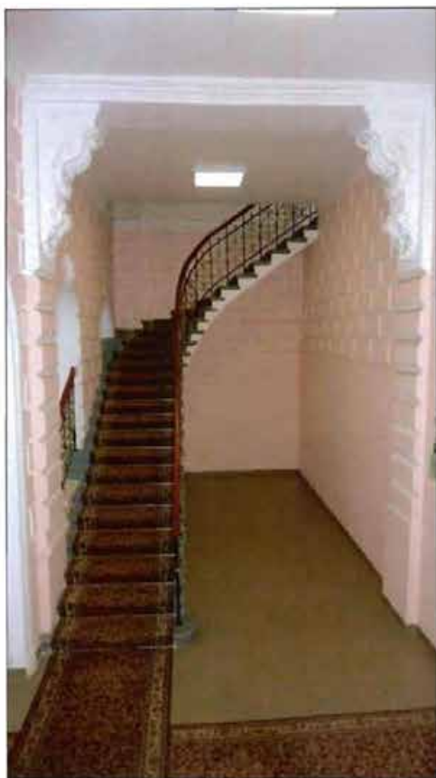
10. Лестница в северной части здания.
