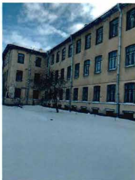
4. Фрагмент северного фасада объекта культурного наследия.
