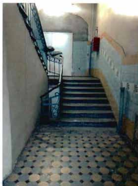
9. Помещение западной лестничной клетки (лестницы Л-3) объекта культурного наследия.
