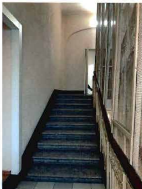
8. Помещение восточной лестничной клетки (лестницы Л-4) объекта культурного наследия.
