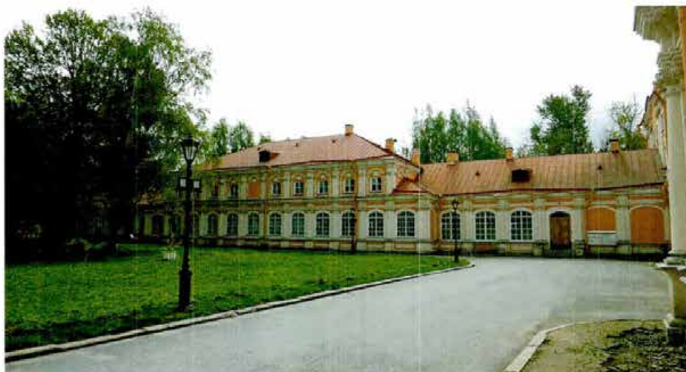
1.Общий вид с северо-запада.
