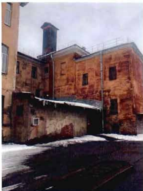
28. Вид на фрагмент территории со стороны северного фасада объекта культурного наследия регионального значения «Отделение для малолетних». Одноэтажная пристройка.
