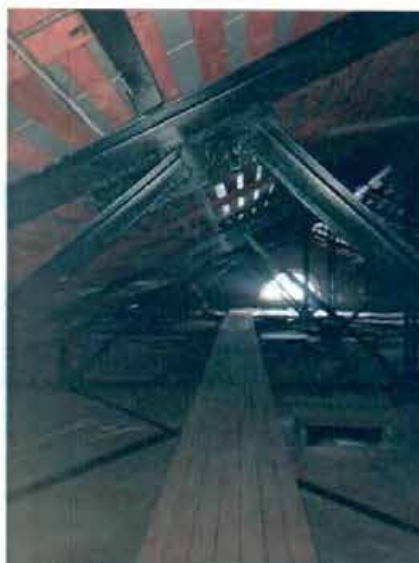
13. Помещение чердака объекта культурного наследия.
