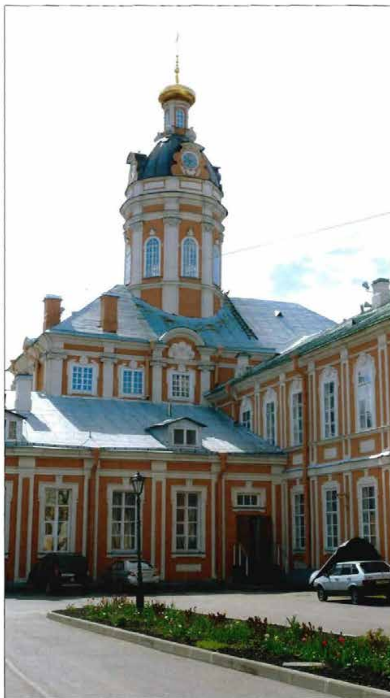
2. Общий вид с северо-востока.
