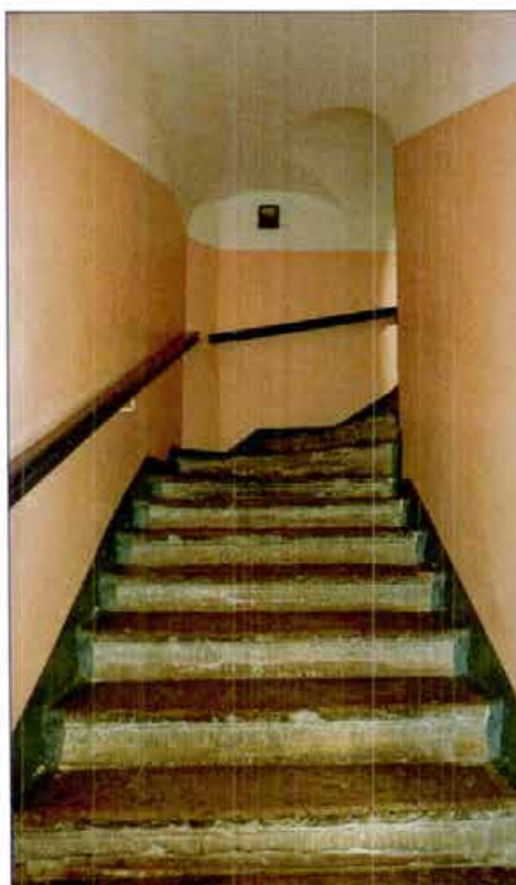
8. Лестница в западной части здания.
