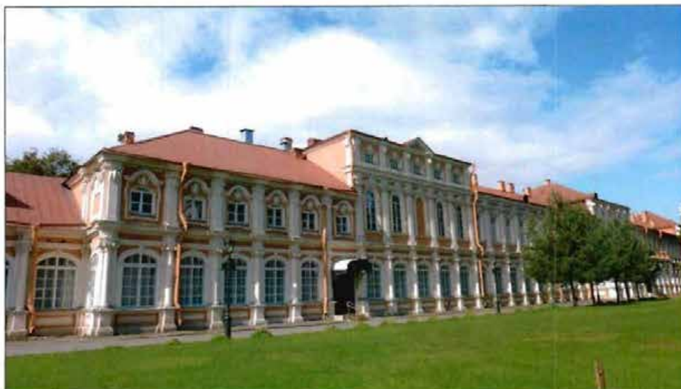
5. Южная часть восточного фасада. Вид с юго-востока.
