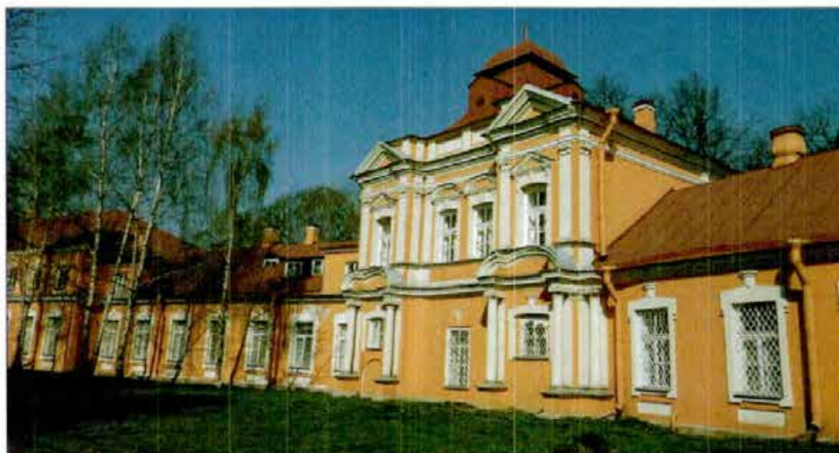
4. Южный фасад. Башенный объем. Вид с юго-востока.
