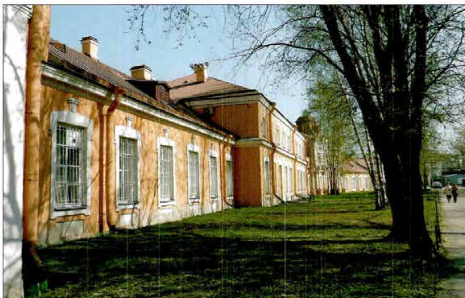
3. Общий вид с юго-запада.
