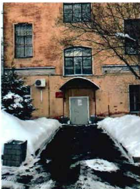
16. Фрагмент южного фасада объекта культурного наследия. Главный вход.
