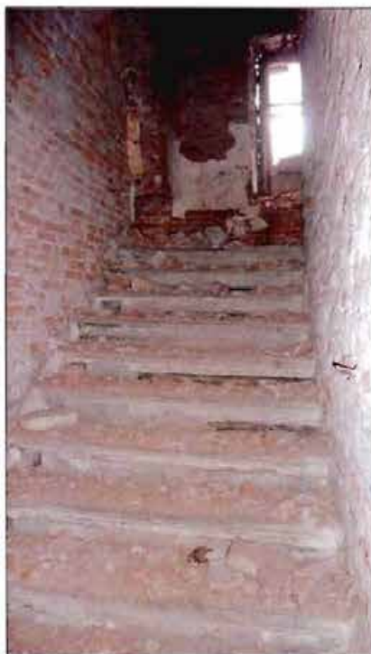
5. Лестница между первым и вторым этажами.
