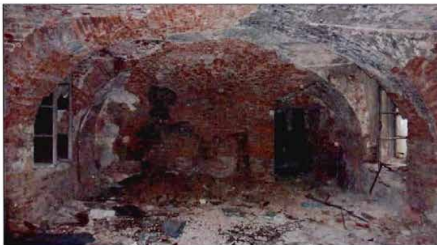
6. Коробовые с распадубкой свода. Помещение первого этажа.
