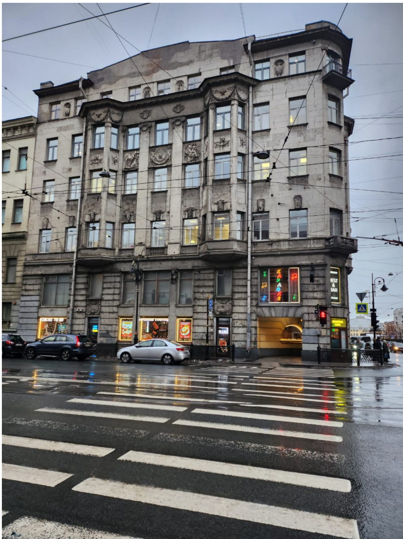
Фото 2. Лицевой фасад по Литейному пр. - место предполагаемой установки мемориальной доски.
