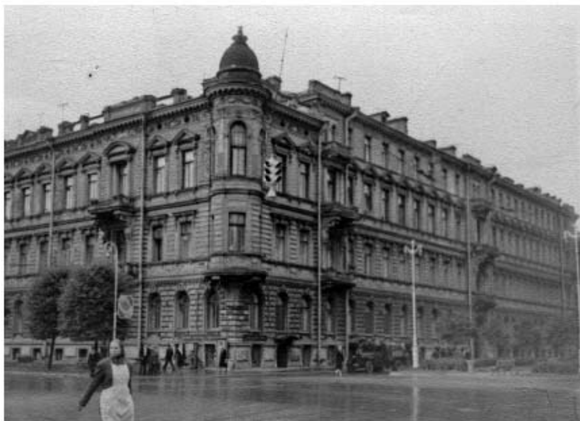
Илл. 46. Перекресток проспекта Чернышевского и улицы Чайковского. 1946-1953 гг. Retro View of Mankind's Habitat [Электронный ресурс] URL: https://pastvu.com/p/778744
