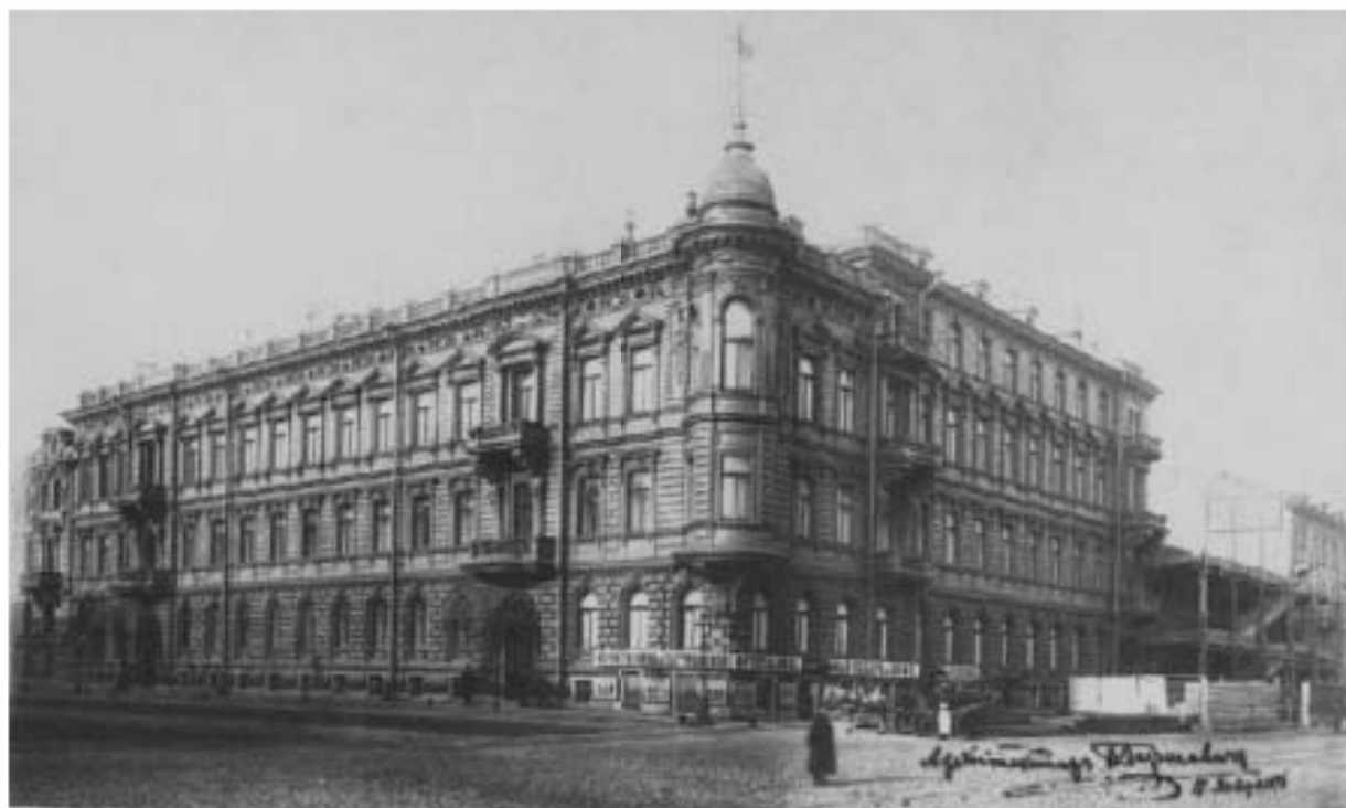
Илл. 44. Дом П. П. Вейнера. 1892-1896 гг. Retro View of Mankind's Habitat [Электронный ресурс] URL: https://pastvu.com/p/626407
