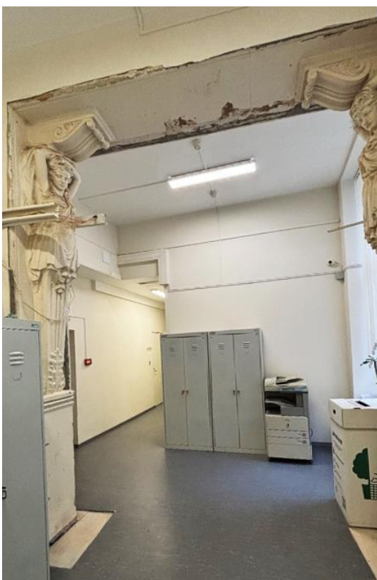
4. «Дом Волконской», Графский переулок, дом 2/48, литера А. Второй этаж. Помещение №106. Общий вид. Фото 01.12.2023г.
