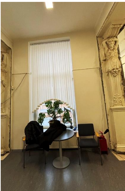
3. «Дом Волконской», Графский переулок, дом 2/48, литера А. Второй этаж. Помещение №106. Общий вид. Фото 01.12.2023г.
