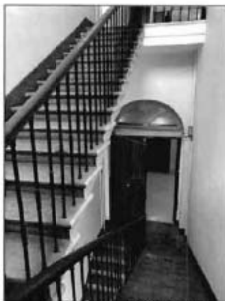
6. Лестница Л2. Общий вид. (фотофиксация выполнена 18.02.2021)
