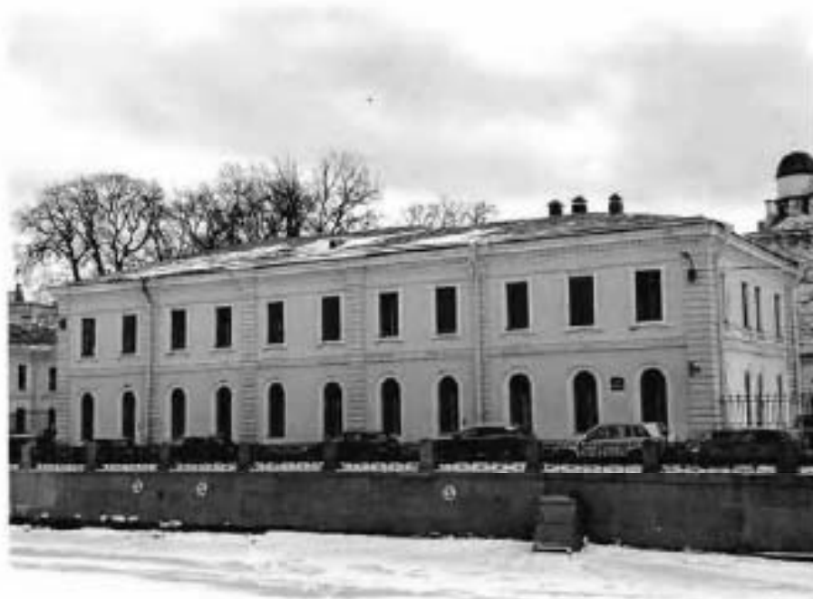
1. Общий вид на объект культурного наследия.
