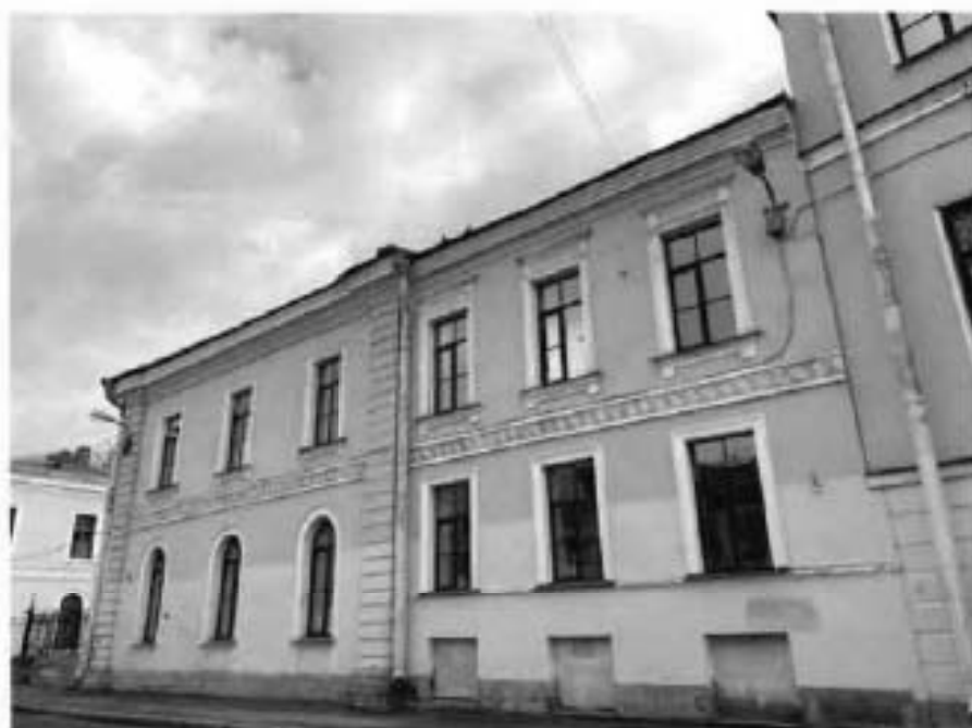
1. Общий вид на объект культурного наследия.
