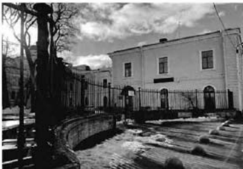
1. Общий вид на объект культурного наследия.
