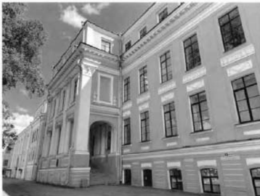
1. Общий вид на объект культурного наследия.
