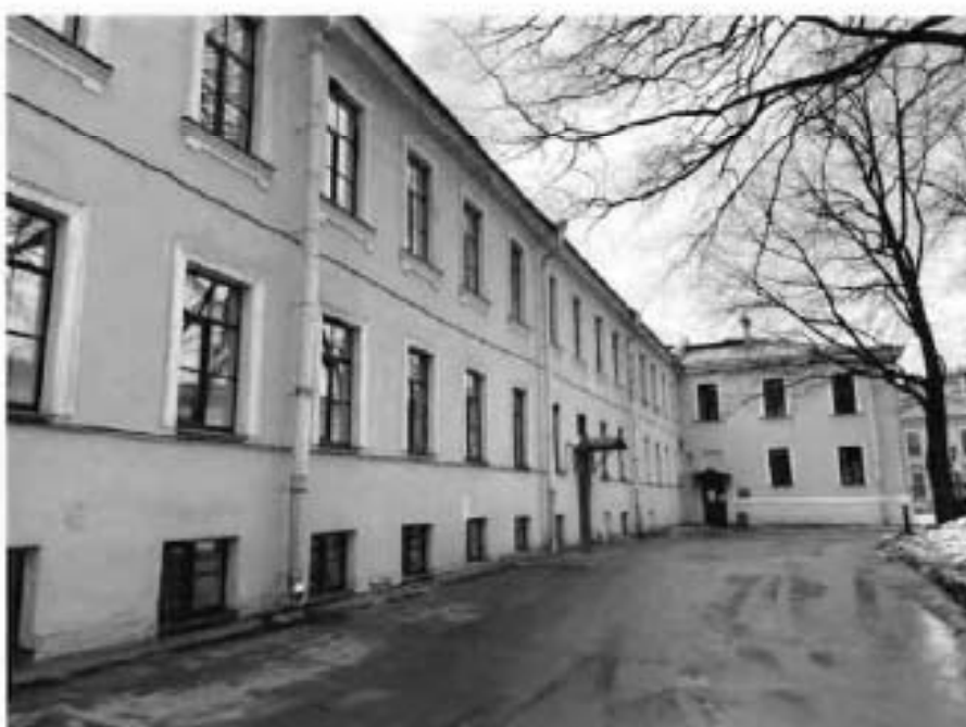
3. Общий вид на объект культурного наследия.
