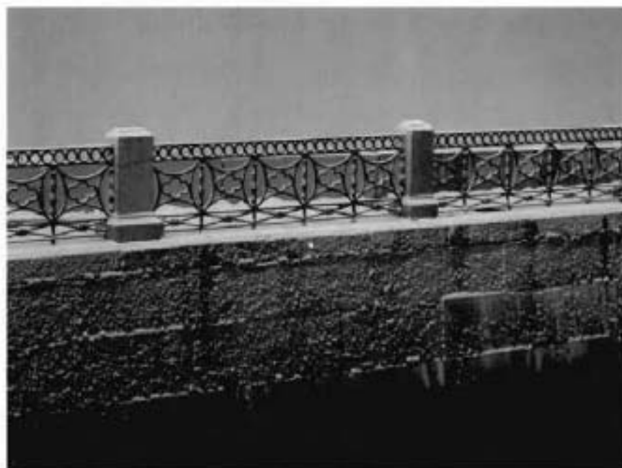
6. Ограждение набережной. Левобережная стенка
