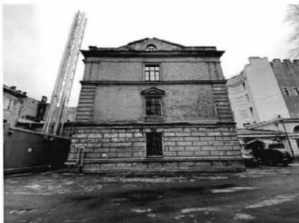
1. Фрагмент южного фасада объекта культурного наследия.
