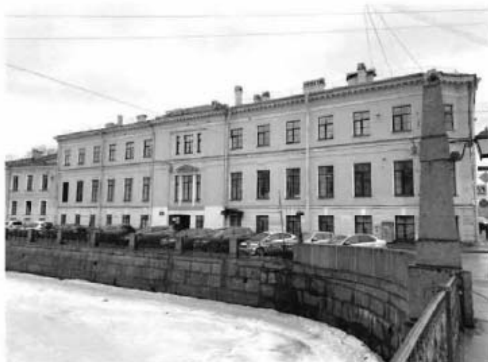
1. Северо-западный лицевой фасад объекта культурного наследия.
