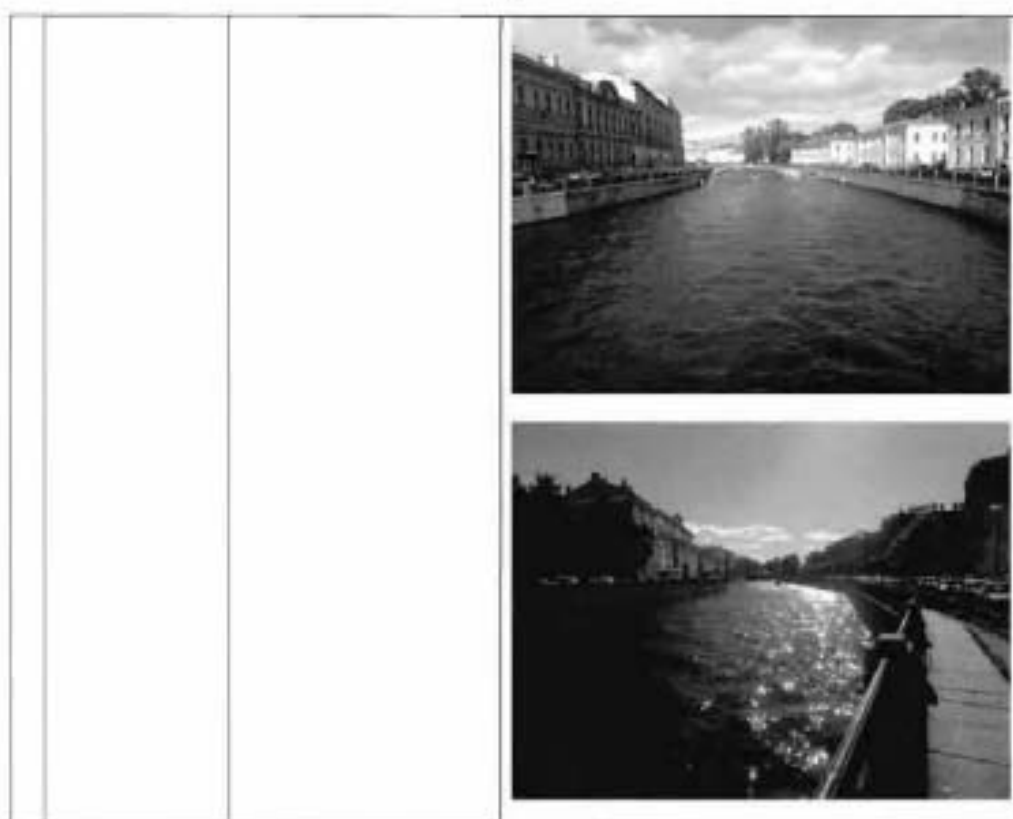
1. «Мост Инженерный Первый», 1824-1826 гг., ниж. база П.П., 1952-1954 гг., ниж. Левин Б.Б., 1953 г., арх. Ротач А.Л., расположенный по адресу: Санкт-Петербург, через р. Мойку по р. Фонтанке наб.
