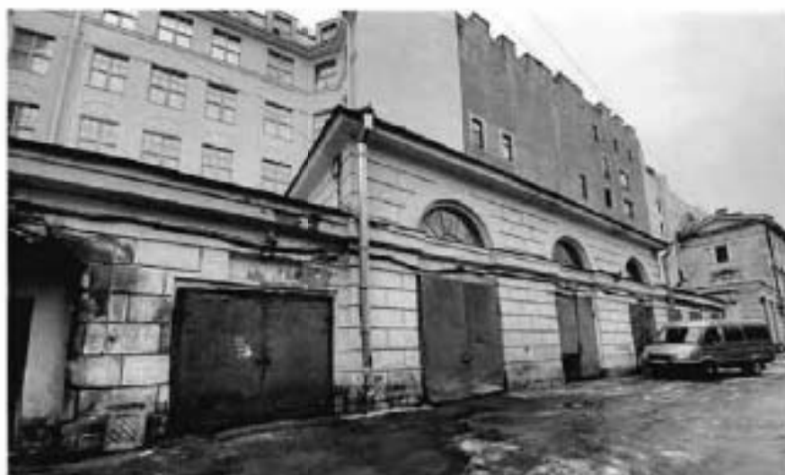
2. Фрагмент южного фасада объекта культурного наследия.
