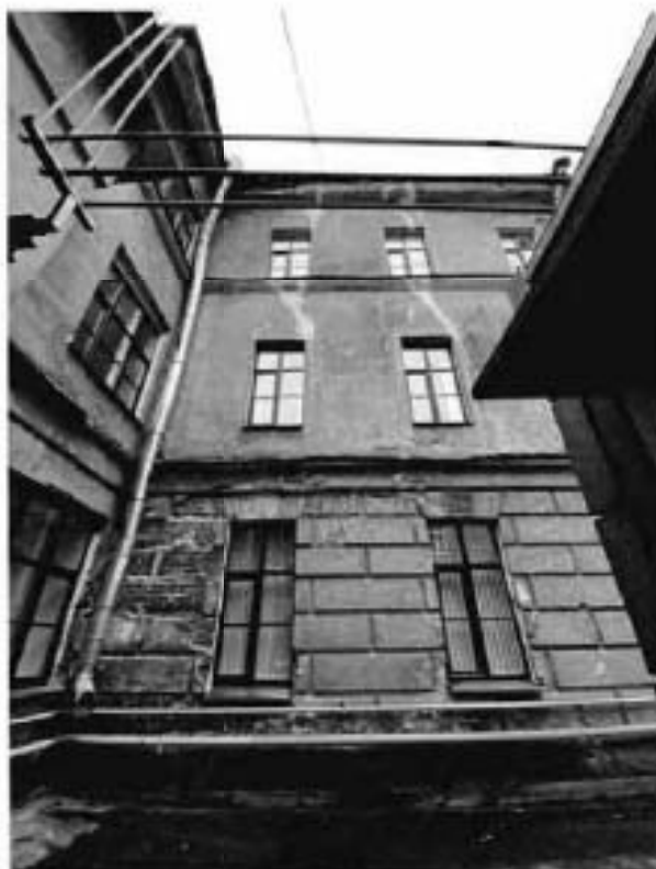
3. Фрагмент западного фасада объекта культурного наследия.
