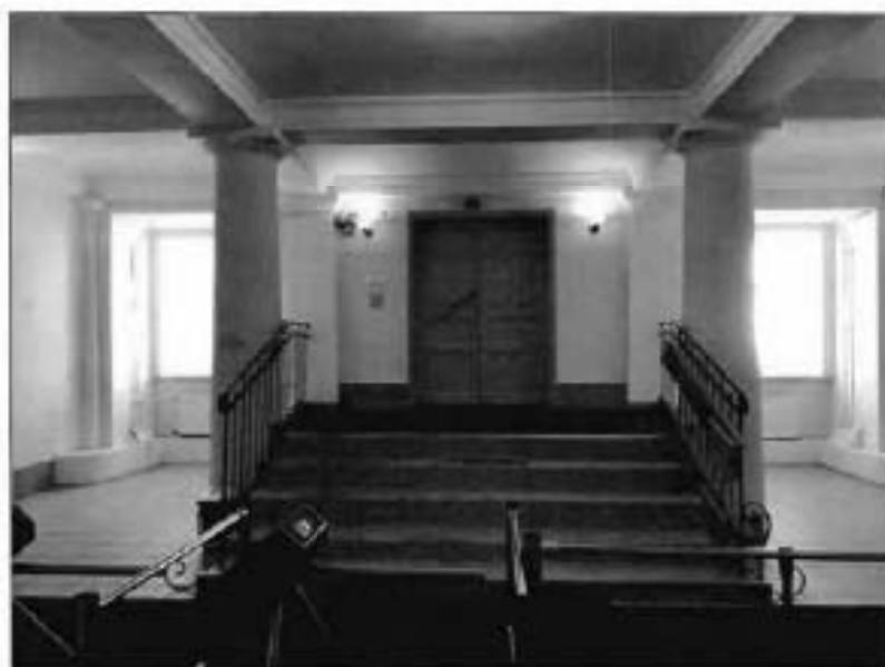
7. Вестибюль. Общий вид. (фотофиксация выполнена 18.02.2021)
