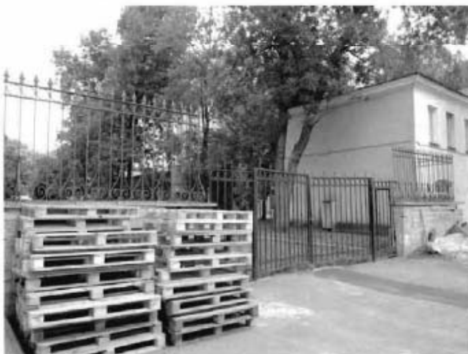
3. Часть ограды южной части сада (между трансформаторной подстанцией и зданием по адресу: набережная реки Мойки, дом 48-50-52, литера Ж)
