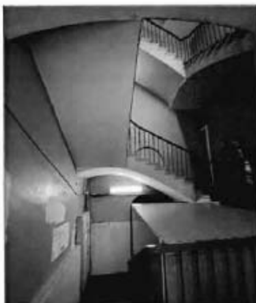
5. Лестница (II-Г) объекта культурного наследия.
