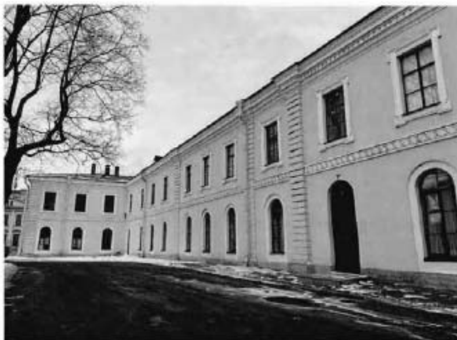
2. Общий вид на объект культурного наследия.
