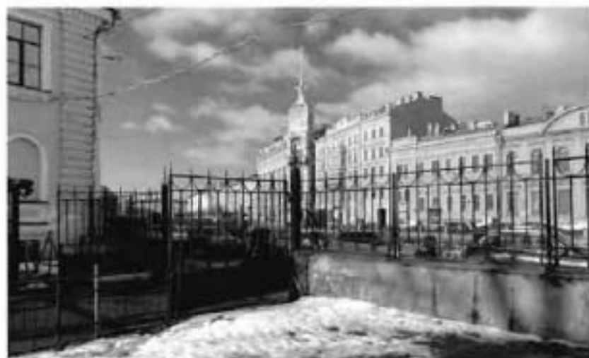
2. Общий вид на объект культурного наследия.
