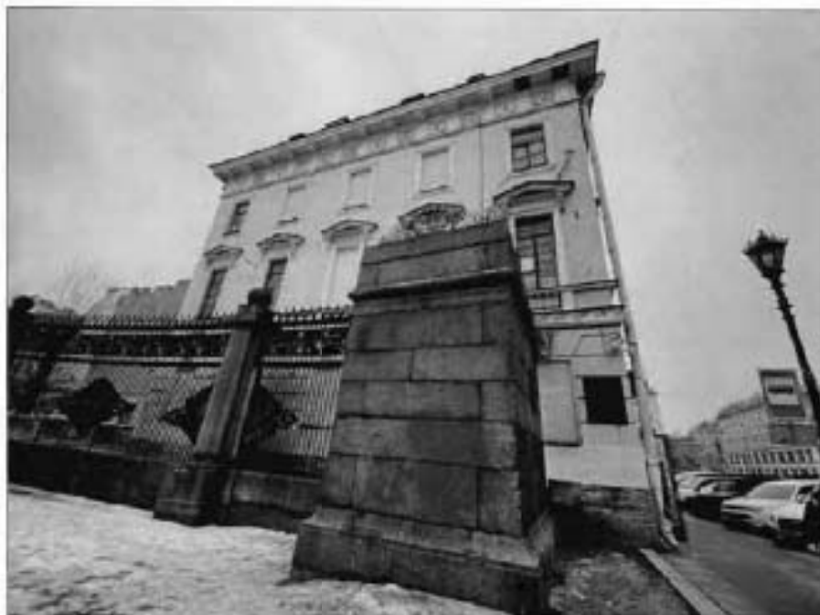
2. Южный лицевой фасад объекта культурного наследия.
