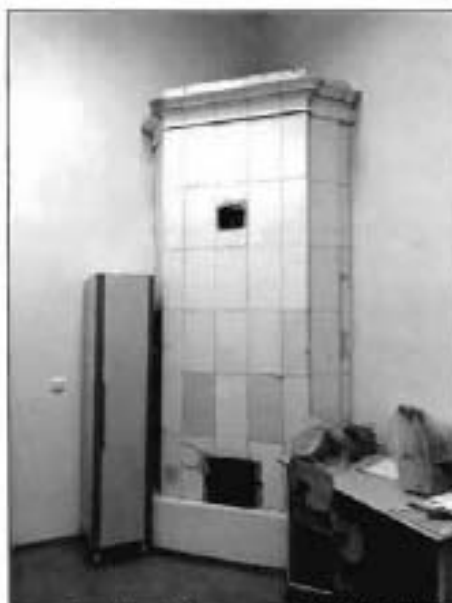
9. Печь. Помещение № 19-Н (94). (фотофиксация выполнена 18.02.2021)
