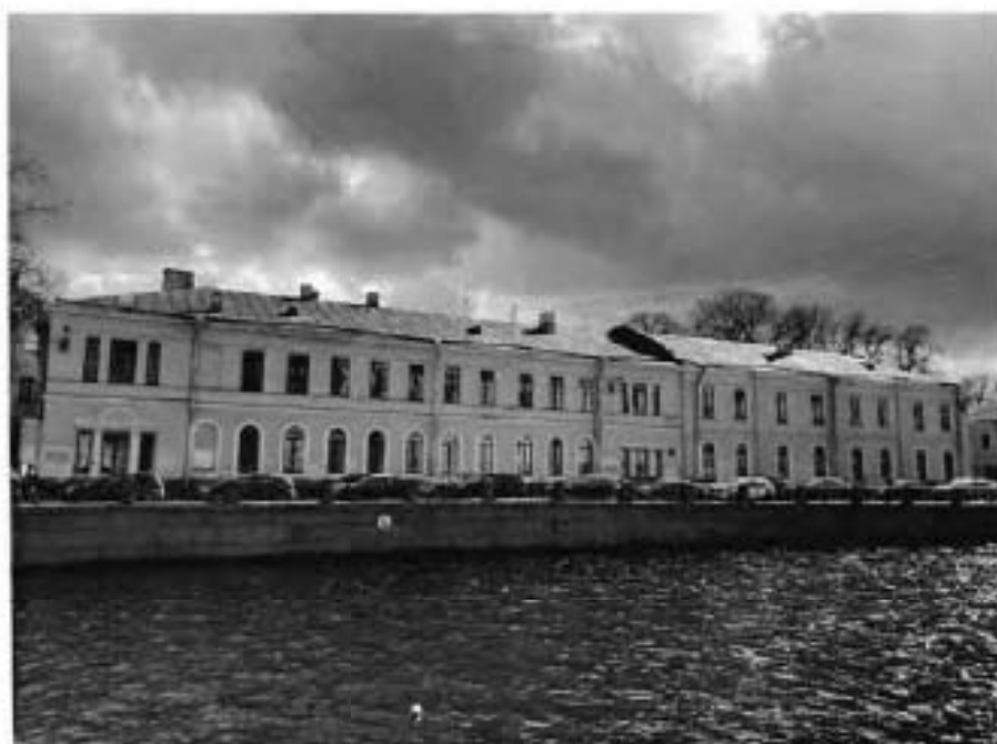
1. Общий вид на объект культурного наследия.
