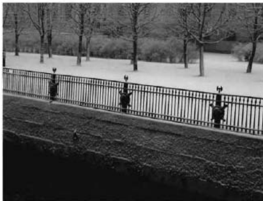
3. Ограждение набережной со стороны Михайловского (Инженерного) замка
