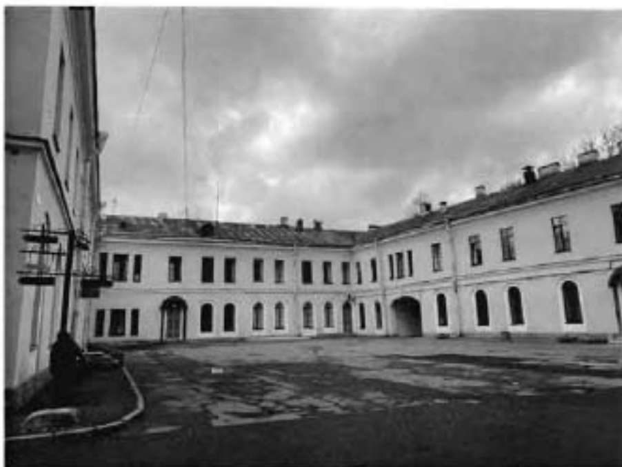
2. Общий вид на объект культурного наследия.
