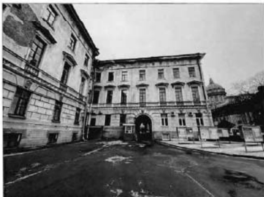
3. Восточный дворовой фасад и фрагмент северного дворового фасада объекта культурного наследия.
