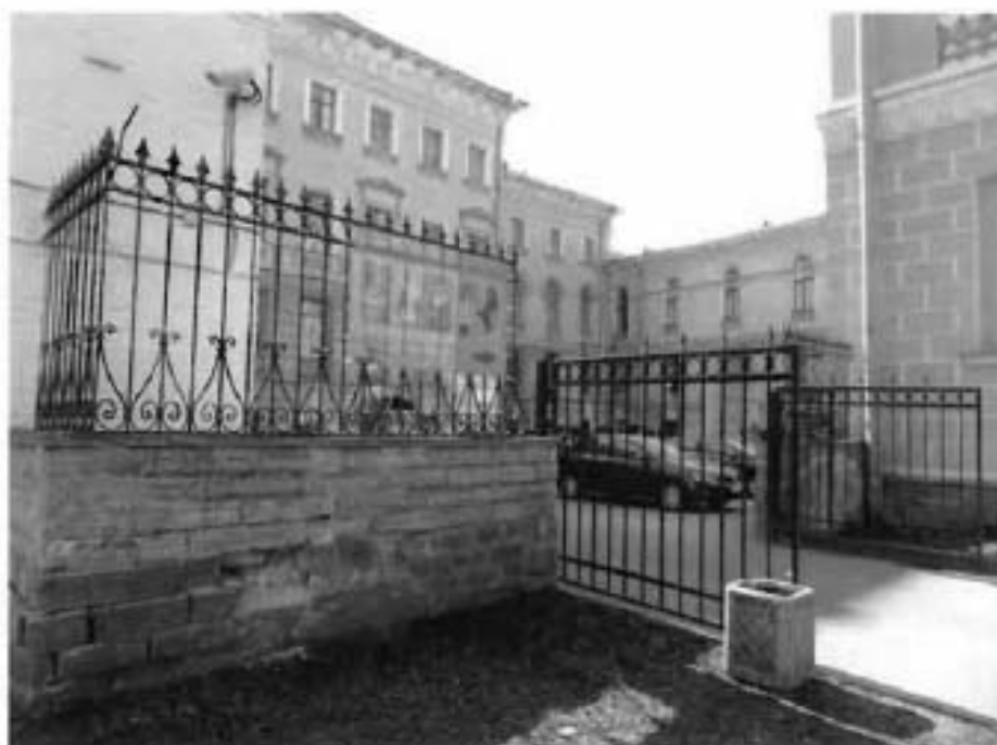
2. Часть ограды южной части сада (между 4 корпусом и трансформаторной подстанцией)
