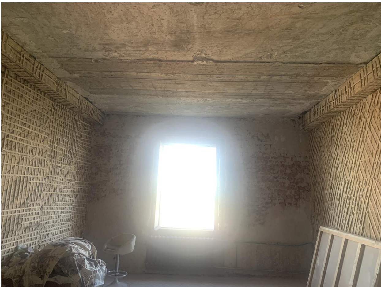
8. Общий вид на жилую комнату (квартира №163)
