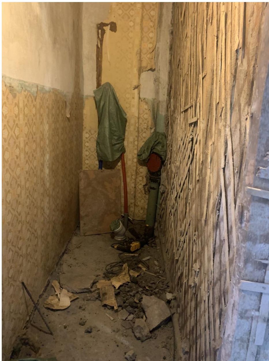
10. Общий вид на туалет (квартира №163)
