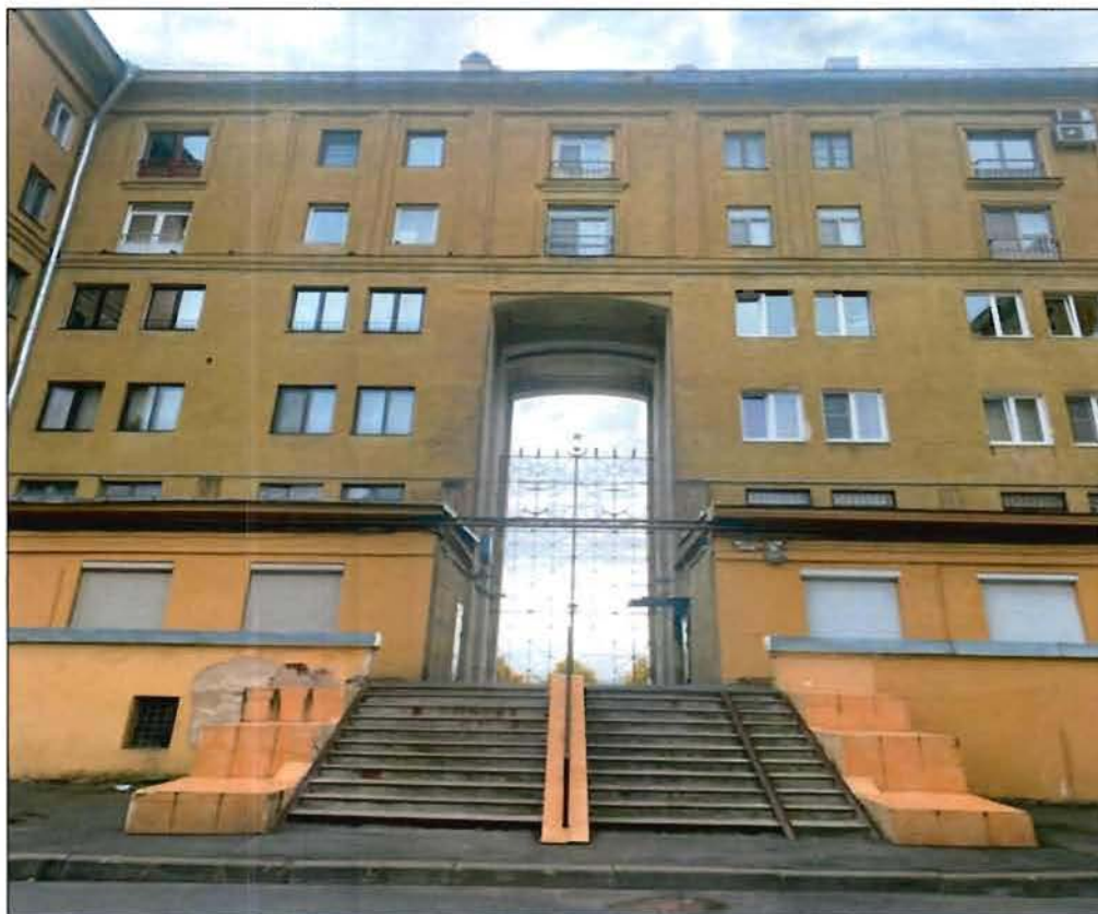
10. Крыльцо и арочный проем в центральной части северного дворового фасада объекта культурного наследия.
