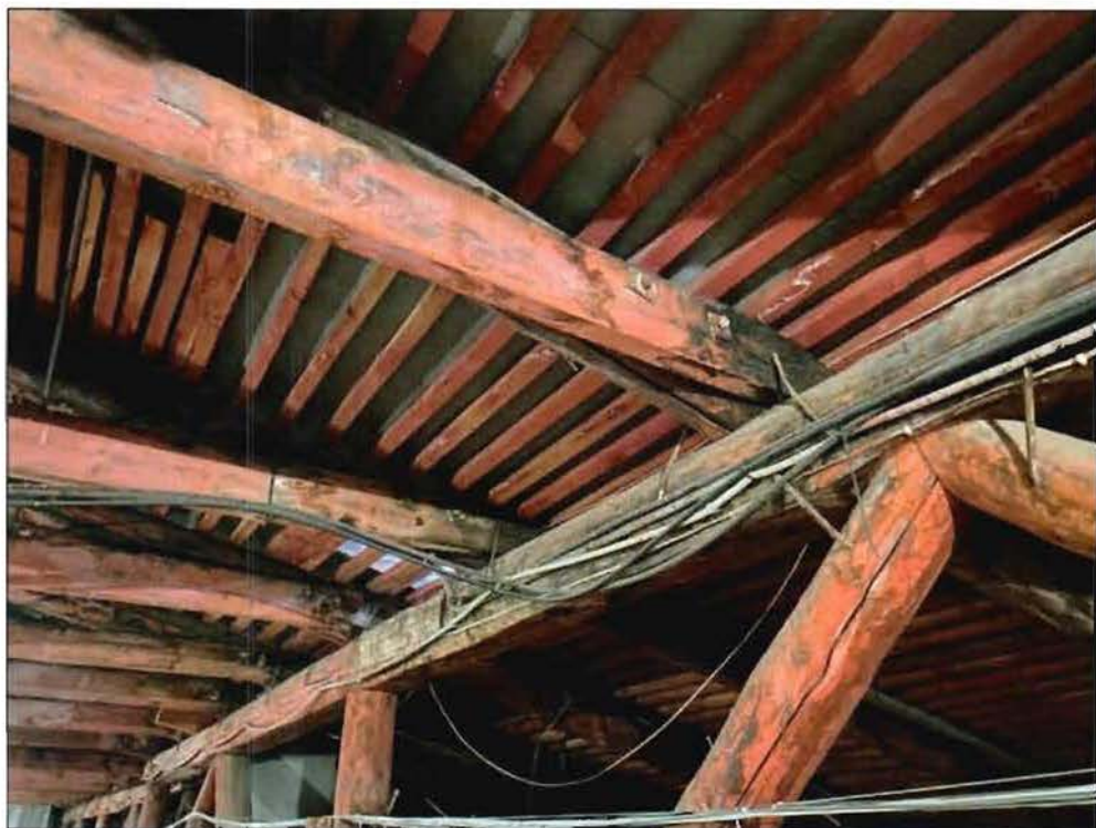
11. Фрагмент стропильной системы объекта культурного наследия.
