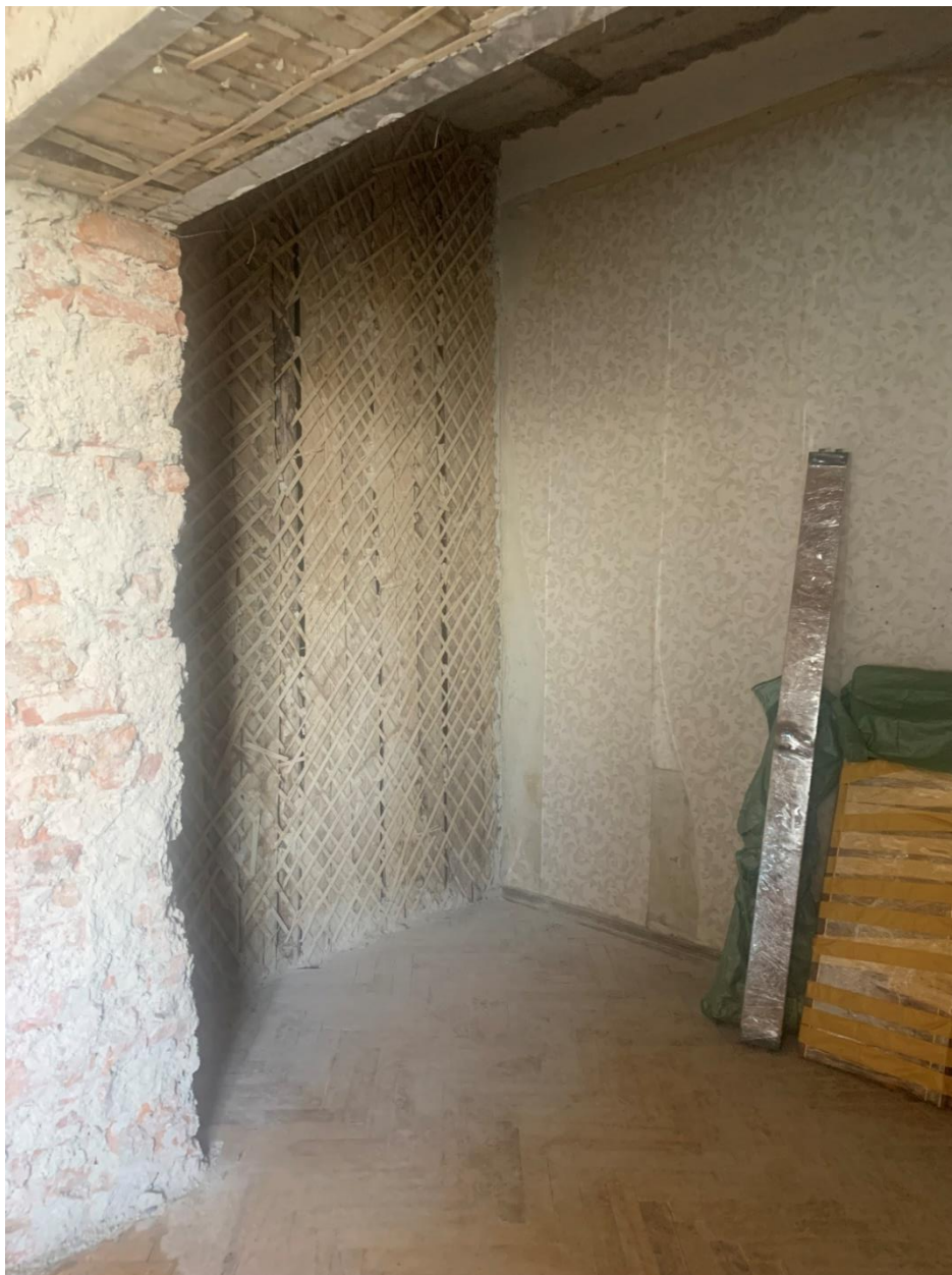
7. Общий вид на жилую комнату (квартира №163)
