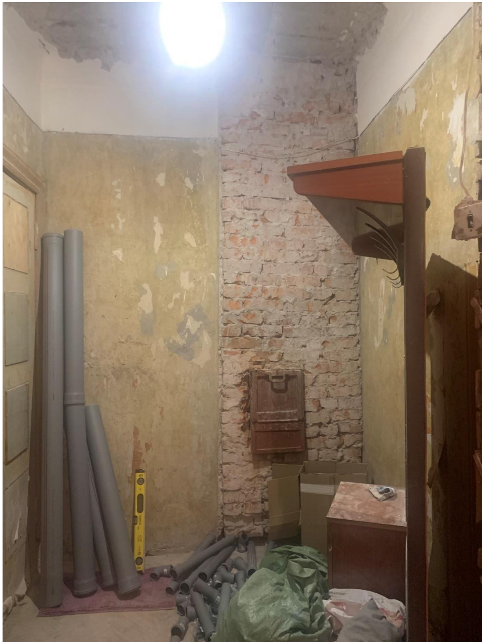
4.Общий вид на коридор жилого помещения (квартира №163)
