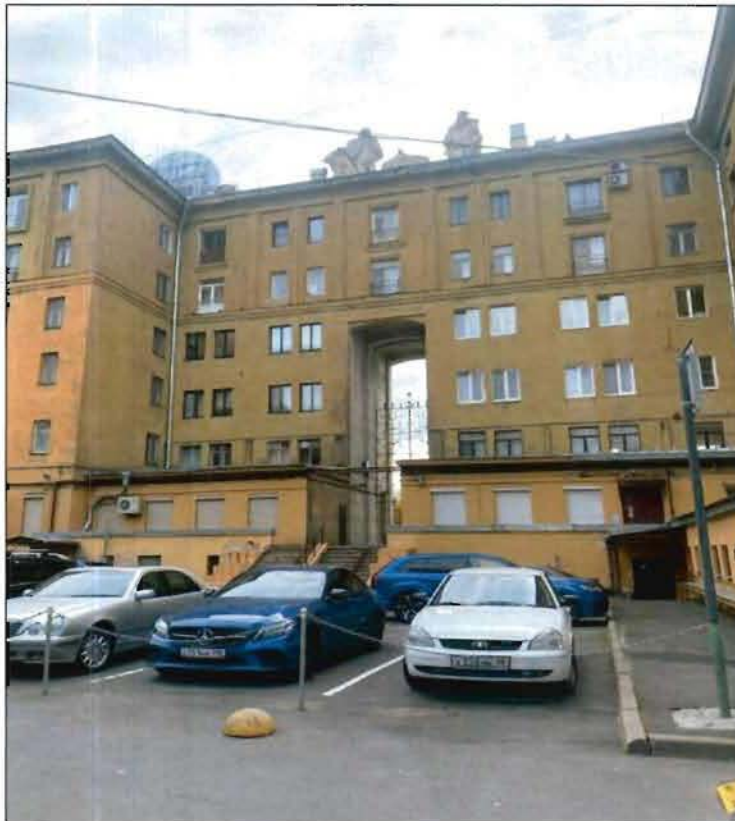
5. Фрагмент центральной части северного дворового фасада объекта культурного наследия.
