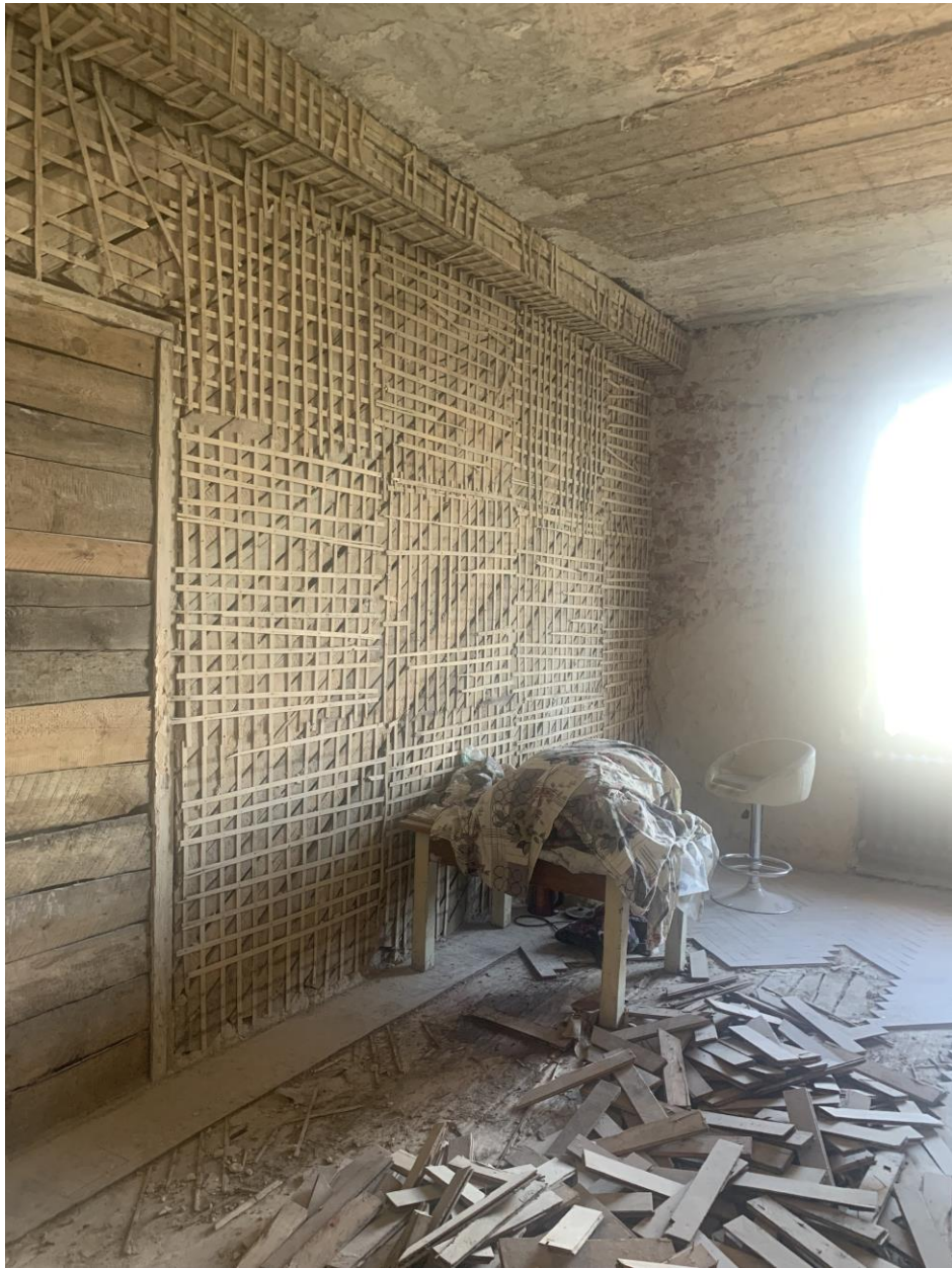
9. Общий вид на жилую комнату (квартира №163)
