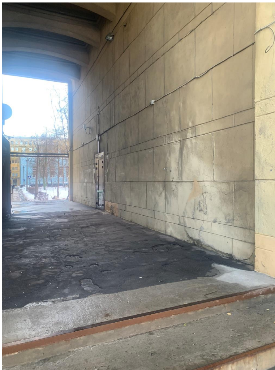
3. Фрагмент восточного флигеля бокового корпуса объекта культурного наследия «Жилой дом», вид на лестницу №10 ЛК
