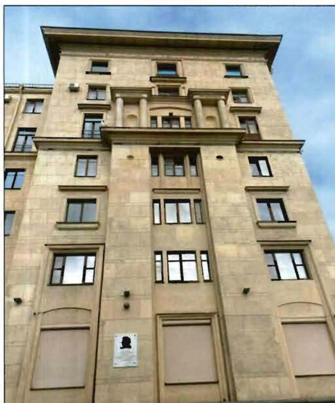
4. Восточная часть лицевого фасада (по Петровской набережной) объекта культурного наследия.
