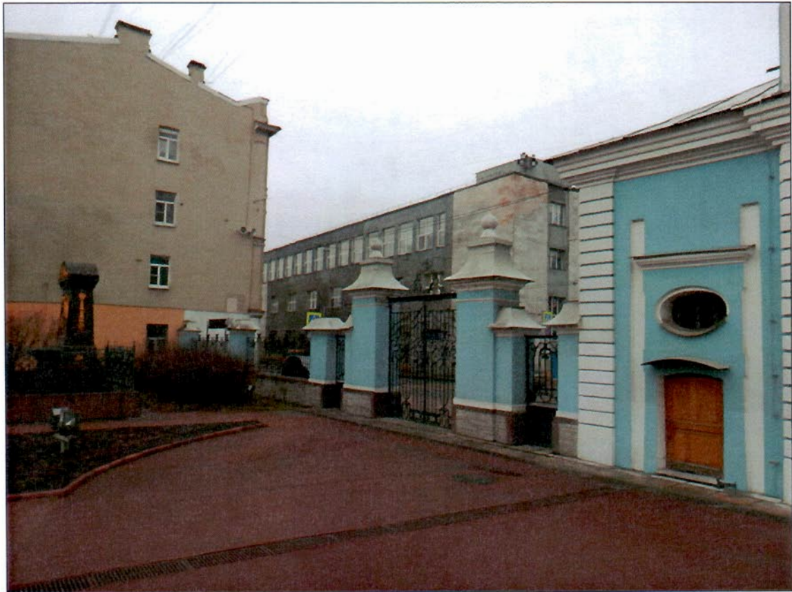
14. Вид на южную часть ограды из сада.
