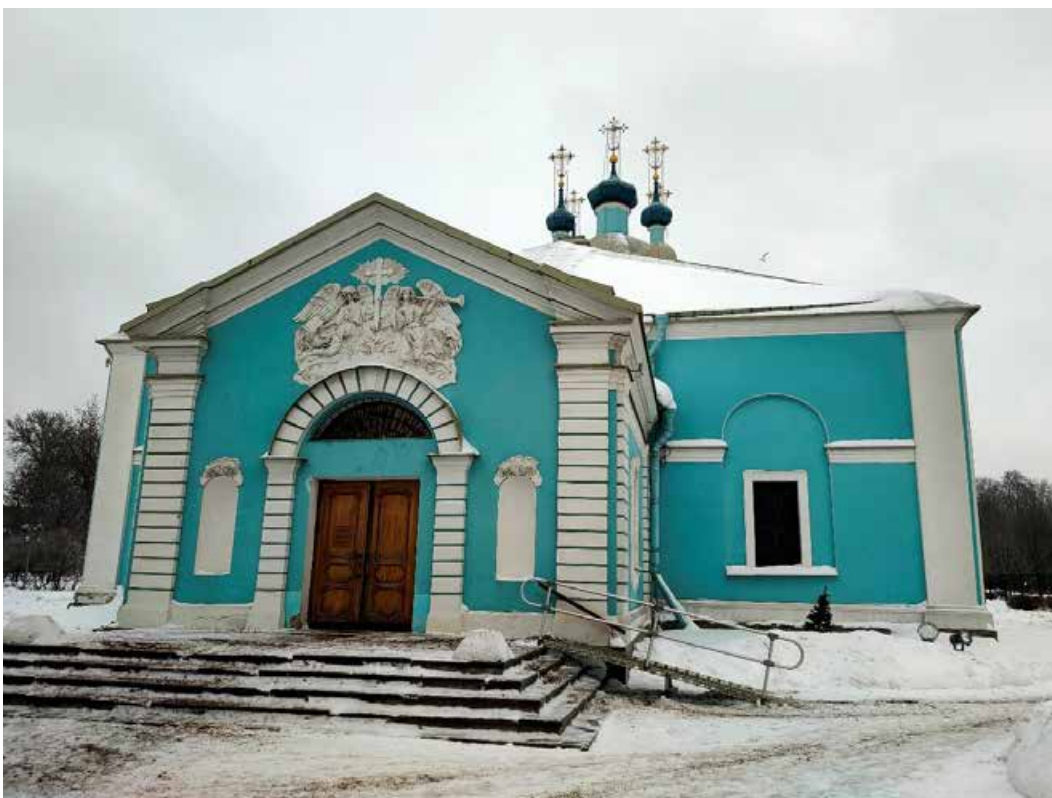
1. «Собор Сампсониевский», расположенный по адресу: г. Санкт-Петербург, Большой Сампсониевский пр., д. 41, лит. А. Западный фасад. Общий вид. Фото 17.11.2022г.
