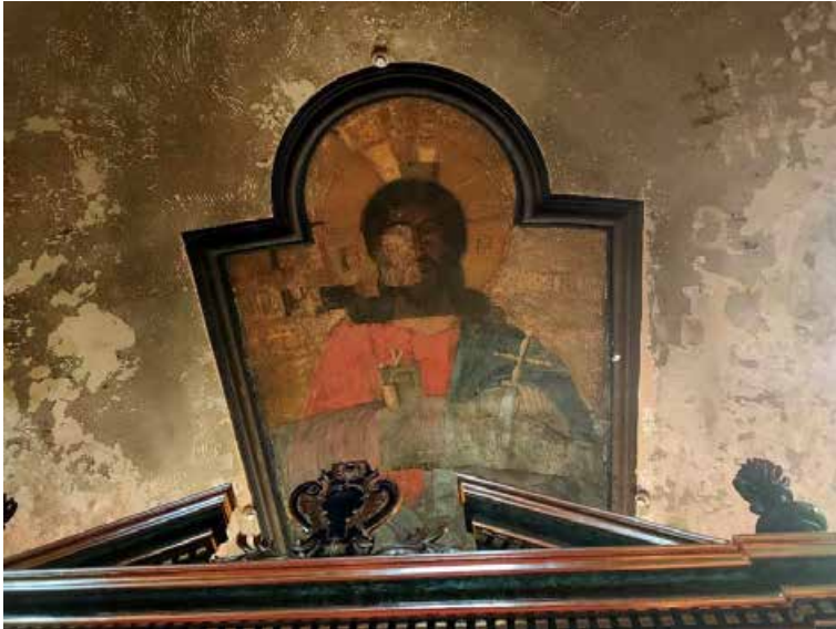
63. «Собор Сампсониевский», расположенный по адресу: г. Санкт-Петербург, Большой Сампсониевский пр., д. 41, лит. А. Свод алтаря собора. Общий вид. Фото 17.11.2022г.
