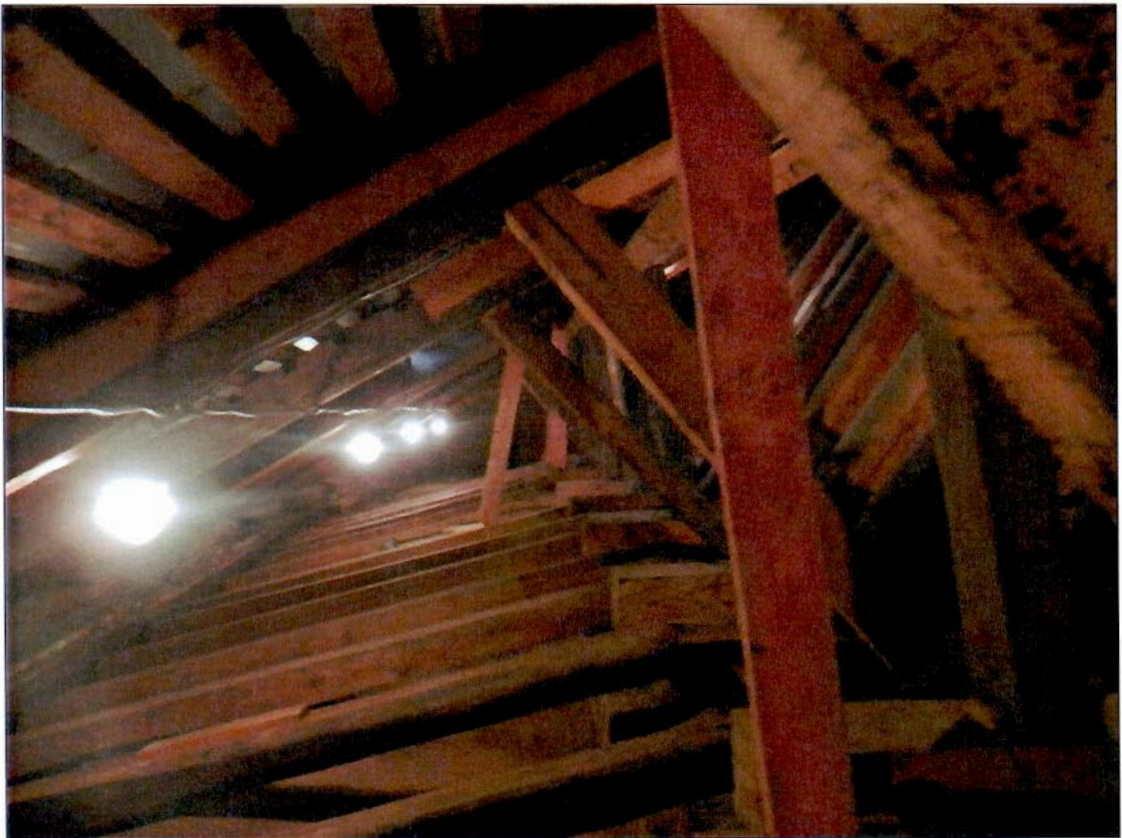
29. «Собор». Стропильная система. Фрагмент.
