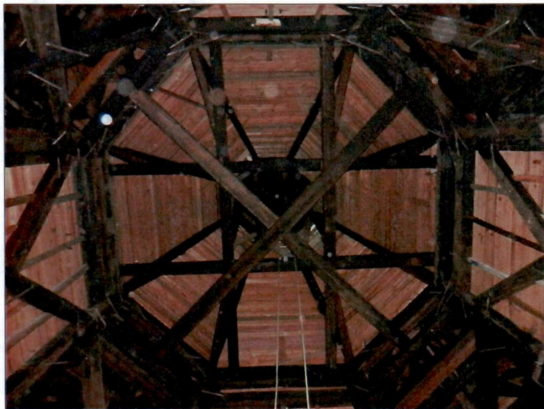
31. «Собор». Стропильная система. Фрагмент.
