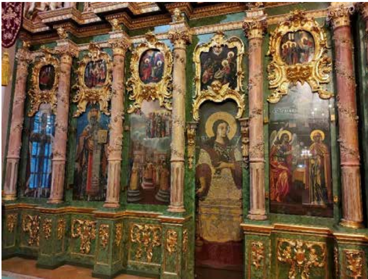
9. «Собор Сампсониевский», расположенный по адресу: г. Санкт-Петербург, Большой Сампсониевский пр., д. 41, лит. А. Главный иконостас Святого Преподобного Сампсония Странноприимца. Фрагмент. Фото 17.11.2022г.
