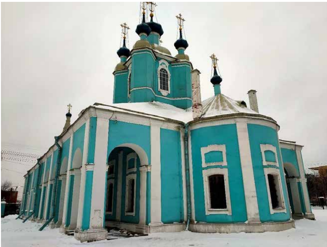
3. «Собор Сампсониевский», расположенный по адресу: г. Санкт-Петербург, Большой Сампсониевский пр., д. 41, лит. А. Восточный фасад. Общий вид. Фото 17.11.2022г.
