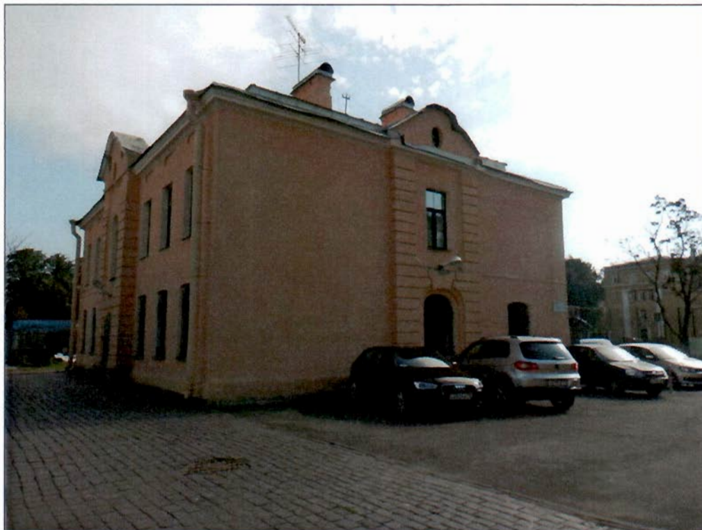
45. «Юбилейный домик». Вид с северо-запада.
