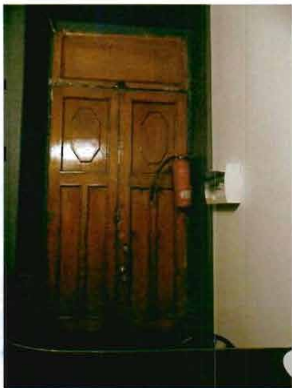
11. Дверные заполнения помещений.
