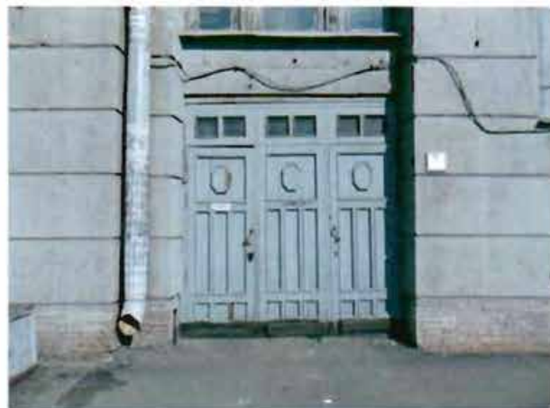
2. Фрагмент южного фасада.
