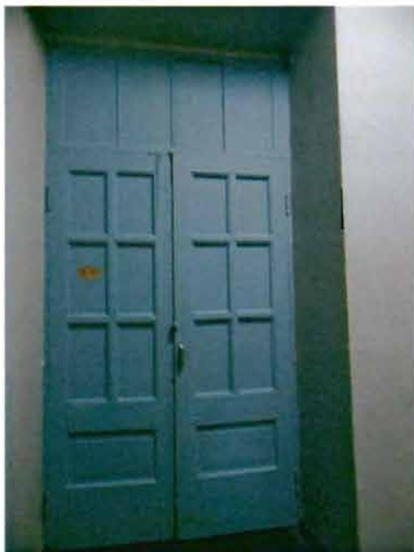
12. Дверные заполнения помещений.
