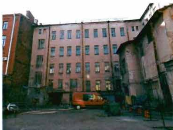
6. Северный дворовой фасад.
