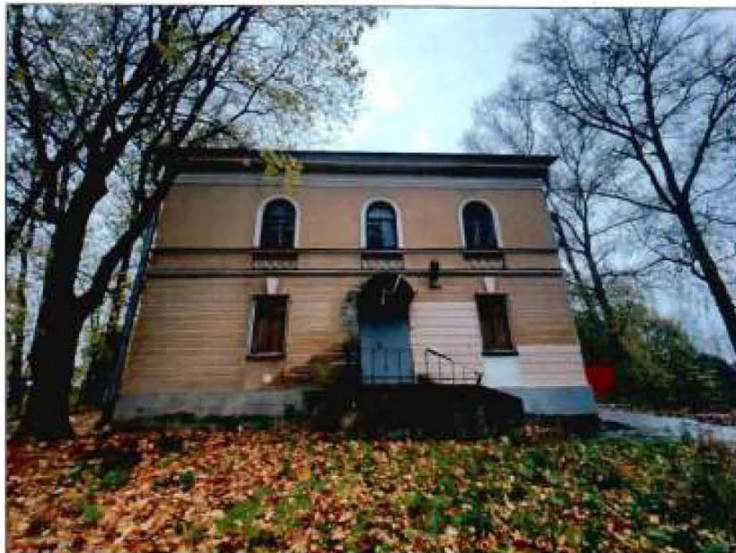
5. Восточный фасад объекта культурного наследия.
