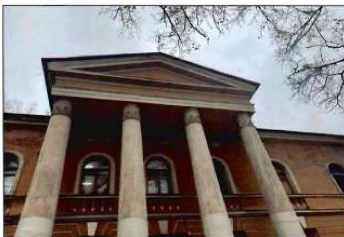
2. Фрагмент портика лицевого фасада объекта культурного наследия.
