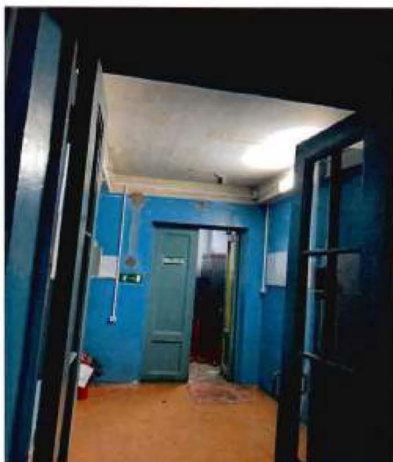
8. Помещения объекта культурного наследия.
