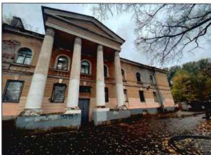
1. Общий вид на лицевой фасад объекта культурного наследия.
