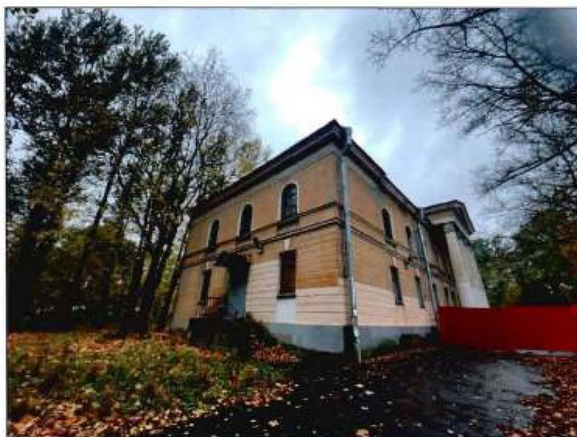
6. Вид на объект культурного наследия с северо-восточной стороны.
