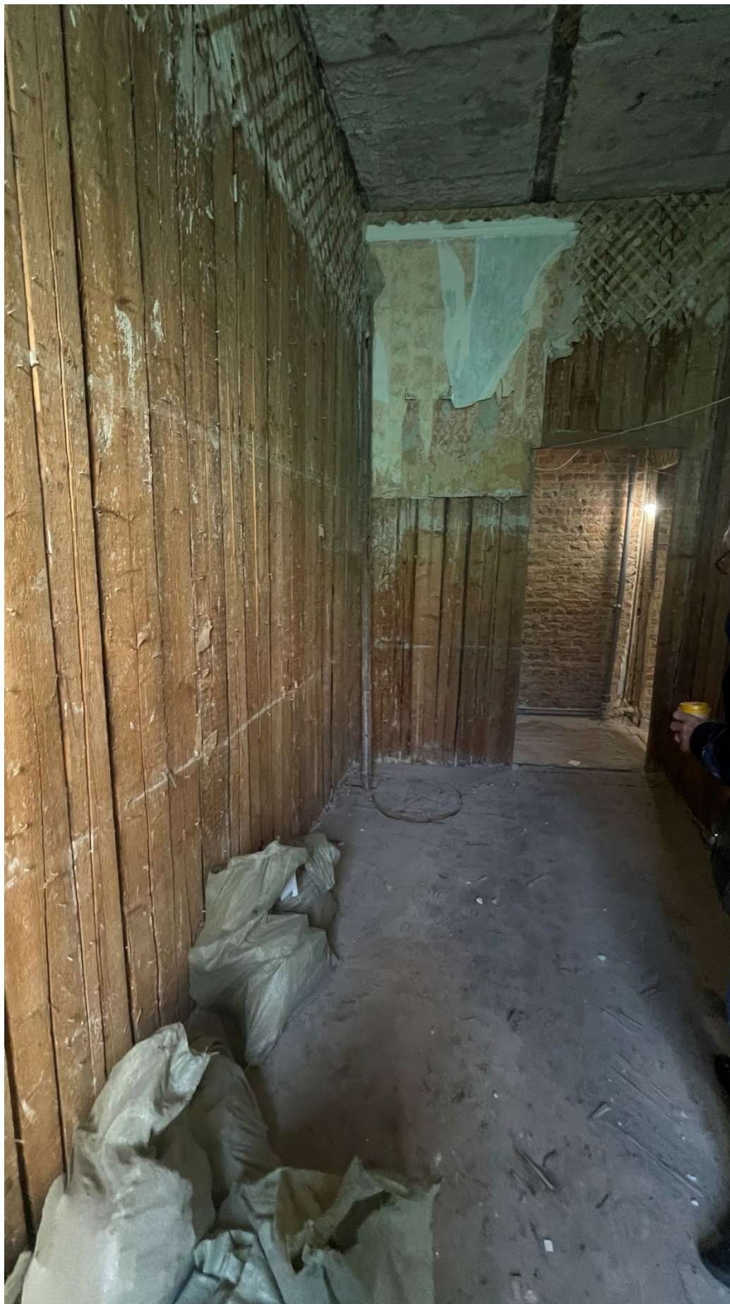
16. Фрагмент интерьера комнаты (помещение 8/10.8);
