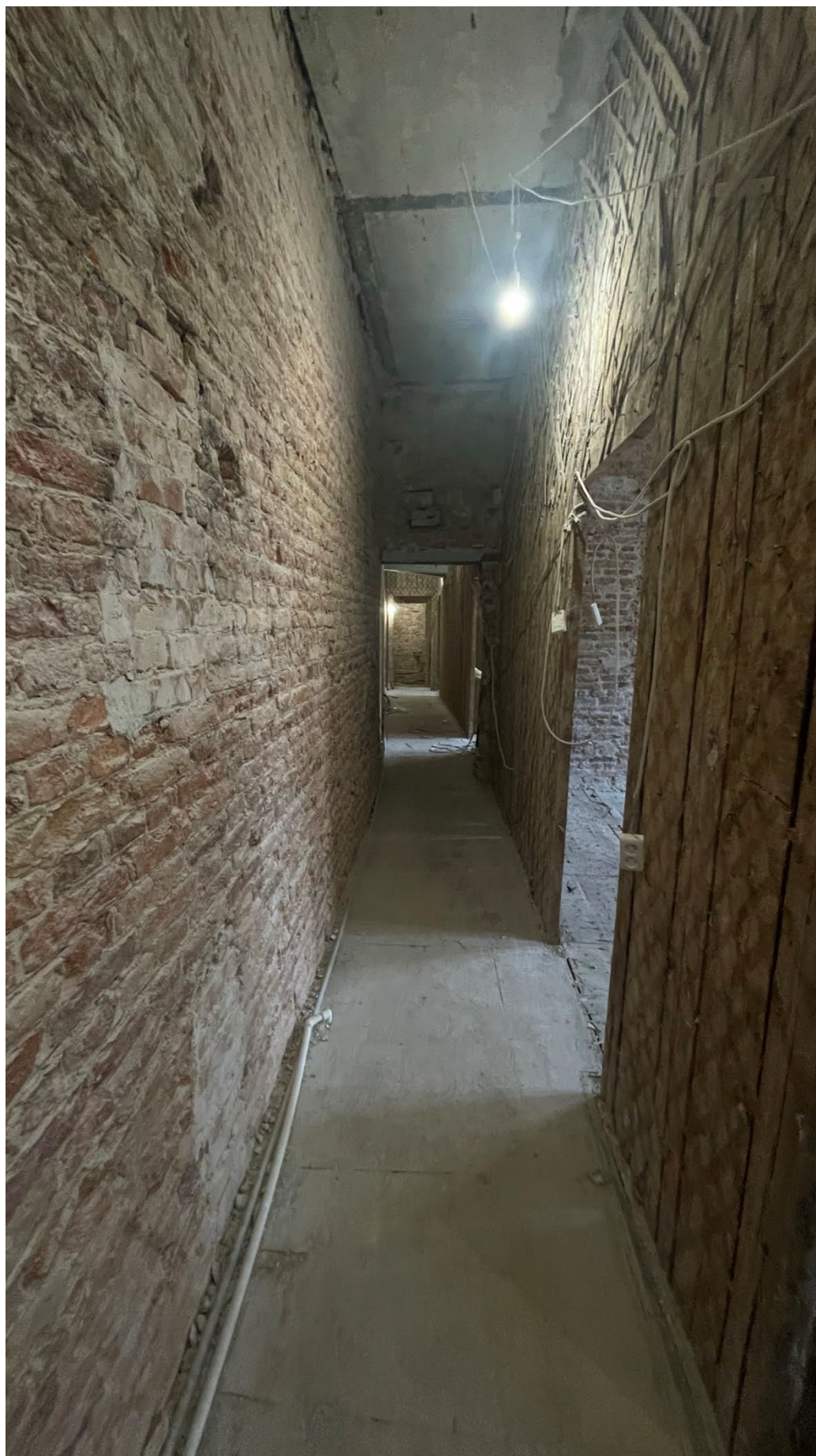
9. Фрагмент интерьера коридора (помещение 4/7.60);
