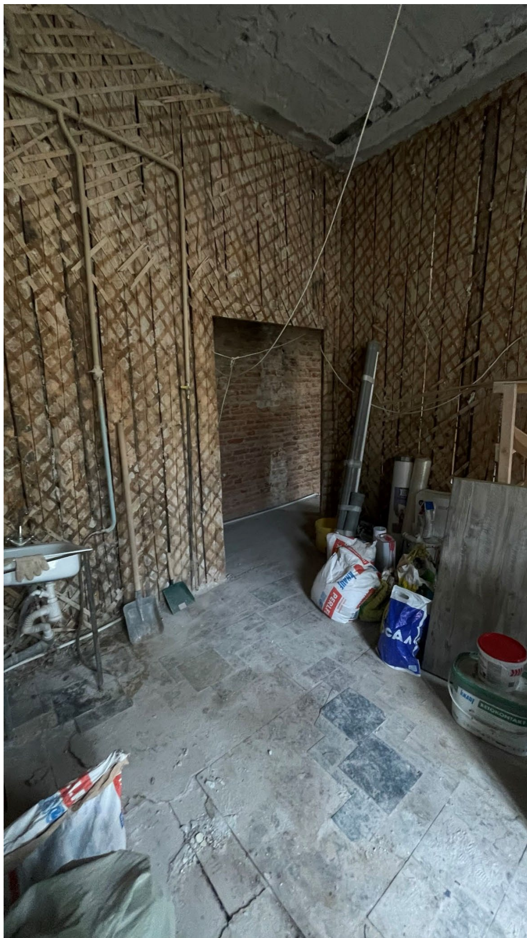
б. Фрагмент интеръера кухни (помещение 1/16.2);
