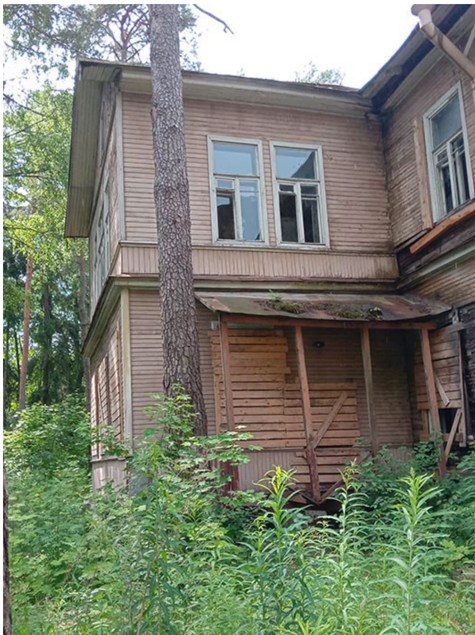
Фото 23. Выявленный объект культурного наследия «Дом купца Елисеева (ресторан) (деревянный)» по адресу: Санкт-Петербург, г. Зеленогорск Приморское шоссе, д. 520 литера Ц.
