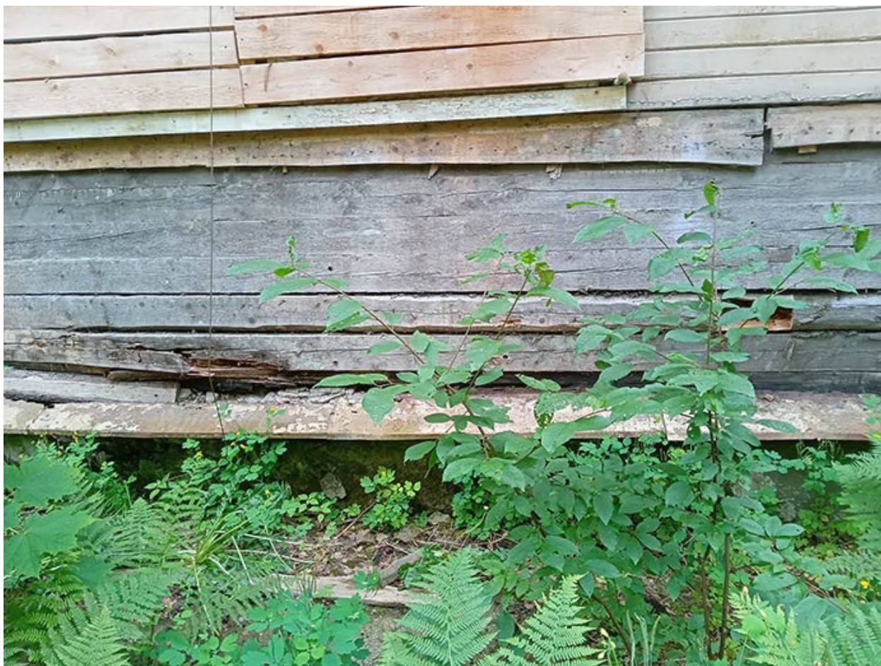
Фото 8. Выявленный объект культурного наследия «Дом купца Елисеева (ресторан) (деревянный)» по адресу: Санкт-Петербург, г. Зеленогорск Приморское шоссе, д. 520 литера Ц.
