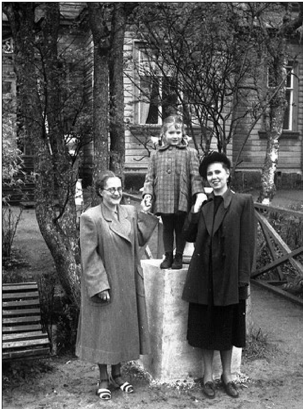
16. Дача Кирхнера, 1960-е гг. На втором плане — фрагмент западного фасада. Сайт terijoki.spb.ru .
