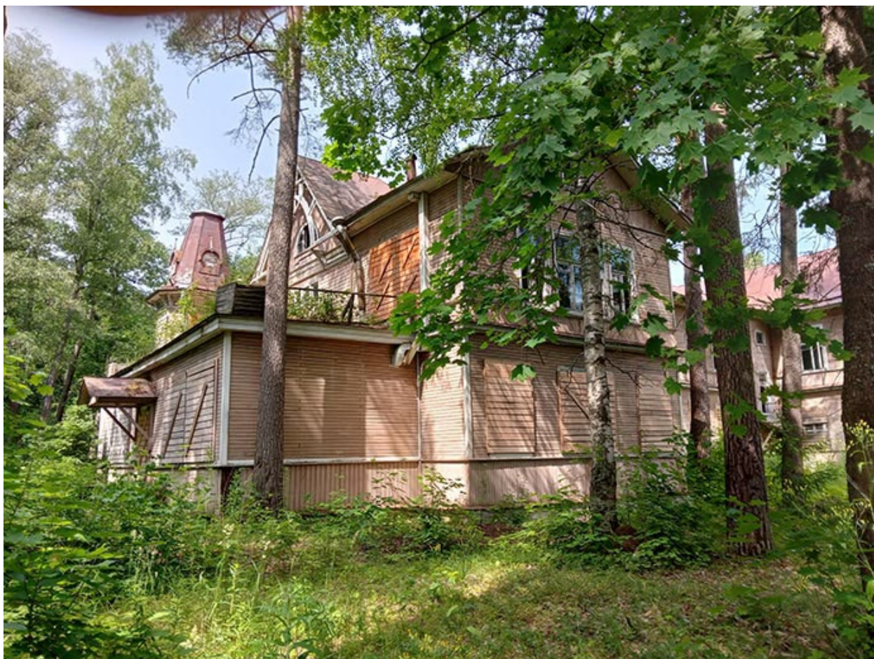
Фото 26. Выявленный объект культурного наследия «Дом купца Елисеева (ресторан) (деревянный)» по адресу: Санкт-Петербург, г. Зеленогорск Приморское шоссе, д. 520 литера Ц.
