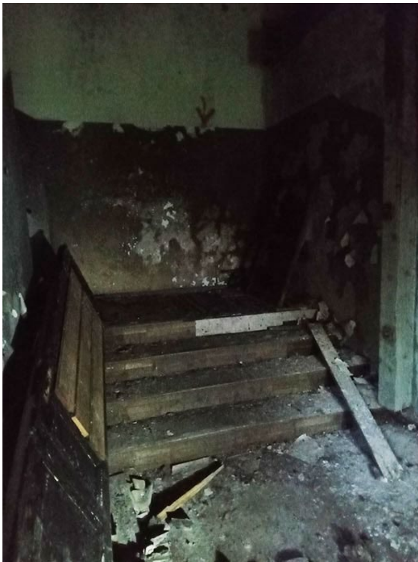
Фото 44. Выявленный объект культурного наследия «Дом купца Елисеева (ресторан) (деревянный)» по адресу: Санкт-Петербург, г. Зеленогорск Приморское шоссе, д. 520 литера Ц.
