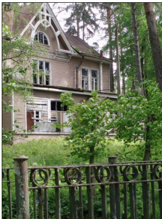
22. Дача Кирхнера. Вид с мостика через ручей на западный фасад. Фото: Е. Травина, 04.06.2012 г Сайт terijoki.spb.ru .
