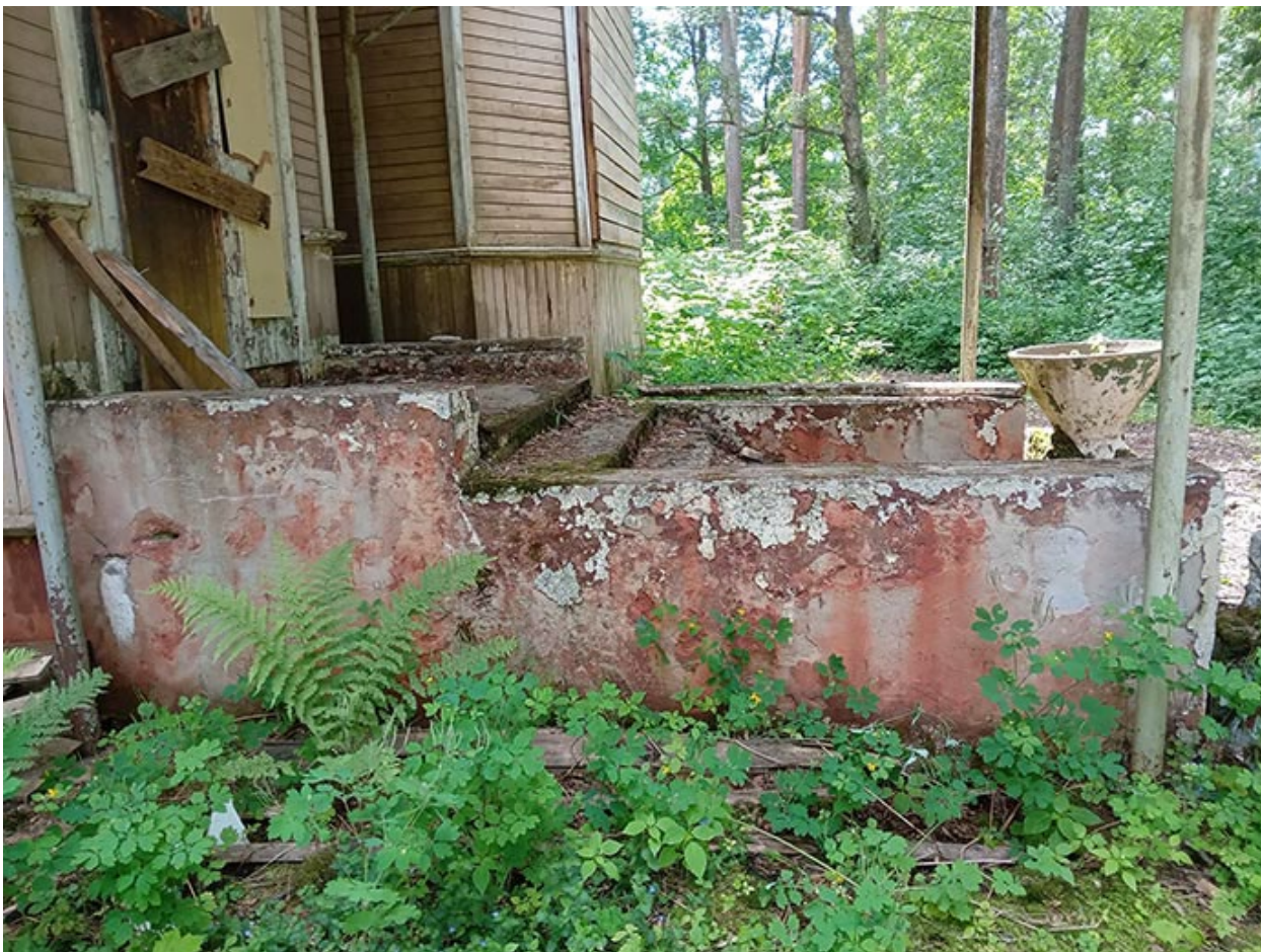
Фото 5. Выявленный объект культурного наследия «Дом купца Елисеева (ресторан) (деревянный)» по адресу: Санкт-Петербург, г. Зеленогорск Приморское шоссе, д. 520 литера Ц.
