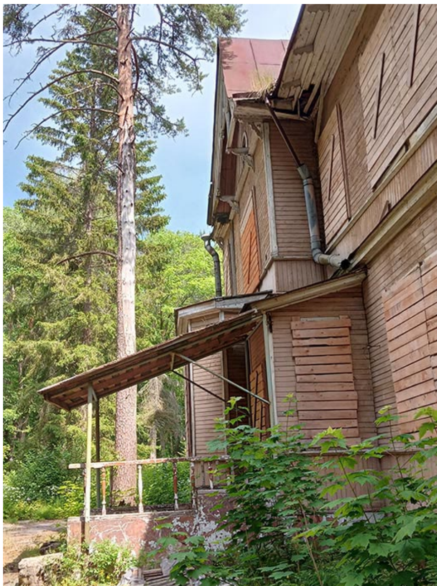
Фото 7. Выявленный объект культурного наследия «Дом купца Елисеева (ресторан) (деревянный)» по адресу: Санкт-Петербург, г. Зеленогорск Приморское шоссе, д. 520 литера Ц.
