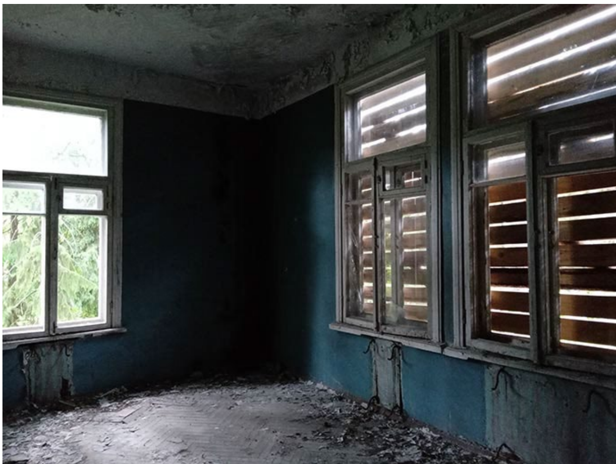
Фото 50. Выявленный объект культурного наследия «Дом купца Елисеева (ресторан) (деревянный)» по адресу: Санкт-Петербург, г. Зеленогорск Приморское шоссе, д. 520 литера Ц.
