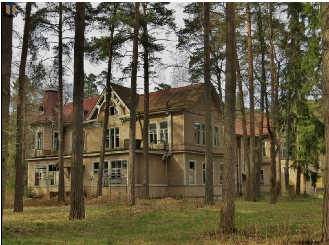
30. Дача Кирхнера. Вид с юго-восточной стороны. Веранда южного фасада расширена предположительно в середине XX в. Фотография 17.05.2017 г. Сайт terijoki.spb.ru .
