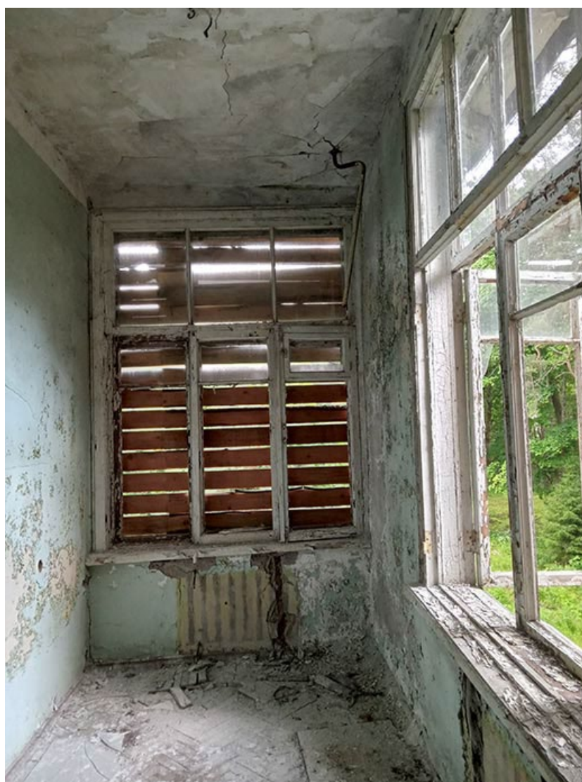
Фото 53. Выявленный объект культурного наследия «Дом купца Елисеева (ресторан) (деревянный)» по адресу: Санкт-Петербург, г. Зеленогорск Приморское шоссе, д. 520 литера Ц.
