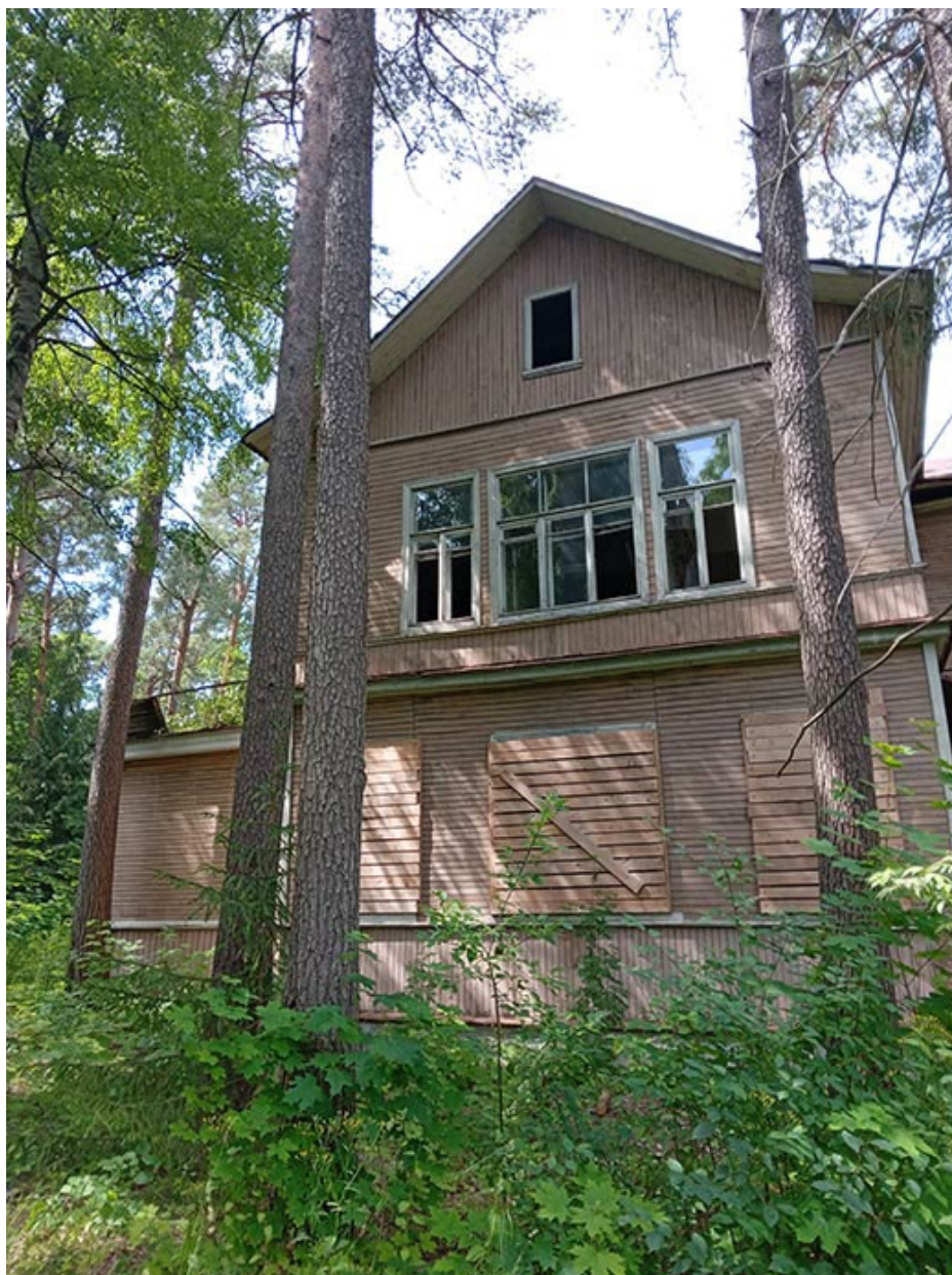
Фото 25. Выявленный объект культурного наследия «Дом купца Елисеева (ресторан) (деревянный)» по адресу: Санкт-Петербург, г. Зеленогорск Приморское шоссе, д. 520 литера Ц.
