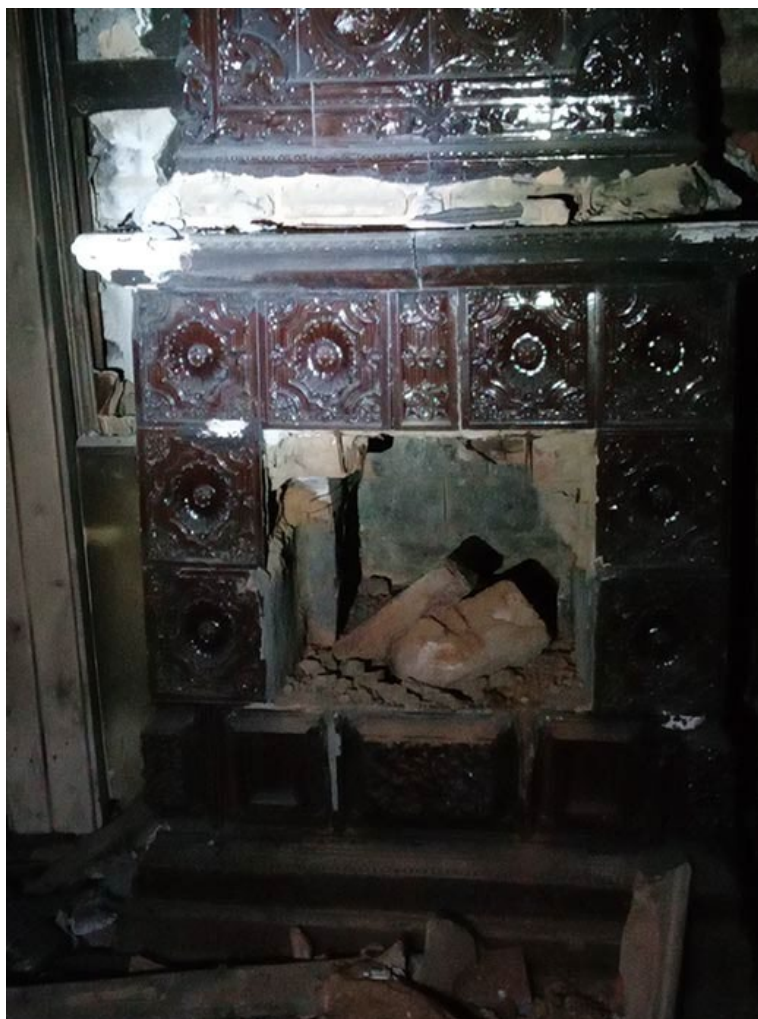
Фото 43. Выявленный объект культурного наследия «Дом купца Елисеева (ресторан) (деревянный)» по адресу: Санкт-Петербург, г. Зеленогорск Приморское шоссе, д. 520 литера Ц.
