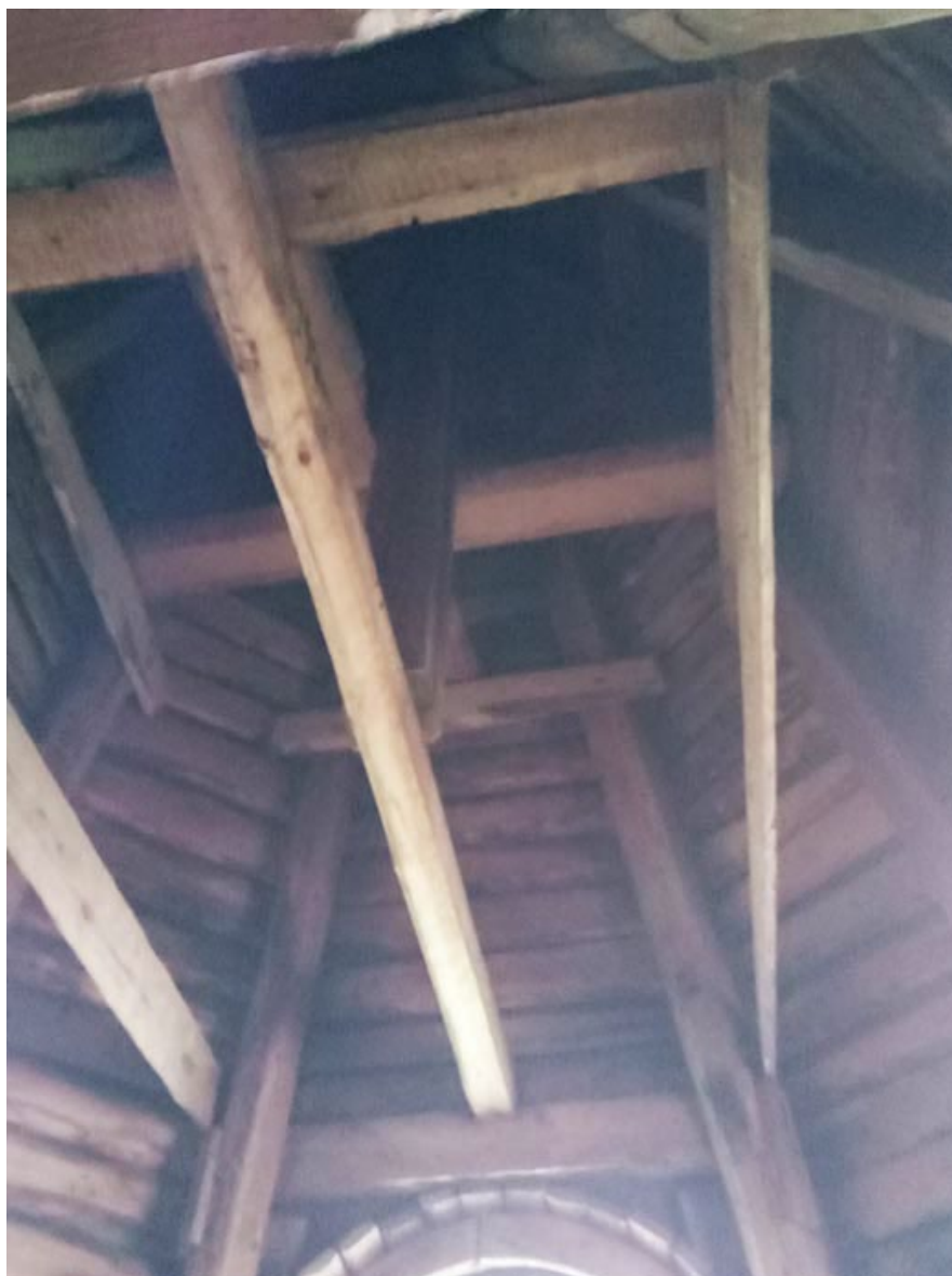
Фото 59. Выявленный объект культурного наследия «Дом купца Елисеева (ресторан) (деревянный)» по адресу: Санкт-Петербург, г. Зеленогорск Приморское шоссе, д. 520 литера Ц.
