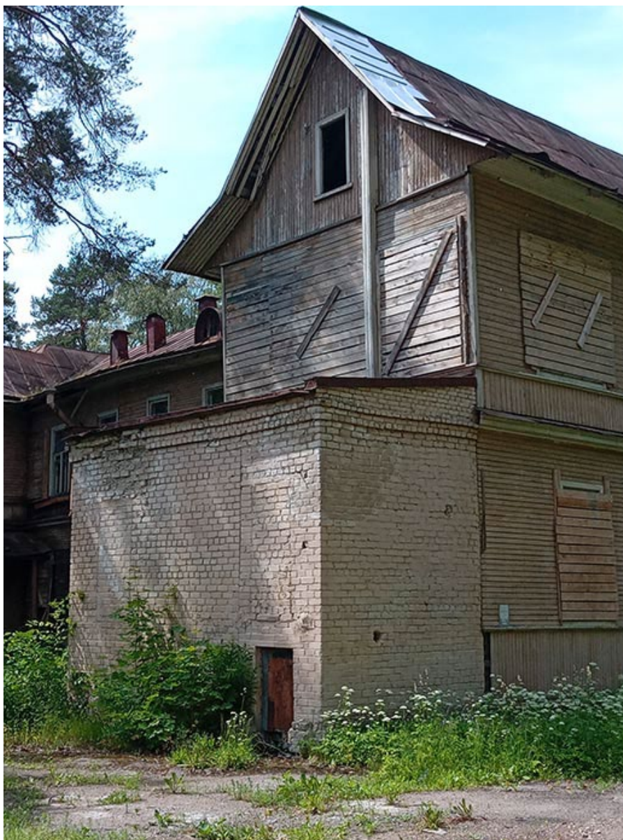
Фото 19. Выявленный объект культурного наследия «Дом купца Елисеева (ресторан) (деревянный)» по адресу: Санкт-Петербург, г. Зеленогорск Приморское шоссе, д. 520 литера Ц.
