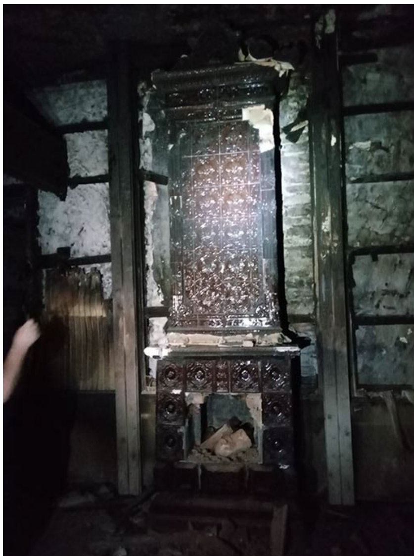
Фото 40. Выявленный объект культурного наследия «Дом купца Елисеева (ресторан) (деревянный)» по адресу: Санкт-Петербург, г. Зеленогорск Приморское шоссе, д. 520 литера Ц.
