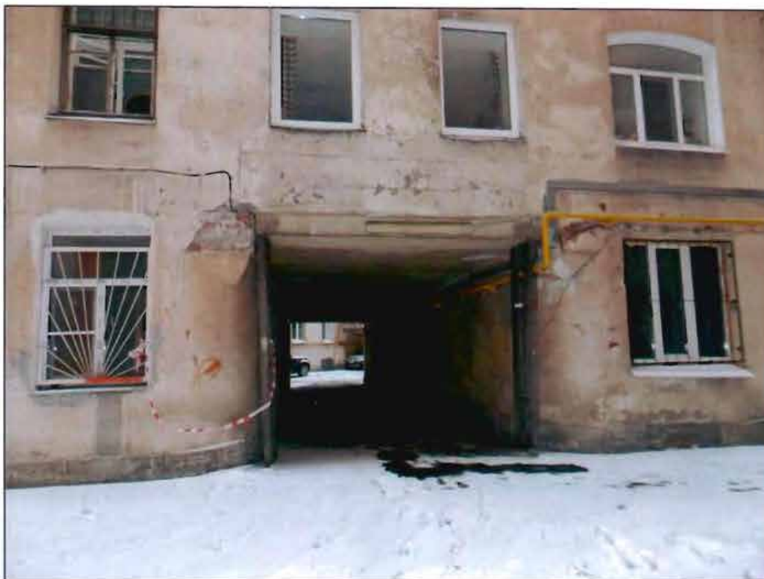
Фото 18. Фрагмент дворового фасада. Южный двор. Южный фасад. Воротный проезд между дворами.
