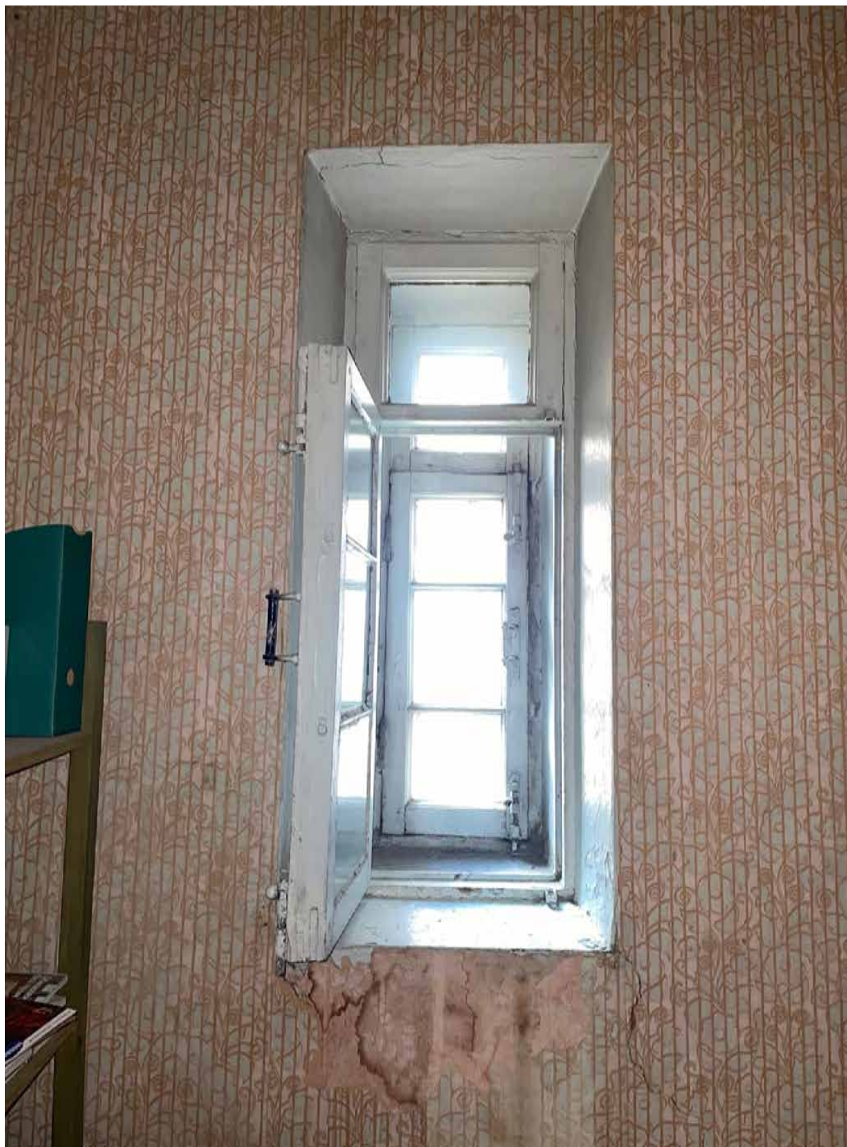
9. Вид оконного заполнения в помещении 3/6.4;
