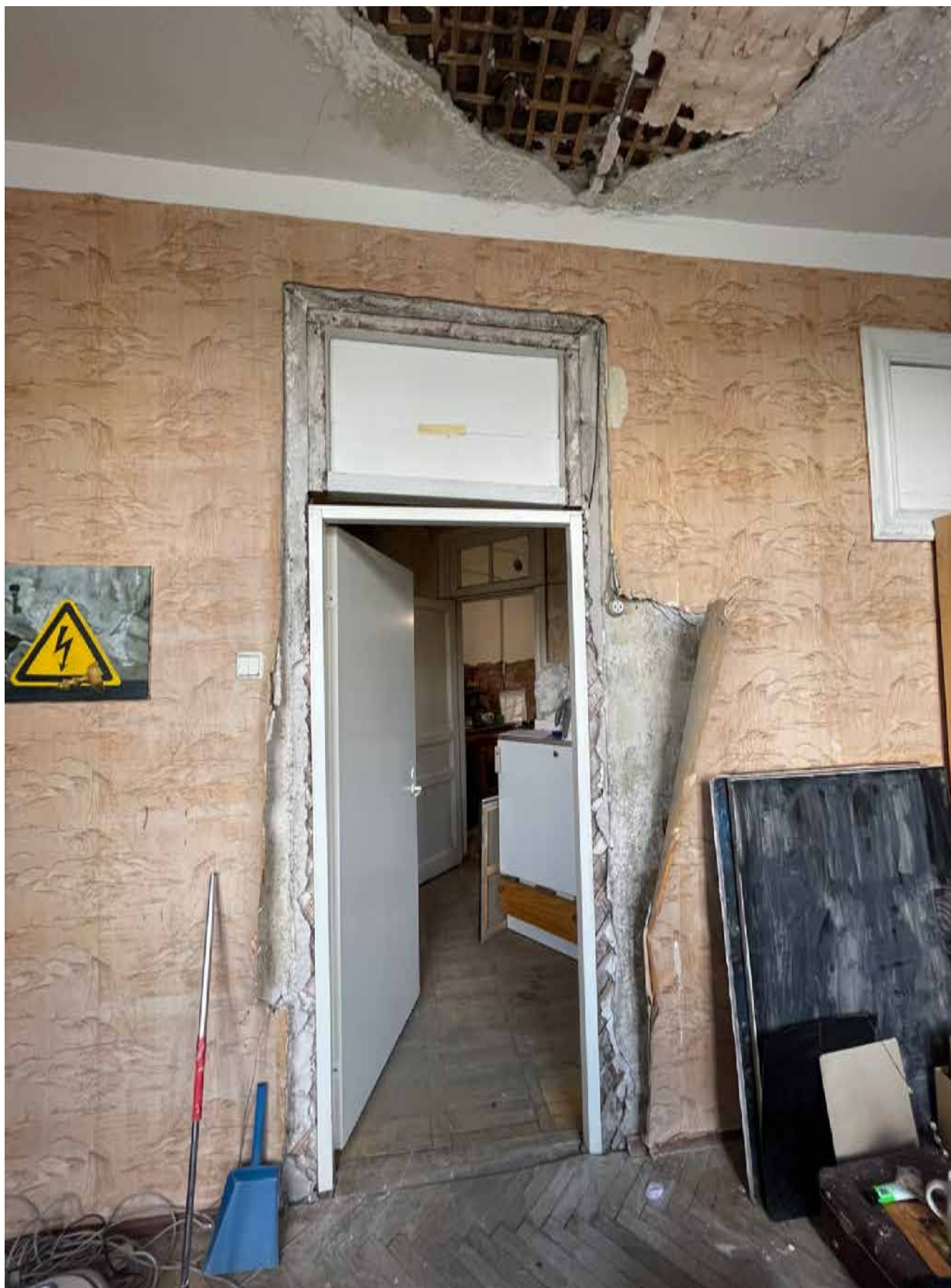
11.Фрагмент интерьера комнаты (помещение 9/13);
