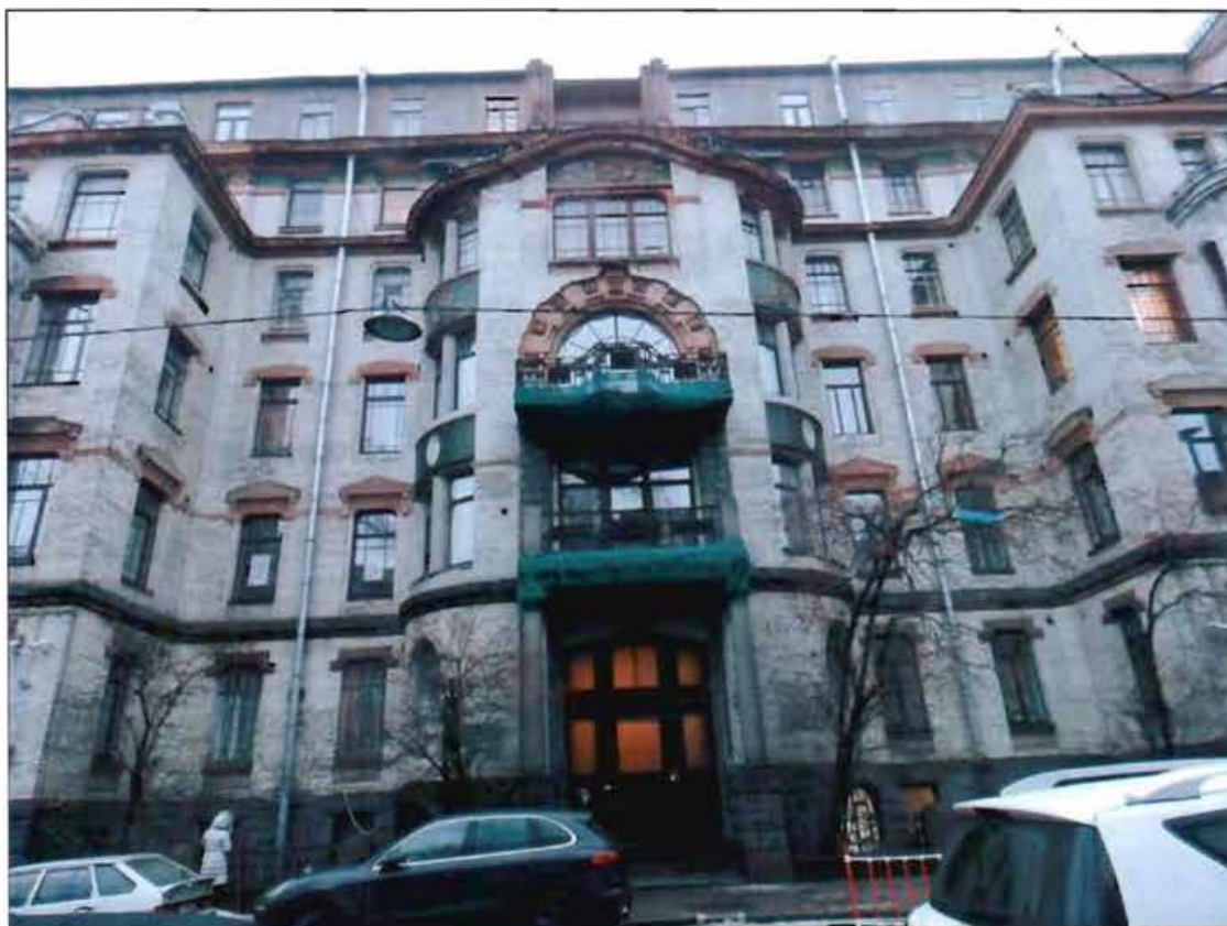
Фото 2. Фрагмент западного фасада.
