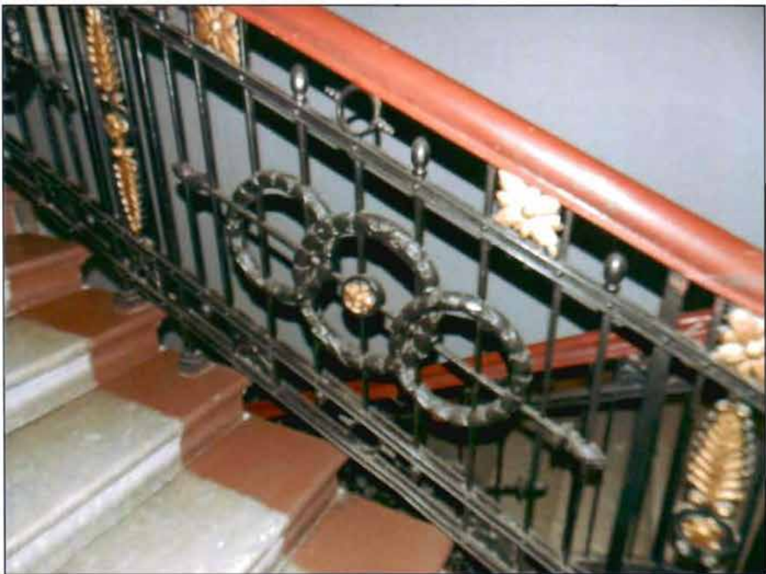
Фото 34. Интерьер. Парадная лестница. Фрагмент ограждения.
