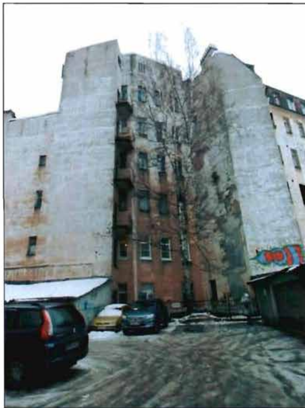
Фото 22. Фрагмент дворового фасада. Восточный двор. Восточный фасад.
