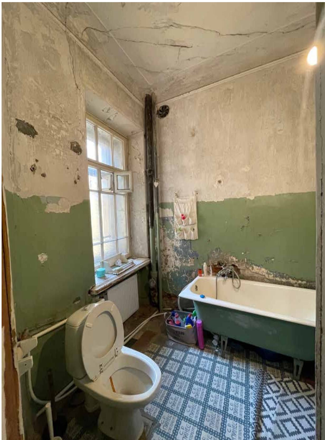
14.Фрагмент интерьера совмещенного санузла (помещение 5/4.7);
