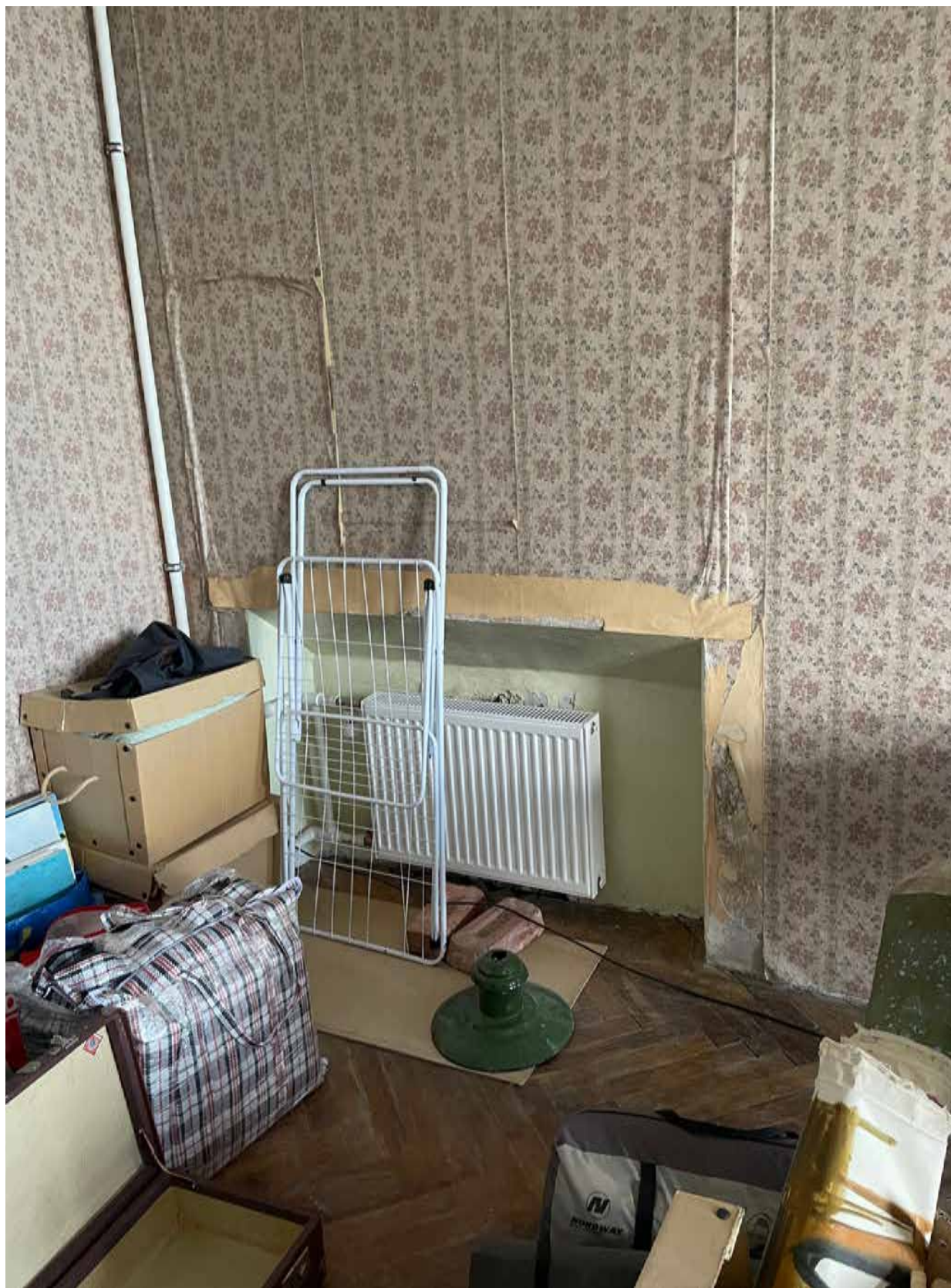
19.Фрагмент интерьера комнаты (помещение 7/16.6);
