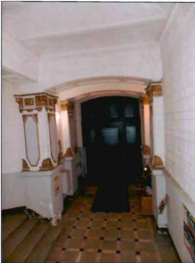
Фото 25. Интерьер. Вестибюль. Парадная лестница.
