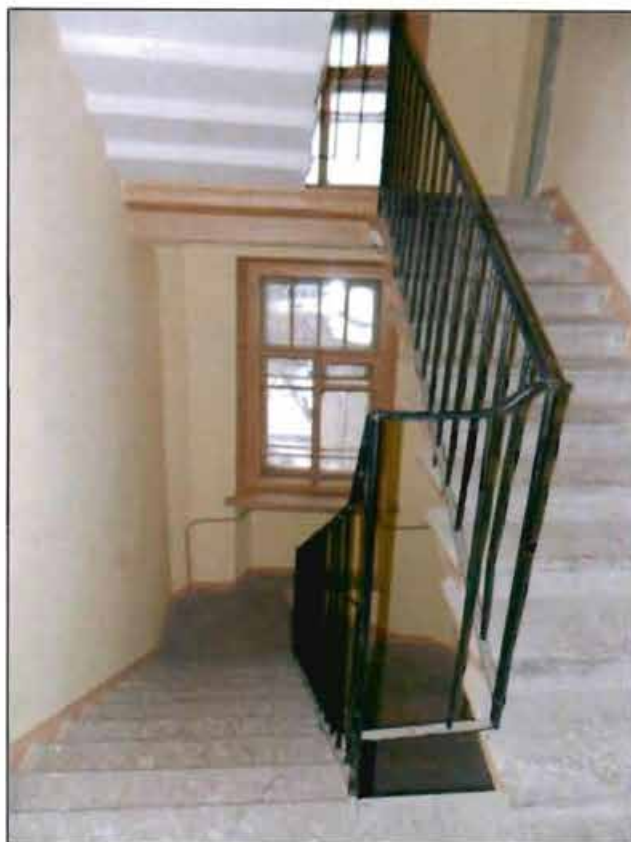
Фото 39. Интерьер. Лестница 3-ЛК.
