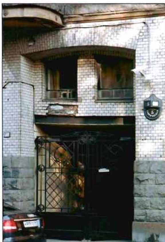
Фото 6. Фрагмент западного фасада. Воротный проезд.
