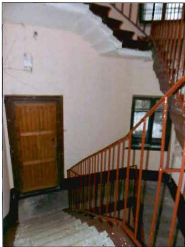
Фото 40. Интерьер. Лестница 4-ЛК.
