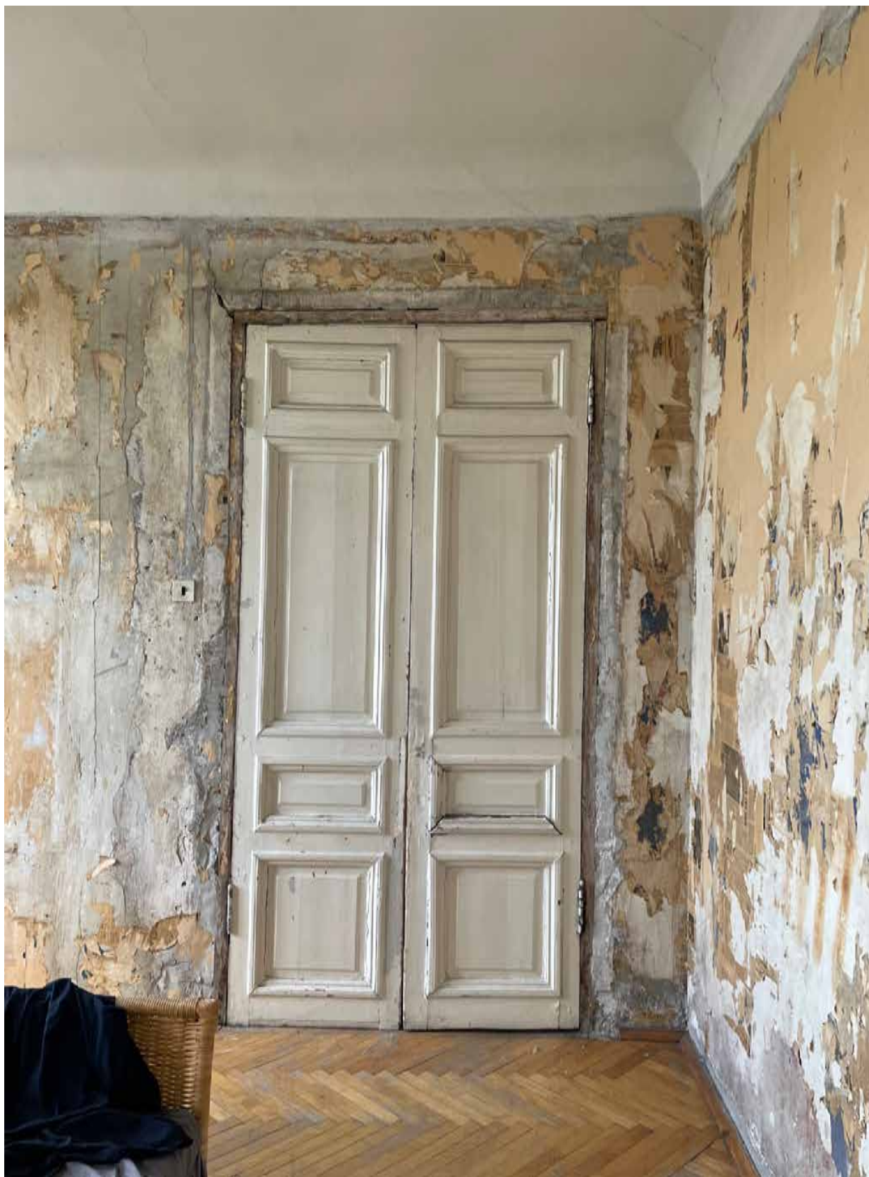
20.Фрагмент интерьера комнаты (помещение 7/16.6).
