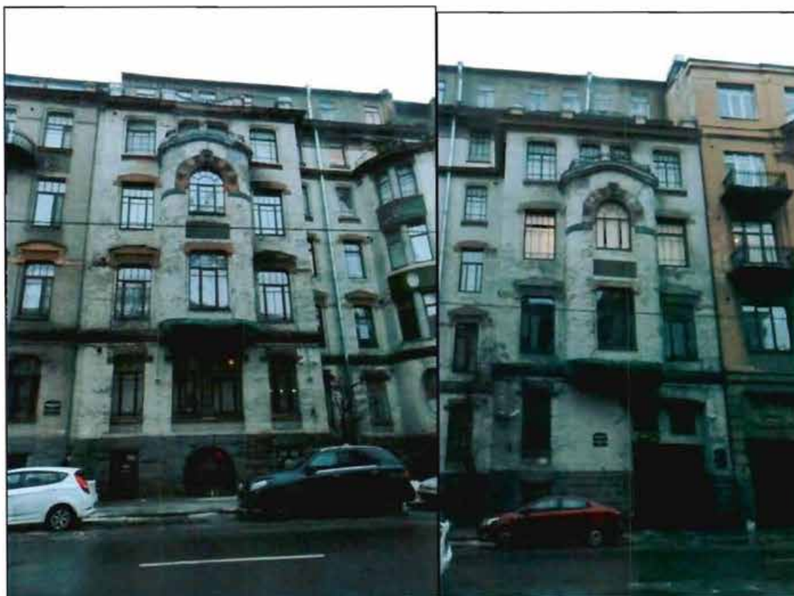
Фото 3-4. Фрагменты западного фасада.
