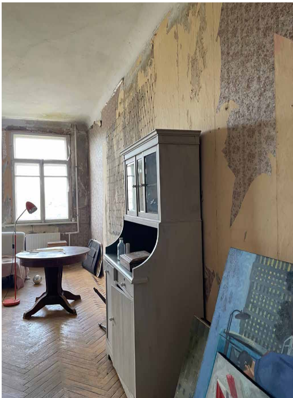
17.Фрагмент интерьера комнаты (помещение 6/28.4);
