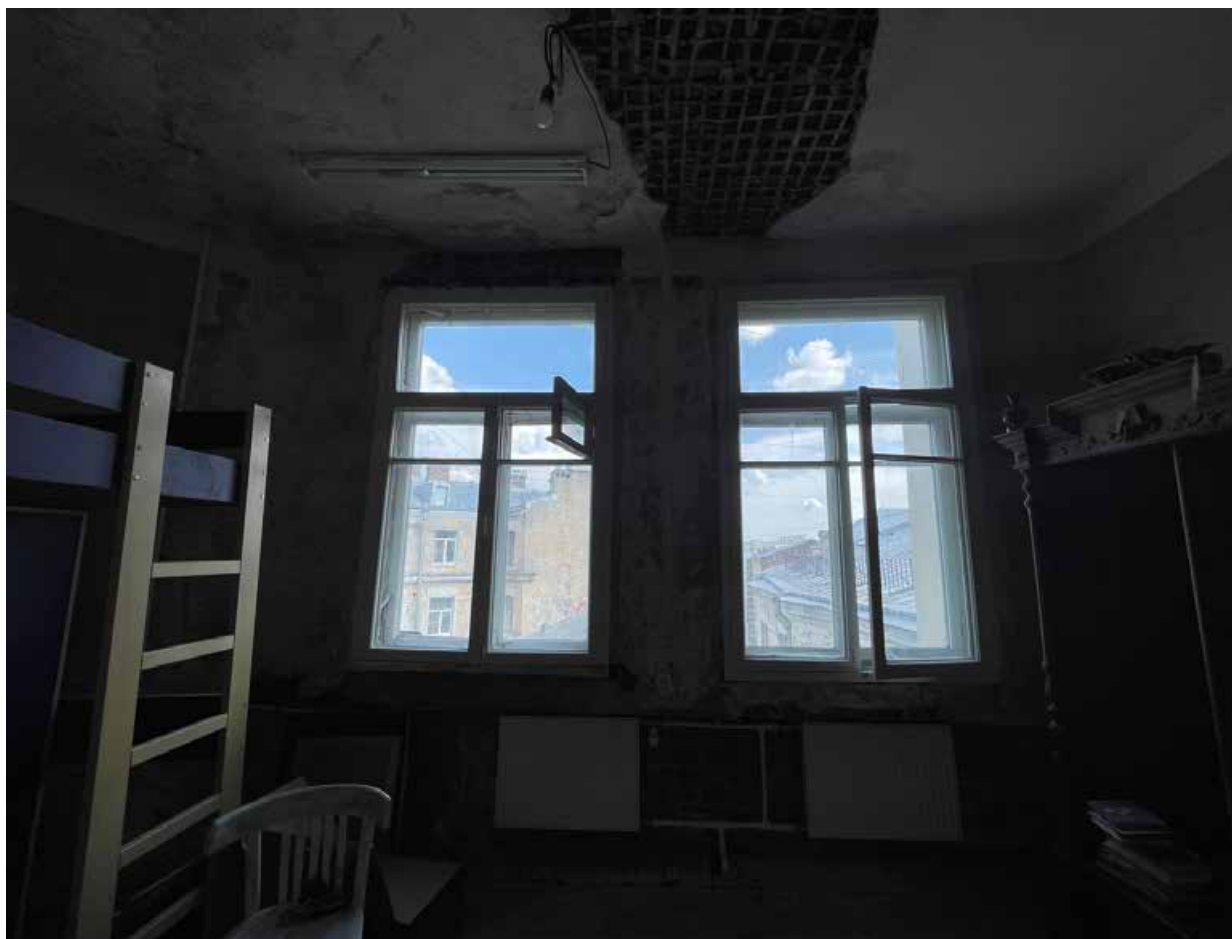
10.Фрагмент интерьера комнаты (помещение 9/13);
