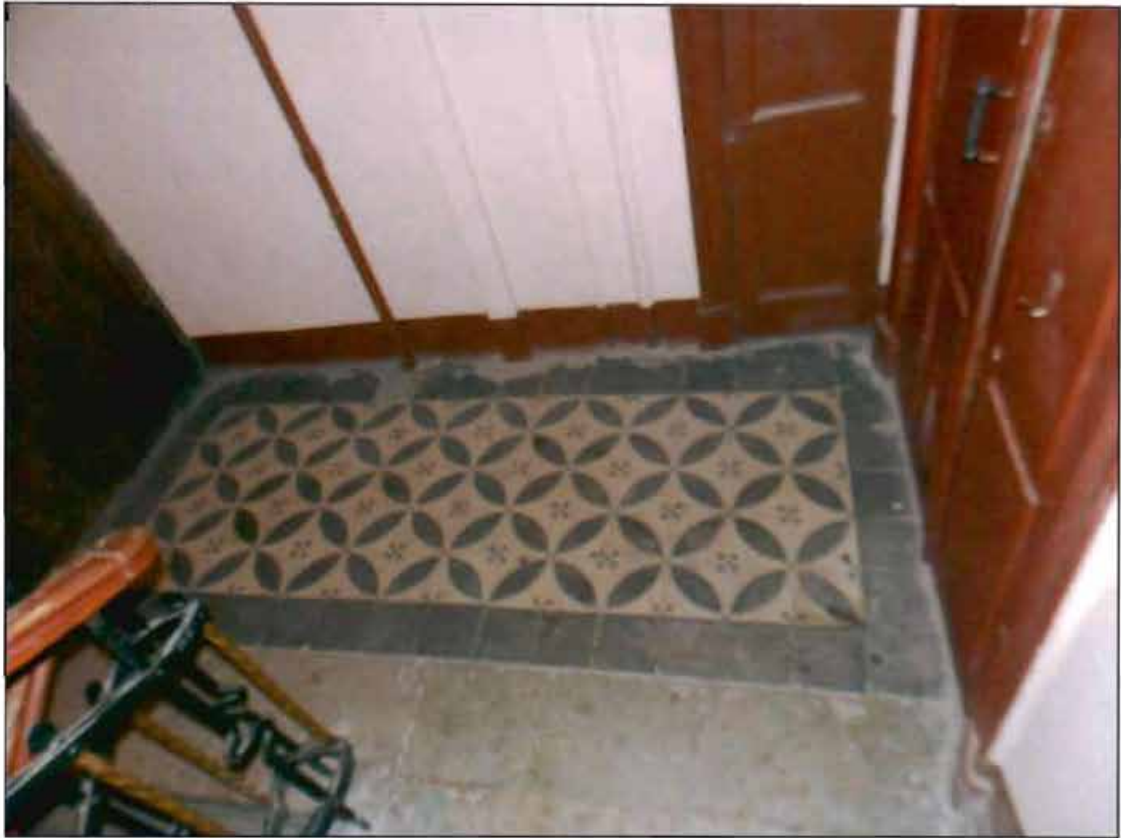
Фото 37. Интерьер. Лестница 2-ЛК.
