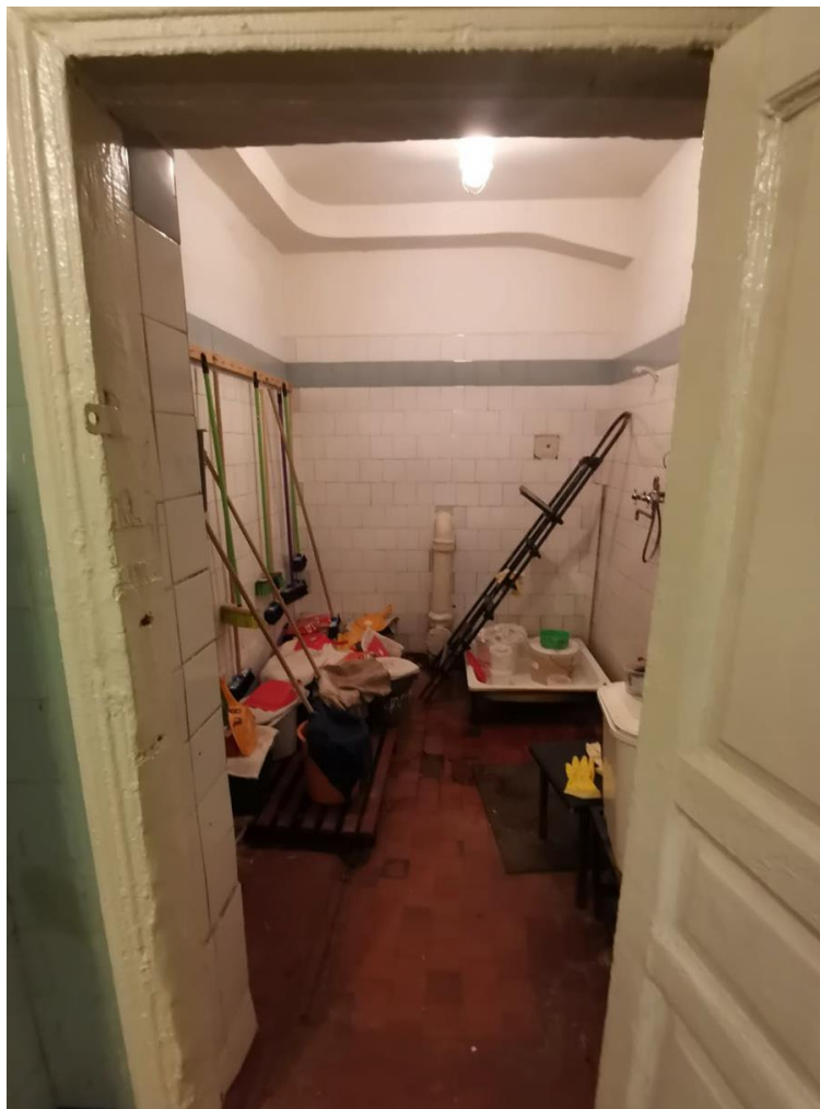
34. Выявленный объект культурного наследия «Здание школы» по адресу: Санкт-Петербург, Балтийская ул., д. 35, лит. А (Балтийская ул., 35). Столовая. Помещение душевой и инвентарной. Общий вид.
