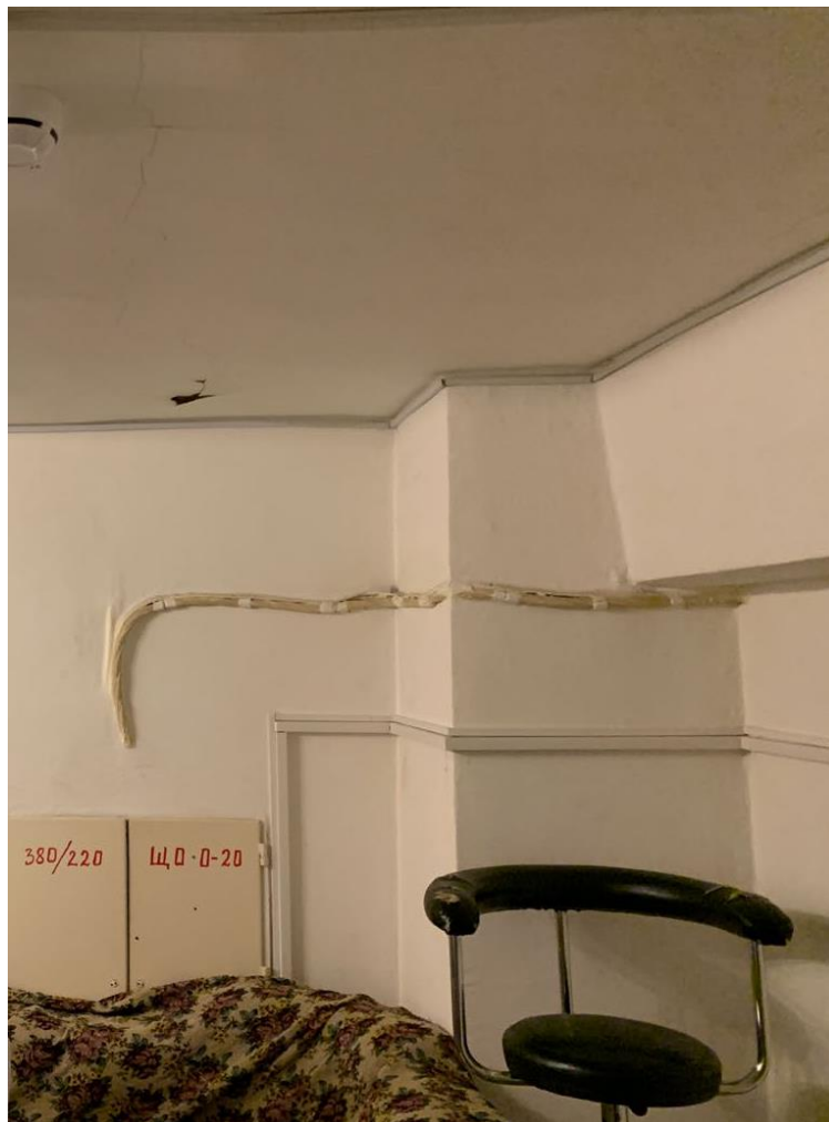
13. Выявленный объект культурного наследия «Здание школы» по адресу: Санкт-Петербург, Балтийская ул., д. 35, лит. А (Балтийская ул., 35). Помещение бухгалтерии (помещение №62). Фрагмент интерьера.
