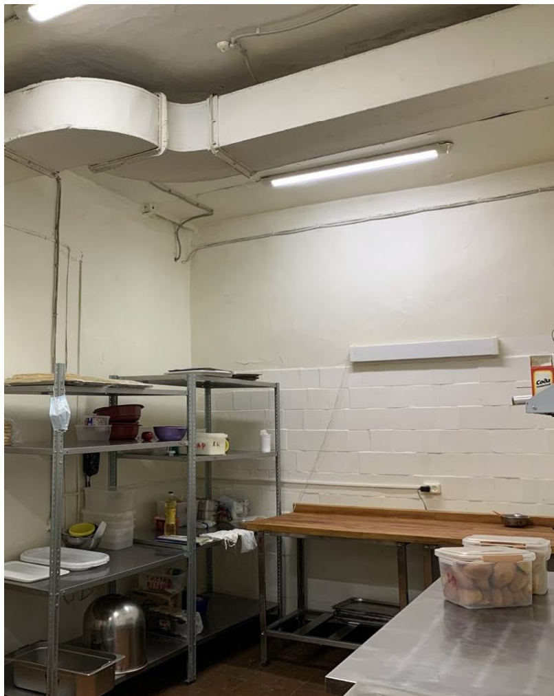
20. Выявленный объект культурного наследия «Здание школы» по адресу: Санкт-Петербург, Балтийская ул., д. 35, лит. А (Балтийская ул., 35). Столовая. Кондитерская (помещение №51). Фрагмент интерьера.
