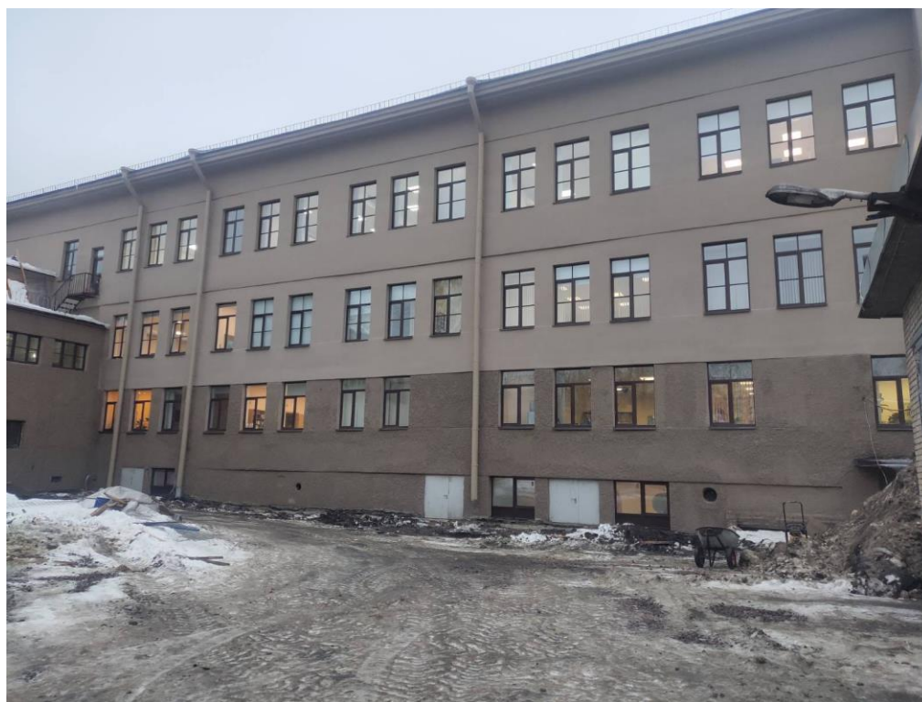
8. Выявленный объект культурного наследия «Здание школы» по адресу: Санкт-Петербург, Балтийская ул., д. 35, лит. А (Балтийская ул., 35). Западный фасад. Фрагмент.
