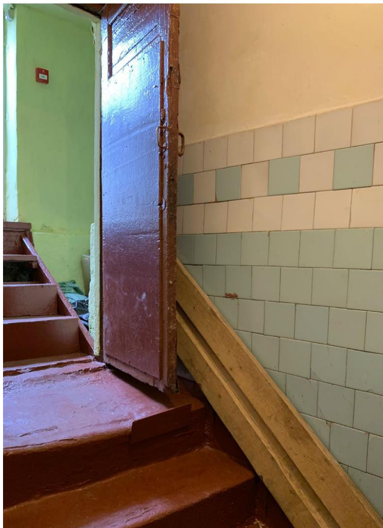
36. Выявленный объект культурного наследия «Здание школы» по адресу: Санкт-Петербург, Балтийская ул., д. 35, лит. А (Балтийская ул., 35). Столовая. Вид на технический выход. Лестница.
