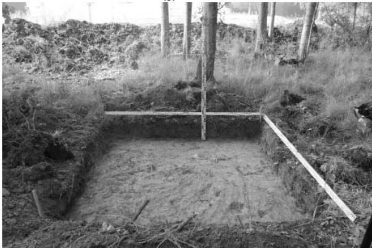
Рис. 48. СПб, Левашовское ш., уч. 1, КН: 78:38:0011501:109. Шурф 2, фиксация по уровню окончания работ, вид на север.
