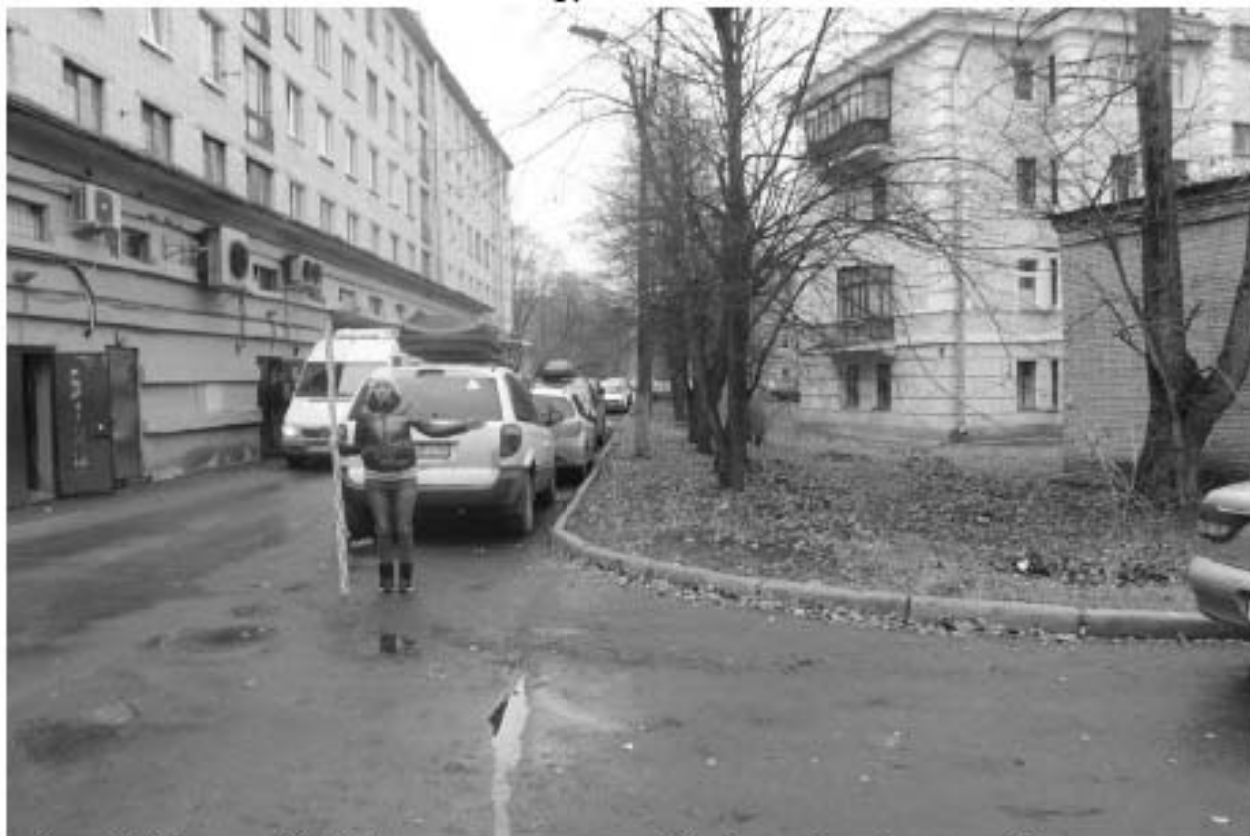
Рис. 14. Пушкин-2023. Красносельское ш., д. 39а. Точка фотофиксации 2, вид на запад.
