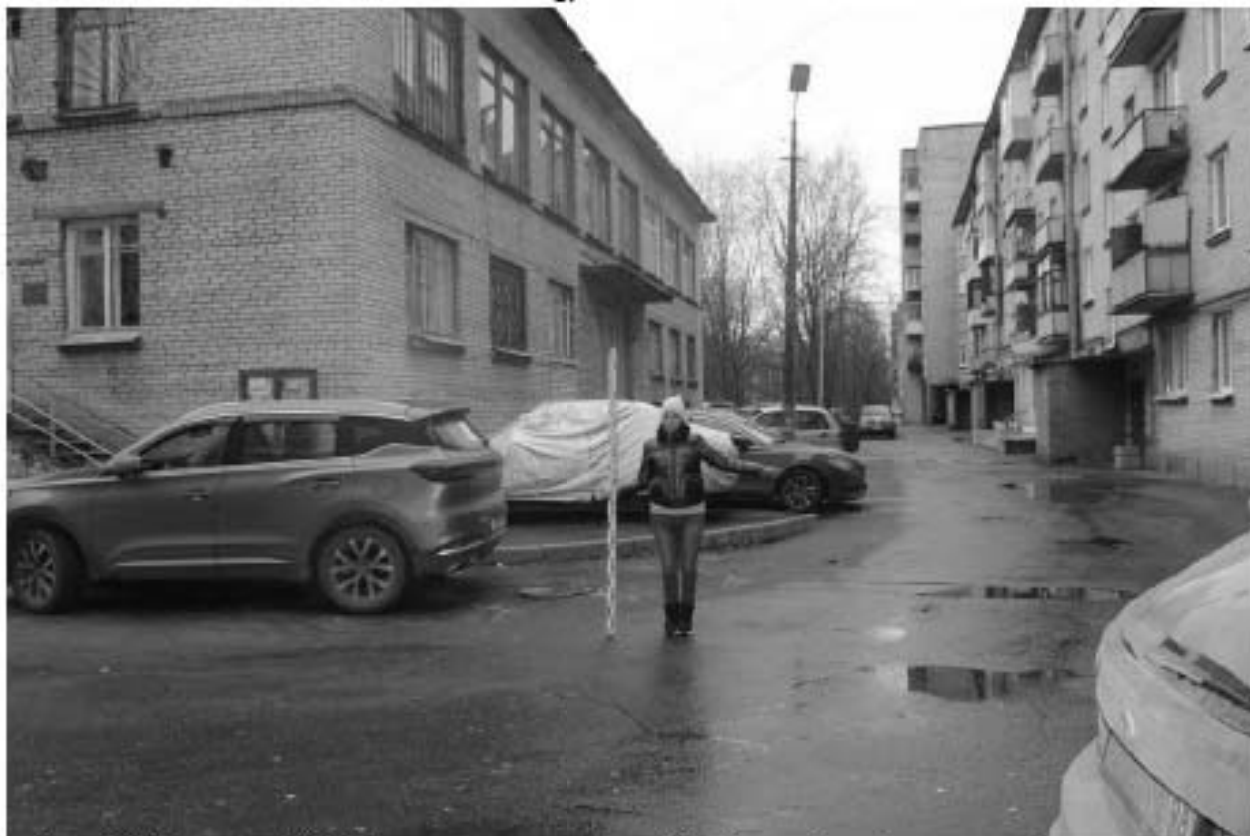
Рис. 20. Пушкин-2023. Красносельское ш., д. 39а. Точка фотофиксации 4, вид на запад.
