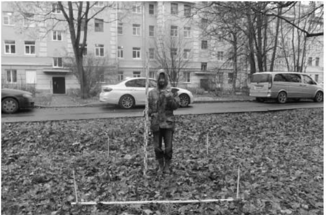
Рис. 43. Пушкин-2023. Красносельское ш., д. 39а. Местоположение шурфа 1, вид на запад.
