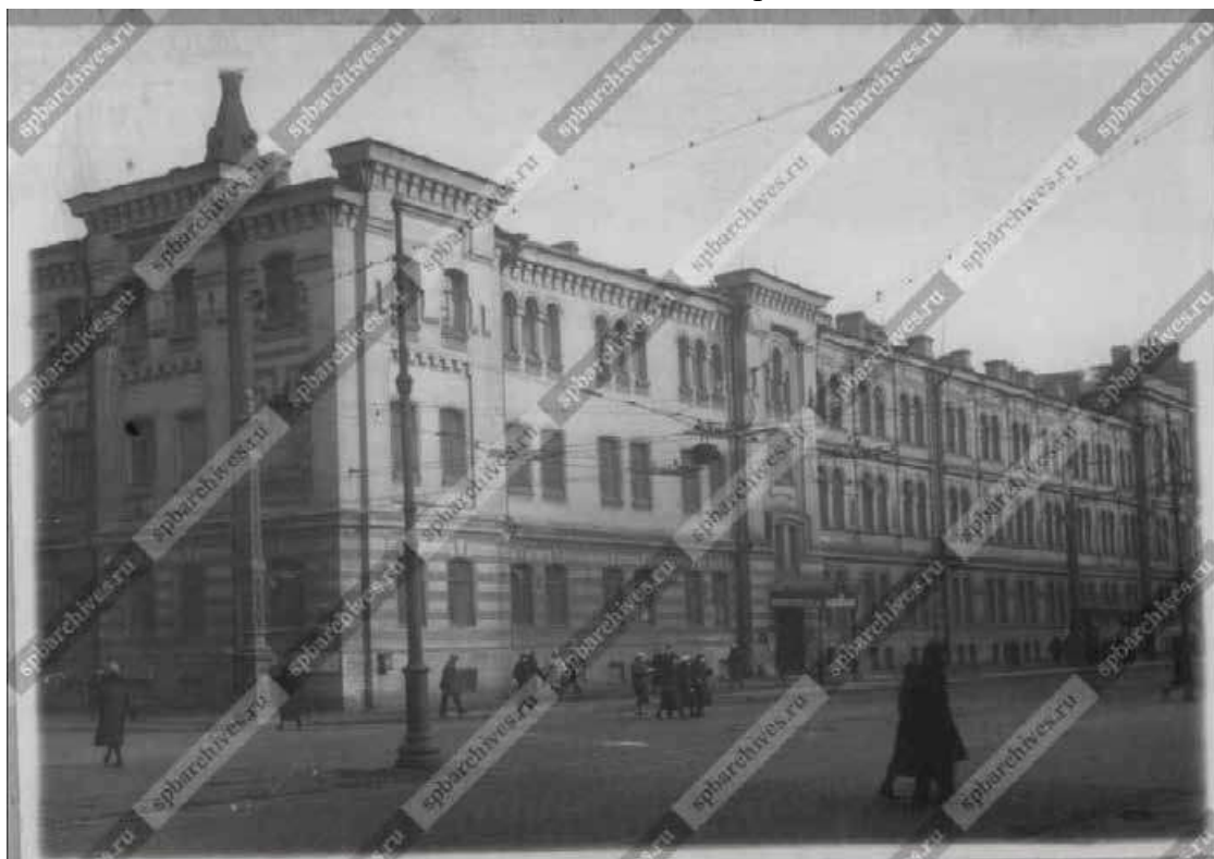
103105. Общий вид со стороны ул. Дегтярной фасада здания Ленинградского института переливания крови (2-я Советская улица д. № 16, до 1917 г. Свято-Троицкая община сестер милосердия, архитекторы Е. С. Воротилов, В. Р. Курзанов, 1876, 1889-1891 гг.). 1932 г. ЦГАКФФД СПб Гр 50073
