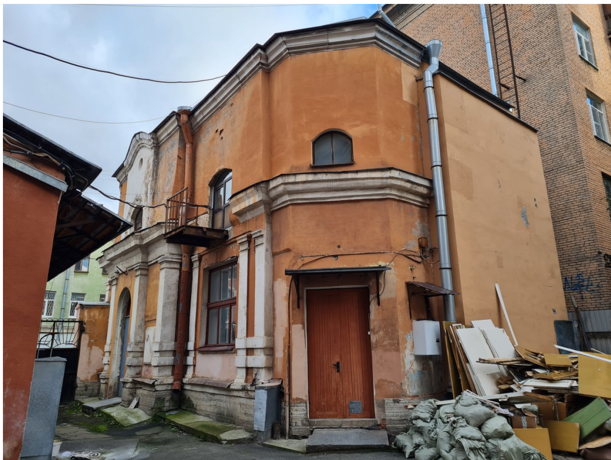
Фото 13. ОКН РЗ Часовня. Фасады со стороны двора.
