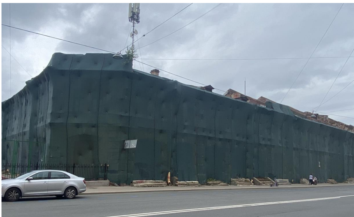
Фото 2. Фасад западного и восточного корпусов по пр. Бакунина.
