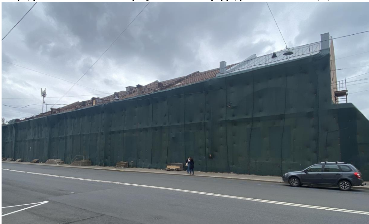
Фото 1. Общий вид восточного фасада здания со стороны пр. Бакунина.
