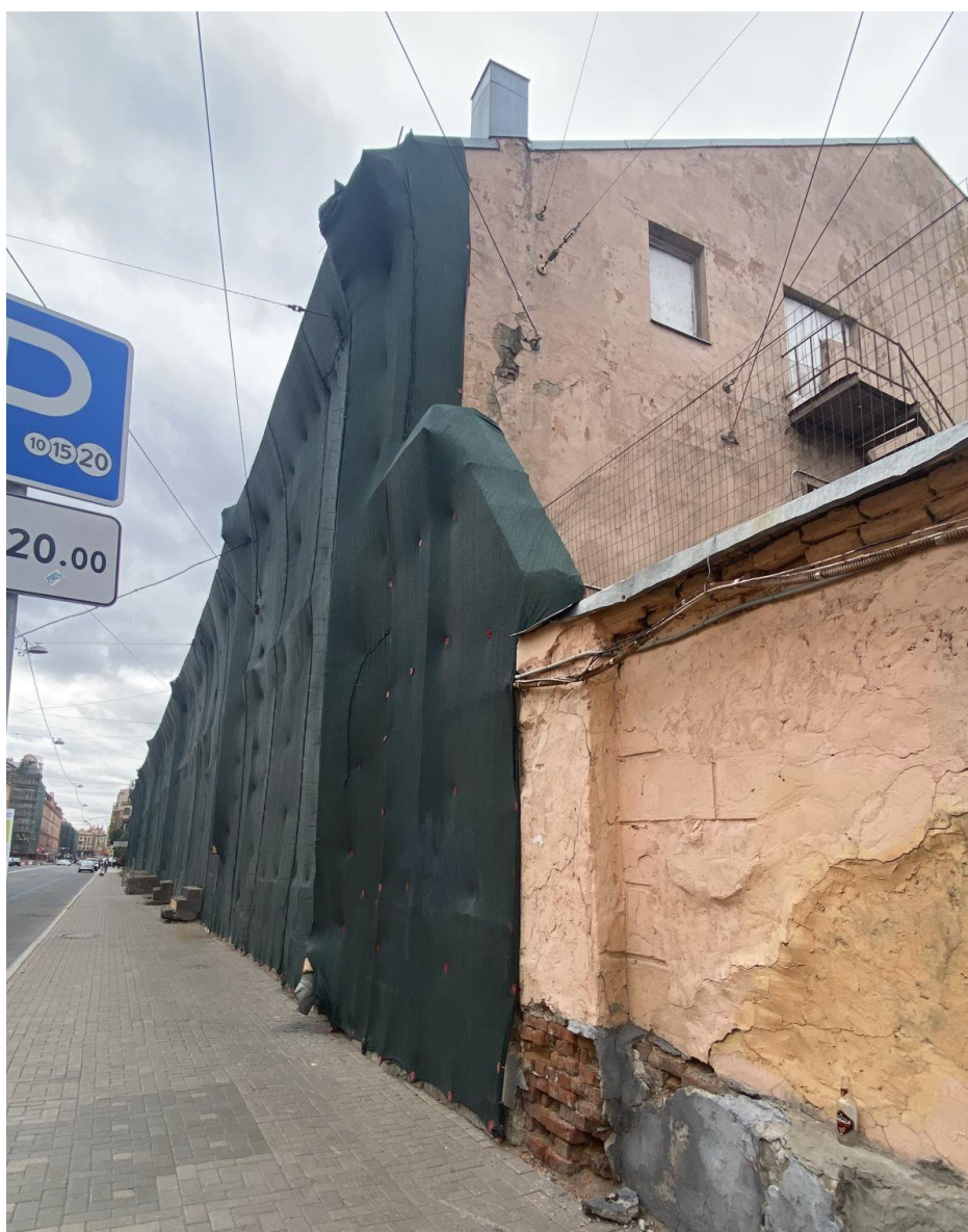
Фото 4. Фрагмент фасада восточного корпуса по пр. Бакунина. Сохранилась часть стены бывших лавок, в настоящее время к ней пристроена каменная ограда.
