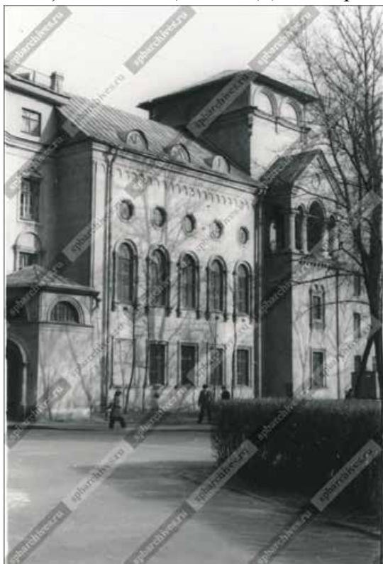
16. Вид части фасада дома №1 с часовней со стороны улицы Воскова ( в доме размещается детская музыкальная школа , бывшее здание детского приюта Братства во имя Царицы Небесной с домовою церковью "Всех скорбящих Радости, архитекторы Н.П. Козлов, А.И. Балинский, А.А. Яковлев, 1902-1903 гг., 1912-1913 гг.). 1978 г. // ЦГАКФФД СПб Ар 242007.
