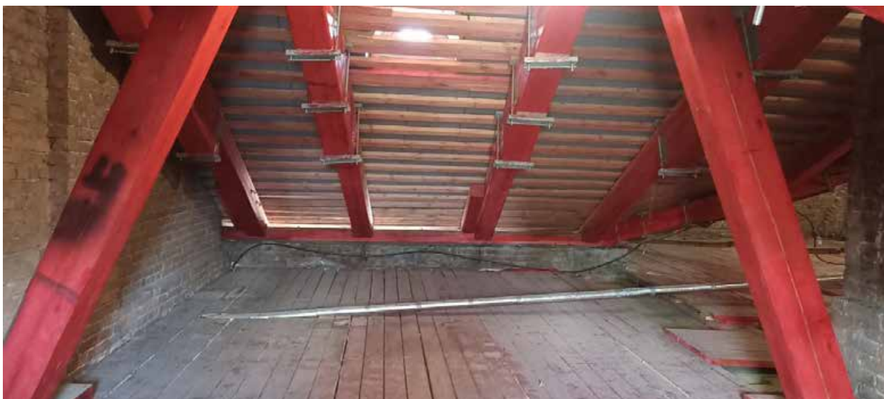
Фото 53. Интерьер чердака объекта культурного наследия регионального значения «Здание приюта для детей-идиотов и эпилептиков Братства во имя Царицы Небесной с примыкающей часовней при домово́й церкви Божьей Матери Скорбящих Радости»
