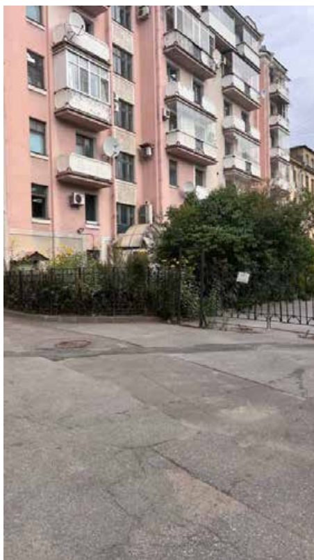
Фото 2. Вид на территорию объекта культурного наследия регионального значения «Здание приюта для детей-идиотов и эпилептиков Братства во имя Царицы Небесной с примыкающей часовней при домовая церкви Божьей Матери Скорбящих Радости»
