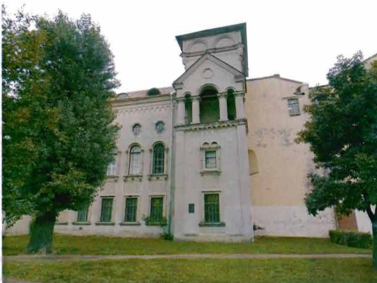
Фото 3. Часть западного фасада.
