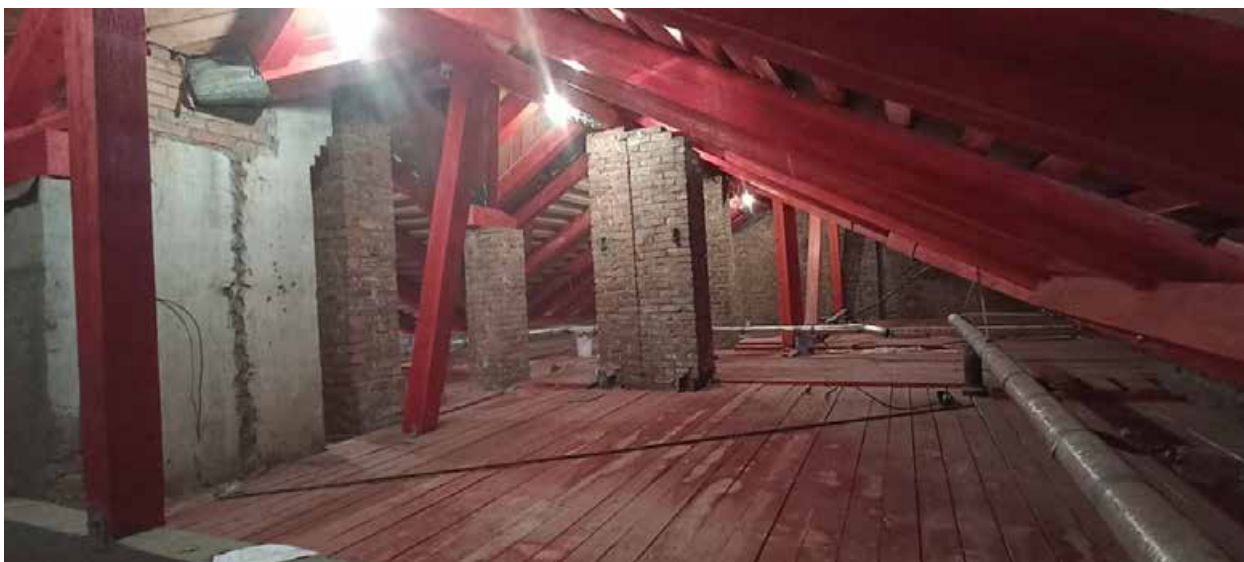
Фото 51. Интерьер чердака объекта культурного наследия регионального значения «Здание приюта для детей-идиотов и эпилептиков Братства во имя Царицы Небесной с примыкающей часовней при домово́й церкви Божьей Матери Скорбящих Радости»
