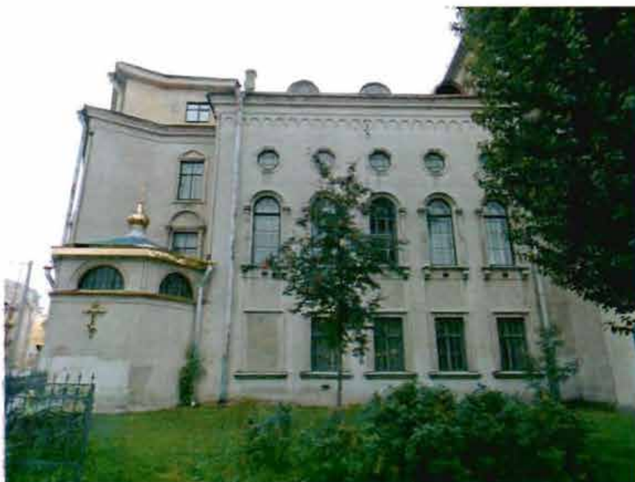
Фото 2. Часть западного фасада.
