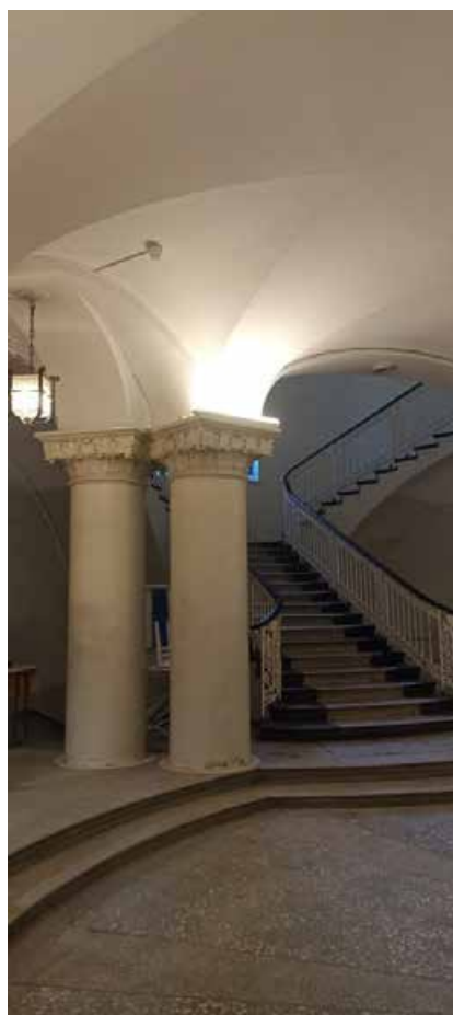
Фото 12. Интерьер 1-го этажа объекта культурного наследия регионального значения «Здание приюта для детей-идиотов и эпилептиков Братства во имя Царицы Небесной с примыкающей часовней при домовая церкви Божьей Матери Скорбящих Радости»
