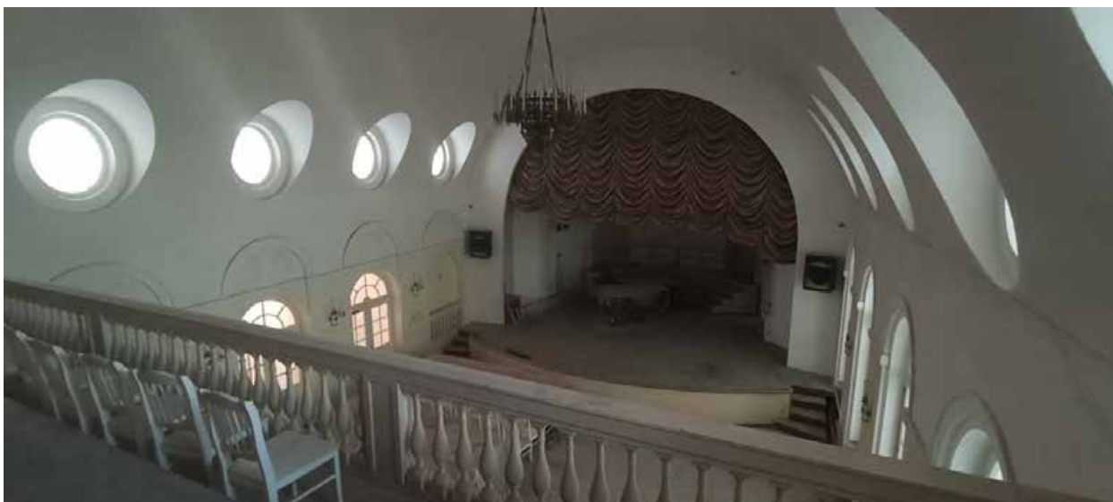
Фото 49. Интерьер 3-го этажа объекта культурного наследия регионального значения «Здание приюта для детей-идиотов и эпилептиков Братства во имя Царицы Небесной с примыкающей часовней при домовая церкви Божьей Матери Скорбящих Радости»
