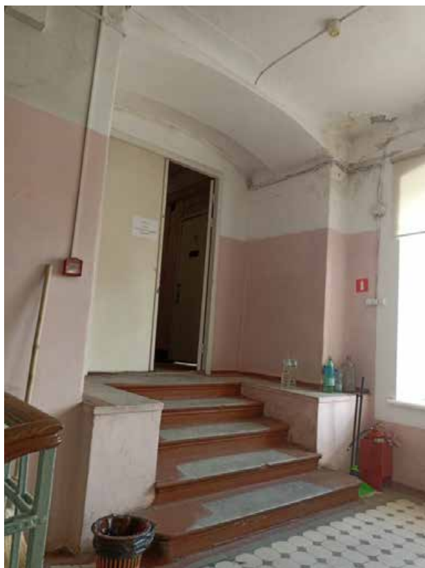
Фото 39. Интерьер 4-го этажа объекта культурного наследия регионального значения «Здание приюта для детей-идиотов и эпилептиков Братства во имя Царицы Небесной с примыкающей часовней при домово́й церкви Божьей Матери Скорбящих Радости»
