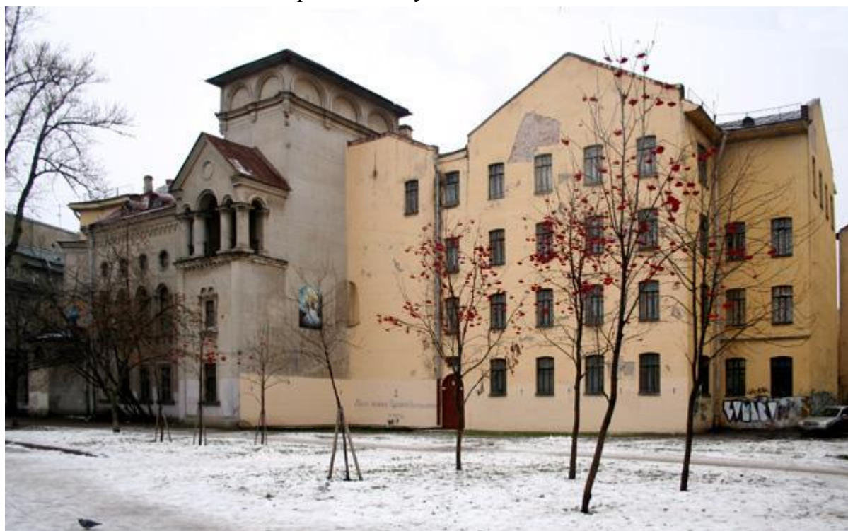
26. Вид со стороны сквера. 2019 г. — Здание детского приюта Братства во имя Царицы Небесной // Citywalls.ru – архитектурный сайт Петербурга [Электронный ресурс]. URL: https://www.citywalls.ru/house5674.html .
