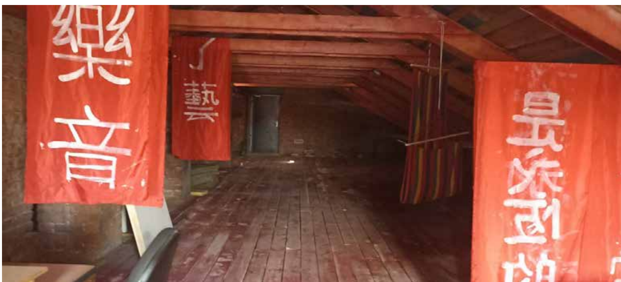
Фото 50. Интерьер чердака объекта культурного наследия регионального значения «Здание приюта для детей-идиотов и эпилептиков Братства во имя Царицы Небесной с примыкающей часовней при домовая церкви Божьей Матери Скорбящих Радости»
