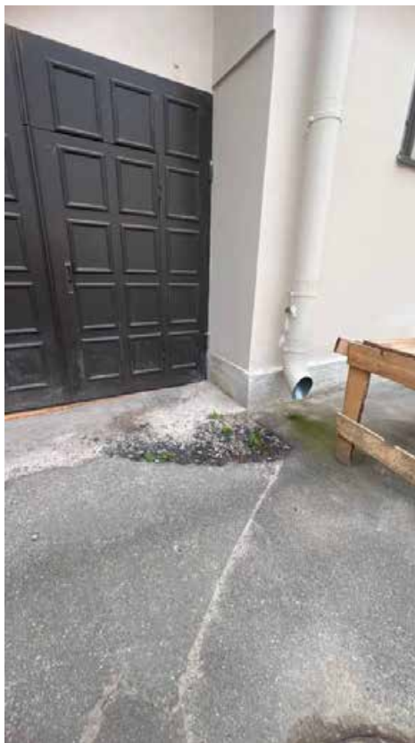
Фото 1. Вид на территорию объекта культурного наследия регионального значения «Здание приюта для детей-идиотов и эпилептиков Братства во имя Царицы Небесной с примыкающей часовней при домовая церкви Божьей Матери Скорбящих Радости»
