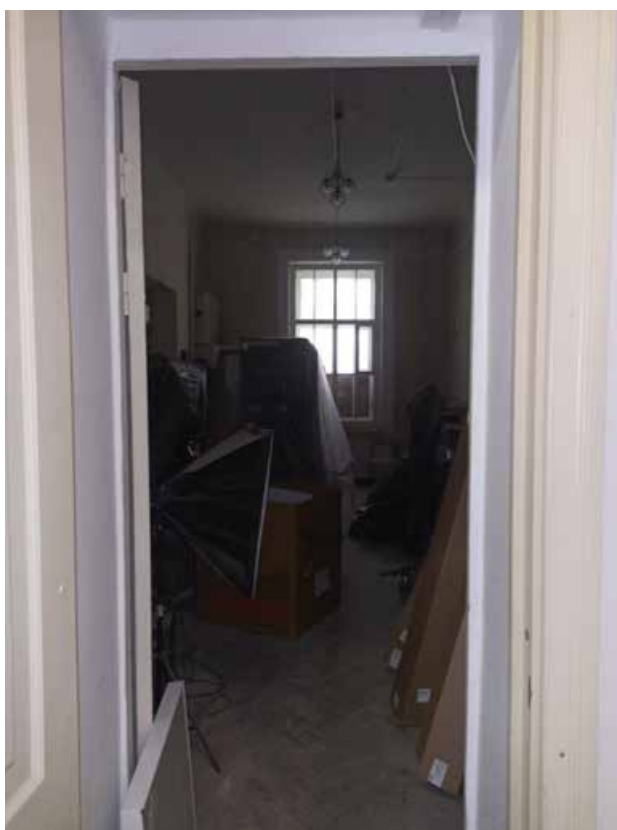
Фото 22. Интерьер 2-го этажа объекта культурного наследия регионального значения «Здание приюта для детей-идиотов и эпилептиков Братства во имя Царицы Небесной с примыкающей часовней при домово́й церкви Божьей Матери Скорбящих Радости»
