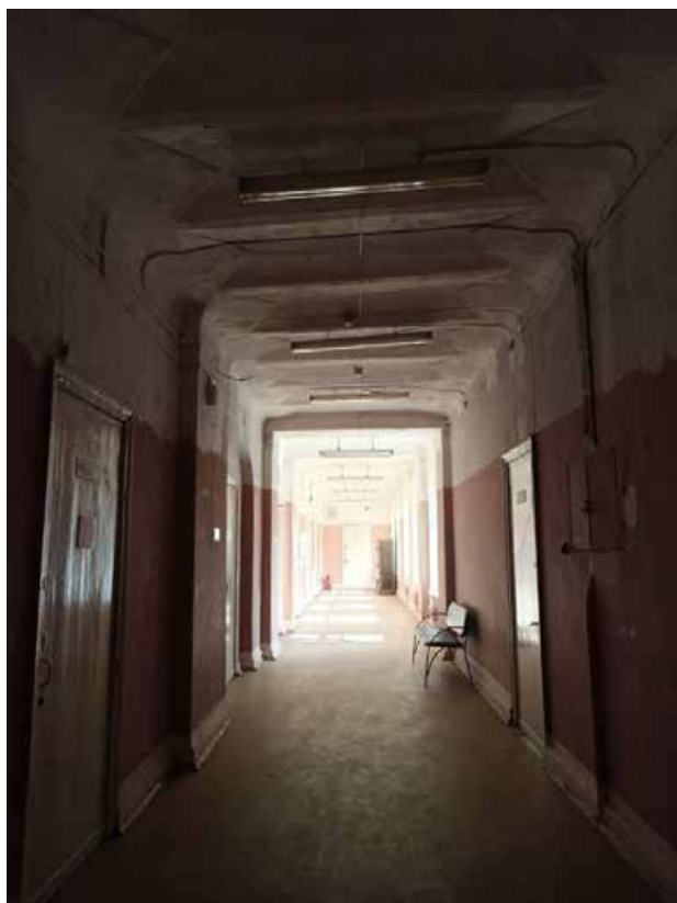
Фото 37. Интерьер 4-го этажа объекта культурного наследия регионального значения «Здание приюта для детей-идиотов и эпилептиков Братства во имя Царицы Небесной с примыкающей часовней при домово́й церкви Божьей Матери Скорбящих Радости»
