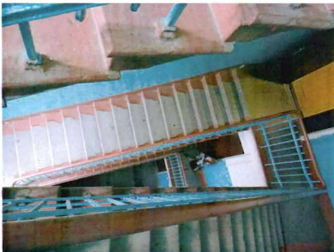
Фото 14. Лестница в южной части здания, пом. Н-2.
