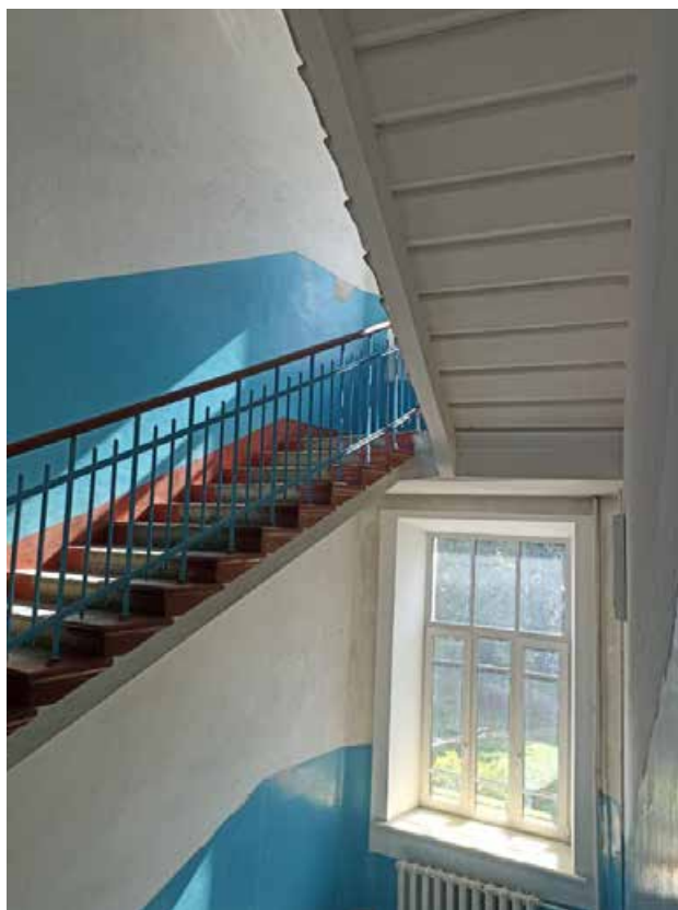
Фото 43. Интерьер 3-го этажа объекта культурного наследия регионального значения «Здание приюта для детей-идиотов и эпилептиков Братства во имя Царицы Небесной с примыкающей часовней при домово́й церкви Божьей Матери Скорбящих Радости»
