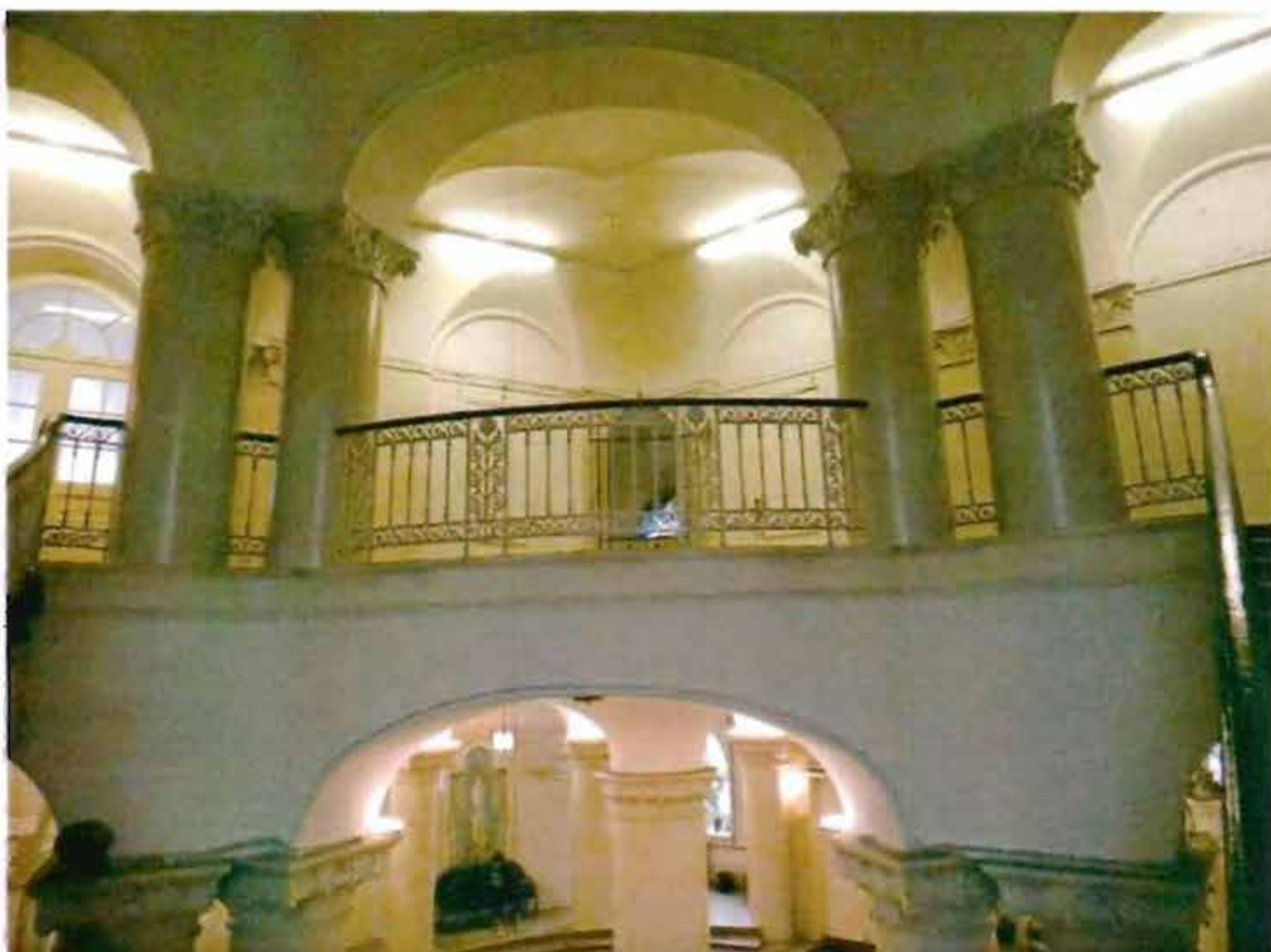
Фото 7. Верхняя площадка 2-го этажа парадной лестницы.
