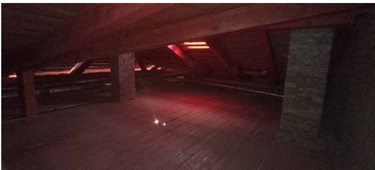
Фото 54. Интерьер чердака объекта культурного наследия регионального значения «Здание приюта для детей-идиотов и эпилептиков Братства во имя Царицы Небесной с примыкающей часовней при домово́й церкви Божьей Матери Скорбящих Радости»
