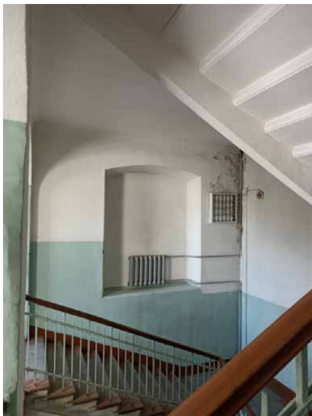
Фото 33. Интерьер 3-го этажа объекта культурного наследия регионального значения «Здание приюта для детей-идиотов и эпилептиков Братства во имя Царицы Небесной с примыкающей часовней при домовой церкви Божьей Матери Скорбящих Радости»
