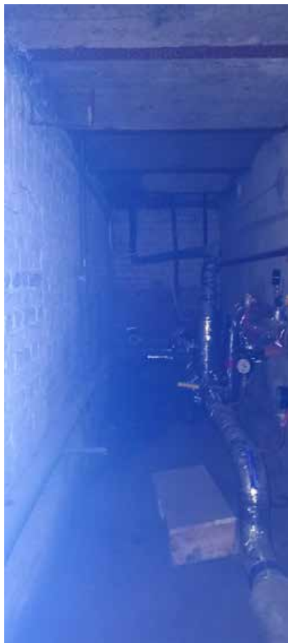
Фото 7. Интерьер подвального этажа объекта культурного наследия регионального значения «Здание приюта для детей-идиотов и эпилептиков Братства во имя Царицы Небесной с примыкающей часовней при домовая церкви Божьей Матери Скорбящих Радости»
