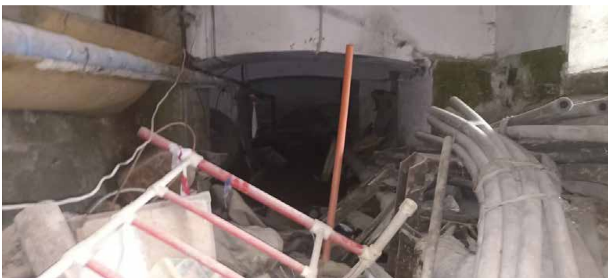
Фото 10. Интерьер подвального этажа объекта культурного наследия регионального значения «Здание приюта для детей-идиотов и эпилептиков Братства во имя Царицы Небесной с примыкающей часовней при домовой церкви Божьей Матери Скорбящих Радости»
