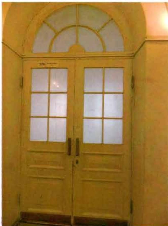
Фото 11. Двустворчатые двери с арочным завершением.
