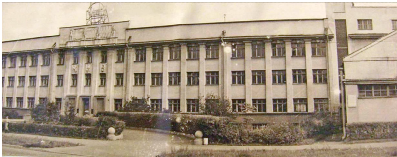
Илл.26. ВНИИГ им. Веденева Лицевой корпус. Фото 1960-х гг. По материалам музея ОАО ВНИИГ им. Б.Е. Веденева.
