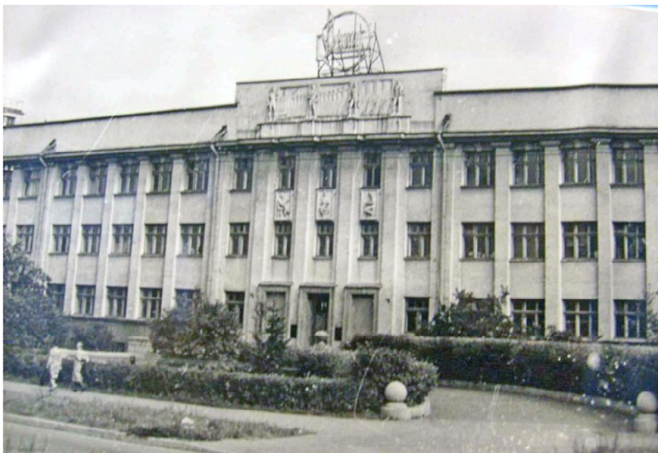
Илл.30. ВНИИГ им. Веденева Лицевой корпус. Фото 1971 г. По материалам музея ОАО ВНИИГ им. Б.Е. Веденева.
