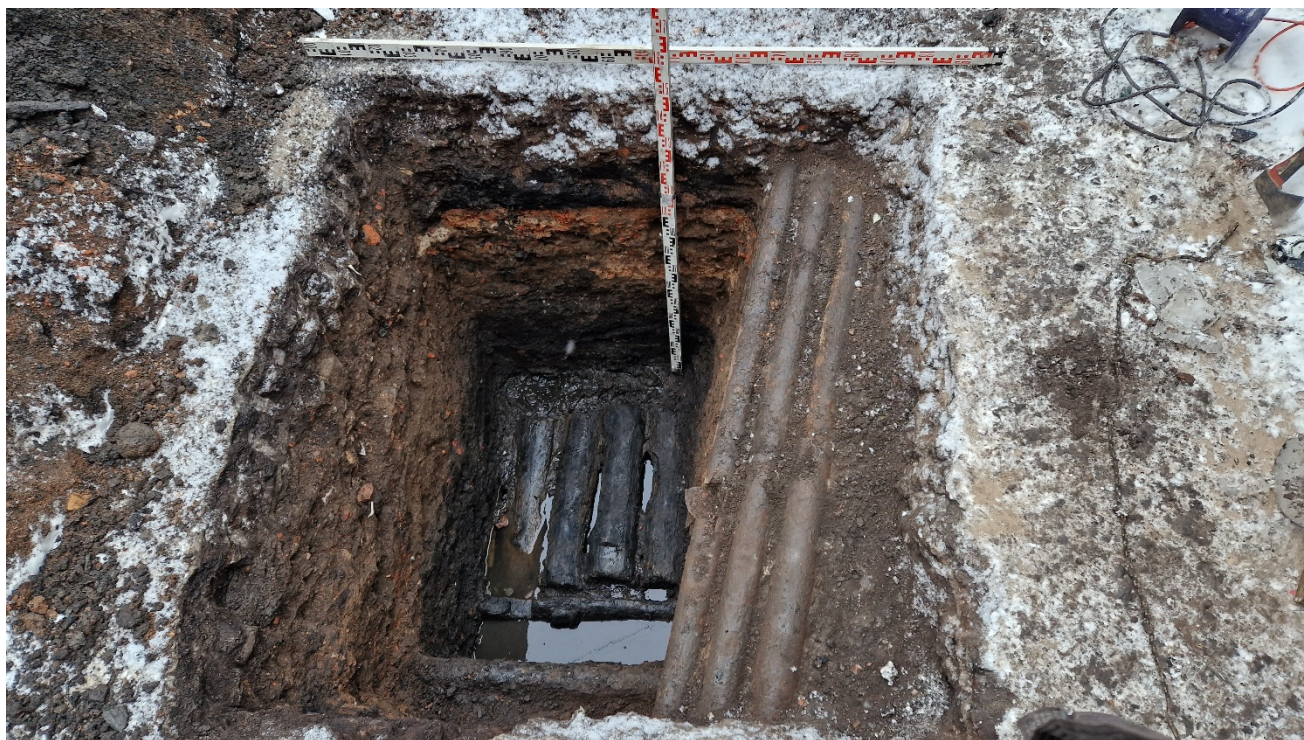
Рис.25. СПб., Центральный район, ул. Харьковская, д. 3-5, литера В. Шурф 1. Фиксация по уровню поверхности дренажного короба. Вид на северо-восток.
