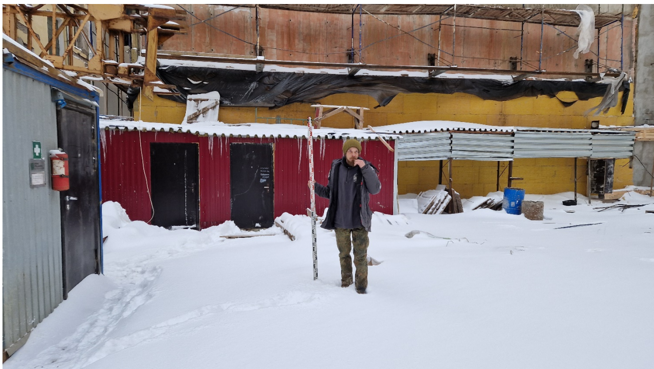
Рис.19. СПб., Центральный район, ул. Харьковская, д. 3-5, литера В. Точка съёмки №2. Вид на запад.
