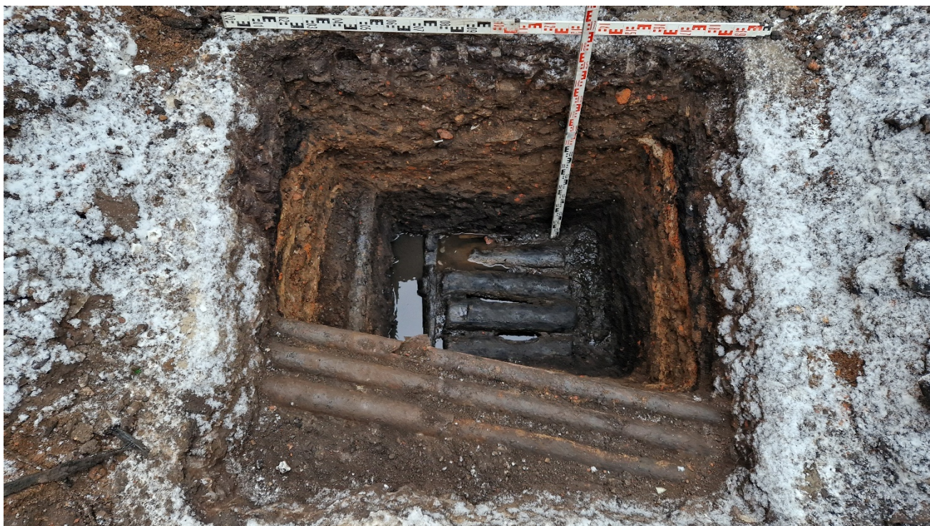
Рис.27. СПб., Центральный район, ул. Харьковская, д. 3-5, литера В. Шурф 1. Фиксация по уровню поверхности дренажного короба. Вид на юго-восток.
