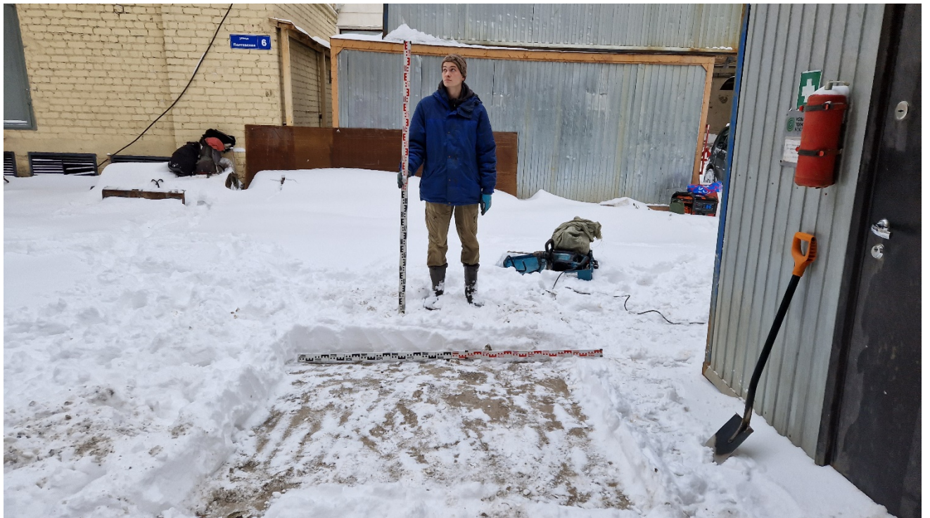
Рис.23. СПб., Центральный район, ул. Харьковская, д. 3-5, литера В. Шурф 1. Общий вид дневной поверхности до начала работ. Вид на северо-восток.
