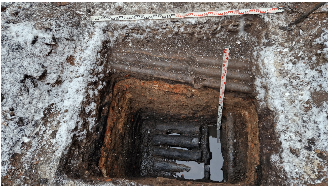
Рис.31. СПб., Центральный район, ул. Харьковская, д. 3-5, литера В. Шурф 1. Фиксация по уровню поверхности дренажного короба. Вид на северо-запад.
