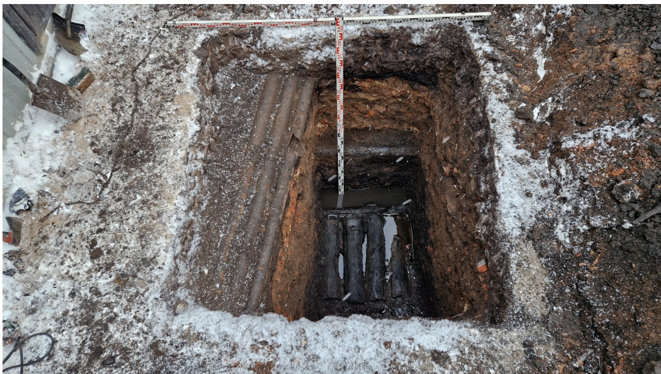
Рис.29. СПб., Центральный район, ул. Харьковская, д. 3-5, литера В. Шурф 1. Фиксация по уровню поверхности дренажного короба. Вид на юго-запад.
