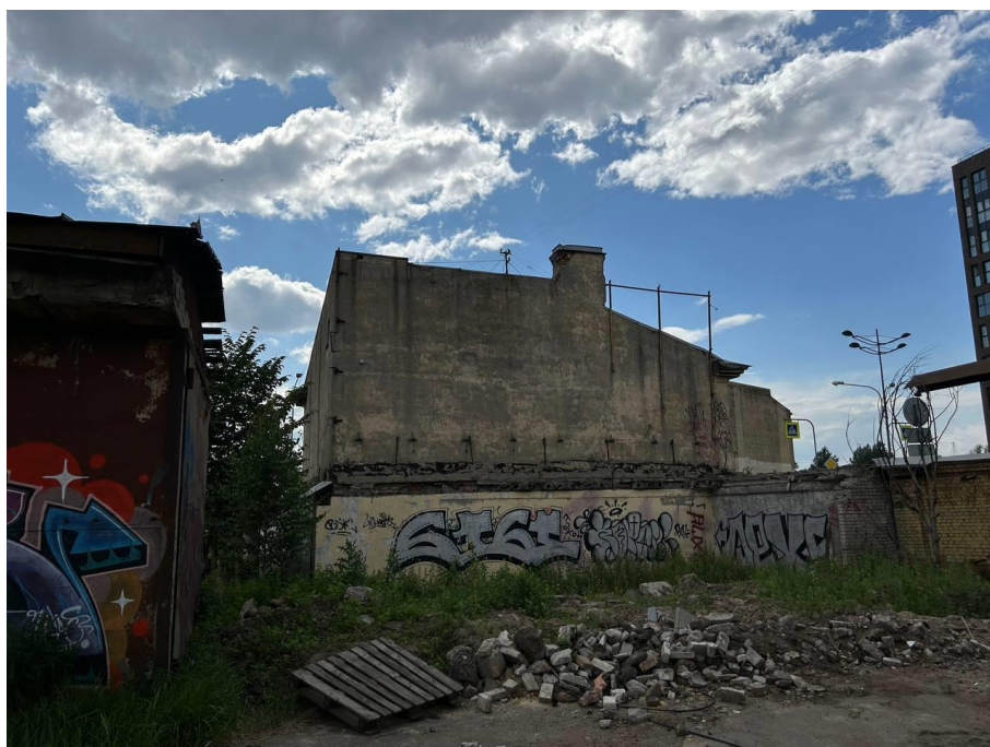
Фото №4. Вид на северный фасад здания.
