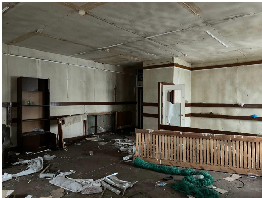
Фото №27. Помещение 2-го этажа, вид в сторону входа.
