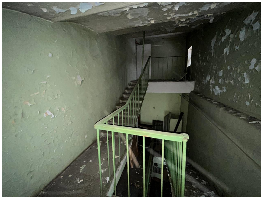
Фото №31. Вид с междуэтажной площадки между 2 этажом и чердачным помещением.
