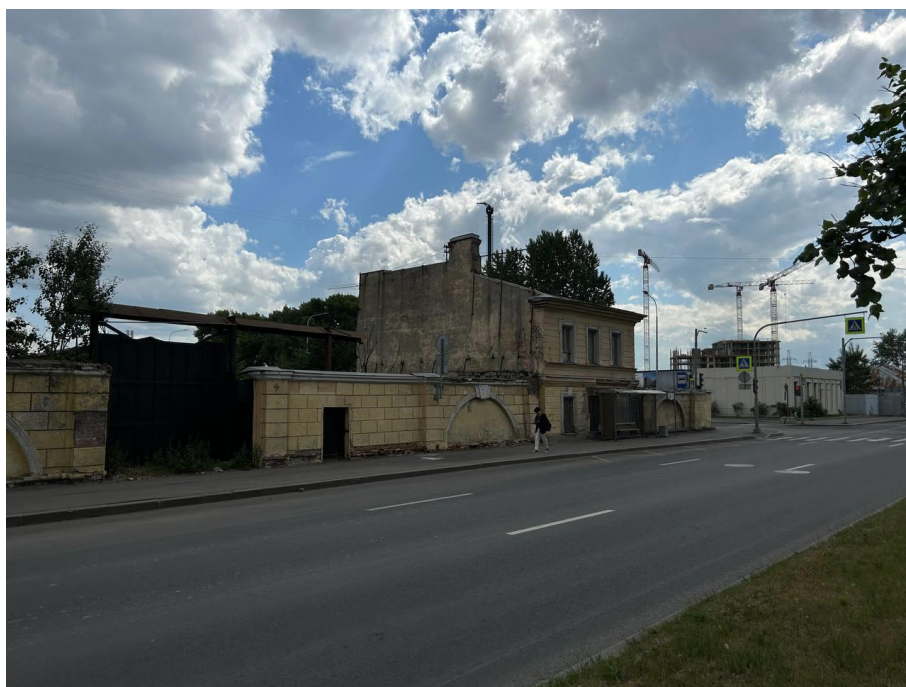
Фото №2. Северный и западный фасады здания, вид с Лиговского проспекта.
