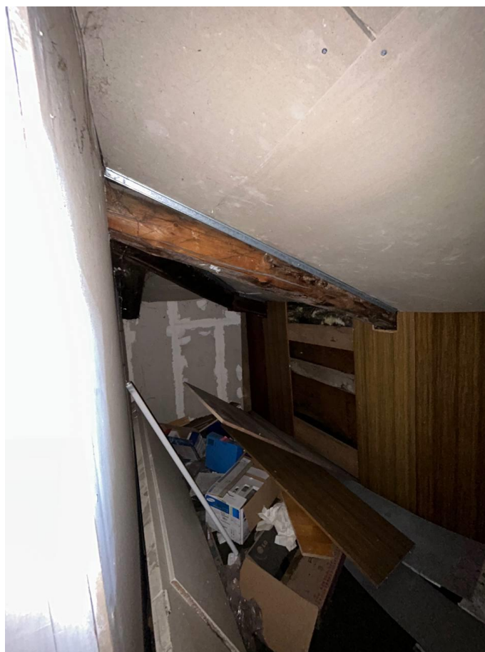
Фото №36. Стропильные конструкции под обшивкой из гипсокартона.
