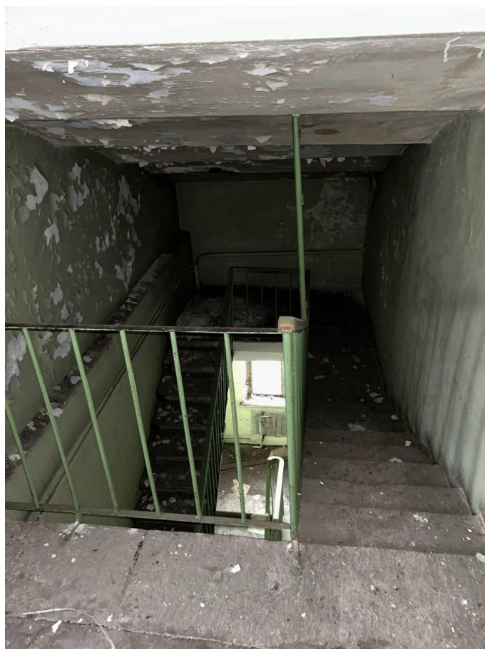
Фото №32. Вид с лестничной площадки чердака.
