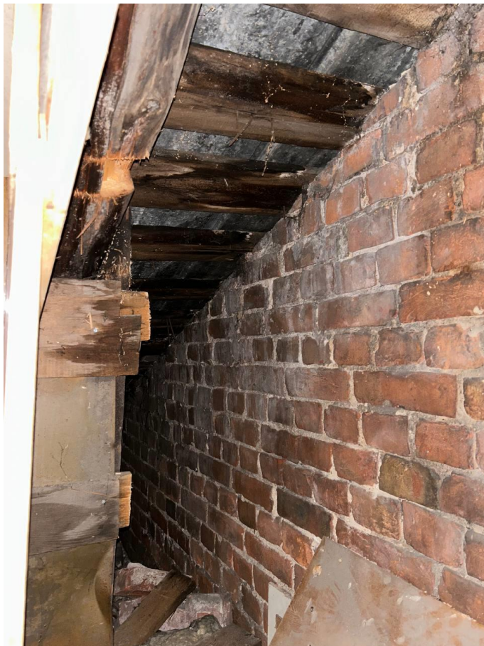
Фото №37. Стропильные конструкции, кирпичная кладка под обшивкой из гипсокартона.
