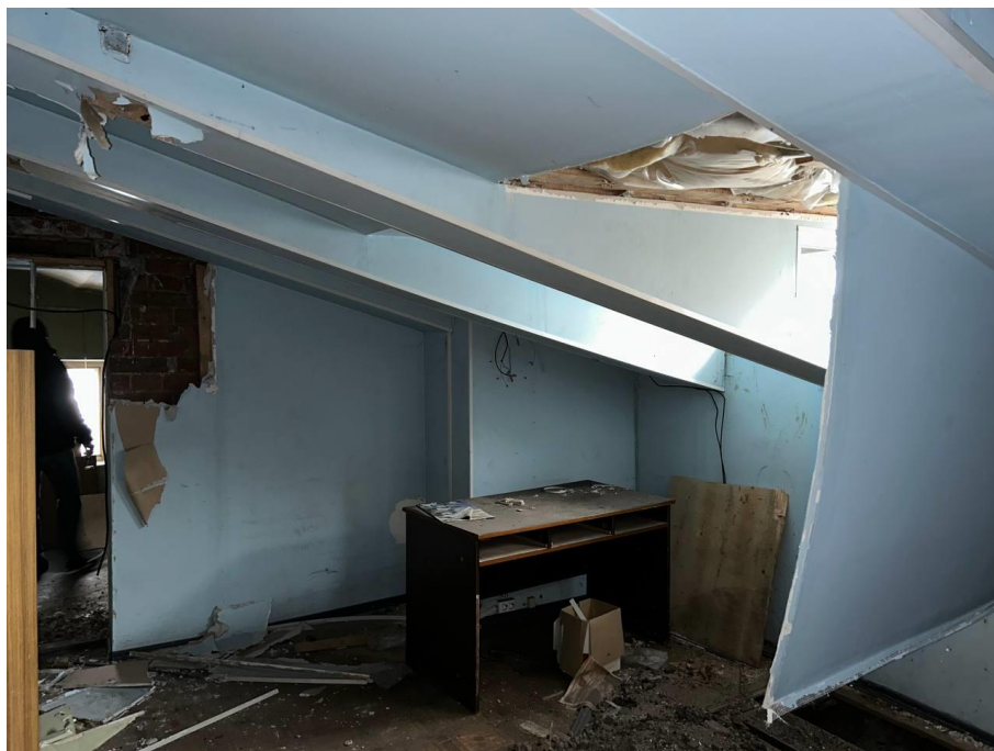
Фото №35. Помещение чердака, вид в сторону входа.
