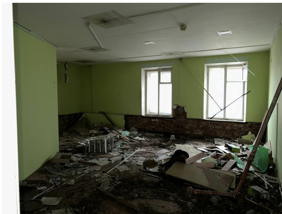
Фото №16. Помещение 1-го этажа, вид со входа.
