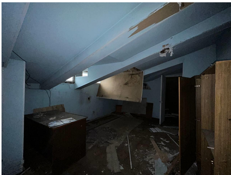
Фото №34. Помещение чердака, вид со стороны входа.
