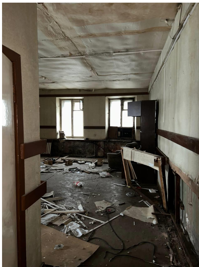
Фото №24. Помещение 2-го этажа, вид со входа.
