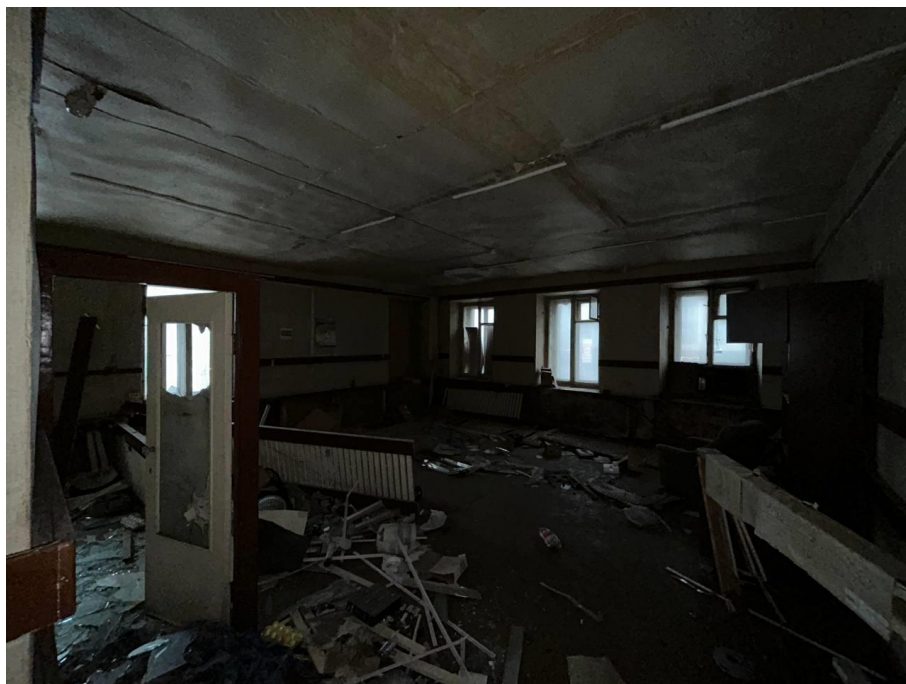
Фото №25. Помещение 2-го этажа, вид со входа.
