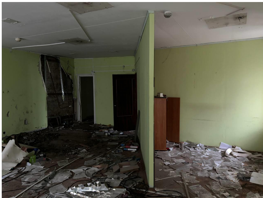
Фото №19. Помещение 1-го этажа, вид в сторону входа.
