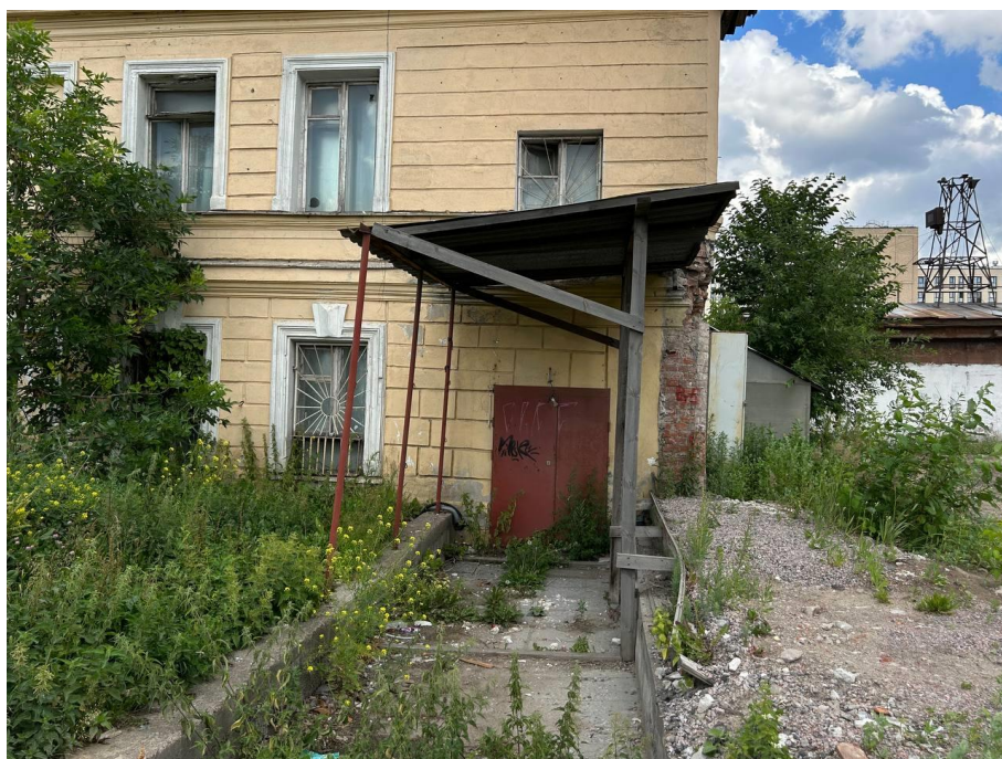
Фото №12. Вход в здание, со стороны южного фасада.
