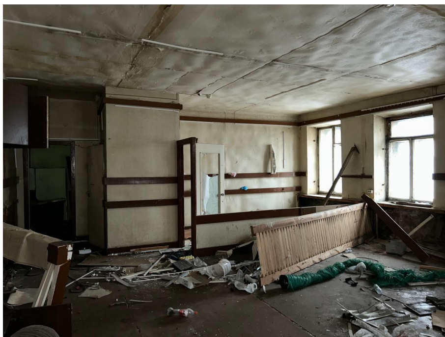
Фото №26. Помещение 2-го этажа, вид в сторону входа.
