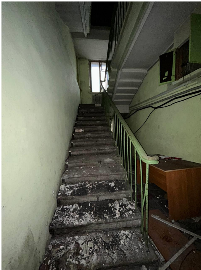
Фото №15. Лестничный марш в уровне 1-го этажа, вид в сторону междуэтажной площадки.
