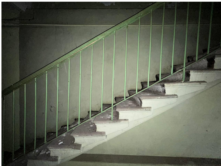
Фото №23. Фрагмент лестничного ограждения.
