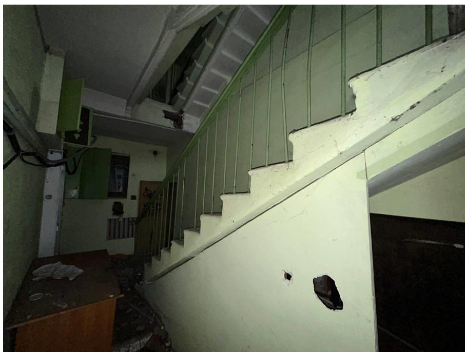
Фото №14. Лестничная клетка 1-го этажа, вид со входа.
