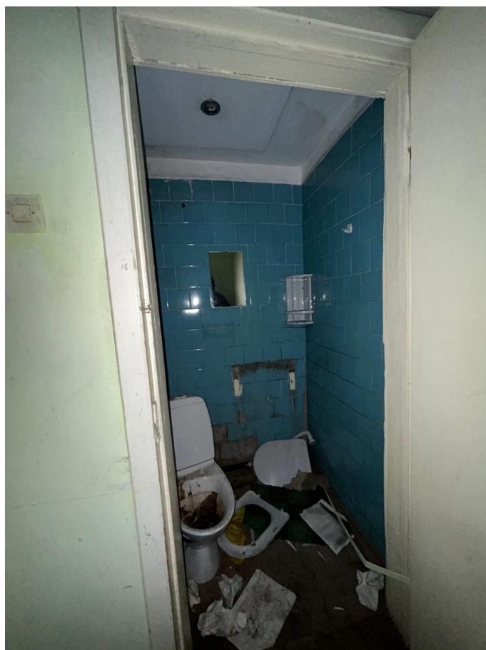
Фото №20. Санузел на 1-м этаже, вид со стороны тамбура.
