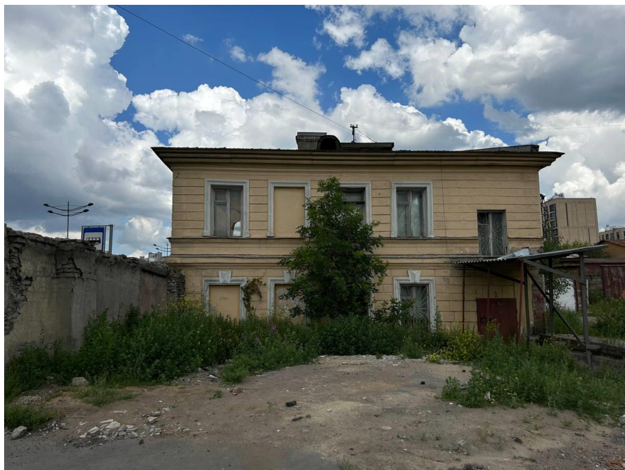
Фото №9. Общий вид на южный фасад здания со стороны ул. Госина.
