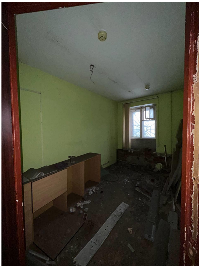
Фото №17. Помещение 1-го этажа, вид со входа.
