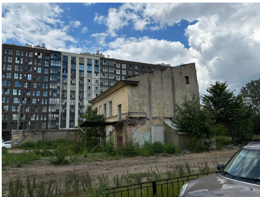
Фото №8. Южный и восточный фасады здания.
