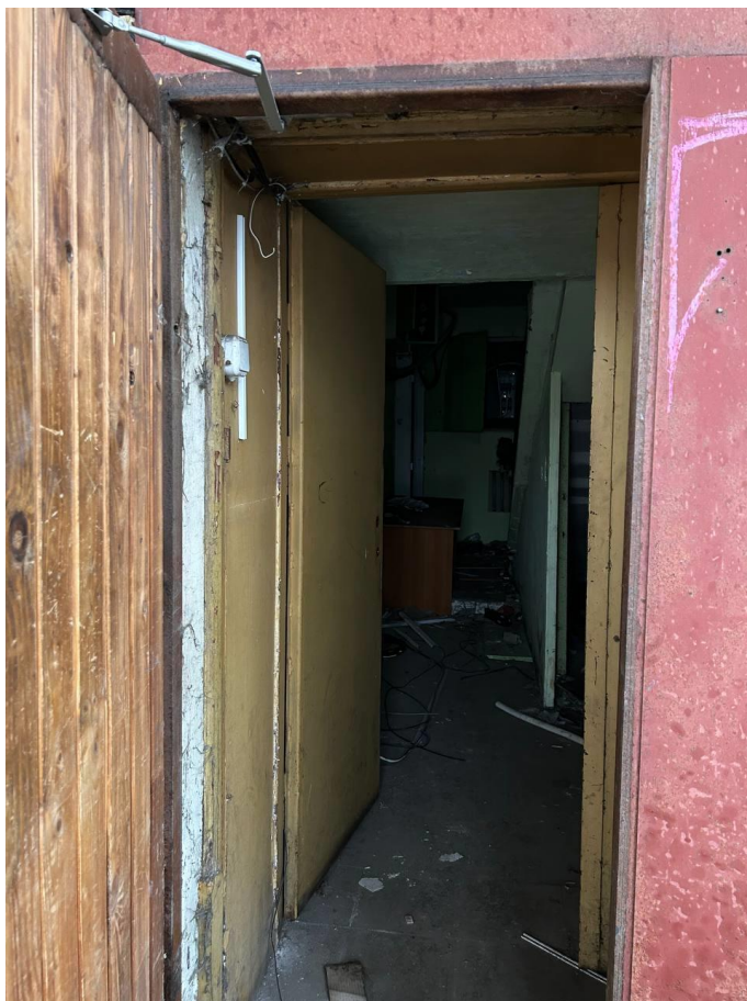
Фото №13. Вход в здание со стороны южного фасада, вид с улицы.
